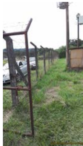
Foto 3 - Cercamento de alambrado metálico no perímetro da área.
