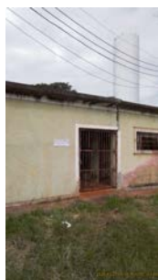
Foto 29 - Edificação em alvenaria existente no local.
