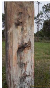
Foto 3 - Armadura exposta.
