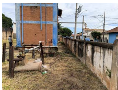
Foto 5 - Vista geral da captação.
