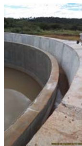
Foto 26 - Vista do interior do decantador.
