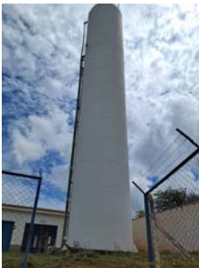
Foto 1 - Vista geral do reservatório.
