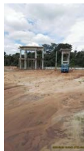
Foto 28 - Vista das estruturas elevadas próximas da entrada da ETE.
