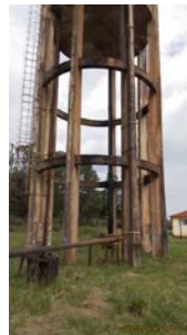
Foto 4 - Vista geral da base do reservatório.
