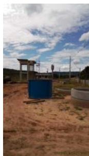
Foto 1 - Vista geral do canteiro de obras.
