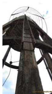
Foto 10 - Escada e guarda corpo presentes na estrutura.
