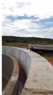
Foto 27 - Vista do interior do decantador.
