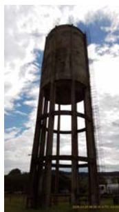
Foto 9 - Vista geral do reservatório.
