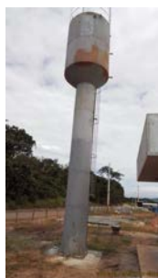
Foto 16 - Reservatório metálico elevado, próximo à edificação na entrada da ETE.
