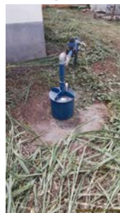
Foto 7 - Vista geral da captação.
