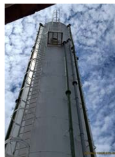
Foto 12 - Vista geral do reservatório.
