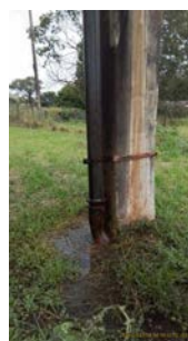
Foto 7 - Acúmulo de água no pavimento sob o reservatório, em razão de vazamento existente.
