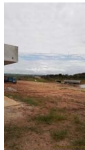
Foto 15 - Vista geral do canteiro de obras.
