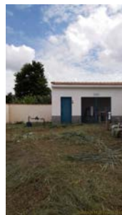
Foto 4 - Vista do interior da área da unidade, com poço à esquerda.
