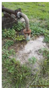
Foto 15 - Vista geral da captação.
