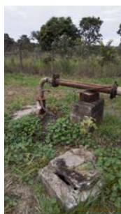
Foto 12 - Vista geral da captação.
