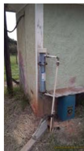
Foto 5 - Dosador de reagentes utilizados no tratamento da água captada.
