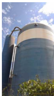
Foto 6 - Vista geral da unidade.
