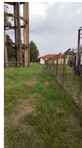
Foto 2 - Cercamento de alambrado metálico no perímetro da área.
