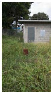
Foto 10 - Vista da área interna do cercado onde se localiza o poço. Recomenda-se roçada e limpeza do local.
