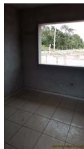
Foto 12 - Interior da edificação na entrada da ETE.
