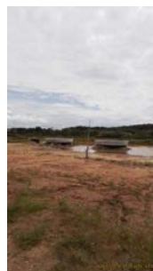
Foto 14 - Vista geral do canteiro de obras.
