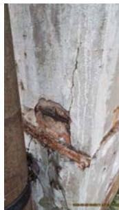
Foto 1 - Armadura exposta.
