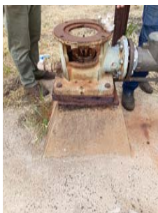
Foto 10 - Vista geral da captação.
