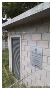
Foto 3 - Edificação de alvenaria existente na unidade. Placa de identificação da área.
