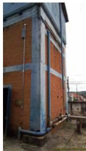
Foto 5 - Vista geral do reservatório.
