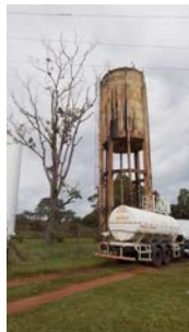
Foto 1 - Vista geral do reservatório. No momento da fiscalização havia um caminhão pipa no local.
