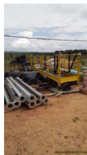
Foto 30 - Tubulação e materiais em espera.
