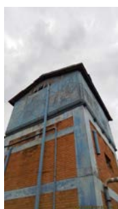
Foto 11 - Vista geral do reservatório.
