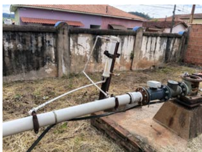
Foto 4 - Vista geral da captação.
