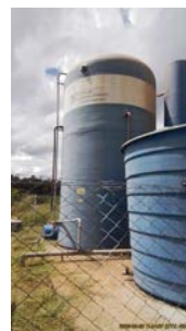
Foto 4 - Vista geral da unidade.
