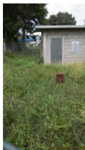
Foto 9 - Vista da área interna do cercado onde se localiza o poço. Recomenda-se roçada e limpeza do local.
