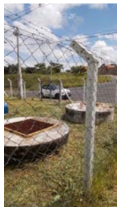
Foto 9 - Vista geral da unidade.
