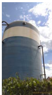
Foto 7 - Vista geral da unidade.
