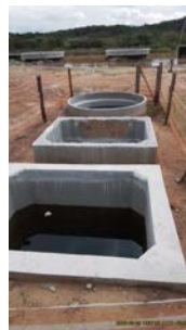
Foto 17 - Poço de chegada do efluente na ETE, caixa para instalação do gradeamento e poço da elevatória a ser instalada.
