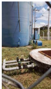
Foto 8 - Vista geral da unidade.
