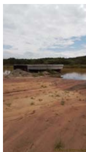
Foto 21 - Vista do decantador em construção.
