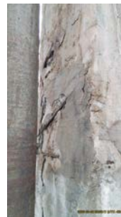
Foto 2 - Armadura exposta.
