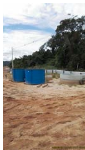
Foto 29 - Pré moldados no canteiro de obras.
