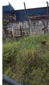
Foto 2 - Vista da área interna do cercado onde se localiza o poço. Recomenda-se roçada e limpeza do local.
