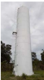
Foto 2 - Vista geral do reservatório.
