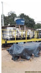
Foto 31 - Estrutura metálica em espera, a ser utilizada na unidade.
