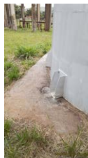
Foto 6 - Base de alvenaria sob o reservatório.
