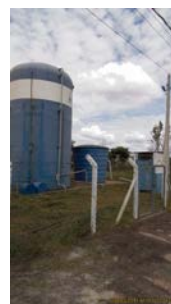
Foto 2 - Vista geral da unidade, a partir do passeio público, evidenciando cercamento com alambrado metálico.
