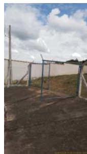
Foto 2 - Vista da unidade a partir do passeio público, indicando fechamento com alambrado e portão metálico.
