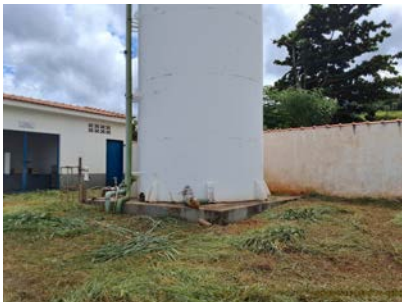
Foto 2 - Vista da base do reservatório.
