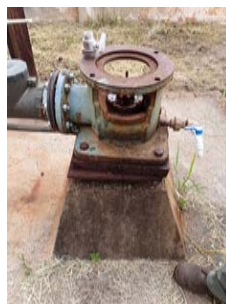
Foto 11 - Vista geral da captação.
