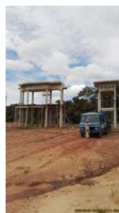
Foto 22 - Estrutura elevada após a EEE.
