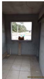
Foto 10 - Interior da edificação na entrada da ETE.
