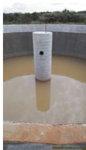
Foto 25 - Vista do interior do decantador.
