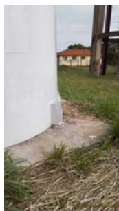
Foto 5 - Base de alvenaria sob o reservatório.
