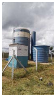
Foto 3 - Vista geral da unidade, a partir do passeio público, evidenciando cercamento com alambrado metálico.
