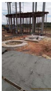
Foto 18 - Sobre o solo, tampas para as caixas do tratamento preliminar.
