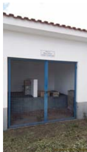
Foto 5 - Edificação de alvenaria no interior da unidade, com placa de identificação.
