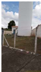
Foto 3 - Vista da unidade a partir do passeio público, indicando fechamento com alambrado.
