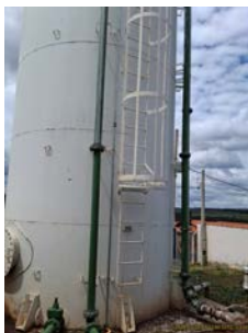
Foto 5 - Vista da base do reservatório.
