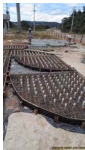
Foto 7 - Preparo das formas para concretagem das placas que formarão o fundo dos filtros.
