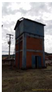
Foto 3 - Vista geral do reservatório.
