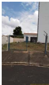
Foto 1 - Vista da unidade a partir do passeio público, indicando fechamento com portão metálico.
