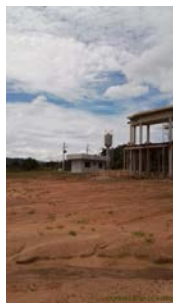
Foto 23 - Edificação na entrada da ETE.
