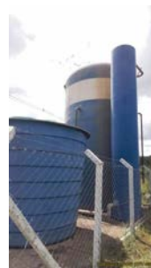
Foto 5 - Vista geral da unidade.
