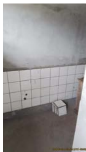
Foto 11 - Interior da edificação na entrada da ETE.
