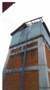
Foto 4 - Vista geral do reservatório.
