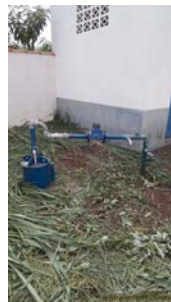
Foto 6 - Vista geral da captação.
