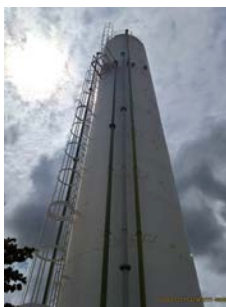
Foto 3 - Vista do reservatório evidenciando escadas e guarda corpos.
