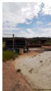
Foto 32 - Abrigos improvisados no canteiro de obras.
