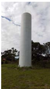
Foto 1 - Vista geral do reservatório.
