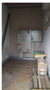
Foto 17 - Vista do interior da edificação.
