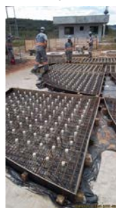
Foto 6 - Preparo das formas para concretagem das placas que formarão o fundo dos filtros.
