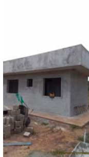
Foto 9 - Edificação na entrada da ETE, para abrigo dos operadores e laboratório.
