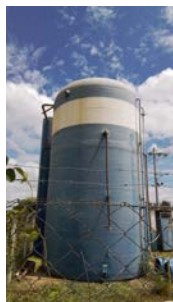
Foto 10 - Vista geral da unidade.
