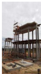
Foto 19 - Estrutura elevada após a EEE.
