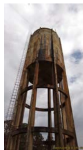
Foto 5 - Vista geral da parte superior do reservatório.
