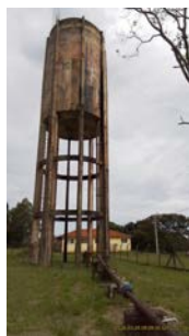
Foto 4 - Reservatório elevado de concreto que recebe a água do poço.
