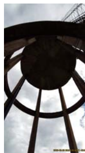
Foto 12 - Vista da parte inferior do reservatório.
