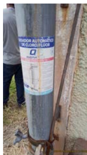
Foto 6 - Dosador de reagentes utilizados no tratamento da água captada.
