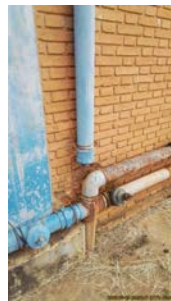
Foto 6 - Tubulação que abastecia o reservatório, com a água captada do poço.
