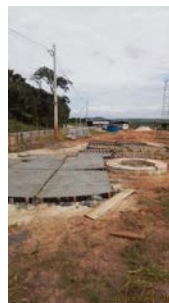
Foto 8 - Pré moldados de concreto armado.
