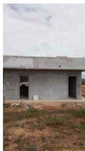
Foto 13 - Edificação na entrada da ETE, para abrigo dos operadores e laboratório.
