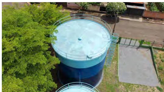
Foto 7 - Vista geral do reservatório.
