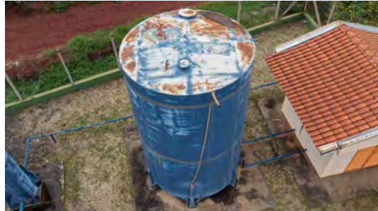
Foto 16 - Vista geral do reservatório apoiado.
