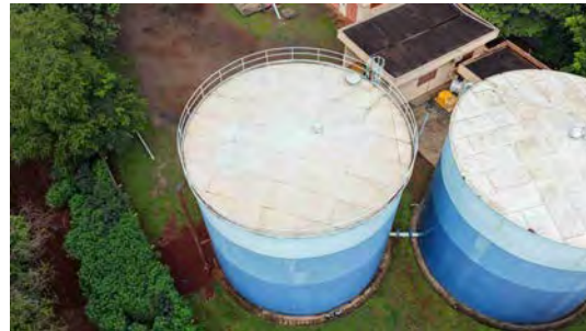
Foto 14 - Vista geral do reservatório.
