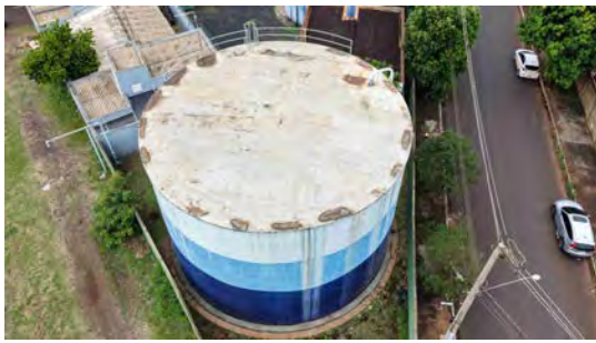
Foto 7 - Vista geral do reservatório.
