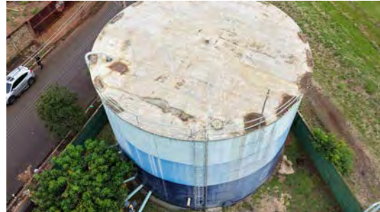
Foto 10 - Guarda-corpo do reservatório metálico.
