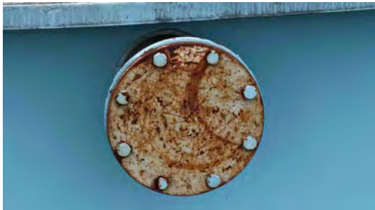
Foto 27 - Ponto de conexão fechado.
