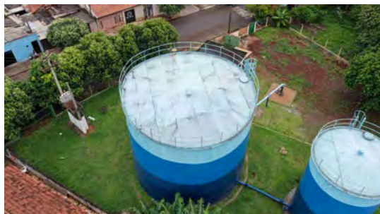
Foto 11 - Vista geral do reservatório.
