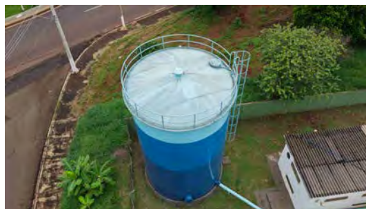
Foto 18 - Vista geral do reservatório 2.
