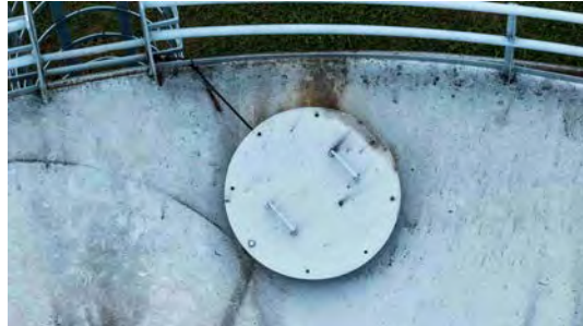
Foto 16 - Tampa de inspeção.
