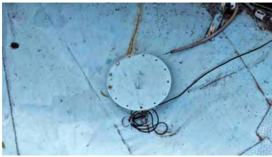
Foto 3 - Tampa de inspeção.
