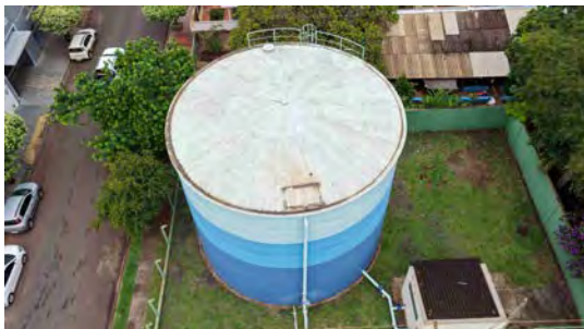
Foto 3 - Vista geral do reservatório.
