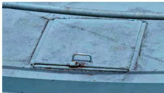
Foto 11 - Tampa de inspeção.
