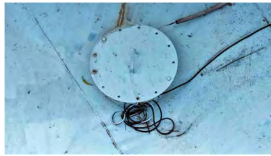
Foto 4 - Tampa de inspeção.
