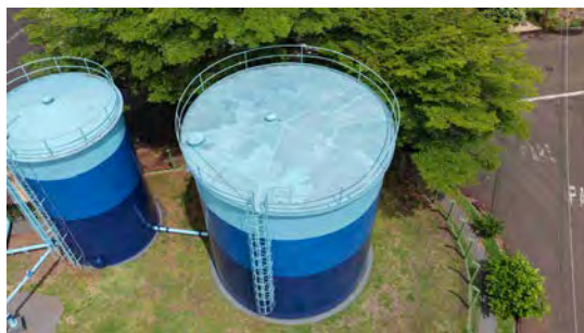
Foto 5 - Vista geral do reservatório.
