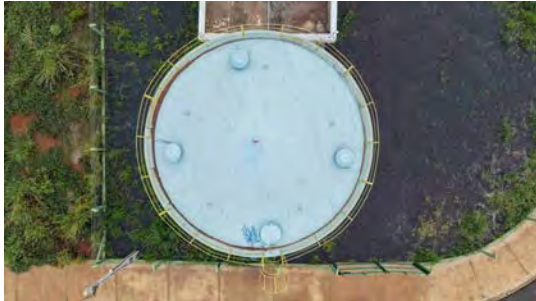
Foto 3 - Vista superior do reservatório.
