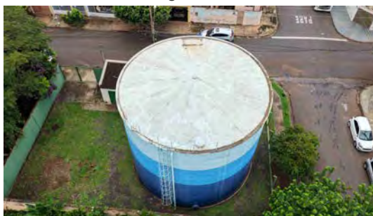
Foto 6 - Vista geral do reservatório.
