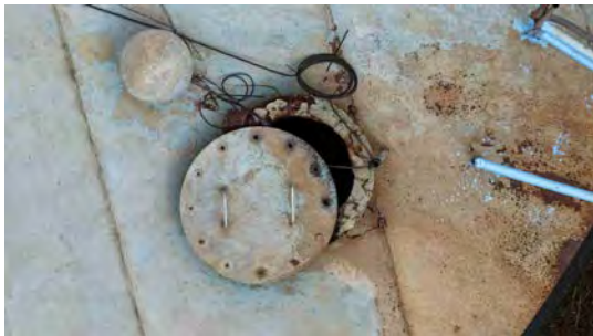
Foto 1 - Tampa de inspeção aberta.
