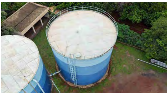
Foto 17 - Vista geral do reservatório.
