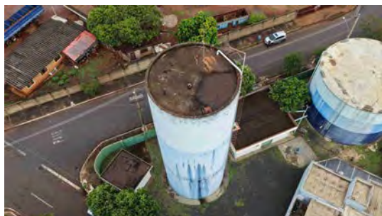
Foto 3 - Vista geral do reservatório.
