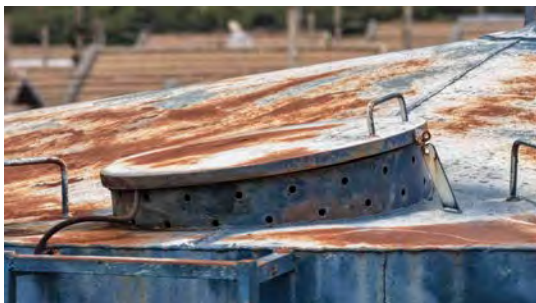
Foto 21 - Tampa de inspeção do apoiado.
