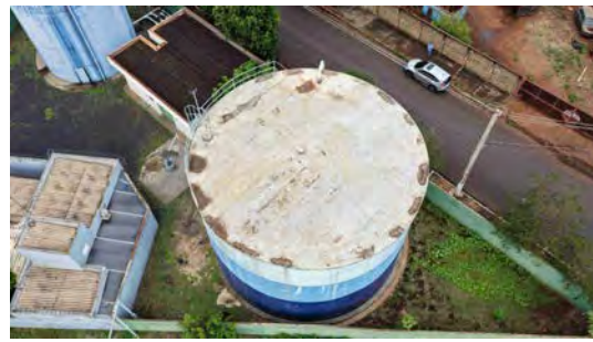
Foto 8 - Vista geral do reservatório.
