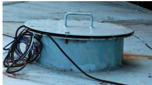
Foto 10 - Tampa de inspeção.
