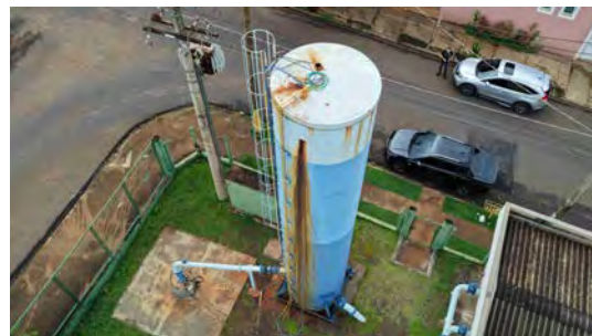
Foto 8 - Vista geral do reservatório.
