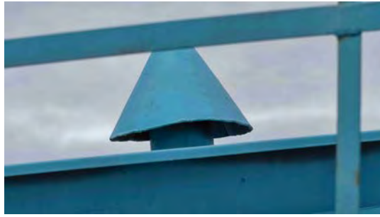
Foto 1 - Ausência de tela de proteção na tubulação de ventilação.
