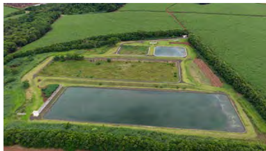
Foto 22 - Vista geral da ETE e cercamento.
