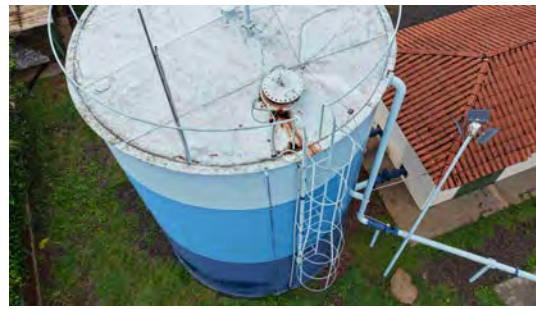
Foto 7 - Vista geral do reservatório.
