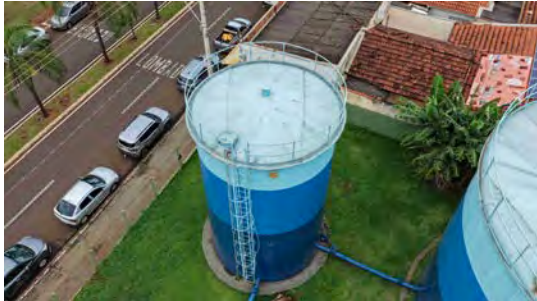
Foto 25 - Vista geral do reservatório.
