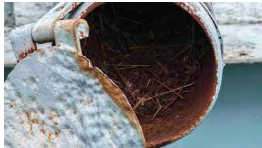
Foto 2 - Remover material de possível ninho do interior do extravasor e fazer a limpeza.
