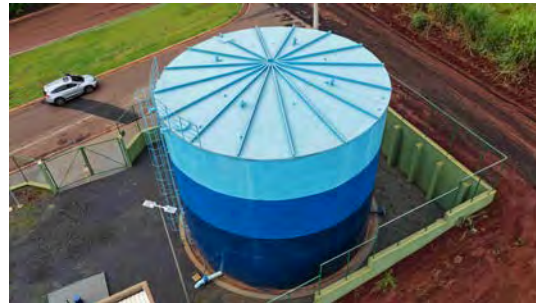
Foto 4 - Vista geral do reservatório.
