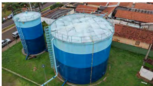
Foto 7 - Vista geral do reservatório.
