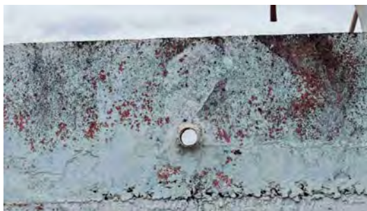
Foto 8 - Drenagem de laje.
