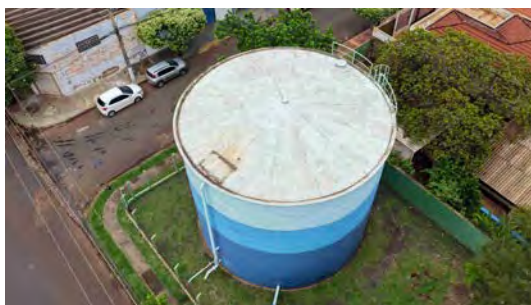
Foto 8 - Vista geral do reservatório.
