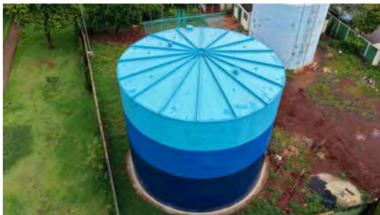
Foto 19 - Vista geral do reservatório metálico (novo).
