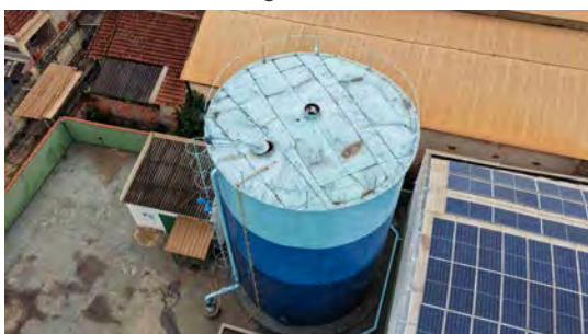
Foto 7 - Vista geral do reservatório.
