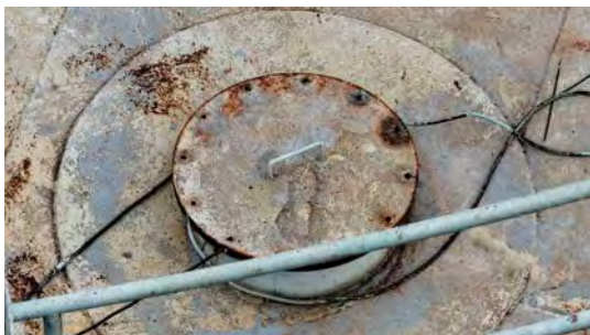
Foto 11 - Tampa de inspeção.
