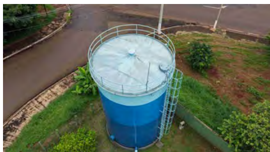
Foto 19 - Vista geral do reservatório 2.
