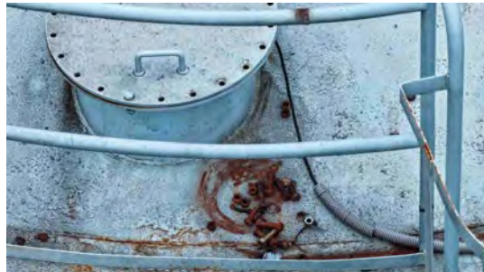
Foto 28 - Tampa de inspeção.
