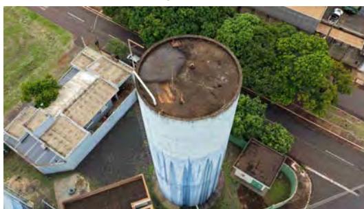
Foto 6 - Vista geral do reservatório.
