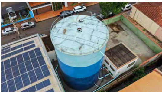
Foto 5 - Vista geral do reservatório.
