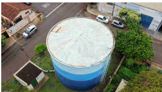
Foto 7 - Vista geral do reservatório.
