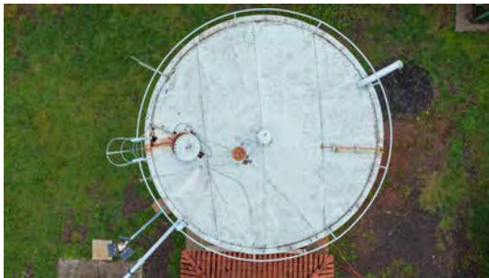
Foto 2 - Vista superior do reservatório.
