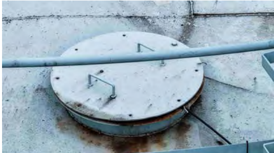
Foto 15 - Tampa de inspeção.
