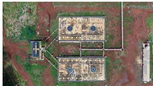
Foto 13 - Vista dos UASBs.
