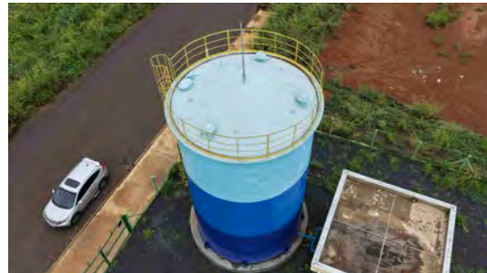
Foto 6 - Vista geral do reservatório.
