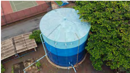
Foto 3 - Vista geral do reservatório.
