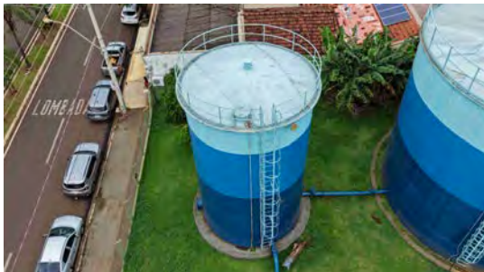
Foto 19 - Vista geral do reservatório.
