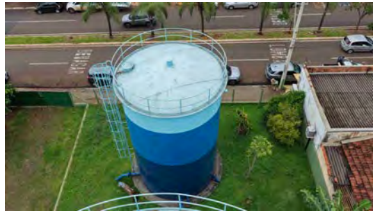
Foto 24 - Vista geral do reservatório.
