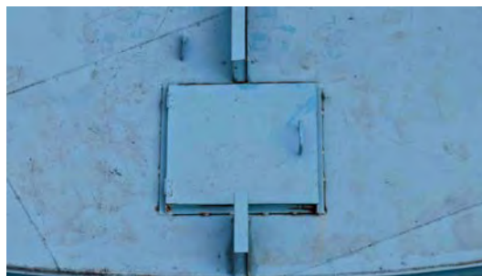
Foto 14 - Tampa de inspeção.
