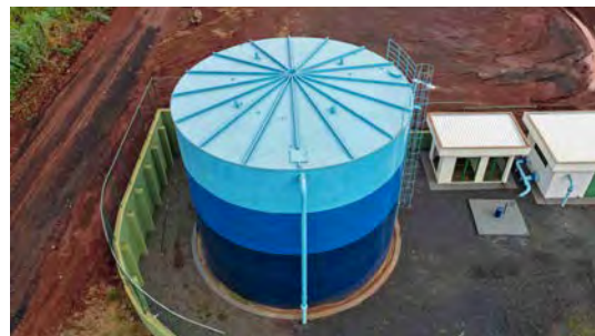
Foto 8 - Vista geral do reservatório.
