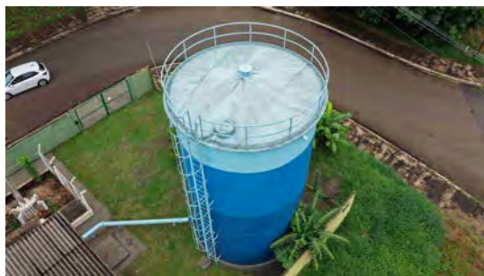
Foto 15 - Vista geral do reservatório 2.
