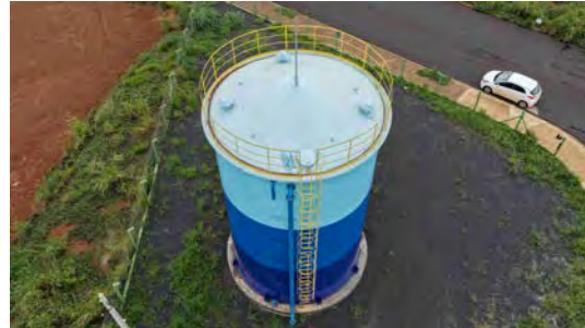
Foto 4 - Vista geral do reservatório.
