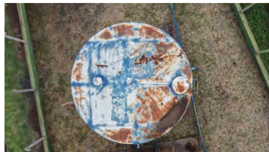
Foto 12 - Vista superior do reservatório apoiado.
