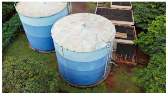
Foto 5 - Vista geral do reservatório.
