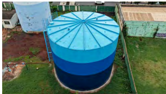
Foto 20 - Vista geral do reservatório metálico (novo).
