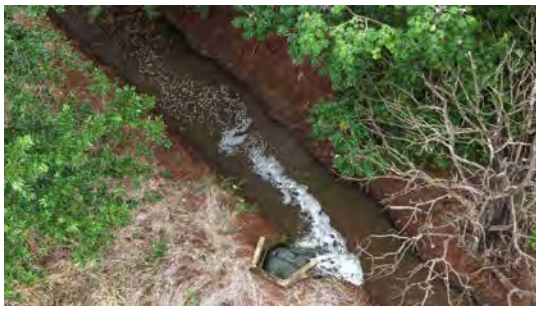
Foto 18 - Detalhe do lançamento do efluente tratado.
