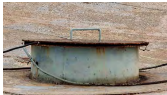
Foto 12 - Tampa de inspeção.
