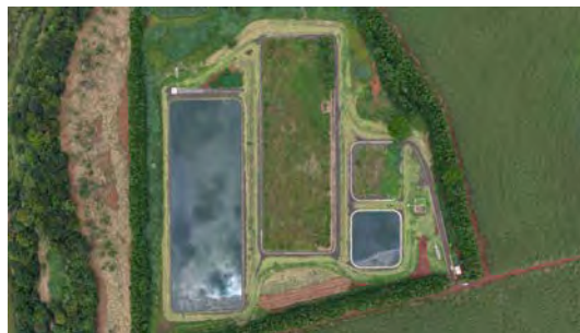
Foto 2 - Vista geral da ETE e cercamento.
