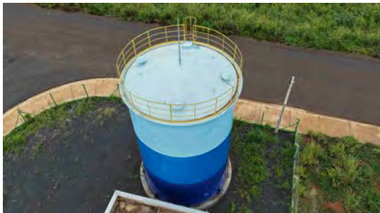
Foto 7 - Vista geral do reservatório.
