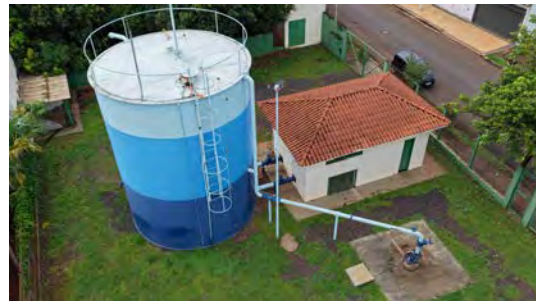
Foto 12 - Vista geral do reservatório.
