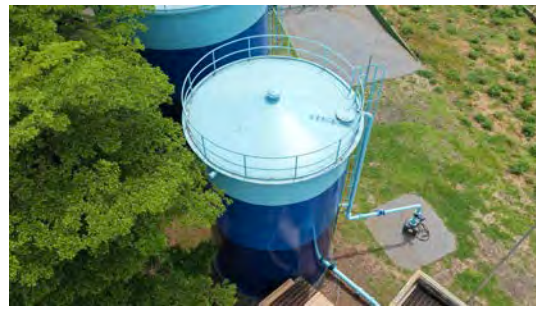
Foto 15 - Vista geral do reservatório.
