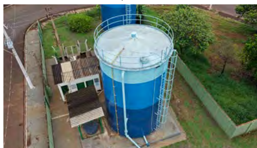
Foto 4 - Vista geral do reservatório 1.
