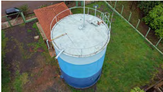
Foto 5 - Vista geral do reservatório.
