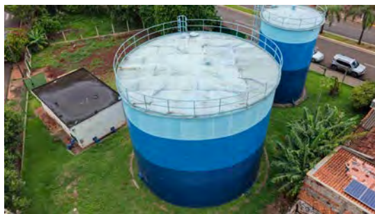
Foto 3 - Vista geral do reservatório.
