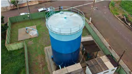
Foto 7 - Vista geral do reservatório 1.
