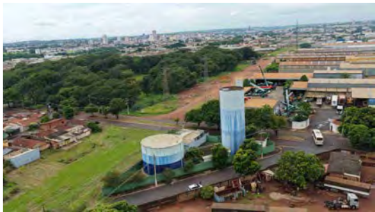
Foto 1 - Vista geral do reservatório.
