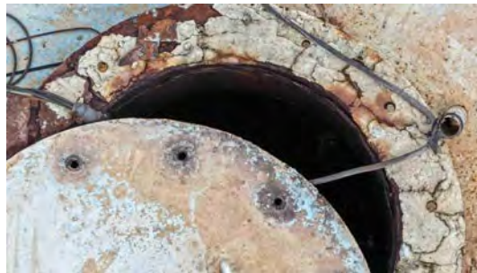
Foto 2 - Tampa de inspeção aberta.
