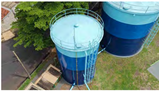
Foto 14 - Vista geral do reservatório.
