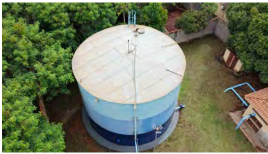
Foto 5 - Vista geral do reservatório.
