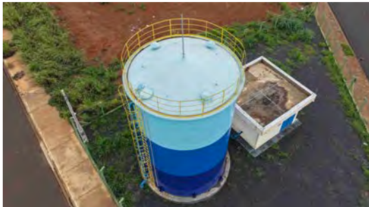
Foto 5 - Vista geral do reservatório.
