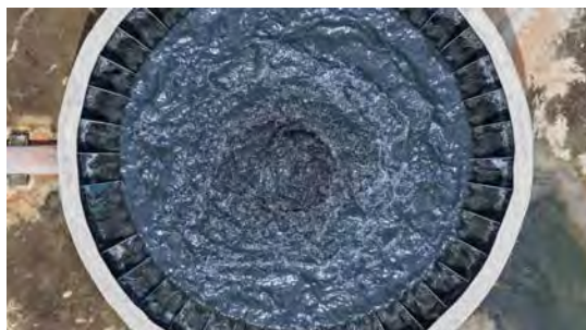
Foto 16 - Detalhes do UASB.
