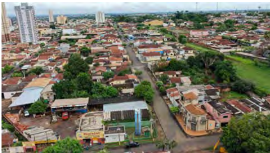
Foto 1 - Vista geral do reservatório.
