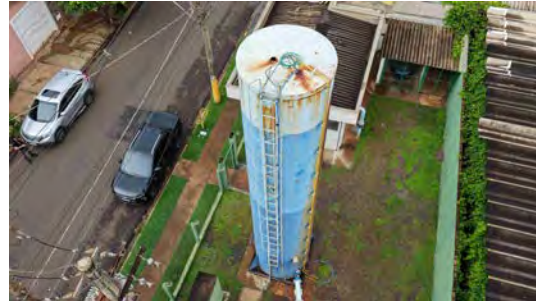
Foto 6 - Vista geral do reservatório.
