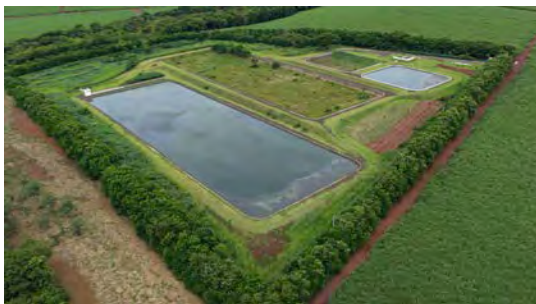
Foto 21 - Vista geral da ETE e cercamento.
