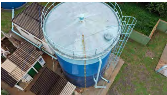
Foto 9 - Tampa de inspeção e guarda-corpo do reservatório 1.
