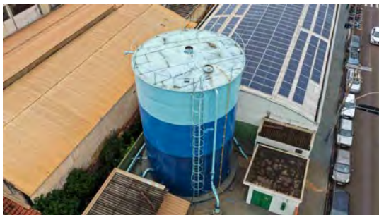
Foto 3 - Vista geral do reservatório.
