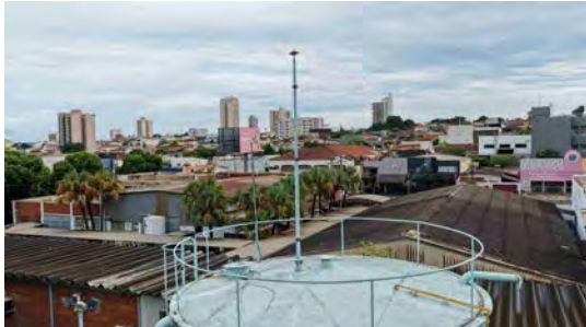
Foto 8 - SPDA, guarda-copro e tubulação de ventilação.
