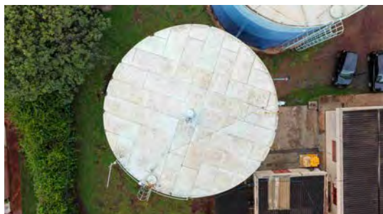
Foto 3 - Vista superior do reservatório.
