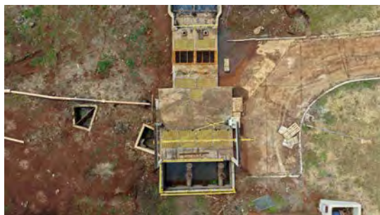
Foto 5 - Poço de sucção.
