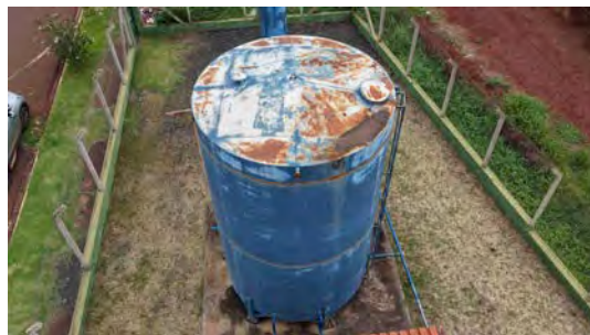
Foto 18 - Vista geral do reservatório apoiado.
