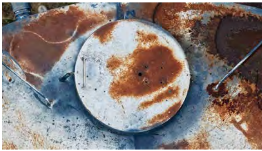
Foto 13 - Tampa de inspeção do apoiado.
