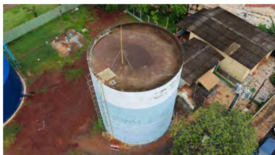
Foto 9 - Vista geral do reservatório de concreto.
