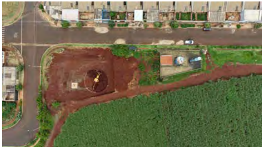
Foto 2 - Vista geral do reservatório.
