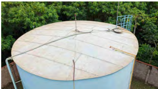
Foto 1 - Instalar guarda-corpo nas proximidades da tampa de inspeção.
