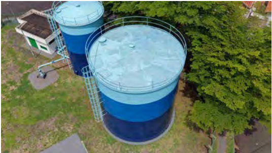
Foto 4 - Vista geral do reservatório.
