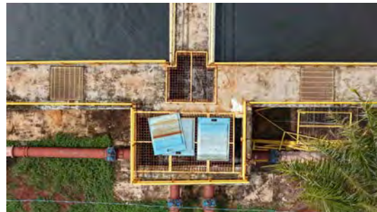
Foto 11 - Detalhe dos guarda-corpos do preliminar.
