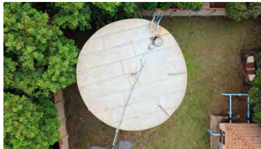
Foto 2 - Vista superior do reservatório.
