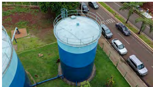
Foto 22 - Vista geral do reservatório.
