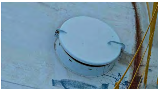
Foto 1 - Tampa de inspeção semiaberta.
