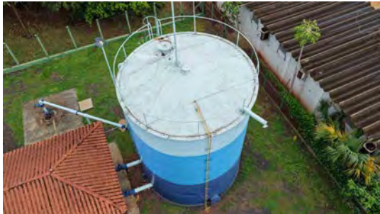
Foto 4 - Vista geral do reservatório.
