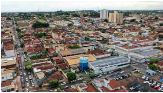
Foto 1 - Vista geral do reservatório.
