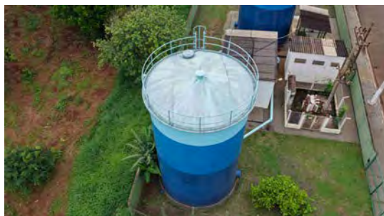
Foto 17 - Vista geral do reservatório 2.
