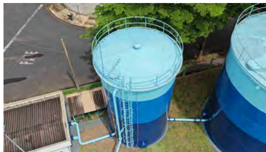
Foto 13 - Vista geral do reservatório.
