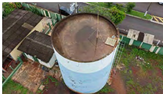
Foto 6 - Vista geral do reservatório de concreto.
