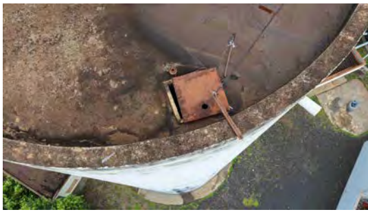
Foto 11 - Tampa de inspeção.
