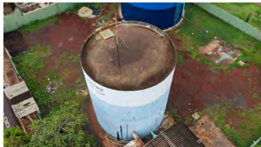
Foto 8 - Vista geral do reservatório de concreto.
