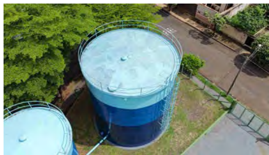
Foto 6 - Vista geral do reservatório.
