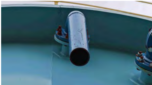
Foto 15 - Detalhe do extravasor.
