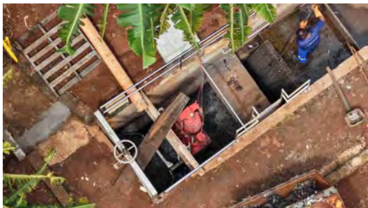
Foto 2 - Chegada do esgoto.
