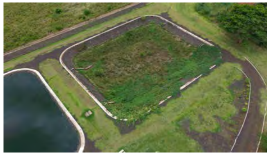
Foto 10 - Vista da lagoa anaeróbia 02 seca.
