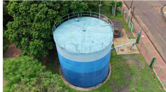
Foto 6 - Vista geral do reservatório.
