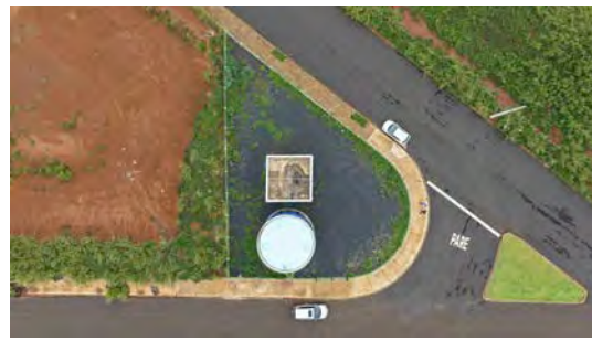
Foto 2 - Vista superior do reservatório.
