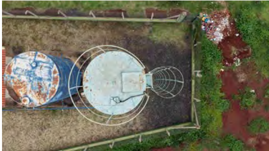
Foto 5 - Vista superior do reservatório elevado.
