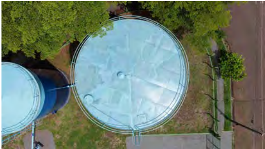
Foto 3 - Vista superior do reservatório.
