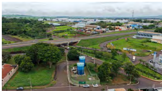
Foto 1 - Vista geral do reservatório.
