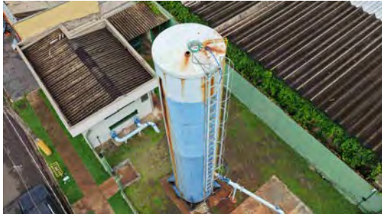
Foto 5 - Vista geral do reservatório.
