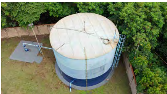
Foto 3 - Vista geral do reservatório.
