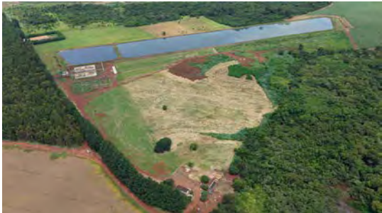
Foto 1 - Vista geral da ETE.
