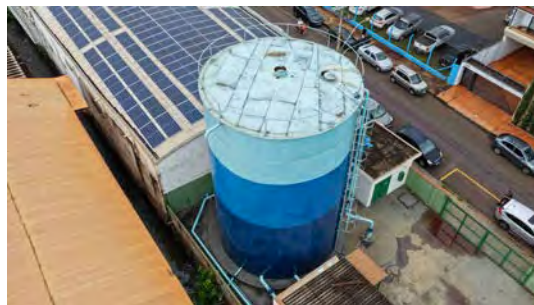
Foto 4 - Vista geral do reservatório.
