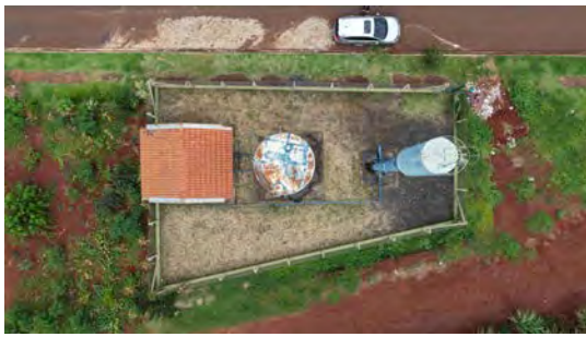
Foto 3 - Vista geral do reservatório.
