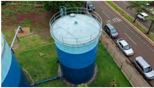
Foto 23 - Vista geral do reservatório.
