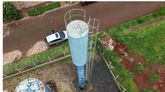
Foto 10 - Vista geral do reservatório elevado.
