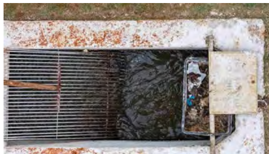
Foto 4 - Detalhe do gradeamento de entrada.
