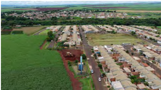
Foto 1 - Vista geral do reservatório.
