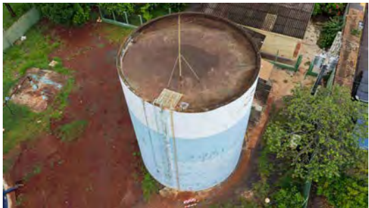
Foto 4 - Vista geral do reservatório de concreto.
