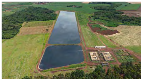
Foto 22 - Vista das lagoas anaeróbia e facultativa.
