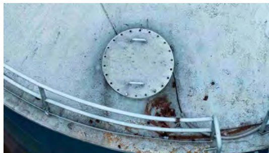
Foto 18 - Tampa de inspeção.
