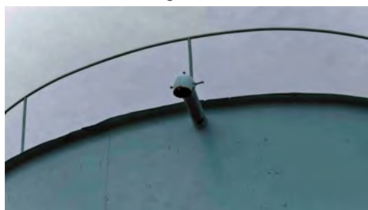
Foto 8 - Tubo Extravador.
