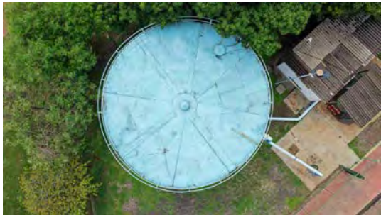
Foto 2 - Vista superior do reservatório.
