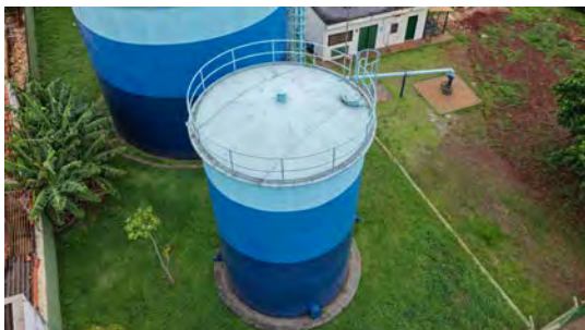
Foto 21 - Vista geral do reservatório.
