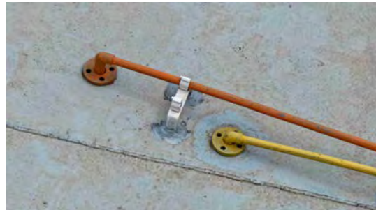
Foto 10 - Aplicação de cloro e fluor.
