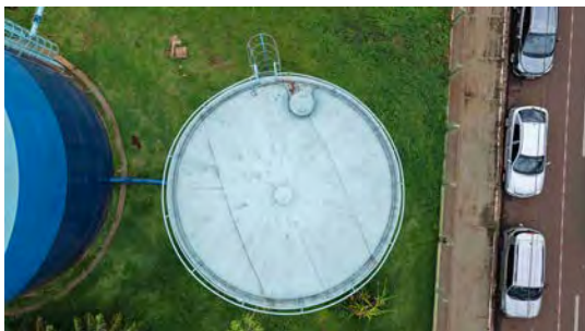
Foto 17 - Vista superior do reservatório.
