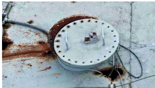
Foto 2 - Tampa de inspeção semiaberta.
