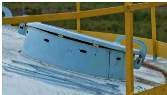
Foto 2 - Tampa de inspeção semiaberta.
