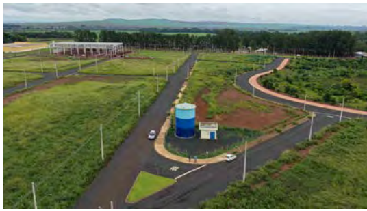
Foto 1 - Vista geral do reservatório.
