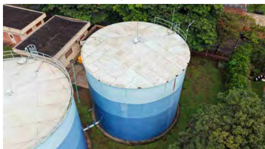
Foto 7 - Vista geral do reservatório.
