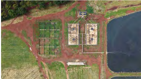
Foto 7 - Vista do tratamento preliminar, UASBs e secagem de lodo.
