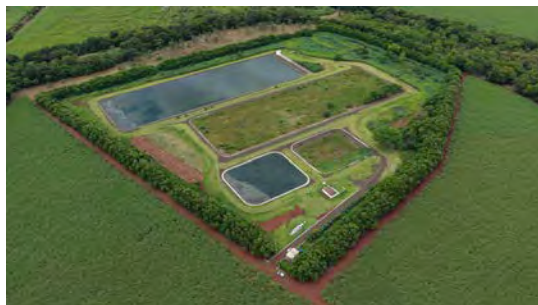
Foto 1 - Vista geral da ETE e cercamento.
