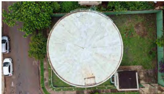
Foto 2 - Vista superior do reservatório.
