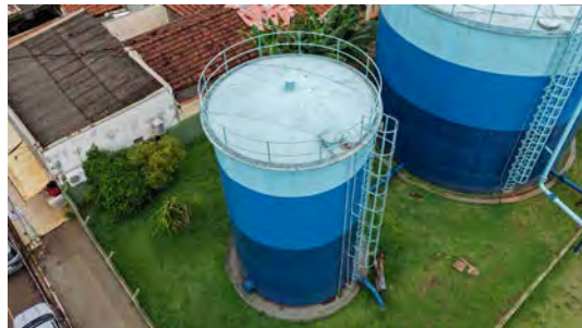
Foto 20 - Vista geral do reservatório.
