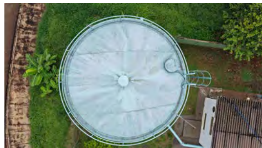
Foto 14 - Vista superior do reservatório 2.
