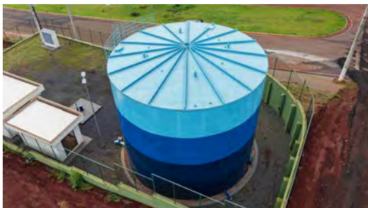
Foto 5 - Vista geral do reservatório.
