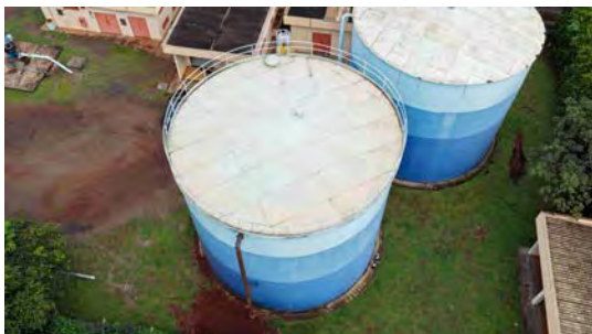
Foto 15 - Vista geral do reservatório.
