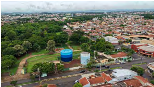
Foto 1 - Vista geral do reservatório.
