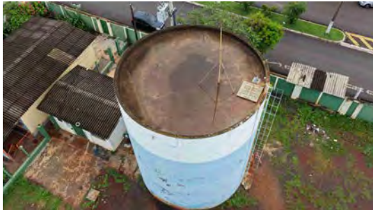
Foto 1 - Cabeamento cortado na segunda anélha.
