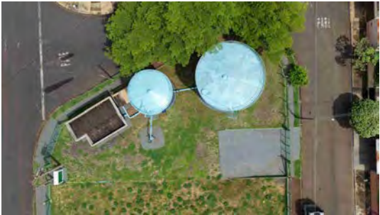
Foto 2 - Vista superior do reservatório.
