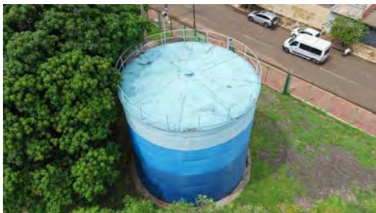
Foto 7 - Vista geral do reservatório.
