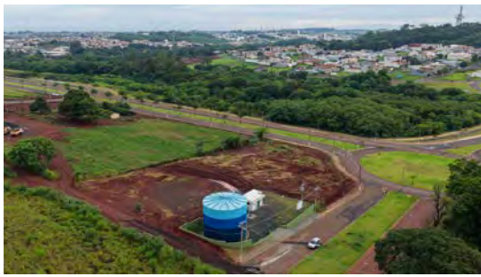
Foto 1 - Vista geral do reservatório.
