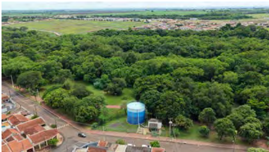
Foto 1 - Vista geral do reservatório.
