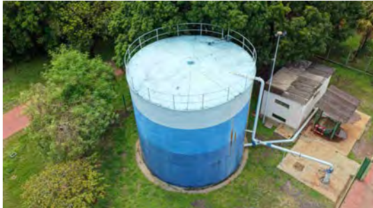
Foto 5 - Vista geral do reservatório.
