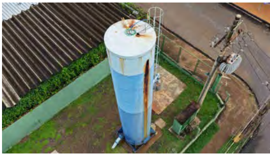
Foto 3 - Vista geral do reservatório.
