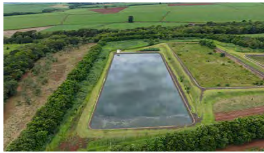
Foto 19 - Vista da lagoa facultativa 02.
