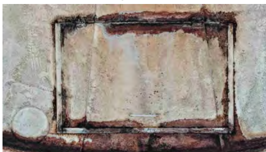
Foto 10 - Tampa de inspeção.
