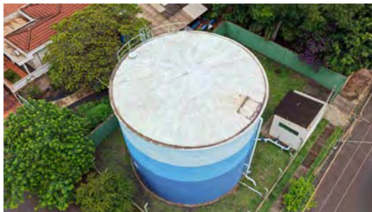
Foto 4 - Vista geral do reservatório.
