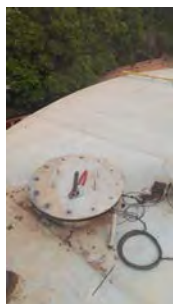
Foto 3 - Evidência do fechamento enviada pelo prestador por e-mail em 02/04/2026.
