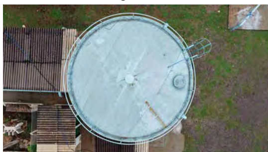
Foto 3 - Vista superior do reservatório 1.
