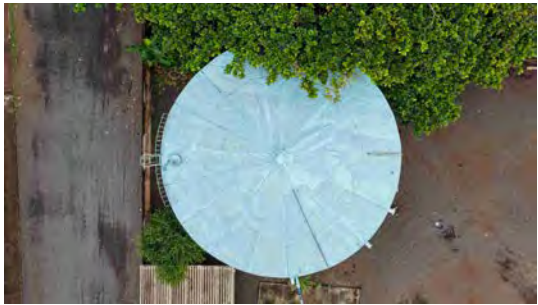
Foto 2 - Vista superior do reservatório.
