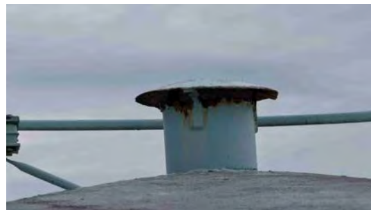
Foto 10 - Tubulação de ventilação.
