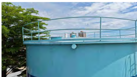
Foto 9 - Tampa de inspeção, extravasor e guarda-corpo.
