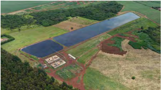
Foto 2 - Vista geral da ETE.
