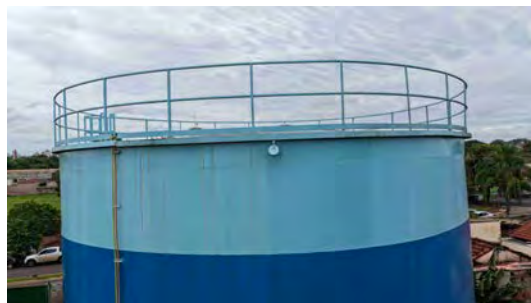
Foto 12 - Vista do guarda-corpo superior.
