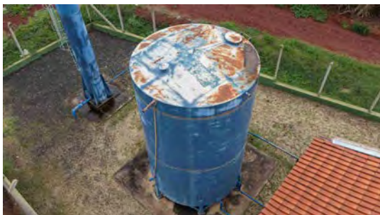
Foto 17 - Vista geral do reservatório apoiado.
