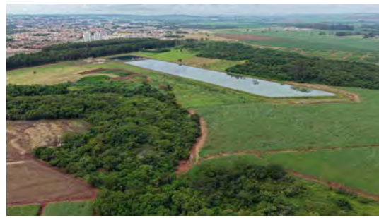
Foto 6 - Vista geral da ETE.
