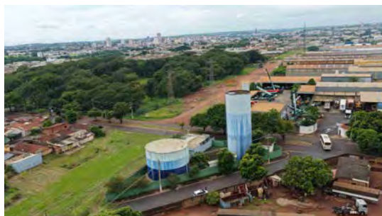
Foto 1 - Vista geral do reservatório.
