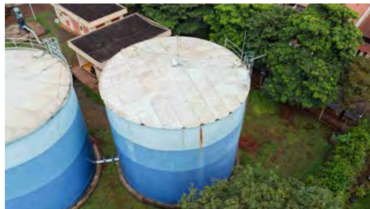
Foto 6 - Vista geral do reservatório.
