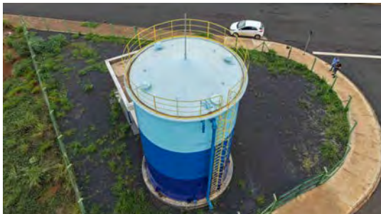
Foto 9 - Vista geral do reservatório.
