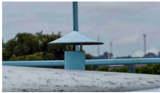
Foto 14 - Tubulação de ventilação.
