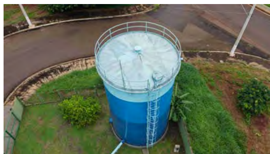
Foto 20 - Vista geral do reservatório 2.
