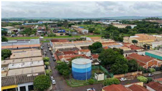
Foto 1 - Vista geral do reservatório.
