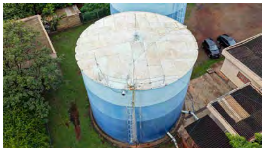
Foto 4 - Vista geral do reservatório.
