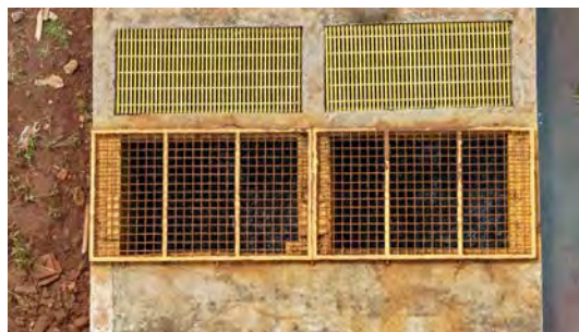
Foto 6 - Gradil de piso instalado para proteção.
