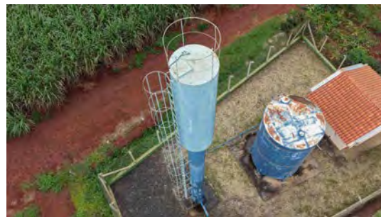
Foto 8 - Guarda-corpo do elevado.
