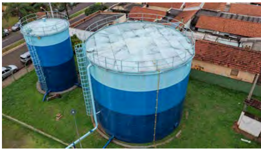
Foto 1 - Ausência de SPDA.
