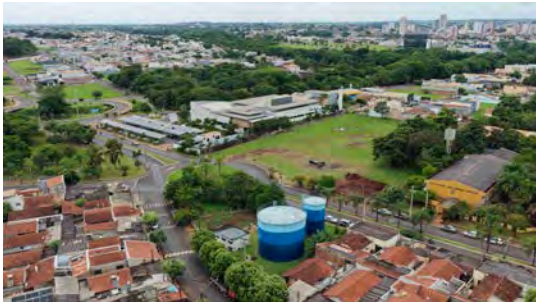
Foto 1 - Vista geral do reservatório.
