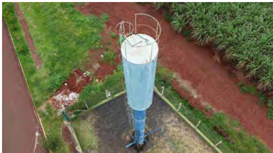
Foto 9 - Vista geral do reservatório elevado.
