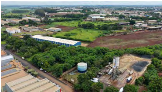
Foto 1 - Vista geral do reservatório.
