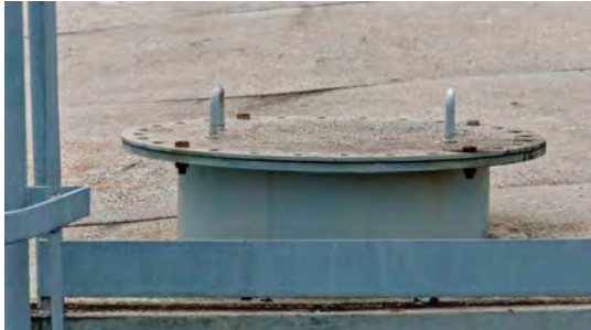
Foto 21 - Tampa de inspeção.
