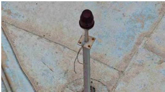
Foto 11 - Luz de identificação com fio cortado.
