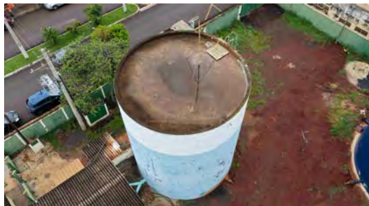
Foto 7 - Vista geral do reservatório de concreto.
