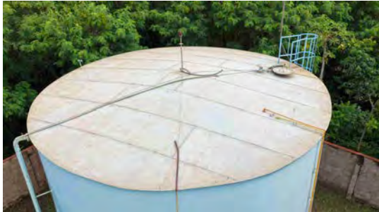
Foto 7 - Vista geral do reservatório.
