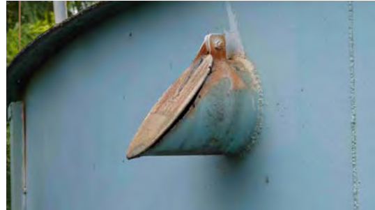
Foto 8 - Tubo Extravador.
