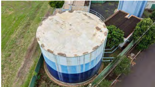
Foto 6 - Vista geral do reservatório.
