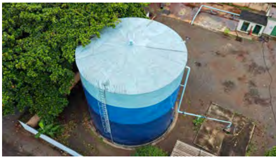
Foto 5 - Vista geral do reservatório.
