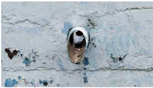
Foto 15 - Drenagem da laje.
