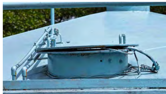
Foto 19 - Tampa de inspeção.
