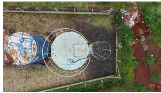
Foto 4 - Vista superior do reservatório.
