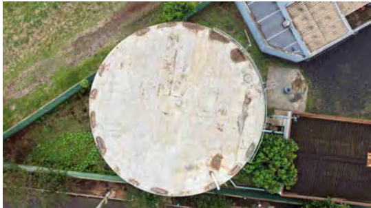
Foto 3 - Vista superior do reservatório.
