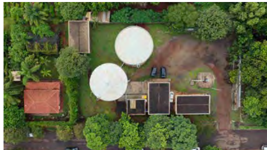
Foto 2 - Vista superior do reservatório.
