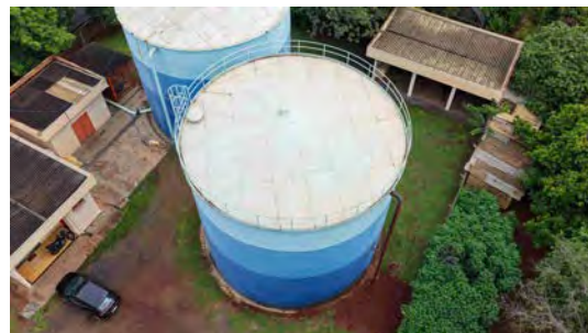
Foto 16 - Vista geral do reservatório.
