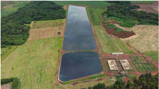
Foto 4 - Vista geral da ETE.
