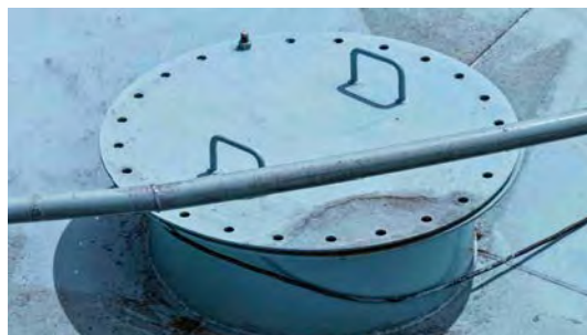
Foto 8 - Tampa de inspeção.
