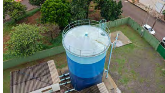
Foto 8 - Vista geral do reservatório 1.
