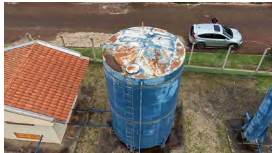
Foto 20 - Vista geral do reservatório apoiado.
