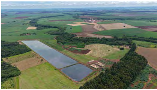
Foto 5 - Vista geral da ETE.
