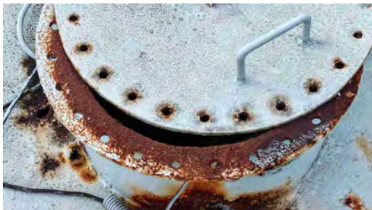
Foto 1 - Tampa de inspeção semiaberta.
