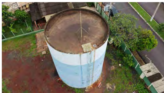
Foto 5 - Vista geral do reservatório de concreto.
