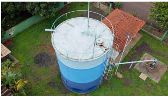
Foto 6 - Vista geral do reservatório.
