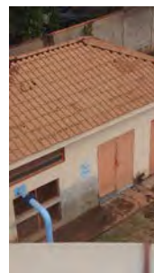
Foto 4 - Evidência do fechamento enviada pelo prestador por e-mail em 02/04/2026.
