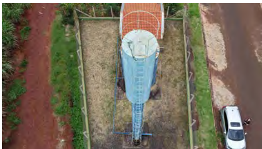
Foto 7 - Guarda-corpo do elevado.
