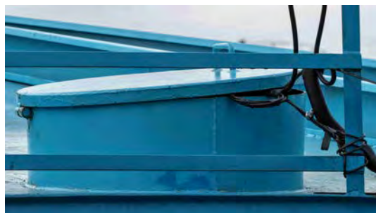
Foto 22 - Tampa de inspeção.
