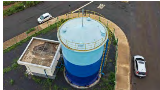
Foto 8 - Vista geral do reservatório.
