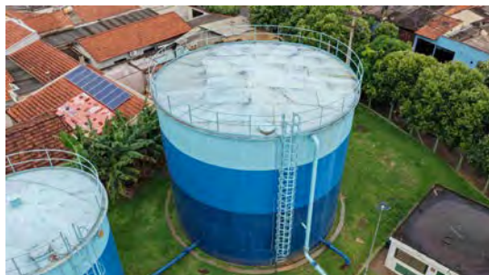
Foto 9 - Vista geral do reservatório.
