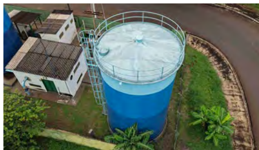
Foto 16 - Vista geral do reservatório 2.
