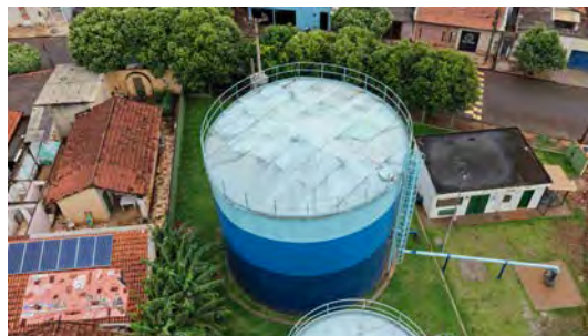
Foto 10 - Vista geral do reservatório.
