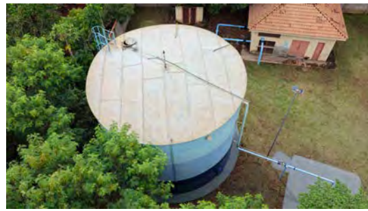
Foto 6 - Vista geral do reservatório.
