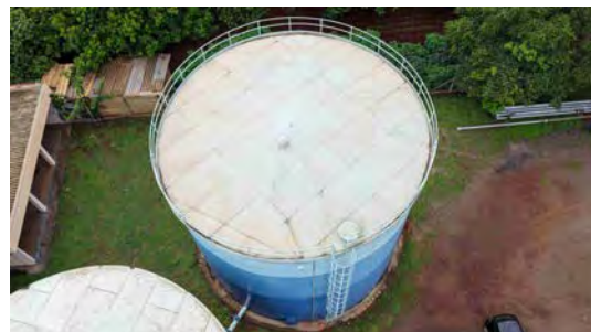
Foto 18 - Vista geral do reservatório.
