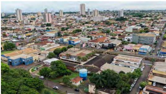
Foto 1 - Vista geral do reservatório.
