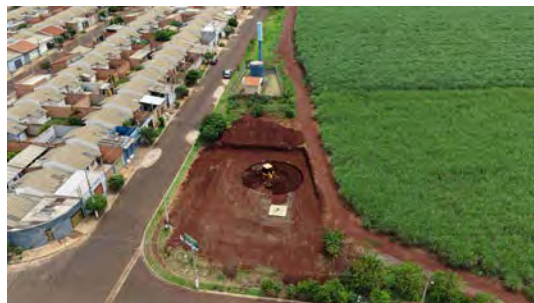
Foto 22 - Vista da obra do poço 55.
