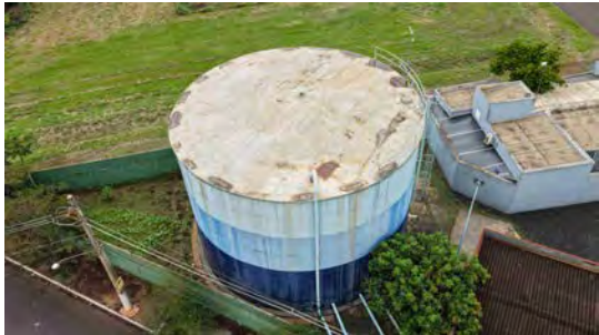
Foto 5 - Vista geral do reservatório.
