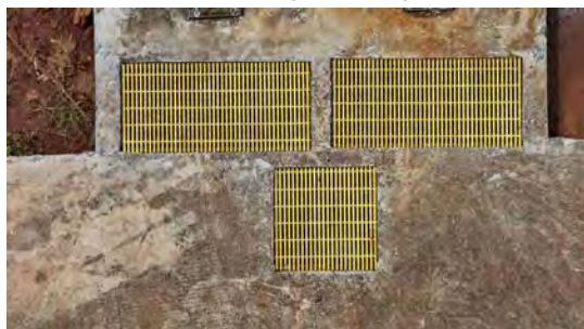
Foto 7 - Gradil de piso instalado para proteção.
