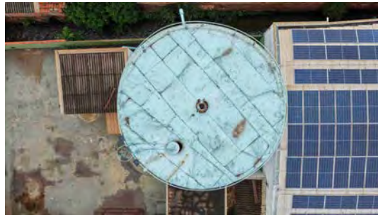
Foto 2 - Vista superior do reservatório.
