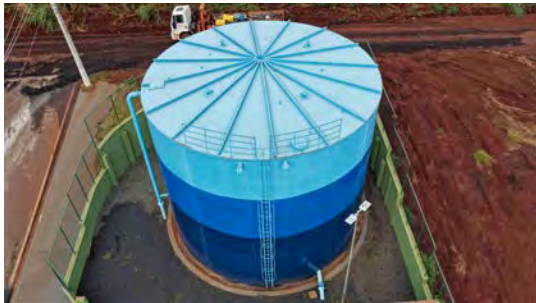
Foto 3 - Vista geral do reservatório.
