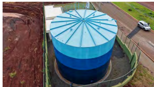
Foto 6 - Vista geral do reservatório.
