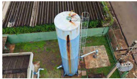
Foto 4 - Vista geral do reservatório.
