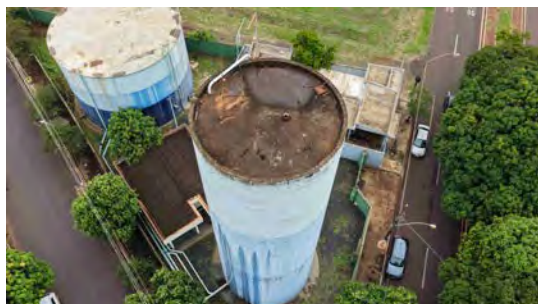
Foto 7 - Vista geral do reservatório.
