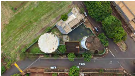
Foto 2 - Vista superior do reservatório.
