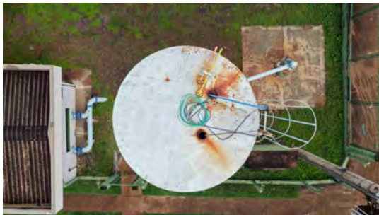
Foto 2 - Vista superior do reservatório.
