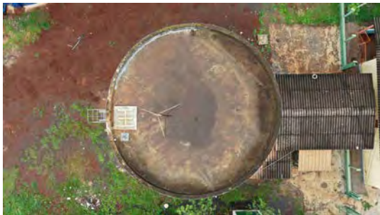
Foto 3 - Vista superior do reservatório de concreto.
