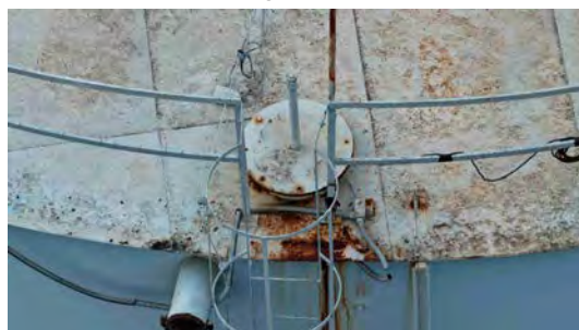
Foto 8 - Tampa de inspeção.
