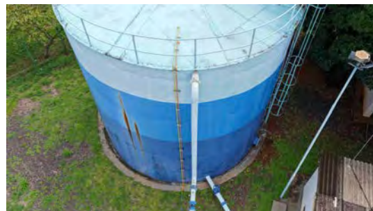
Foto 8 - Vista geral do reservatório.
