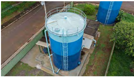
Foto 5 - Vista geral do reservatório 1.
