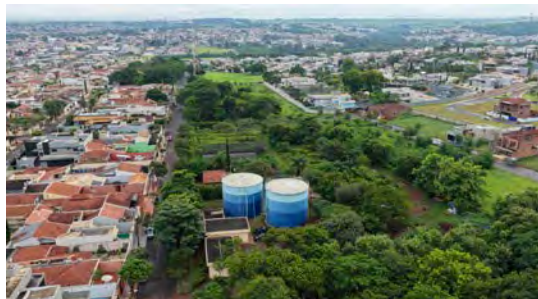
Foto 1 - Vista geral do reservatório.
