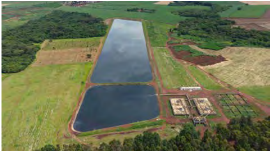
Foto 3 - Vista geral da ETE.
