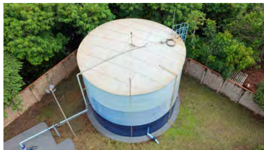
Foto 4 - Vista geral do reservatório.
