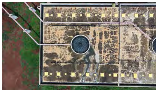
Foto 15 - Detalhes do UASB.
