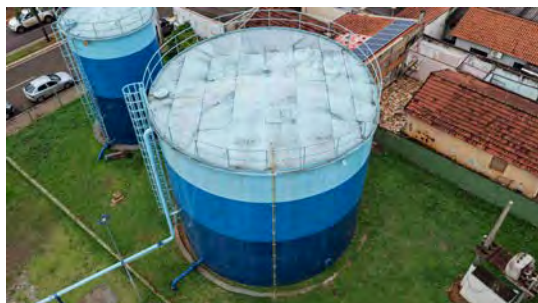
Foto 5 - Vista geral do reservatório.
