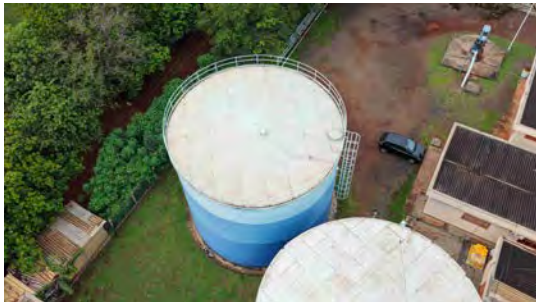
Foto 13 - Vista geral do reservatório.
