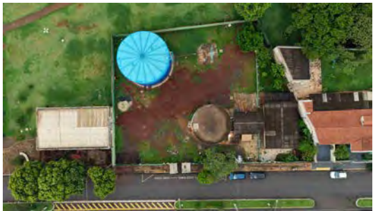
Foto 2 - Vista superior do reservatório.
