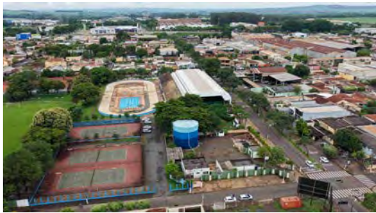
Foto 1 - Vista geral do reservatório.
