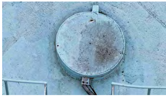
Foto 6 - Tampa de inspeção.
