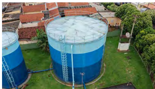
Foto 8 - Vista geral do reservatório.
