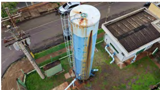
Foto 7 - Vista geral do reservatório.
