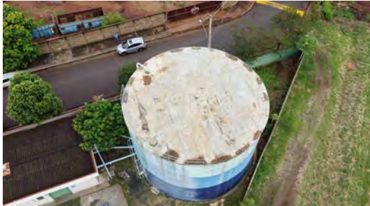
Foto 9 - Vista geral do reservatório.
