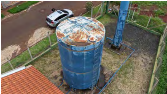
Foto 19 - Vista geral do reservatório apoiado.
