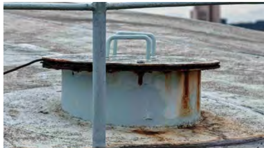
Foto 2 - Instalar barra de rodapé no guarda-corpo existente.
