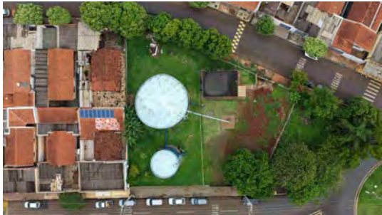
Foto 2 - Vista superior do reservatório.
