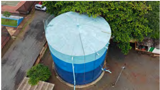
Foto 4 - Vista geral do reservatório.
