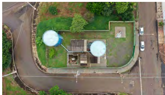
Foto 2 - Vista superior do reservatório.
