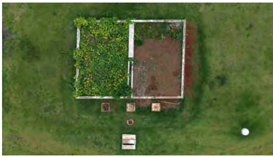
Foto 9 - Vista do tanque de secagem de lodo.
