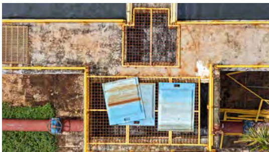
Foto 12 - Detalhe dos guarda-corpos do preliminar.
