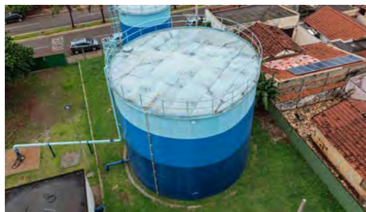
Foto 4 - Vista geral do reservatório.
