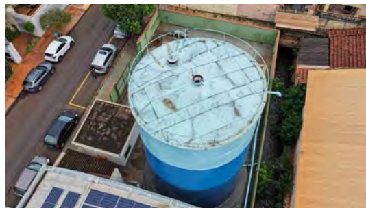
Foto 6 - Vista geral do reservatório.
