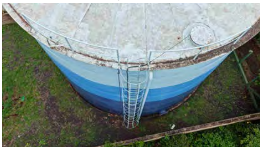
Foto 3 - Instalar barra de rodapé no guarda-corpo existente.
