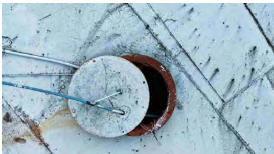
Foto 1 - Tampa de inspeção aberta.
