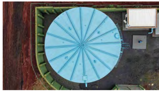
Foto 2 - Vista superior do reservatório.
