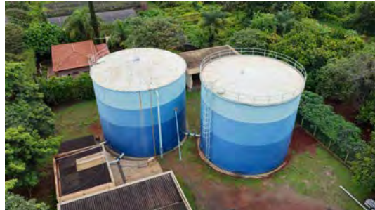
Foto 22 - Vista geral do reservatório.
