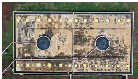
Foto 19 - Vista dos UASBs.
