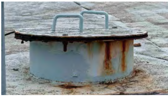
Foto 11 - Tampa de inspeção.
