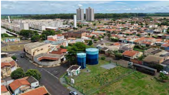
Foto 1 - Vista geral do reservatório.
