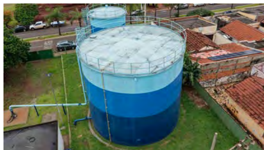
Foto 6 - Vista geral do reservatório.
