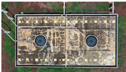
Foto 14 - Vista dos UASBs.
