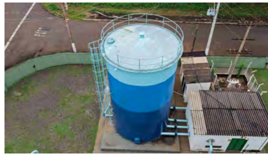
Foto 6 - Vista geral do reservatório 1.
