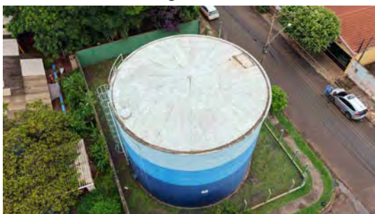
Foto 5 - Vista geral do reservatório.
