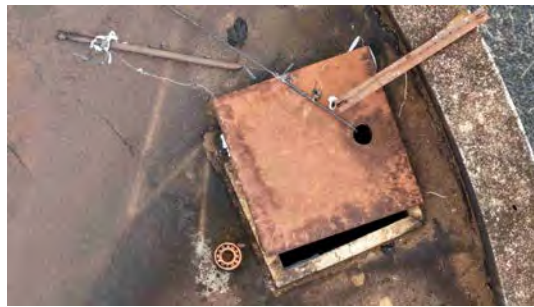
Foto 2 - Tampa de inspeção com buraco aberto.
