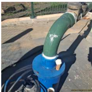
Foto 9 - Tubo de medição de nível
