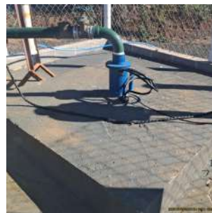
Foto 10 - Laje de proteção
