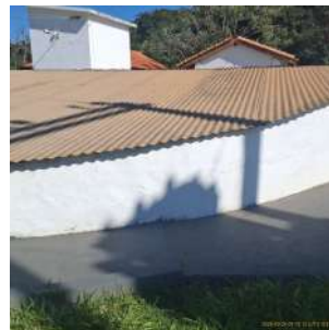
Foto 4 - Cobertura do reservatório Aurora II
