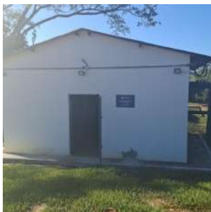
Foto 1 - Vista externa da casa de bombas
