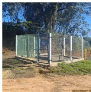
Foto 2 - Cercamento da área
