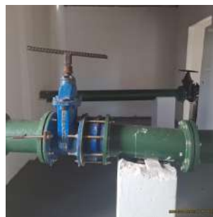
Foto 5 - Válvula de retenção substituídas
