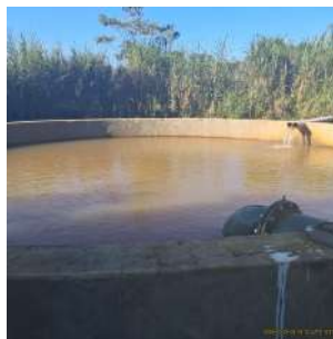
Foto 2 - Poço de sucção
