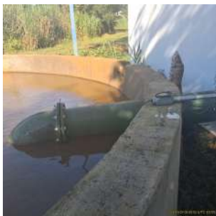
Foto 3 - Tomada de água
