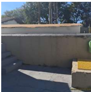
Foto 1 - Vista lateral do reservatório
