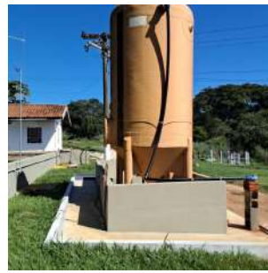
Foto 7 - Armazenamento de PAC
