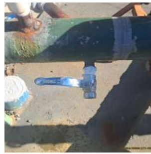
Foto 6 - Tomada para coleta de água bruta
