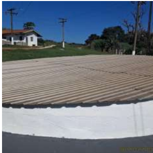
Foto 3 - Cobertura do reservatório Aurora I
