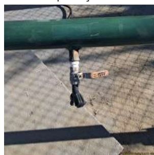
Foto 6 - Tomada para coleta de água bruta
