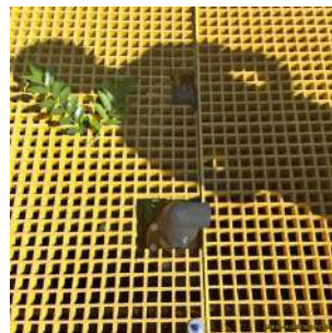
Foto 10 - Ventosa e válvula anti golpe de Ariete
