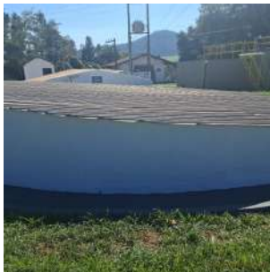
Foto 5 - Vista lateral do reservatório Aurora I
