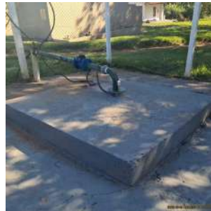
Foto 6 - Laje de proteção
