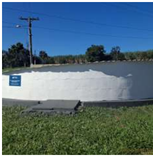
Foto 1 - Reservatório Aurora I
