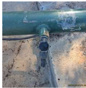
Foto 4 - Tomada para coleta de água bruta
