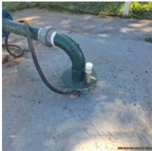
Foto 5 - Tubo de medição de nível
