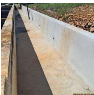
Foto 4 - Reformas realizadas na lateral dos floculadores
