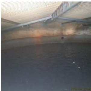
Foto 3 - Interior do reservatório Aurora II
