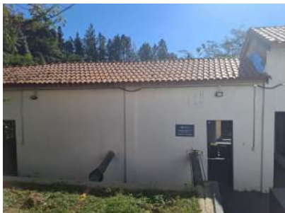
Foto 6 - Vista da reforma da EEAT (telhado)
