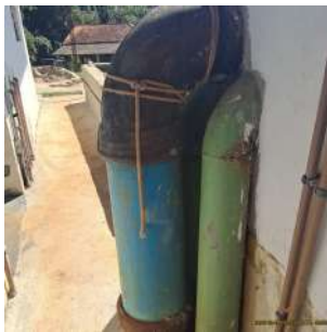
Foto 1 - Chegada da nova adutora de água bruta (Tubulação azul)
