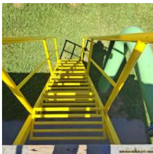
Foto 22 - Escada de acesso dos filtros
