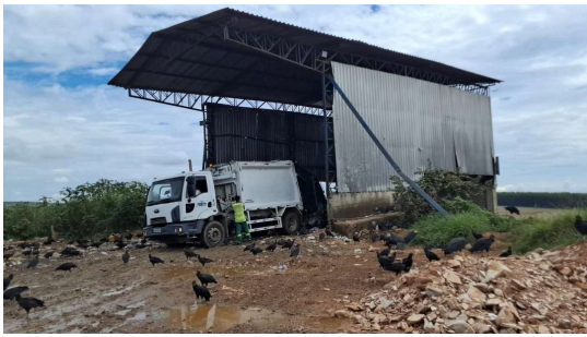
Foto 1 - Descarregamento de resíduos
