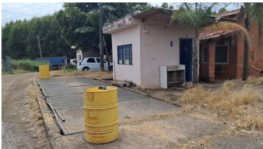
Foto 5 - Guarita e controle de acesso
