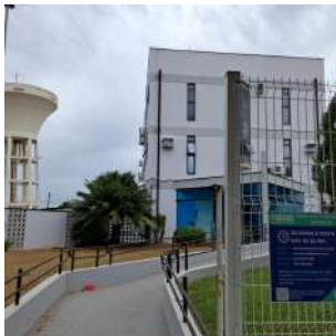
Foto 1 - Fachada entrada atendimento
