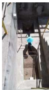
Foto 4 - Gradeamento preliminar e calha parshall.
