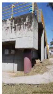
Foto 24 - Saída de esgoto tratado dos decantadores.
