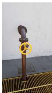
Foto 1 - Um dos pontos de descarte de lodo de um dos reatores
