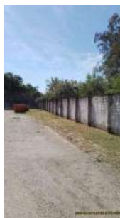
Foto 2 - Muro no perímetro.
