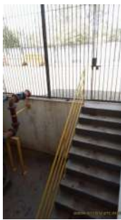
Foto 1 - Escada para acessar a casa de bombas.
