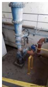
Foto 4 - Bomba submersa.
