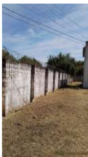
Foto 1 - Muro no perímetro.
