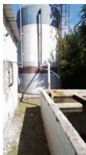
Foto 11 - Aplicação de hipoclorito de sódio.
