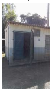
Foto 17 - Abrigo dos sopradores e do cloro.
