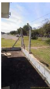
Foto 1 - Cercamento no perímetro.
