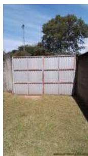
Foto 1 - Portão de acesso. Muro no perímetro.
