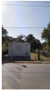
Foto 1 - Entrada da ETE Batovi.
