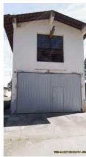
Foto 10 - Abrigo das centrífugas.
