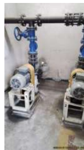
Foto 6 - Bombas centrífugas.
