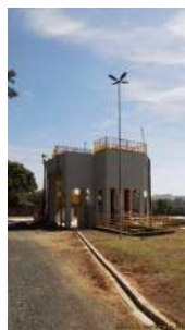
Foto 4 - Novo tratamento preliminar, cuja operação foi iniciada em 1º de abril. Por se tratar de uma nova unidade, que substituiu a antiga, foi elaborado formulário específico de investimentos para detalhar a unidade.
