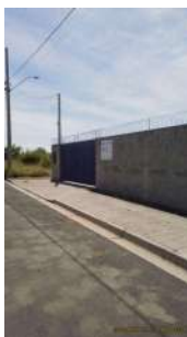
Foto 1 - Muro e portão de acesso.
