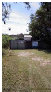
Foto 1 - Visão geral da elevatória.
