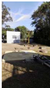
Foto 5 - Elevatória após as fossas.
