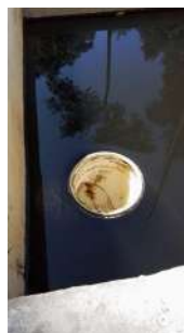
Foto 14 - Saída de efluente após a chicana de cloração.
