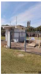
Foto 1 - Visão geral da elevatória.
