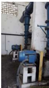
Foto 1 - Bombas centrífugas.
