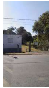
Foto 2 - Portão de acesso.
