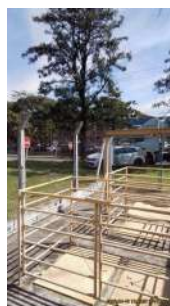
Foto 2 - Cercamento no perímetro.
