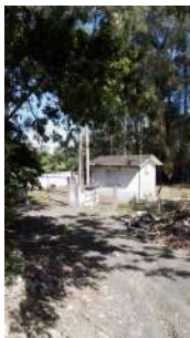
Foto 1 - Visão geral da elevatória.
