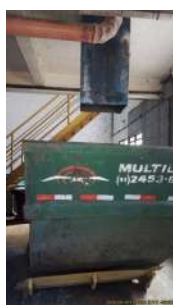
Foto 5 - Caçamba para disposição do lodo ressecado pelas centrífugas.
