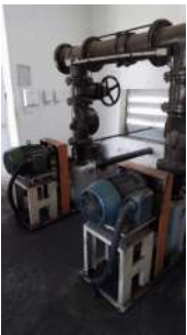
Foto 4 - Bombas centrífugas.
