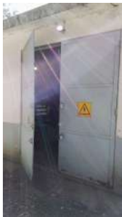
Foto 3 - Acesso à casa de bombas.
