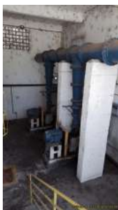
Foto 3 - Bombas centrífugas
