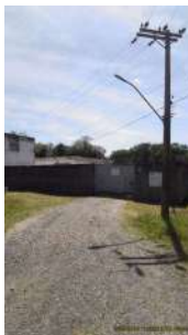
Foto 1 - Acesso à elevatória.
