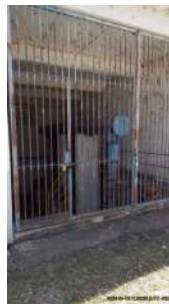
Foto 2 - Acesso à casa de bombas.
