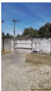
Foto 3 - Muro no perímetro e portão.
