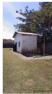
Foto 2 - Visão geral da elevatória.
