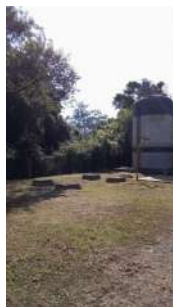
Foto 3 - Fossas, primeira etapa do tratamento.
