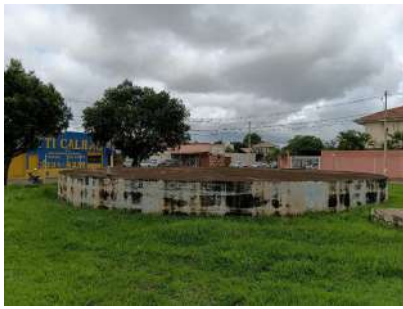
Foto 10 - Vista geral do reservatório.
