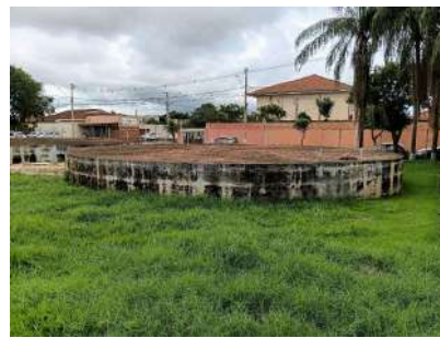
Foto 2 - Vista geral do reservatório.
