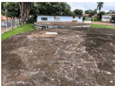
Foto 8 - Vista da parte superior do reservatório.
