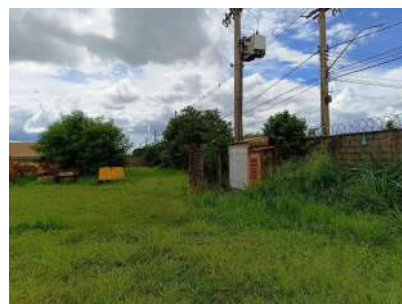
Foto 5 - Vista da área interna da unidade.
