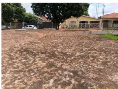
Foto 5 - Vista da parte superior do reservatório.
