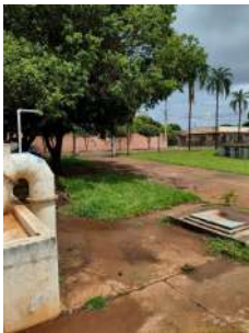
Foto 2 - Vista da área ao redor do reservatório, sendo possível visualizar cercamento da área com alambrado.
