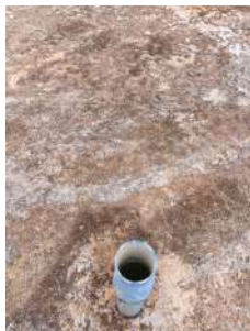
Foto 6 - Tubo de ventilação, protegido com tela, na parte superior do reservatório.
