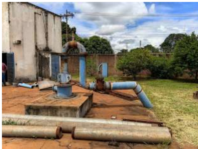
Foto 4 - Vista geral da captação.
