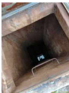
Foto 3 - Vista do interior do reservatório a partir da abertura da tampa de inspeção.
