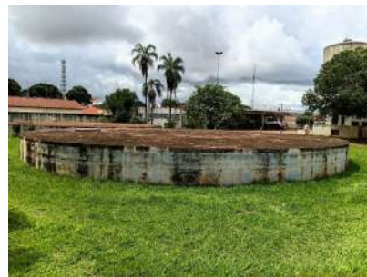
Foto 6 - Vista geral do reservatório.
