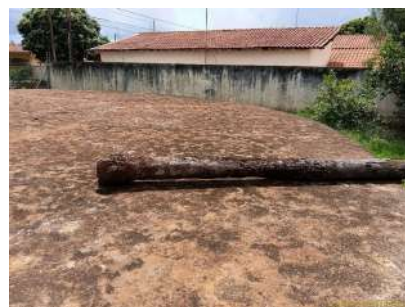
Foto 4 - Vista da parte superior do reservatório.
