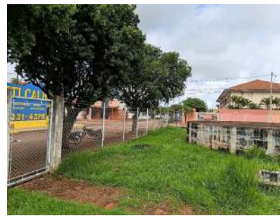
Foto 2 - Vista geral área interna da unidade, evidenciando cercamento do perímetro com alambrado de tela.
