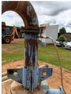
Foto 7 - Torneira para coleta de água bruta.
