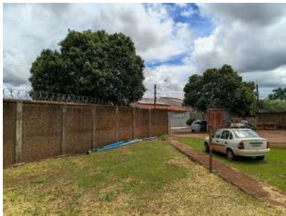
Foto 1 - Vista da área interna da unidade, evidenciando cercamento com muro com concertina e portão metálico.
