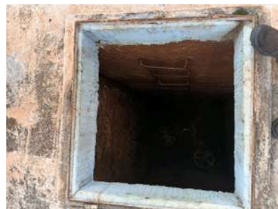
Foto 2 - Abertura para acesso ao recinto.
