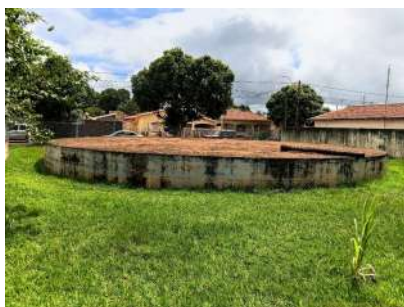
Foto 3 - Vista geral do reservatório.
