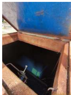
Foto 11 - Vista do interior do reservatório, a partir da abertura da tampa de inspeção.
