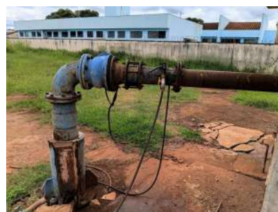
Foto 7 - Vista geral da captação.
