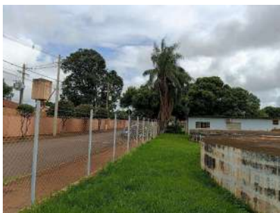
Foto 3 - Vista geral área interna da unidade, evidenciando cercamento do perímetro com alambrado de tela.
