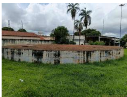
Foto 1 - Vista geral do reservatório.
