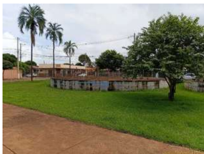
Foto 1 - Vista geral do reservatório.
