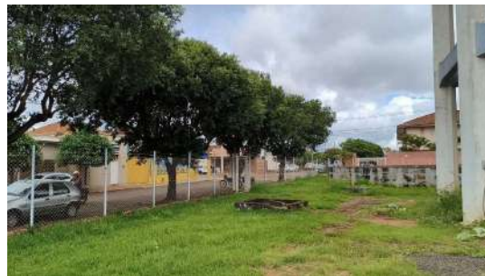
Foto 12 - Vista do cercamento da área.
