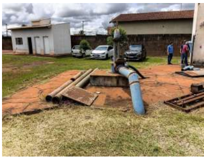
Foto 5 - Vista geral da captação.
