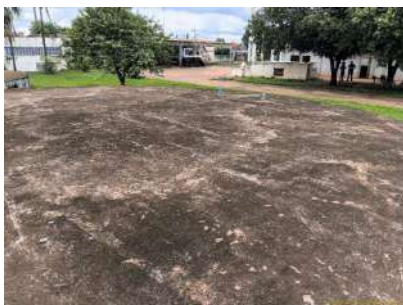
Foto 8 - Vista da parte superior do reservatório.
