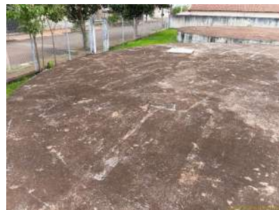
Foto 7 - Vista da parte superior do reservatório.
