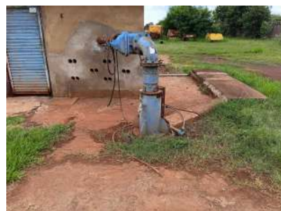
Foto 9 - Vista geral da captação.
