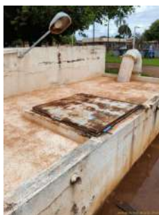
Foto 12 - Tampa de inspeção de um dos reservatórios.
