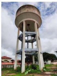
Foto 5 - Vista geral do reservatório.
