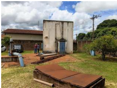
Foto 3 - Vista da área interna da unidade.
