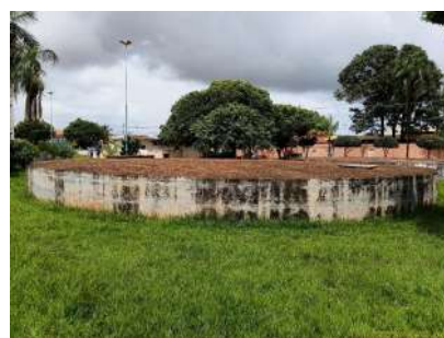
Foto 2 - Vista geral do reservatório.
