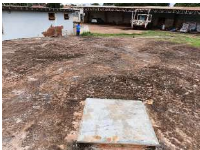
Foto 4 - Vista da parte superior do reservatório.
