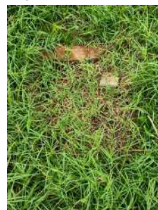
Foto 4 - Caixa de passagem com tampa quebrada e coberta por grama (risco de acidente).
