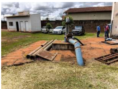
Foto 8 - Material depositado sobre a laje, ao redor da captação.
