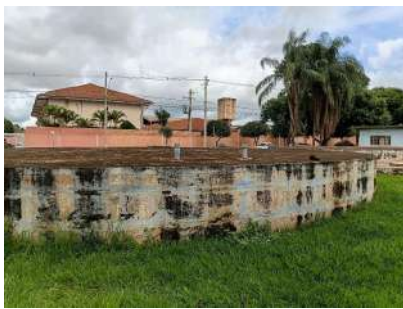
Foto 1 - Vista geral do reservatório.
