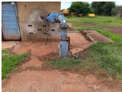
Foto 1 - Terra e vegetação em contato com o tubo da saída do poço.
