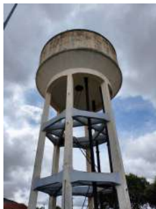
Foto 11 - Vista geral do reservatório
