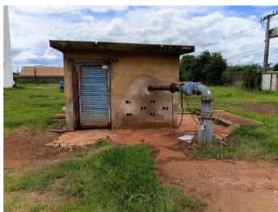
Foto 5 - Abrigo de alvenaria para reagentes químicos.
