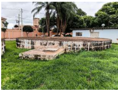
Foto 1 - Vista geral do reservatório. Adjacente a ele, observa-se na imagem estrutura de alvenaria com poço de acesso a registros de manobra do RSE 03 e RSE 04.
