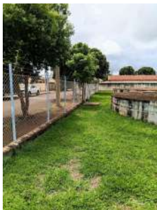
Foto 5 - Vista da área interna da unidade, evidenciando cercamento com alambrado.
