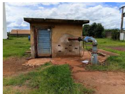
Foto 13 - Edificação em alvenaria adjacente ao poço, para abrigo dos reagentes utilizados no tratamento.
