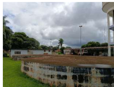
Foto 4 - Vista geral do reservatório.
