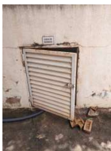
Foto 1 - Porta de acesso ao interior da EEA.
