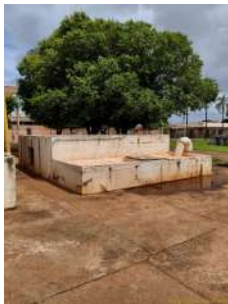
Foto 1 - Vista geral do reservatório.
