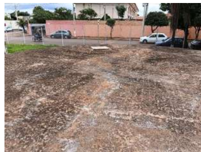
Foto 5 - Vista da parte superior do reservatório.
