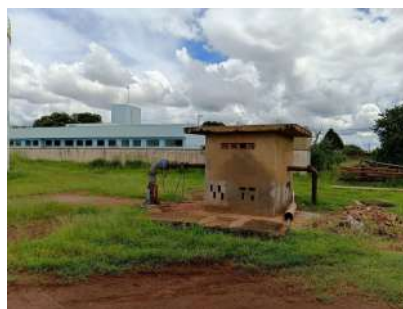
Foto 6 - Abrigo de alvenaria para reagentes químicos.
