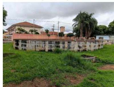
Foto 9 - Vista geral do reservatório.
