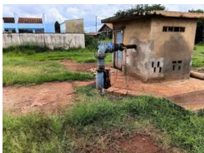
Foto 8 - Vista geral da captação.
