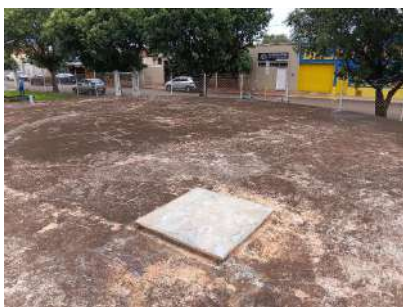
Foto 6 - Vista da parte superior do reservatório.
