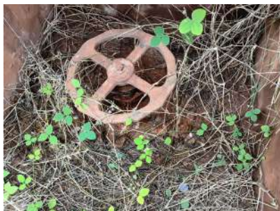
Foto 1 - Vazamento em registro localizado em caixa de passagem adjacente à captação.
