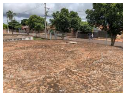
Foto 6 - Vista da parte superior do reservatório.
