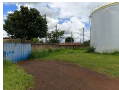
Foto 4 - Vista da área interna da unidade.
