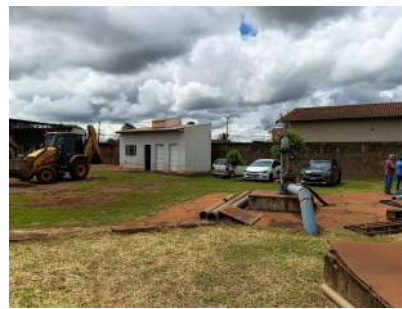
Foto 6 - Vista geral da captação.
