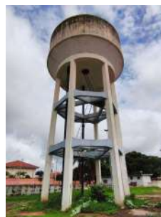
Foto 6 - Vista geral do reservatório.
