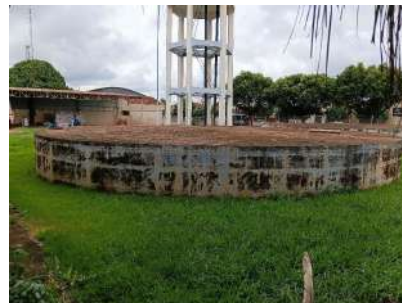
Foto 3 - Vista geral do reservatório.
