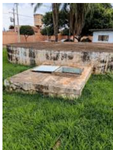
Foto 1 - Estrutura de alvenaria para acesso aos registros de manobra dos reservatórios semi enterrados 03 e 04.
