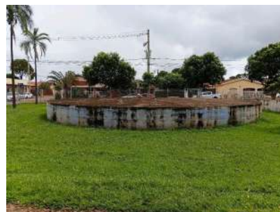
Foto 2 - Vista geral do reservatório.
