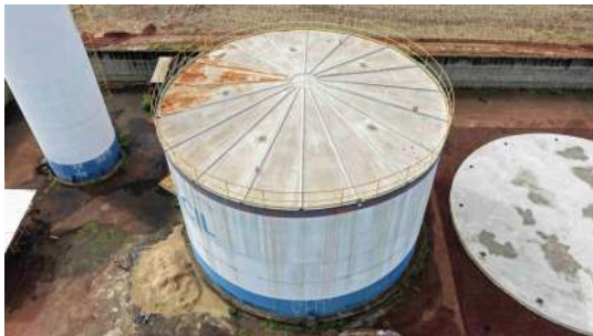
Foto 10 - Vista geral do reservatório.
