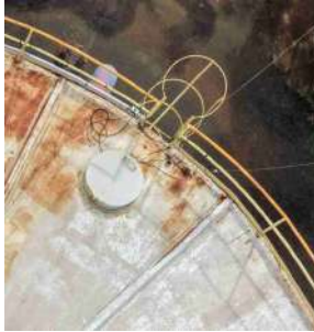
Foto 14 - Tampa de inspeção.
