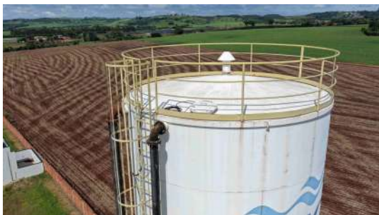
Foto 7 - Vista do topo do reservatório.
