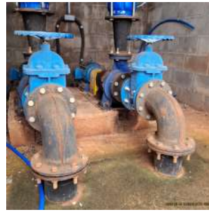
Foto 4 - Tubulação de recalque.
