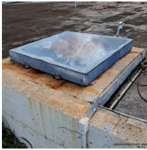
Foto 1 - Tamba de inspeção do reservatório 1.
