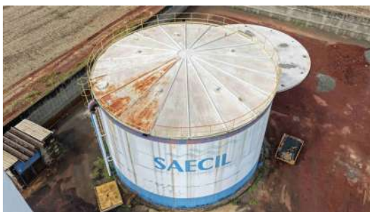
Foto 1 - Topo do reservatório.
