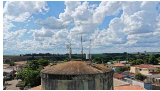
Foto 5 - Topo do reservatório, com destaque para o para-raios.
