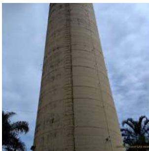
Foto 1 - Vista geral do reservatório.
