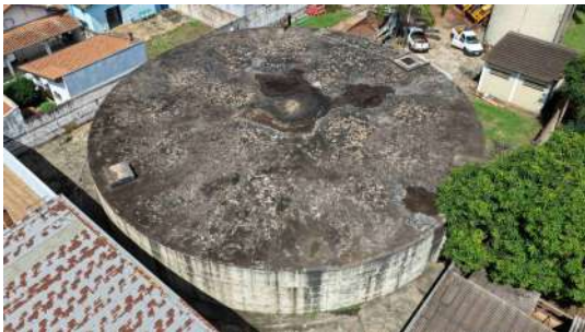
Foto 9 - Vista geral do reservatório.
