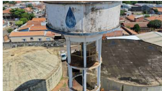
Foto 9 - Base do reservatório.
