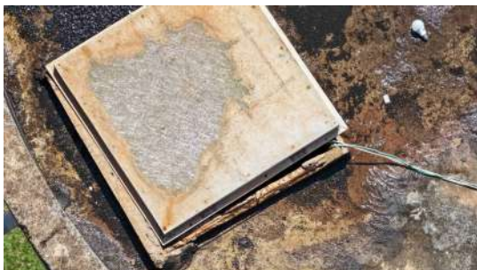
Foto 9 - Tapa de inspeção.
