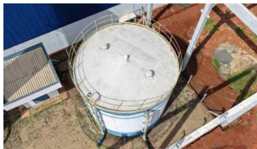
Foto 4 - Topo do reservatório.
