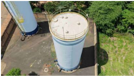
Foto 9 - Vista lateral do Reservatório 2
