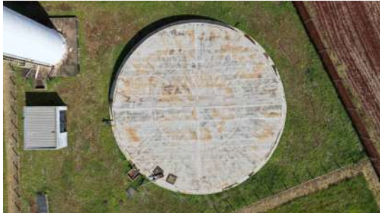
Foto 5 - Vista do topo do reservatório.
