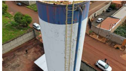
Foto 9 - Escada de acesso ao topo.
