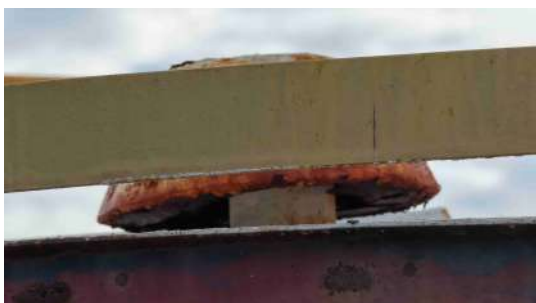
Foto 10 - Tubo de ventilação.
