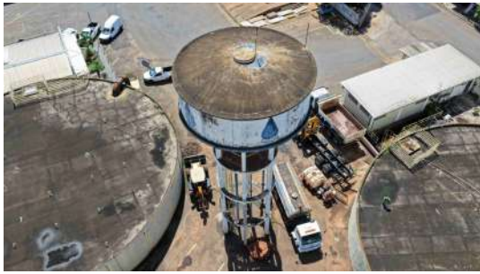
Foto 4 - Vista geral do reservatório.
