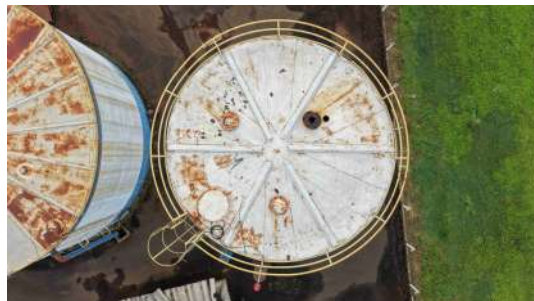
Foto 2 - Topo do reservatório com destaque para tampa de inspeção e tubulação de ventilação.
