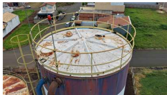
Foto 4 - Vista geral do local de abertura.
