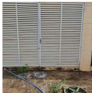
Foto 6 - Edificação que abriga as motobombas.
