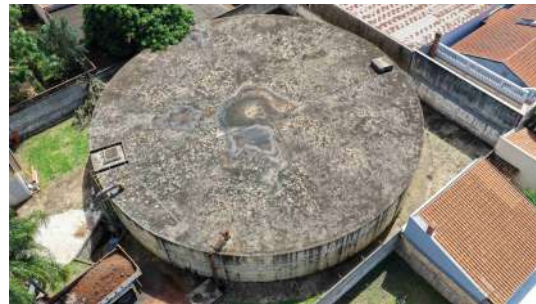
Foto 10 - Vista do topo do reservatório
