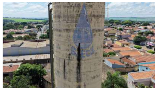
Foto 14 - Vista lateral do reservatório.
