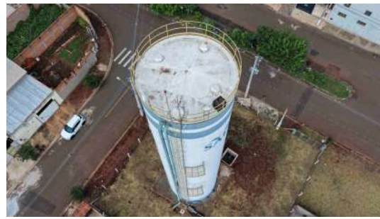
Foto 4 - Tubulação de entrada de água e tubo extravasor.
