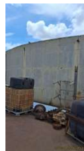
Foto 5 - Vista lateral do reservatório 2.
