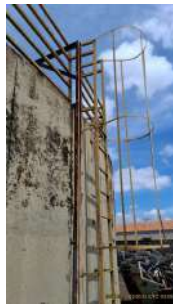
Foto 3 - Escada de acesso ao topo do reservatório 1.
