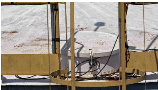
Foto 8 - Tampa de inspeção.
