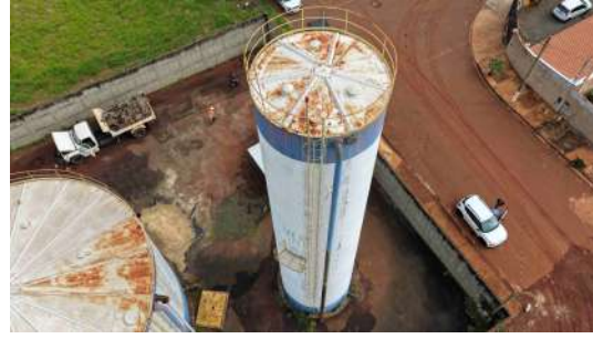
Foto 2 - Topo do reservatório.
