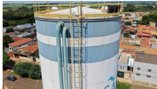
Foto 7 - Escada de acesso ao topo.
