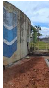
Foto 4 - Vista lateral do Reservatório 1.
