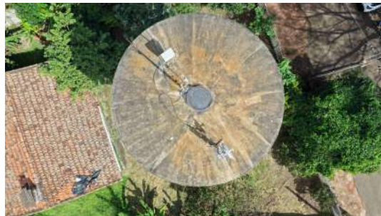
Foto 2 - Topo do reservatório.
