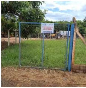
Foto 1 - Placa de identificação e cercamento.
