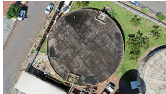
Foto 12 - Vista superior do Reservatório 1.
