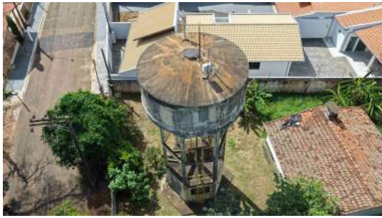
Foto 4 - Vista geral do reservatório.
