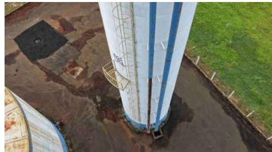
Foto 9 - Escada de acesso ao topo do reservatório.
