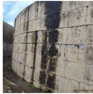
Foto 4 - Vista lateral do reservatório.
