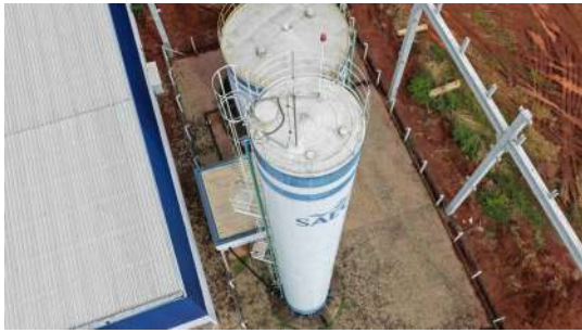
Foto 4 - Vista geral do reservatório.
