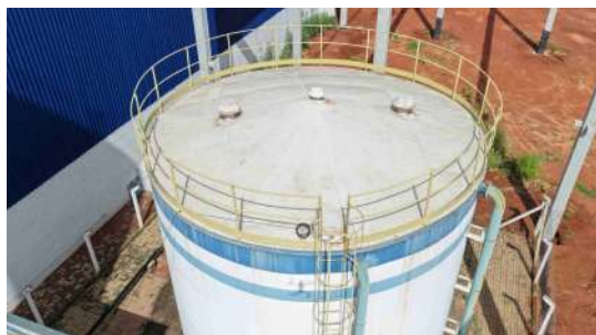
Foto 5 - Escada de acesso ao topo do reservatório.
