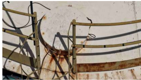
Foto 10 - Tampa de inspeção do Reservatório 2.
