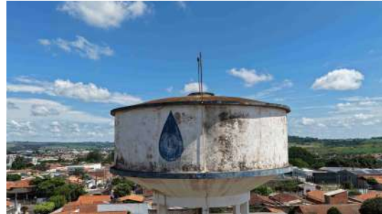
Foto 7 - Vista lateral do reservatório.
