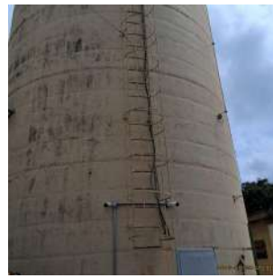
Foto 6 - Escada de acesso ao topo.
