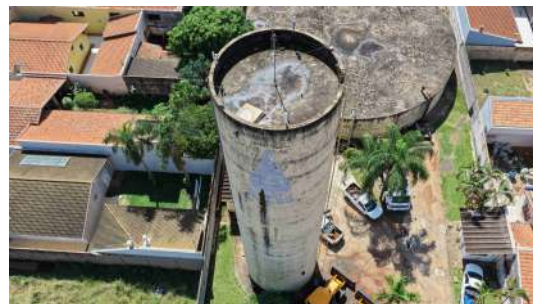
Foto 10 - Vista geral do reservatório.
