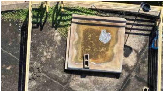
Foto 13 - Tampa de inspeção do Reservatório 1.
