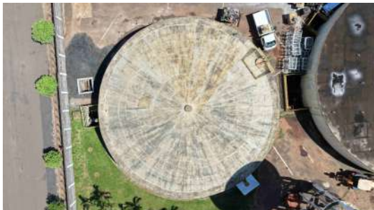
Foto 15 - Vista superior do Reservatório 2.
