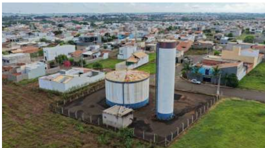
Foto 1 - Vista do entorno do local onde se encontra instalado o reservatório.
