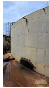
Foto 9 - Vista lateral do Reservatório 3.
