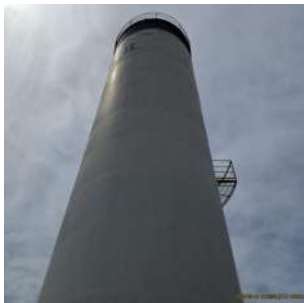
Foto 1 - Vista geral do reservatório.
