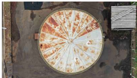
Foto 2 - Topo do reservatório.
