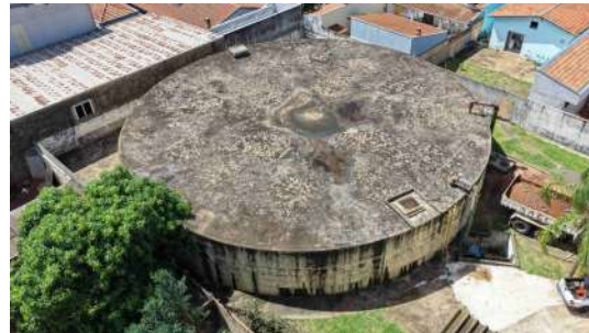
Foto 8 - Vista geral do reservatório.
