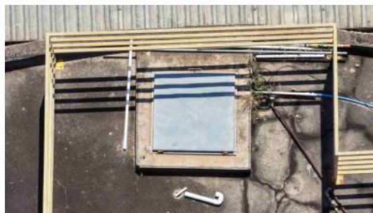
Foto 18 - Tampa de inspeção do Reservatório 3.
