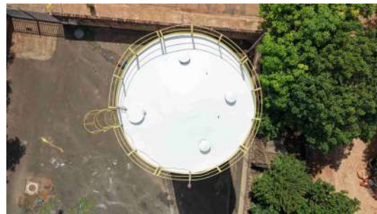
Foto 2 - Topo do Reservatório 1, com destaque para os tubos de ventilação, a tampa de inspeção e o guarda-corpo.
