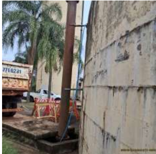
Foto 5 - Tubo extravasador.
