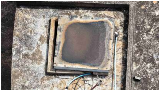
Foto 11 - Tampa de inspeção.
