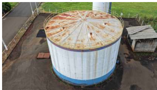
Foto 3 - Topo do reservatório com destaque para tampa de inspeção, tubo de ventilação e guarda corpo.
