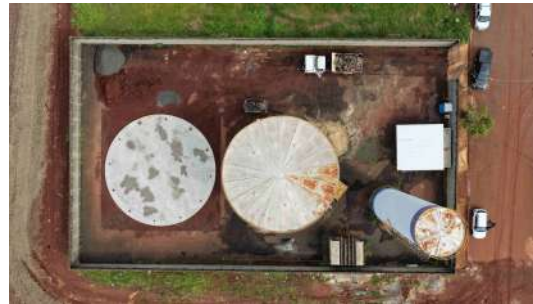
Foto 7 - Vista geral dos dois reservatórios. Além disso é mostrado a base onde será instalado um novo reservatório para o atendimento a um novo empreendimento.
