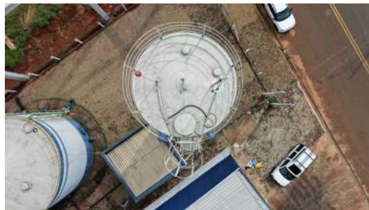
Foto 2 - Topo do reservatório.
