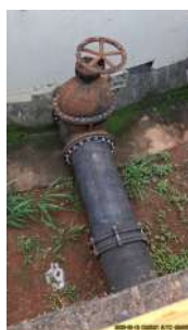
Foto 6 - Tubulação que interliga os reservatórios.
