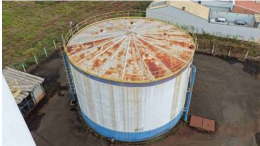
Foto 6 - Tubulação de entrada de água e extravasor.
