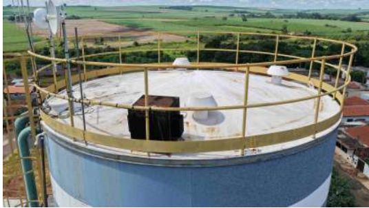
Foto 5 - Topo do reservatório com destaque para tampa de inspeção, tubo de ventilação e guarda corpo.
