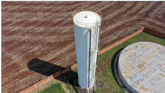
Foto 5 - Vista geral do reservatório.
