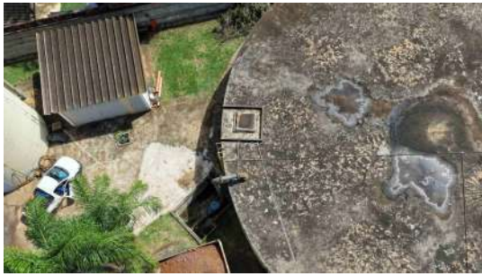
Foto 13 - Vista do local de entrada de água.
