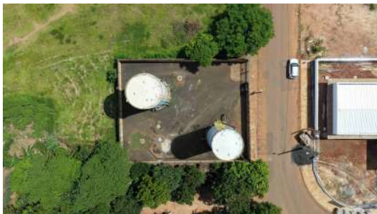
Foto 1 - Vista superior dos dois reservatórios.
