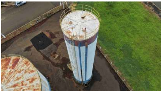
Foto 3 - Tubo extravasor e tubulação de entrada de água recalçada pela estação elevatória.
