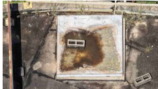
Foto 14 - Tampa de inspeção do Reservatório 1.
