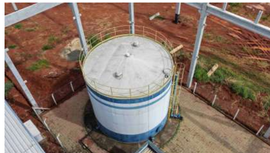
Foto 2 - Vista geral do reservatório.
