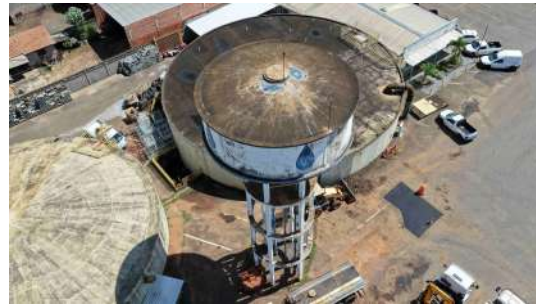
Foto 5 - Vista geral do reservatório.
