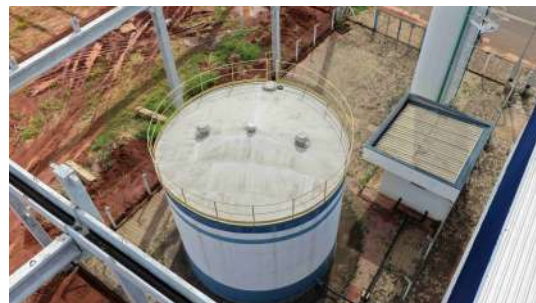
Foto 3 - Topo do reservatório, com destaque para a tubulação de ventilação, tampa de inspeção e
