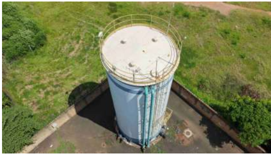
Foto 7 - Vista geral do Reservatório 2.
