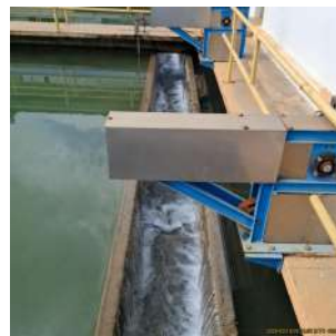
Foto 15 - Condução da água em direção aos filtros.
