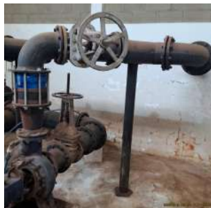
Foto 1 - Tubulação de recalque.
