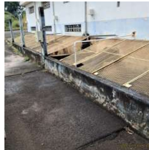
Foto 4 - Área de drenagem.
