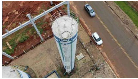
Foto 5 - Topo do reservatório.
