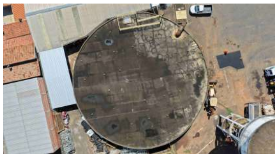
Foto 17 - Vista superior do Reservatório 3.
