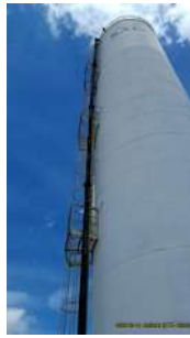
Foto 1 - Vista geral do reservatório.
