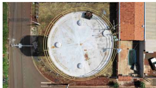
Foto 2 - Topo do reservatório.
