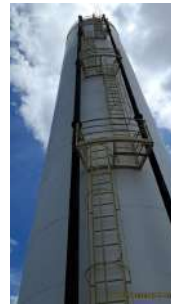
Foto 2 - Escada de acesso ao topo.
