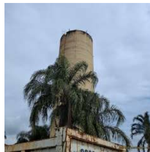
Foto 2 - Vista do topo do reservatório.
