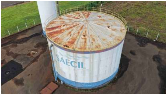
Foto 4 - Vista geral do reservatório.
