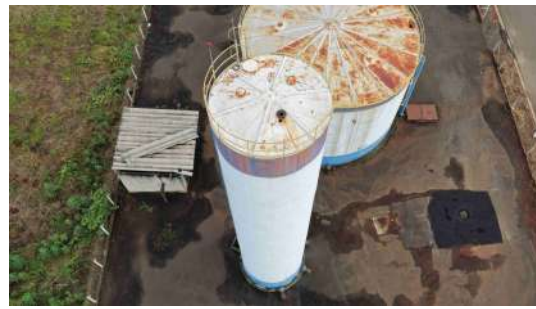
Foto 4 - Vista geral do reservatório.
