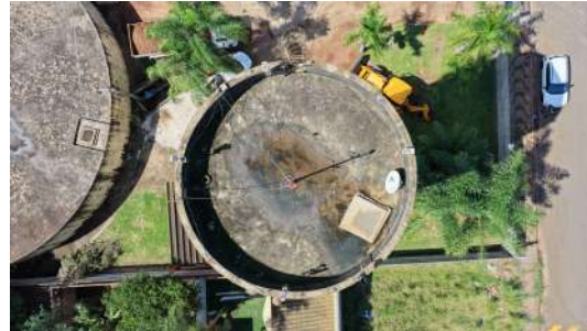
Foto 8 - Topo do reservatório.
