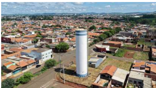
Foto 1 - Vista do entorno do local onde se encontra instalado o reservatório.
