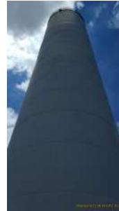
Foto 4 - Vista lateral, destacando o tubo extravasador.
