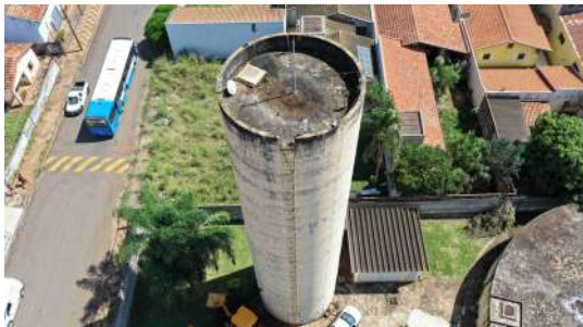
Foto 11 - Vista geral do reservatório.
