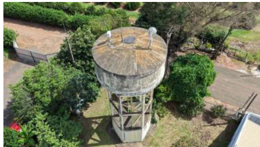
Foto 3 - Vista geral do reservatório.
