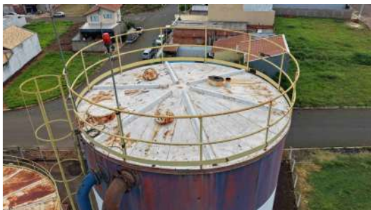
Foto 6 - Topo do reservatório.
