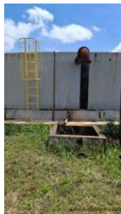
Foto 1 - Escada de acesso ao topo e tubulação de entrada de água.
