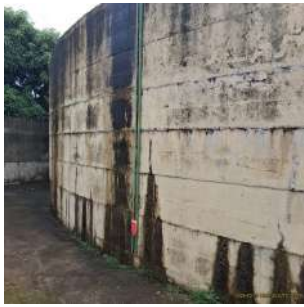
Foto 3 - Vista lateral do reservatório.
