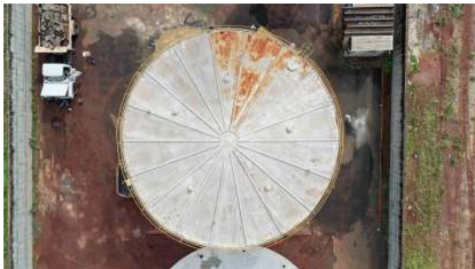
Foto 8 - Vista superior do reservatório.
