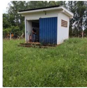
Foto 2 - Edificação que abriga o conjunto de motobombas.
