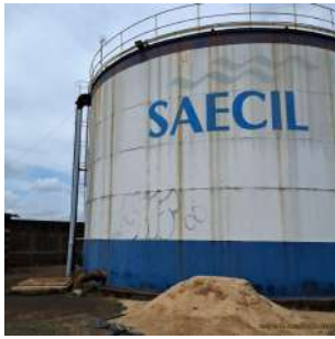
Foto 3 - Tubo de entrada de água e tubo extravasor .
