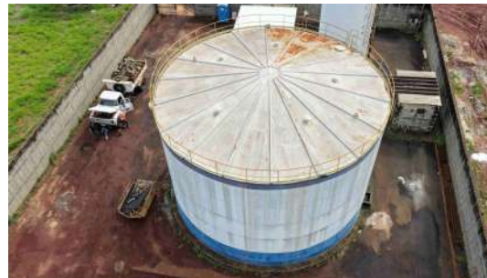
Foto 9 - Vista geral do reservatório.
