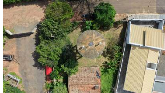
Foto 7 - Vista do topo do reservatório.
