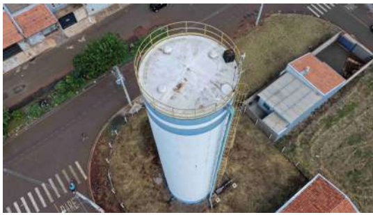
Foto 3 - Topo do reservatório.
