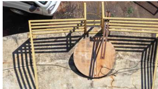
Foto 16 - Tampa de inspeção do Reservatório 2.
