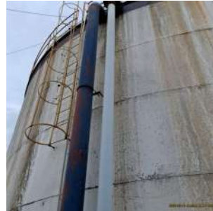
Foto 5 - Escada de acesso ao topo do reservatório.
