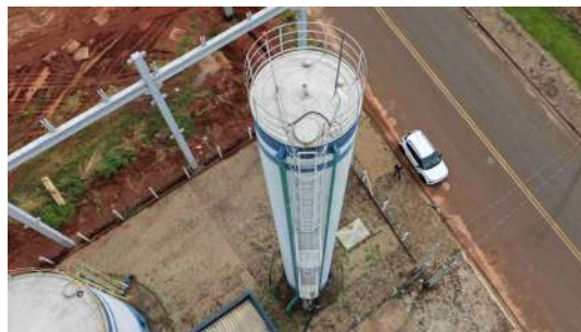
Foto 3 - Vista geral do reservatório.
