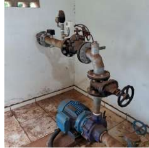
Foto 4 - Tubulação de recalque.
