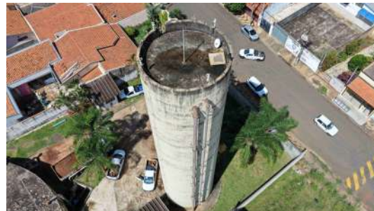
Foto 12 - Tubulação de entrada de água e tubo extravasador.
