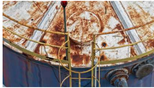
Foto 6 - Tampa de inspeção.
