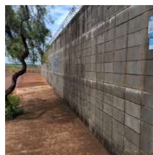
Foto 2 - Cercamento da área em que o reservatório está instalado.
