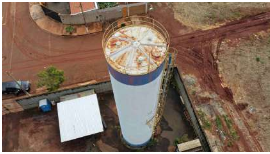
Foto 5 - Vista do topo do reservatório.
