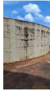
Foto 2 - Vista lateral do Reservatório 1.
