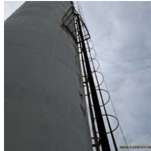
Foto 4 - Escada de acesso ao topo do reservatório.
