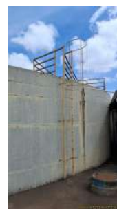
Foto 7 - Escada de acesso ao topo do reservatório 2.
