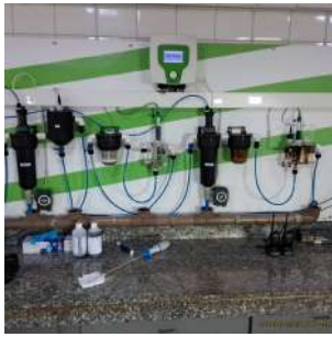
Foto 7 - Medidores automáticos para análise dos principais parâmetros de qualidade da água.
