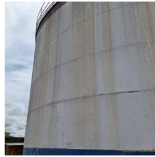
Foto 4 - Vista lateral do reservatório.
