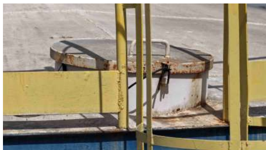
Foto 7 - Tampa de inspeção.
