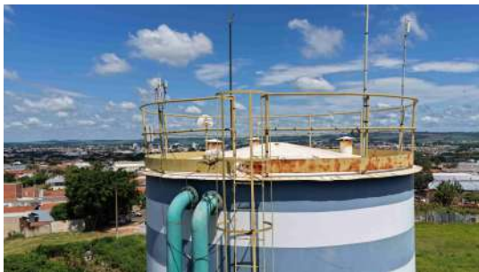
Foto 11 - Topo do Reservatório 2, com destaque para o para-raios e o guarda-corpo.
