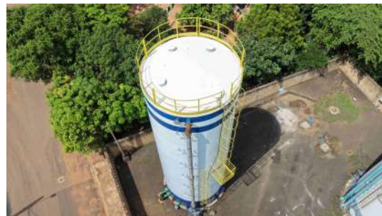
Foto 4 - Escada de acesso ao topo, tubulação de entrada de água e tubo extravasor (com tela de proteção).
