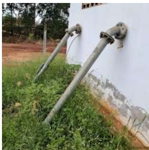
Foto 7 - Tubulação de recalque.
