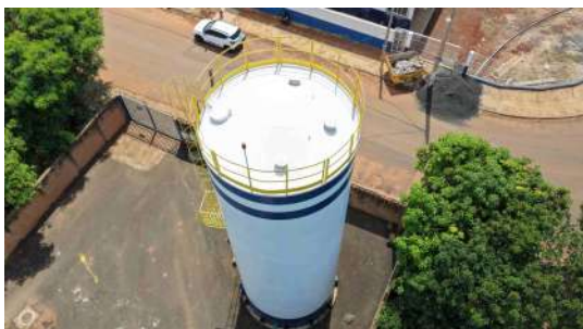
Foto 5 - Vista geral do Reservatório 1.
