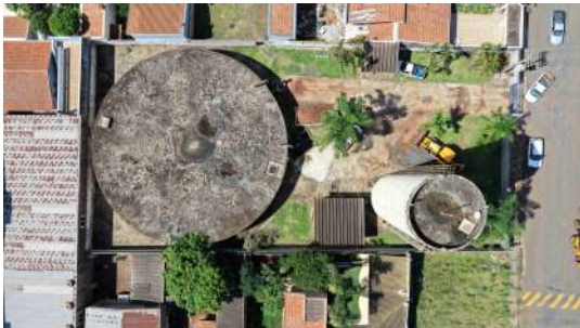
Foto 7 - Vista dos dos reservatórios.
