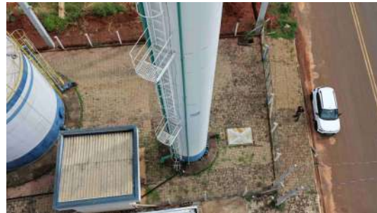
Foto 9 - Escada de acesso ao topo, tubo extravasor e tubulação de entrada de água recalçada pela estação elevatória.
