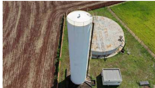
Foto 6 - Vista geral do reservatório.
