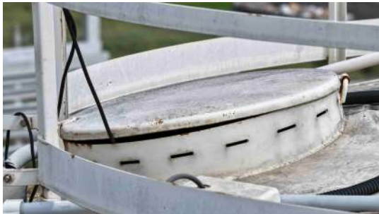
Foto 8 - Tampa de inspeção.
