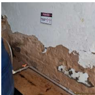
Foto 23 - Placa de identificação de produto químico.
