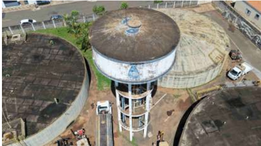
Foto 6 - Vista geral do reservatório.
