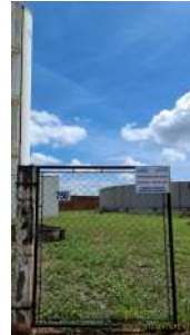
Foto 6 - Cercamento da estação.
