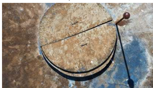
Foto 3 - Tampa de inspeção.
