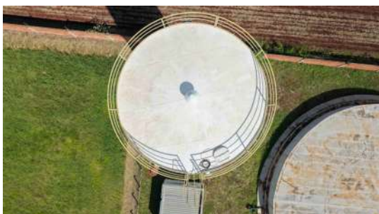
Foto 9 - Vista do topo do reservatório, com destaque para a tampa de inspeção e guarda corpo.
