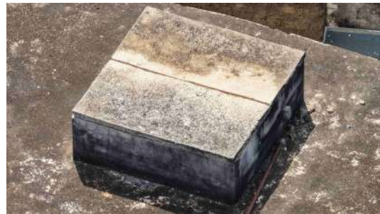
Foto 12 - Tampa de inspeção.
