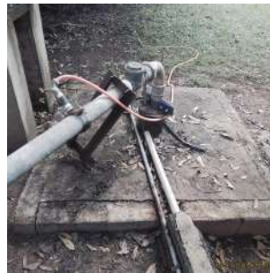
Foto 2 - Laje de proteção do poço
