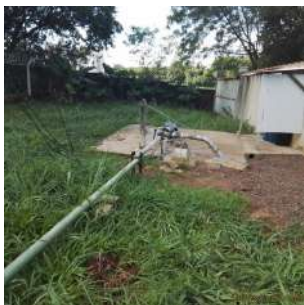
Foto 1 - Vista geral do poço
