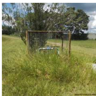
Foto 1 - Vista geral do poço
