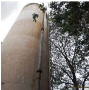
Foto 7 - Vista lateral do Reservatório Elevado
