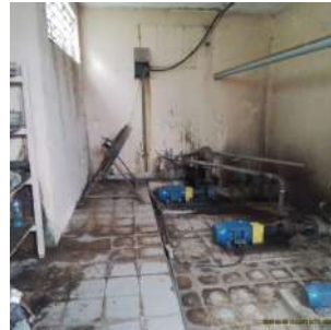
Foto 7 - Vista geral interna da casa de bombas
