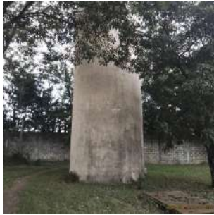
Foto 3 - Vista frontal do reservatório
