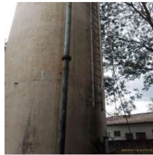
Foto 6 - Vista lateral do Reservatório Elevado
