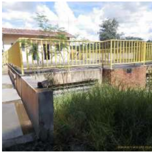
Foto 1 - Mato alto ao redor do reservatório
