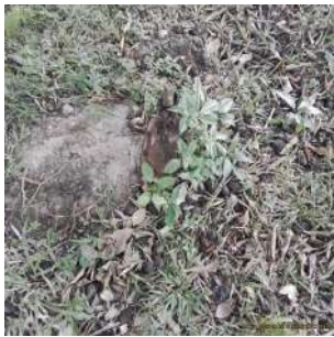
Foto 5 - Válvula de fechamento
