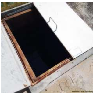
Foto 3 - Tampa de Inspeção de acesso ao reservatório
