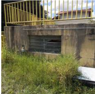
Foto 3 - Mato alto ao redor do reservatório
