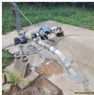
Foto 2 - Vista geral do poço
