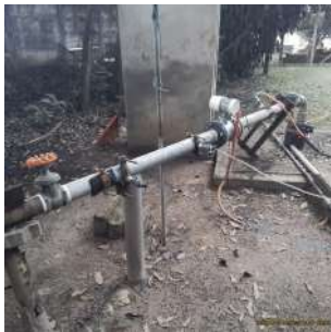
Foto 1 - Vista geral do poço
