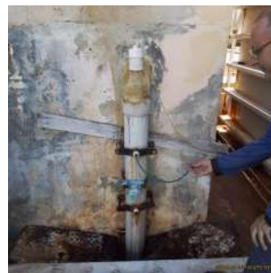
Foto 32 - Mangueira verde é de fluor (não dosado) e de a transparente de hipoclorito de sódio
