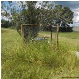
Foto 1 - Mato alto em torno do Poço 7
