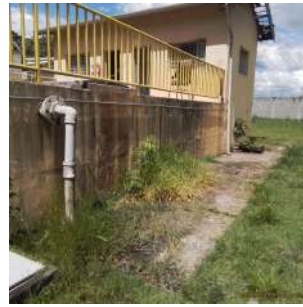
Foto 2 - Mato alto ao redor do reservatório
