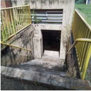
Foto 1 - Entrada da Casa de Bombas
