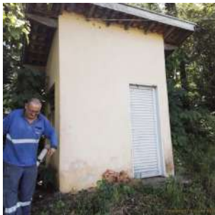
Foto 5 - Casa de bombas
