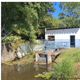
Foto 7 - Tomada de água
