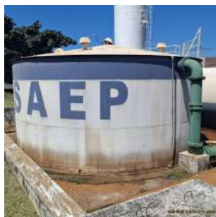
Foto 3 - Reservatório apoiado Santa Fé (R100)
