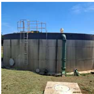
Foto 1 - Vista frontal do reservatório apoiado Santa Fé
