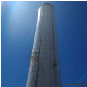
Foto 3 - Escada de acesso e guarda-corpo
