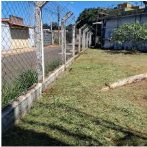
Foto 4 - Cercamento da área dos reservatórios e ETA Santa Fé
