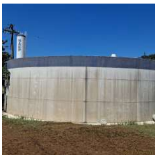
Foto 4 - Vista lateral do reservatório apoiado Santa Fé
