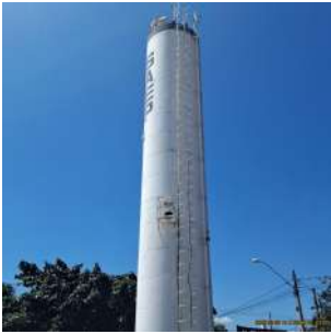
Foto 1 - Reservatório elevado ETA Santa Fé
