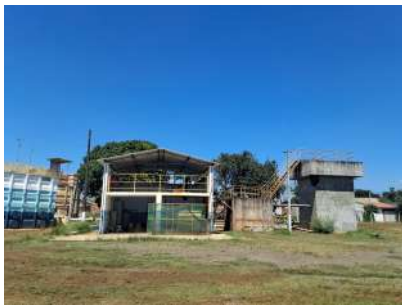
Foto 1 - Vista frontal do sistema de tratamento de lodo fora de operação
