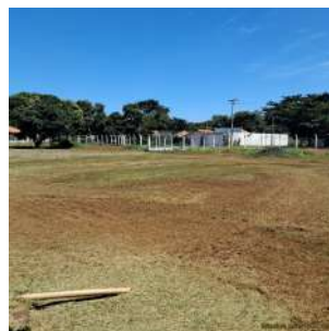
Foto 5 - Vista da limpeza da área
