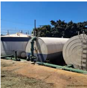
Foto 1 - Vista lateral dos reservatórios apoiados ETA Santa Fé (R100,R85,R50)
