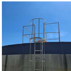
Foto 2 - Escada de acesso e guarda-corpo
