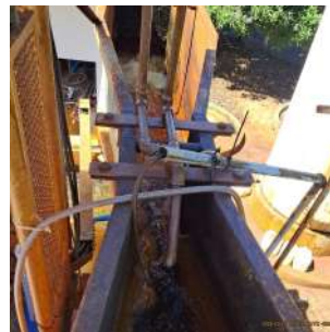
Foto 17 - Dosagem de PAC
