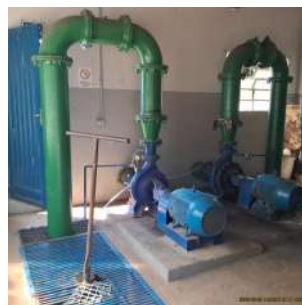
Foto 8 - Vista do interior da captação Córrego da Barra
