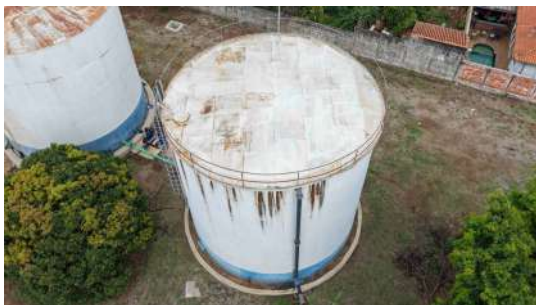
Foto 5 - Vista geral reservatório apoiado 1, indicando tubo de alimentação.
