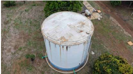
Foto 3 - Vista geral reservatório apoiado 1, indicando escada e guarda corpo.
