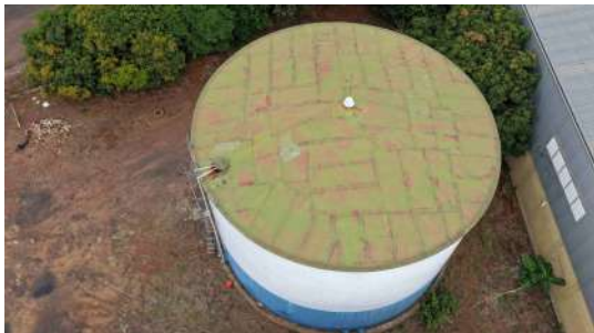
Foto 15 - Vista geral reservatório 1.
