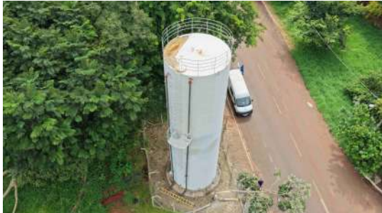
Foto 6 - Vista geral do reservatório.
