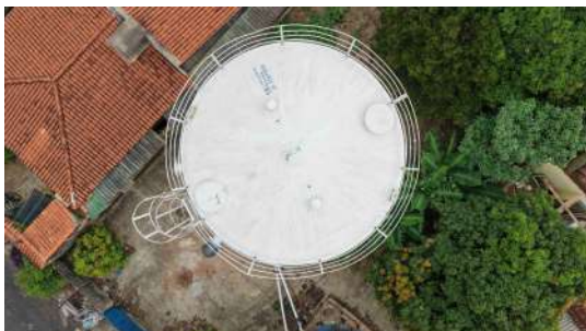
Foto 15 - Reservatório cilíndrico: vista superior.
