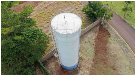
Foto 8 - Vista geral do reservatório.
