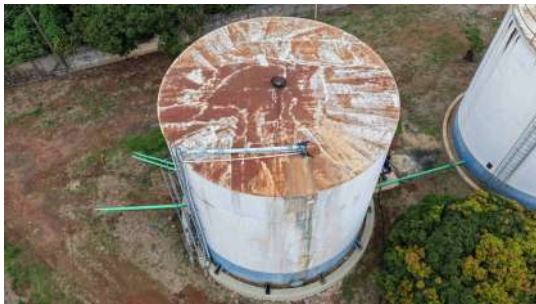
Foto 11 - Vista geral reservatório apoiado 2. Escada com guarda corpo à esquerda e abertura de ventilação no centro da parte superior.
