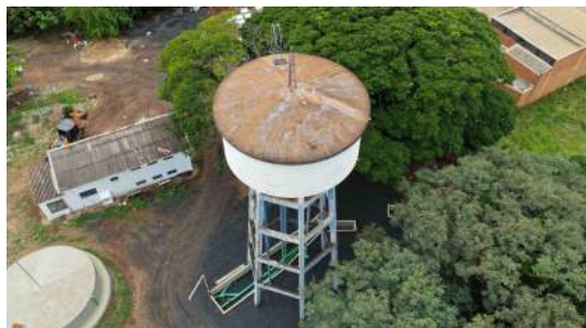
Foto 1 - Vista geral do reservatório.
