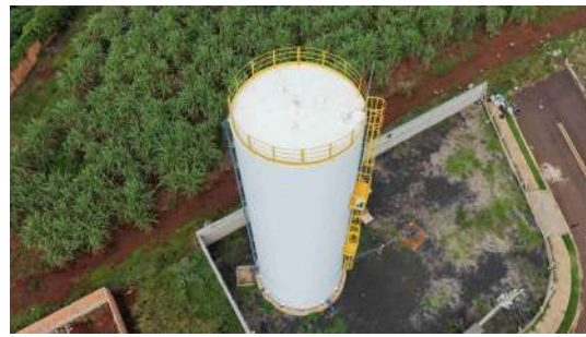
Foto 4 - Vista lateral do reservatório.
