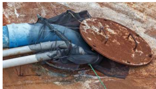
Foto 15 - Tampa de inspeção na parte superior do reservatório apoiado 2.
