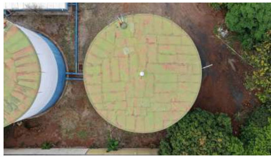
Foto 10 - Vista parte superior do reservatório 1.
