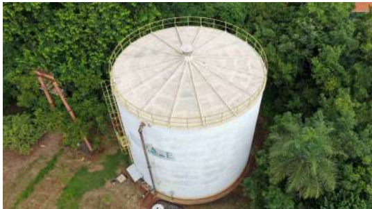
Foto 3 - Vista geral do reservatório.
