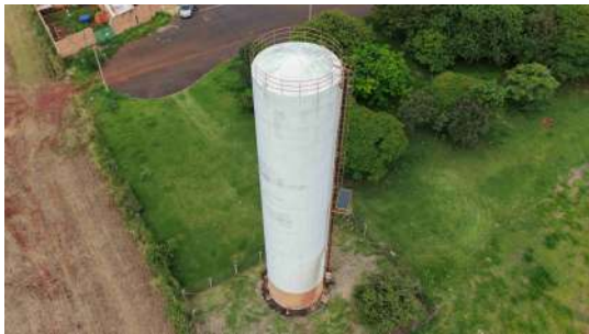
Foto 7 - Vista geral do reservatório.
