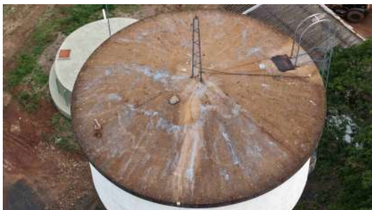
Foto 11 - Vista da parte superior do reservatório.
