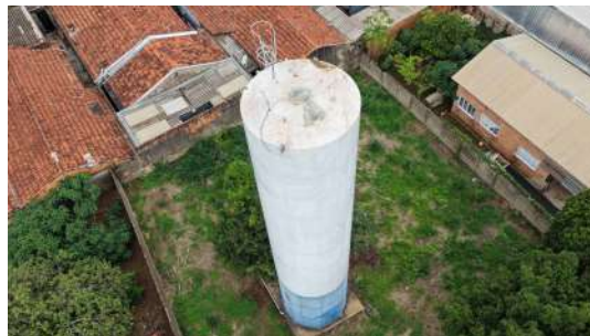
Foto 6 - Vista geral do reservatório.
