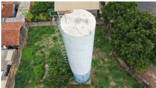
Foto 5 - Vista geral do reservatório.
