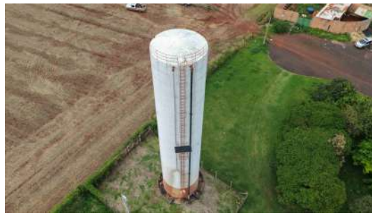
Foto 6 - Vista geral do reservatório. Escadas e guarda corpo. Tubo extravasor à esquerda da escada.
