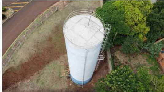
Foto 6 - Vista geral do reservatório.
