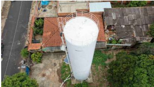
Foto 11 - Reservatório cilíndrico: vista geral.
