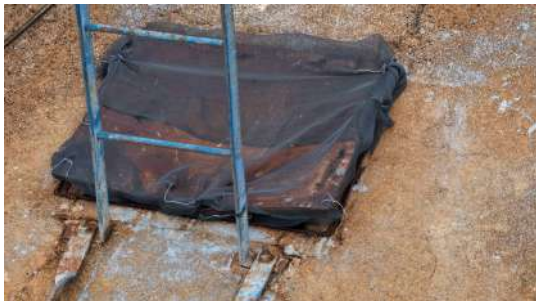
Foto 9 - Tampa de inspeção na parte superior do reservatório.
