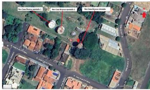
Foto 19 - Identificação dos reservatórios da área. Foto Google Earth.
