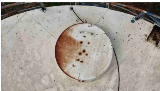
Foto 1 - Tampa de inspeção do reservatório.
