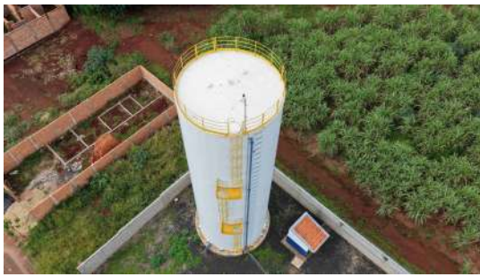
Foto 3 - Vista lateral exibindo escadas, guarda corpo e tubo de alimentação.
