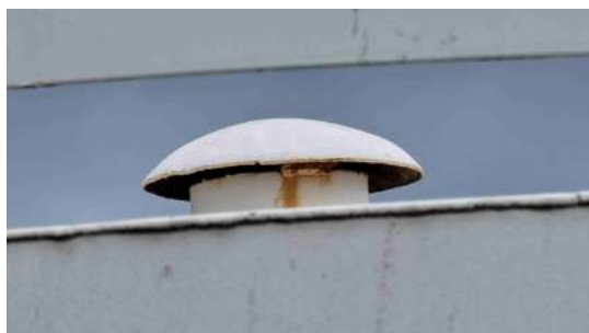
Foto 1 - Abertura de ventilação na parte superior do reservatório cilíndrico.
