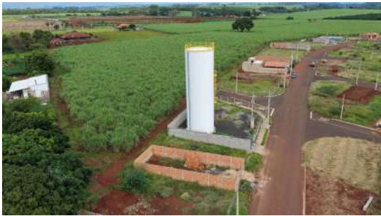
Foto 1 - Vista geral do reservatório.
