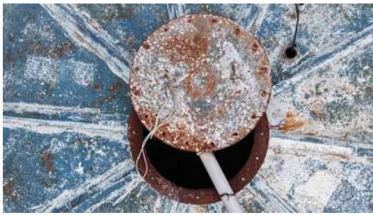
Foto 9 - Reservatório taça: tampa de inspeção na parte superior.
