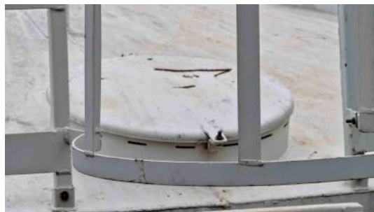
Foto 16 - Reservatório cilíndrico: tampa de inspeção na parte superior.
