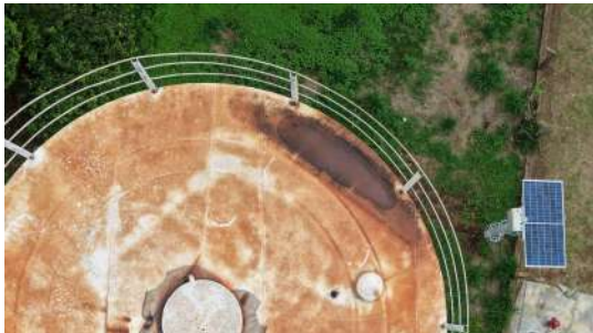
Foto 3 - Perfurações na tampa de inspeção.
