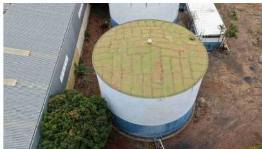
Foto 14 - Vista geral reservatório 1.
