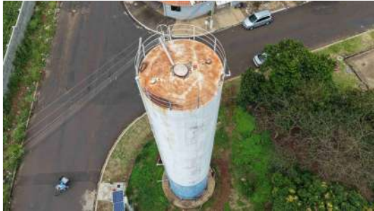
Foto 5 - Vista geral do reservatório.
