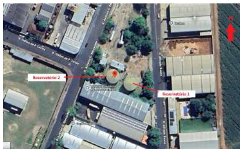
Foto 1 - Identificação dos reservatórios da área. Foto Google Earth.
