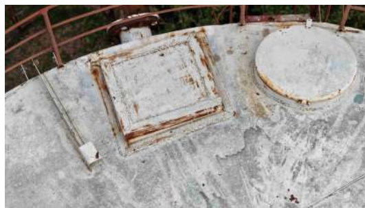
Foto 4 - Tampas de inspeção do reservatório.
