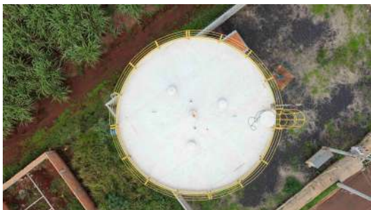
Foto 6 - Vista do topo do reservatório, exibindo tampa de inspeção em boas condições.
