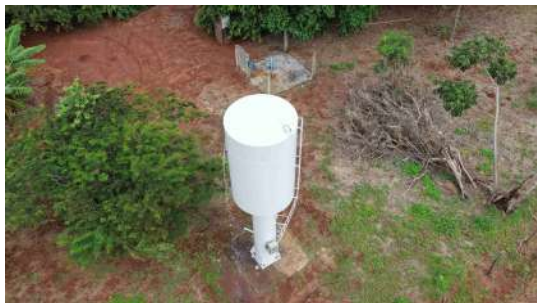
Foto 5 - Vista geral do reservatório.
