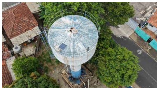
Foto 7 - Reservatório taça: vista geral.
