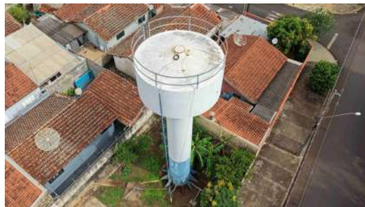
Foto 8 - Vista geral do reservatório.
