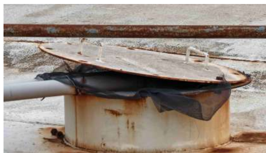
Foto 2 - Tampa de inspeção do reservatório apoiado 1.
