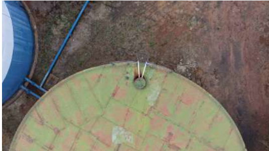
Foto 11 - Vista parte superior do reservatório 1.
