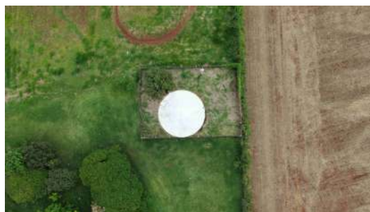
Foto 2 - Vista superior da área onde se localiza o reservatório.
