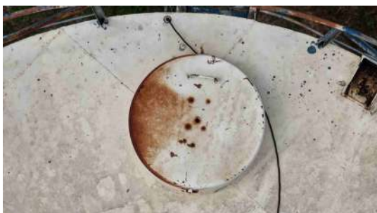
Foto 8 - Tampa de inspeção do reservatório.
