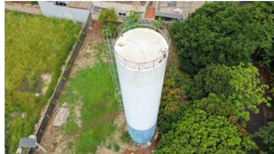
Foto 4 - Vista geral do reservatório.
