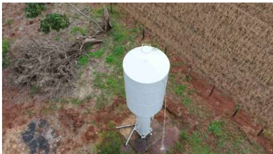
Foto 6 - Vista geral do reservatório.
