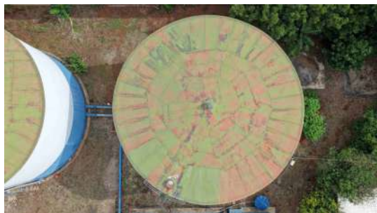
Foto 5 - Vista superior do reservatório 2.
