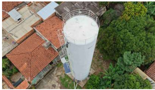
Foto 10 - Reservatório cilíndrico: vista geral evidenciando escadas e guarda corpos.
