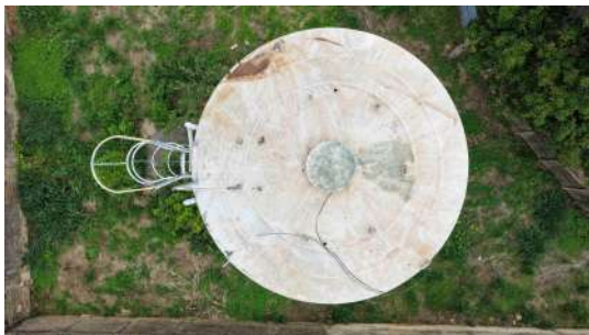
Foto 3 - Vista da parte superior do reservatório.
