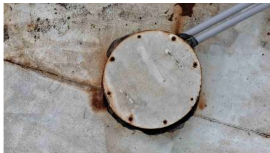
Foto 8 - Tampa de inspeção na parte superior do reservatório apoiado 1.
