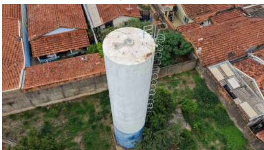
Foto 7 - Vista geral do reservatório.
