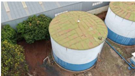
Foto 13 - Vista geral reservatório 1.
