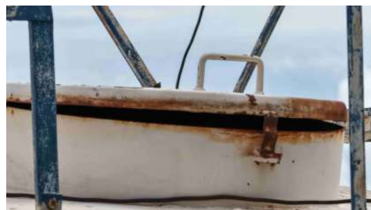
Foto 9 - Tampa de inspeção do reservatório.
