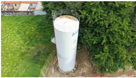
Foto 4 - Vista geral do reservatório.
