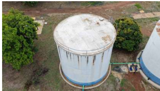
Foto 2 - Vista geral reservatório apoiado 1.
