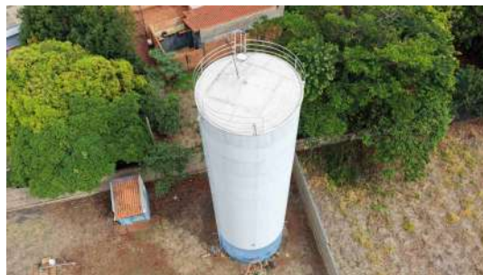
Foto 7 - Vista geral do reservatório.
