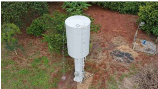
Foto 4 - Vista geral do reservatório.
