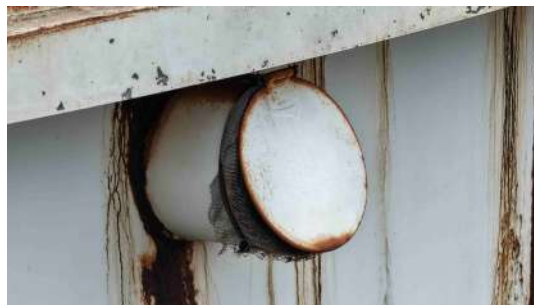
Foto 6 - Extravasor reservatório apoiado 1, com tela de proteção.
