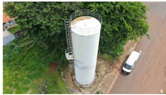
Foto 5 - Vista geral do reservatório.
