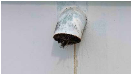
Foto 1 - Tubo extravasador do reservatório 2.
