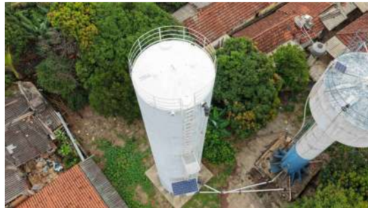
Foto 14 - Reservatório cilíndrico: vista geral.
