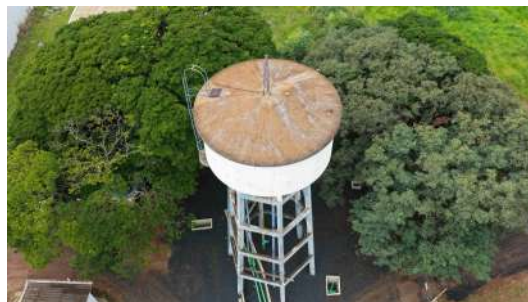
Foto 2 - Vista geral do reservatório.
