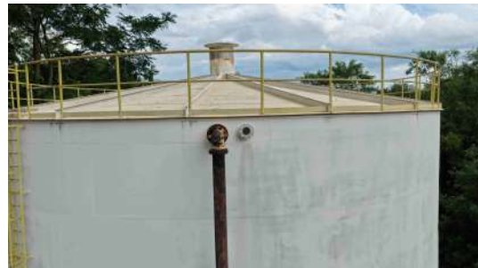
Foto 8 - Vista da parte superior do reservatório.
