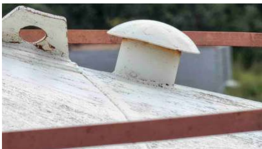
Foto 1 - Abertura de ventilação na parte superior do reservatório, não é possível verificar a presença de tela de proteção.
