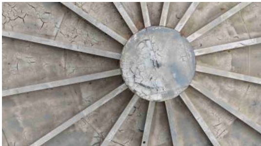
Foto 7 - Vista da parte superior do reservatório.
