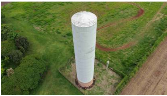
Foto 5 - Vista geral do reservatório.
