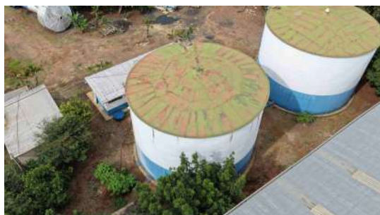
Foto 7 - Vista geral dos reservatório 2 (esquerda) e 1 (direita).
