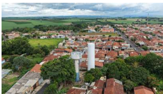
Foto 2 - Vista geral da área dos reservatórios.
