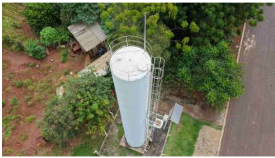
Foto 4 - Vista geral do reservatório.
