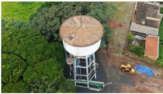
Foto 3 - Vista geral do reservatório.
