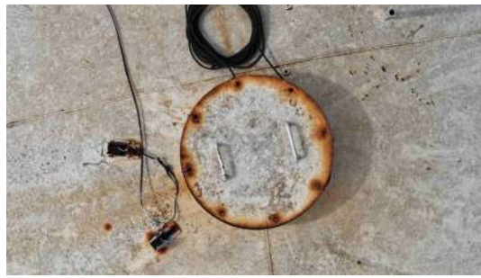
Foto 4 - Tampa de inspeção na parte superior do reservatório.
