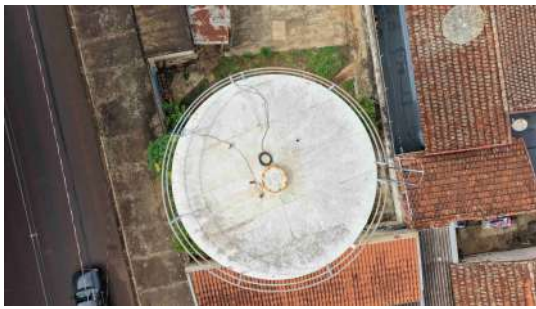
Foto 3 - Vista da parte superior do reservatório, evidenciando tampa de inspeção.
