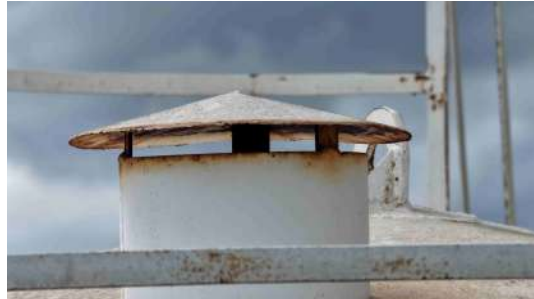
Foto 7 - Abertura de ventilação
