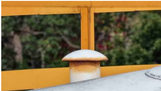
Foto 1 - Abertura de ventilação no topo do reservatório 1.
