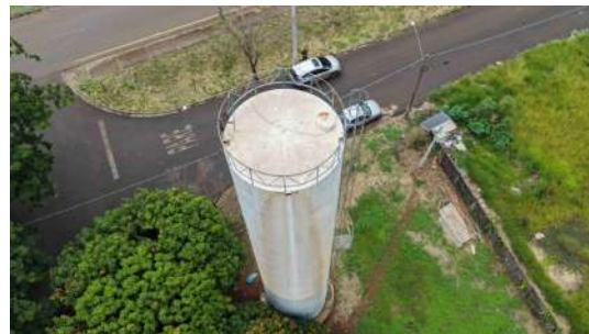
Foto 5 - Vista geral do reservatório.
