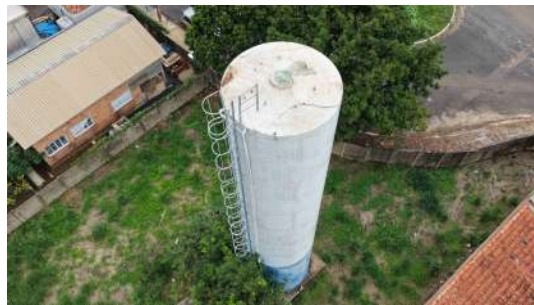
Foto 4 - Vista geral do reservatório.
