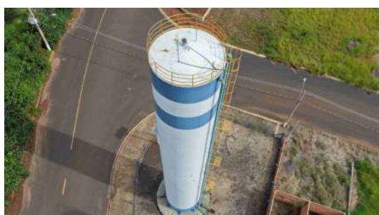
Foto 6 - Vista geral do reservatório 1.
