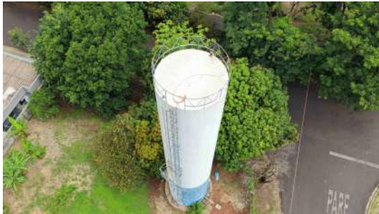
Foto 3 - Vista geral do reservatório evidenciando escada e guarda corpo.
