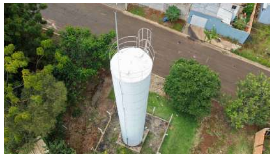
Foto 5 - Vista geral do reservatório.
