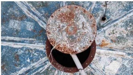
Foto 1 - Tampa de inspeção, aberta, na parte superior do reservatório taça.
