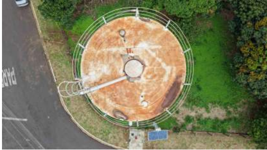
Foto 3 - Vista da parte superior do reservatório.
