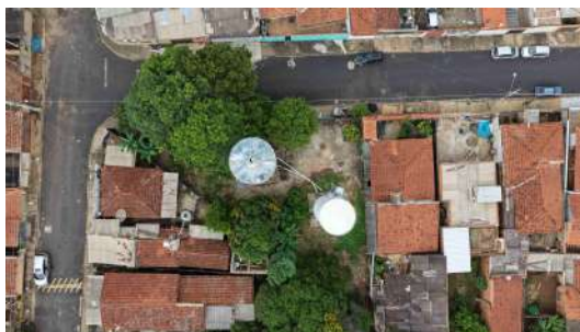
Foto 3 - Vista superior da área dos reservatórios.
