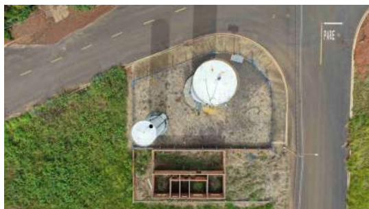
Foto 3 - Vista superior da área onde se localizam os reservatórios.
