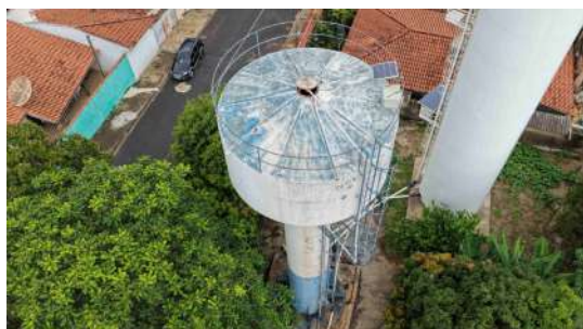
Foto 4 - Reservatório taça: vista geral evidenciando escadas e guarda corpos..
