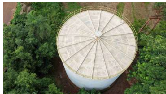
Foto 6 - Vista da parte superior do reservatório.
