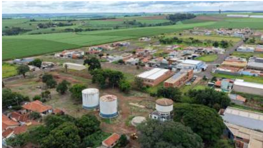
Foto 20 - Vista geral da área onde se encontram os reservatórios.
