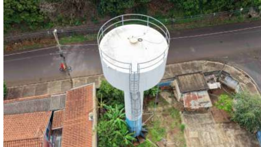
Foto 6 - Vista geral do reservatório, evidenciando escadas e guarda corpo.
