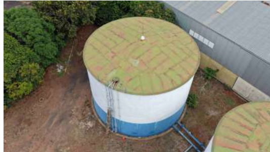
Foto 12 - Vista geral reservatório 1.
