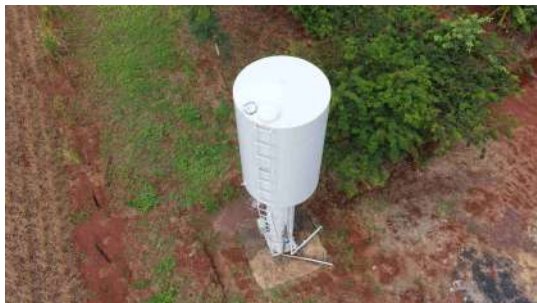
Foto 7 - Vista geral do reservatório.
