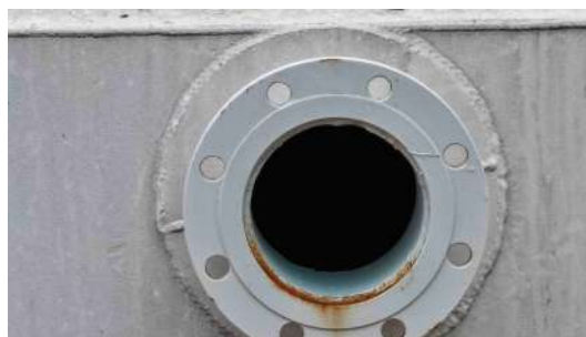
Foto 2 - Abertura do extravasor no reservatório cilíndrico.
