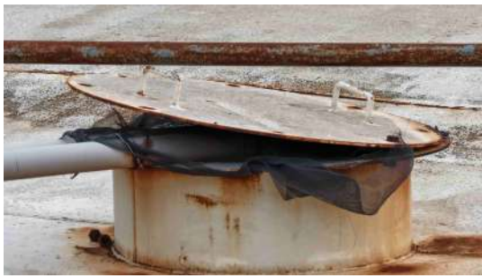
Foto 9 - Tampa de inspeção na parte superior do reservatório apoiado 1.
