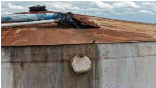
Foto 16 - Tubo extravasor do reservatório apoiado 2.
