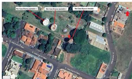
Foto 16 - Identificação dos reservatórios da área.
