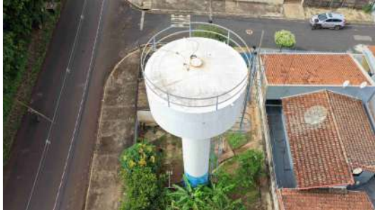
Foto 5 - Vista geral do reservatório.
