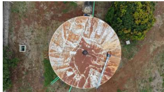
Foto 17 - Vista da parte superior do reservatório apoiado 2.
