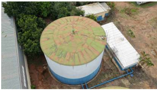
Foto 9 - Vista geral reservatório 2.
