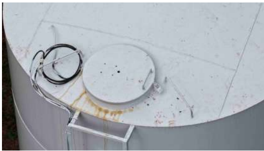
Foto 8 - Tampa de inspeção na parte superior do reservatório.
