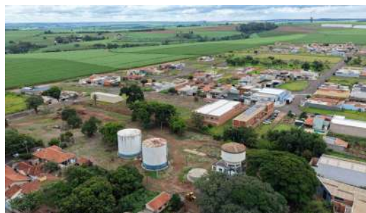
Foto 14 - Vista geral da área onde se encontram os reservatórios.
