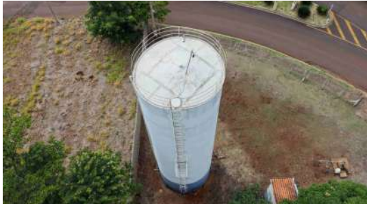
Foto 5 - Vista geral do reservatório, evidenciando escadas e guarda corpo.
