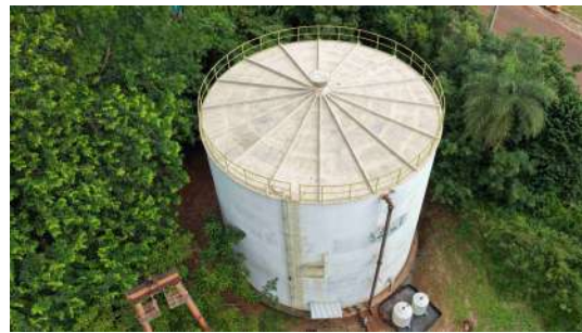
Foto 2 - Vista geral do reservatório.
