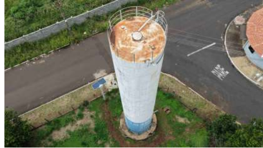
Foto 4 - Vista geral do reservatório.
