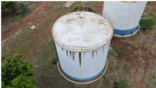
Foto 1 - Vista geral reservatório apoiado 1.
