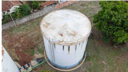
Foto 4 - Vista geral reservatório apoiado 1, abertura de ventilação localizada no centro da parte superior.
