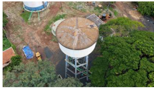
Foto 4 - Vista geral do reservatório.
