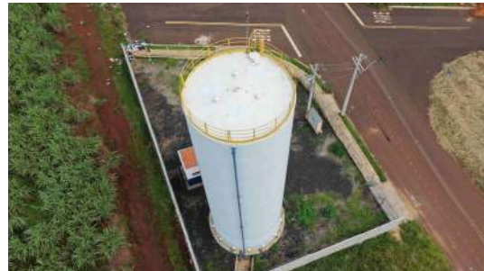
Foto 5 - Vista lateral do reservatório.
