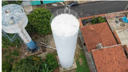
Foto 12 - Reservatório cilíndrico: vista geral.
