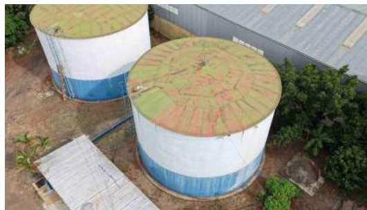
Foto 6 - Vista geral reservatórios 1 e 2, evidenciando escadas com guarda corpo e guarda corpo na parte superior, próximo à tampa de inspeção.
