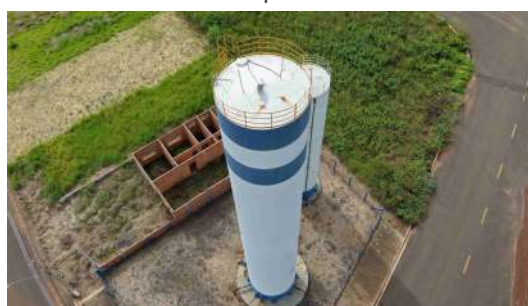
Foto 7 - Vista geral do reservatório 1.
