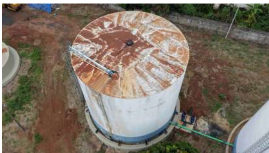
Foto 14 - Vista geral reservatório apoiado 2.
