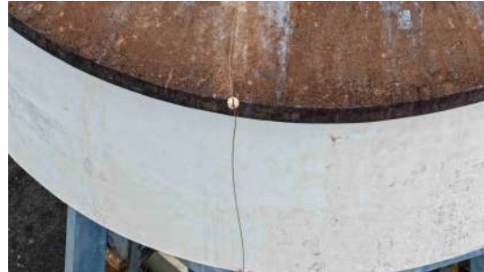
Foto 6 - Condutor do SPDA.
