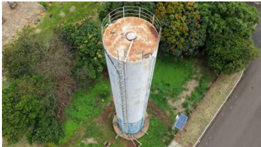
Foto 7 - Vista geral do reservatório.
