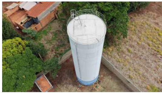
Foto 4 - Vista geral do reservatório.
