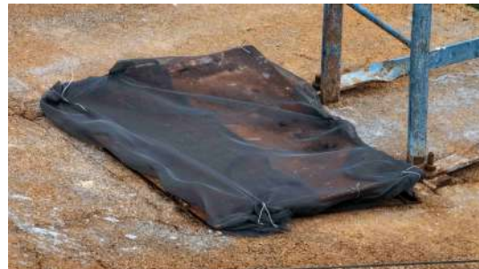
Foto 10 - Tampa de inspeção na parte superior do reservatório.
