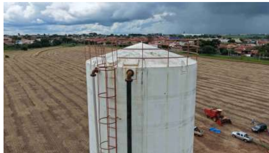
Foto 8 - Vista da parte superior do reservatório.
