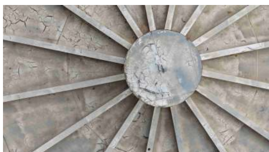
Foto 3 - Pintura descascando.
