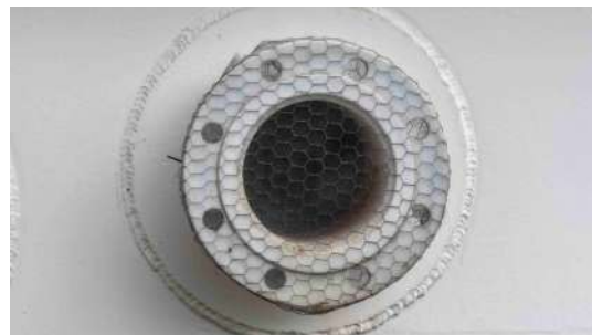
Foto 10 - Tubo extravasor com tela.
