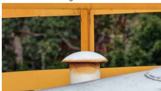
Foto 8 - Abertura de ventilação do reservatório 1.
