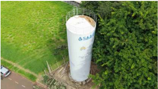
Foto 3 - Vista geral do reservatório.
