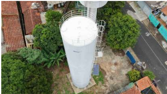
Foto 13 - Reservatório cilíndrico: vista geral.
