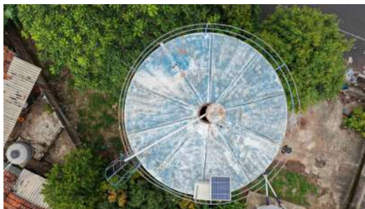
Foto 8 - Reservatório taça: vista superior.
