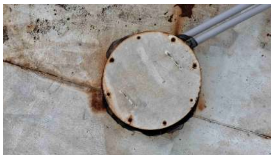
Foto 1 - Tampa de inspeção do reservatório apoiado 1.
