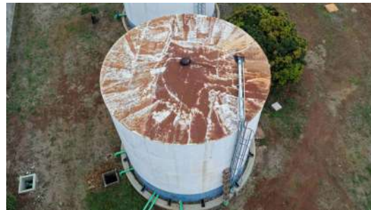
Foto 12 - Vista geral reservatório apoiado 2.
