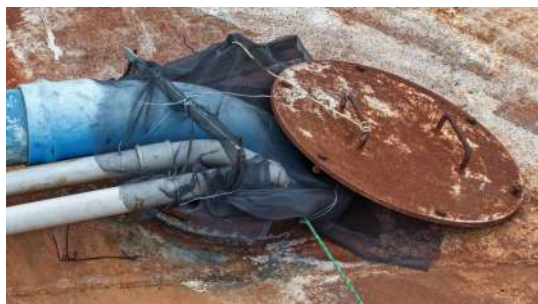
Foto 3 - Tampa de inspeção do reservatório apoiado 2.
