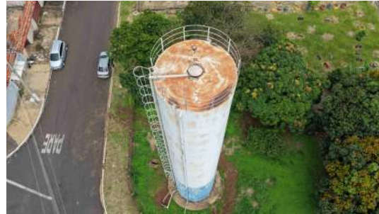
Foto 6 - Vista geral do reservatório.
