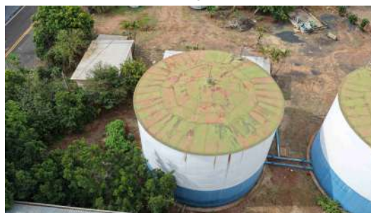
Foto 8 - Vista geral reservatório 2.
