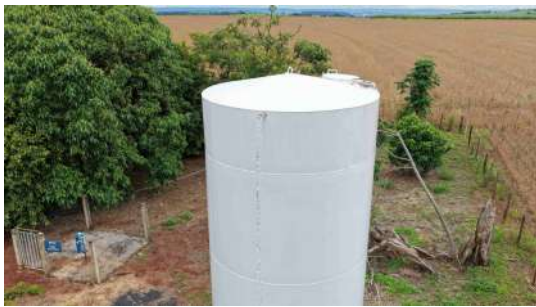
Foto 1 - Não há guarda corpo na parte superior do reservatório.
