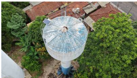
Foto 6 - Reservatório taça: vista geral.
