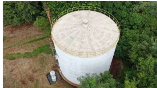
Foto 4 - Vista geral do reservatório.
