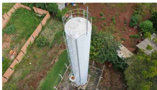
Foto 3 - Vista geral do reservatório.
