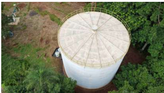
Foto 5 - Vista geral do reservatório.
