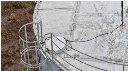
Foto 10 - Tampa de inspeção localizada na parte superior do reservatório.
