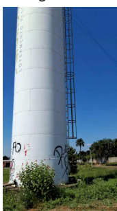
Foto 6 - Vista lateral do reservatório.
