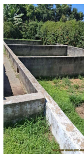
Foto 13 - Leito de secagem (não utilizado).
