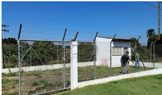
Foto 8 - Vista geral da estação elevatória de esgoto.
