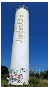
Foto 4 - Vista geral do reservatório.
