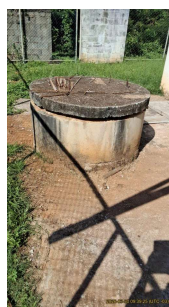
Foto 7 - Ponto de entrada de esgoto.
