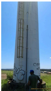
Foto 1 - Escada de acesso ao topo do reservatório e tubulação de entrada de água.
