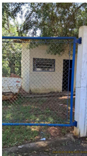
Foto 1 - Portão de acesso para a estação elevatória de esgoto.
