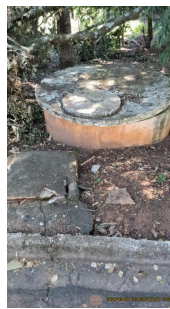
Foto 2 - Vista geral da elevatória de esgoto.
