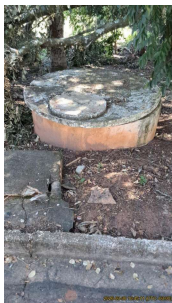
Foto 3 - Vista geral da elevatória de esgoto.
