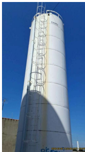
Foto 3 - Escada de acesso ao topo, tubulação de entrada de água e tubulação extravasora.
