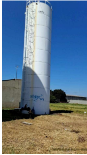
Foto 1 - Vista geral do reservatório.
