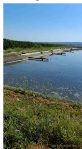
Foto 6 - Ponto de entrada do esgoto na primeira lagoa.
