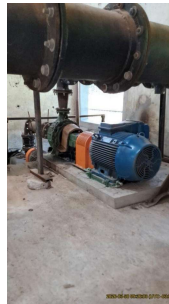
Foto 2 - Motobomba (Faz parte de um conjunto, sendo uma utilizada em operação, e outra em reserva).
