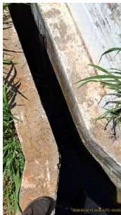
Foto 1 - Passagem do esgoto.
