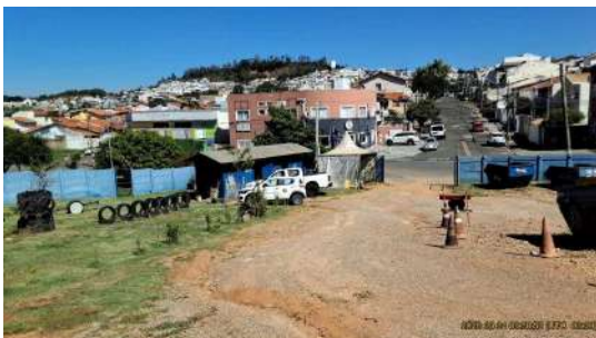
Foto 15 - Visão geral, interna
