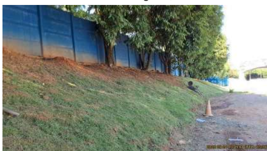
Foto 7 - Visão geral, interna
