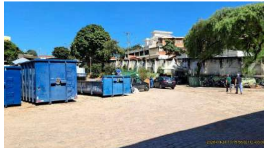
Foto 16 - Visão geral, interna
