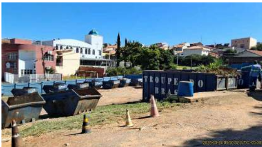
Foto 17 - Visão geral, interna
