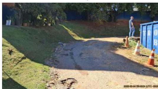
Foto 6 - Visão geral, interna
