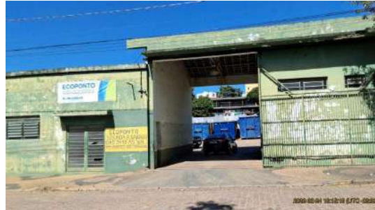
Foto 12 - Visão geral, externa
