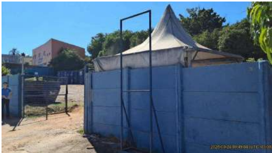
Foto 1 - Ausência de identificação da área
