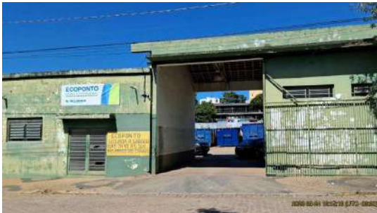
Foto 13 - Visão geral, externa
