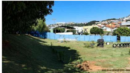
Foto 14 - Visão geral, interna
