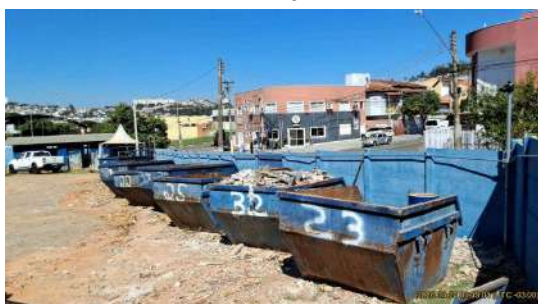
Foto 5 - Visão geral, interna
