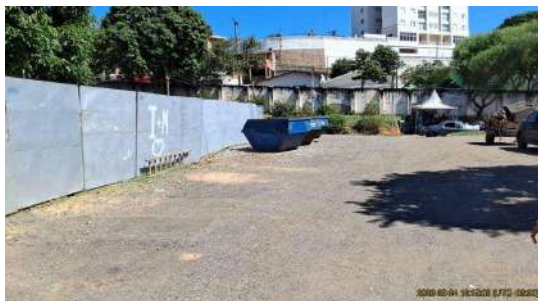
Foto 1 - Visão geral, interna
