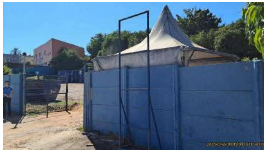
Foto 2 - Visão geral, externa
