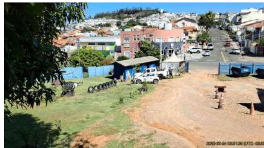
Foto 18 - Visão geral, interna
