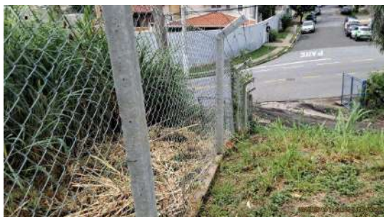
Foto 3 - Visão geral, cercamento
