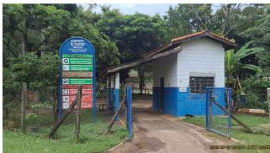
Foto 1 - Visão geral, externa
