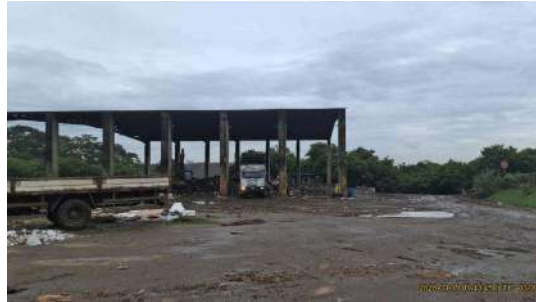
Foto 2 - Visão geral, área superior
