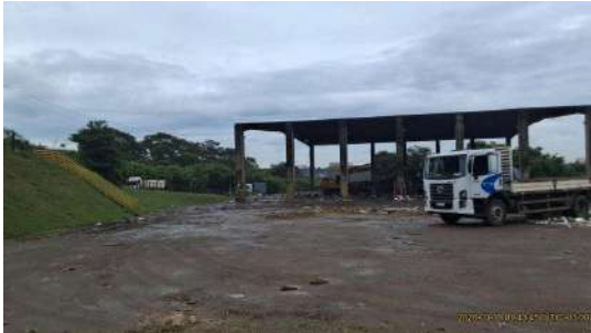
Foto 1 - Visão geral, área superior
