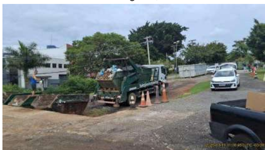
Foto 5 - Visão geral, interna
