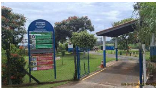
Foto 1 - Visão geral, externa
