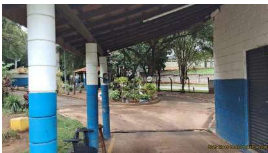
Foto 3 - Visão geral, interna
