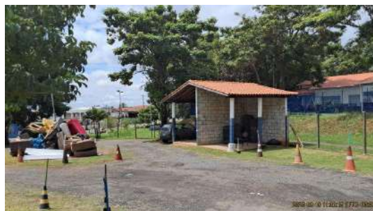
Foto 6 - Visão geral, interna
