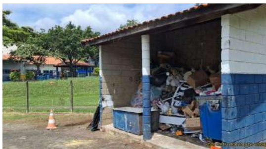
Foto 5 - Visão geral, interna
