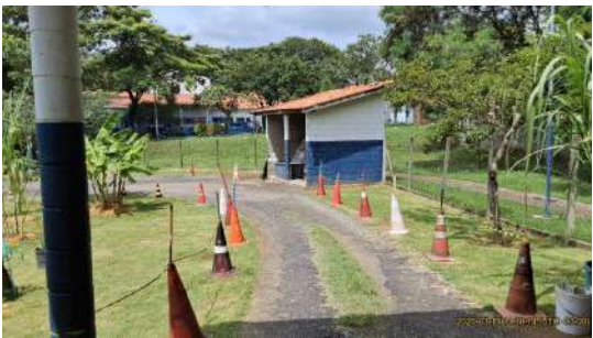
Foto 2 - Visão geral, interna
