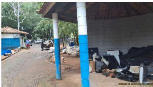
Foto 7 - Visão geral, interna
