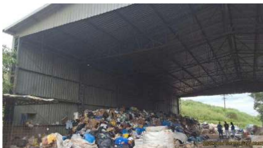
Foto 7 - Visão geral, interna
