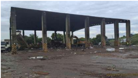
Foto 5 - Visão geral, área superior
