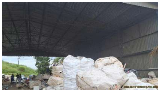
Foto 6 - Visão geral, interna
