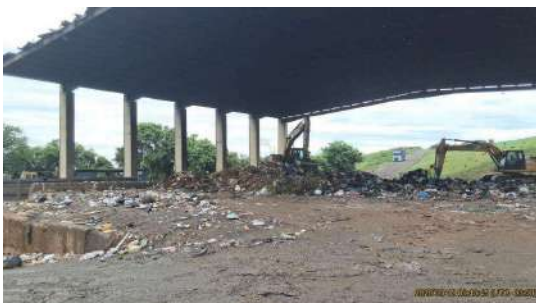
Foto 7 - Visão geral, área superior
