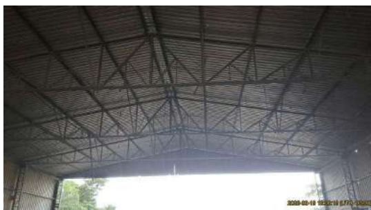
Foto 15 - Visão geral, interna
