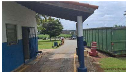
Foto 2 - Visão geral, acesso
