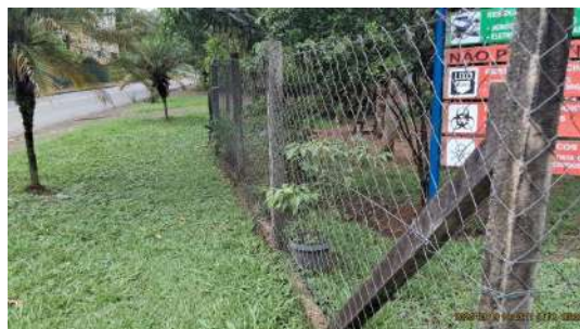
Foto 2 - Visão geral, isolamento
