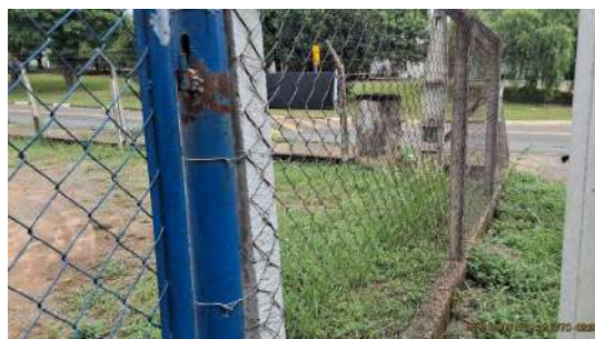
Foto 2 - Visão geral, isolamento
