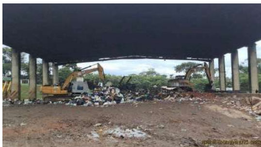
Foto 21 - Visão geral, área superior
