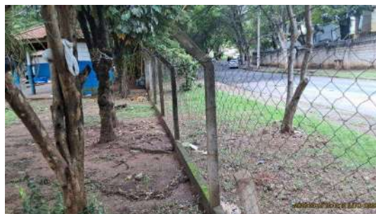
Foto 6 - Visão geral, interna
