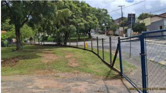
Foto 15 - Visão geral, isolamento
