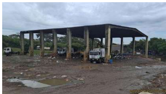
Foto 22 - Visão geral, área superior
