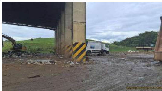
Foto 8 - Visão geral, área superior
