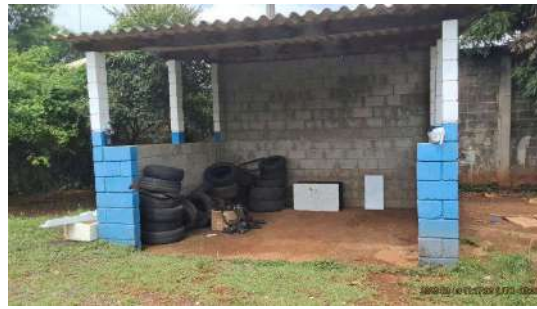
Foto 12 - Visão geral, interna
