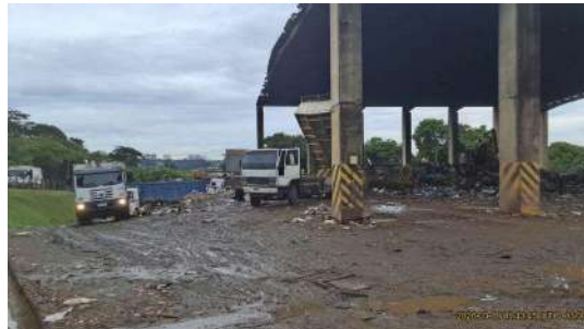
Foto 6 - Visão geral, área superior
