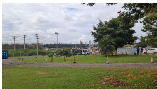
Foto 10 - Visão geral, interna
