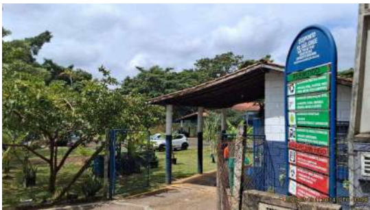
Foto 1 - Visão geral, externa
