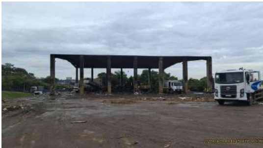
Foto 3 - Visão geral, área superior
