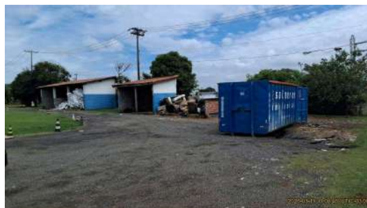
Foto 4 - Visão geral, interna
