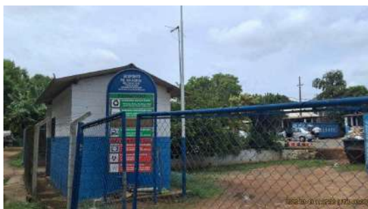
Foto 1 - Visão geral, externa
