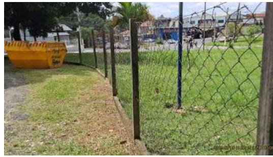
Foto 14 - Visão geral, isolamento
