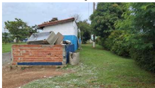
Foto 6 - Visão geral, interna
