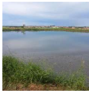
Foto 12 - Vista geral da primeira das duas lagoas anaeróbias.
