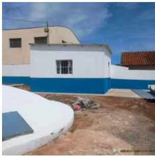
Foto 13 - Novo abrigo dos conjuntos motobomba.
