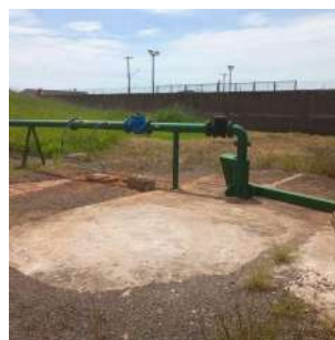
Foto 2 - Vista geral do Poço P5.
