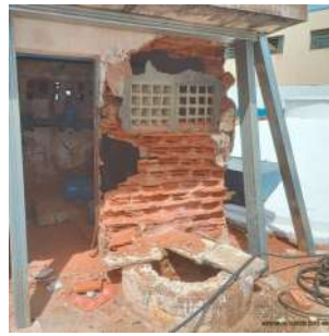
Foto 4 - Vista geral externa da EEAT.
