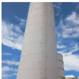
Foto 7 - Vista geral do reservatório.
