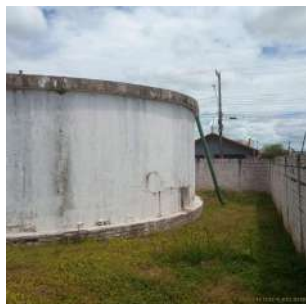
Foto 5 - Vista lateral do reservatório.
