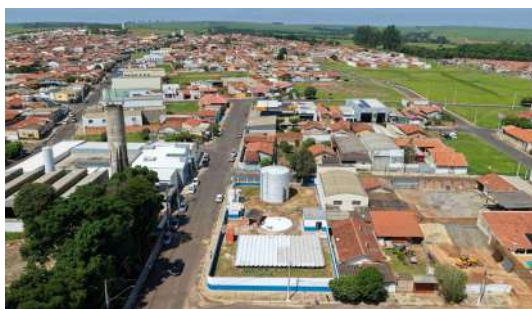
Foto 6 - Vista aérea da área operacional do Poço P4.
