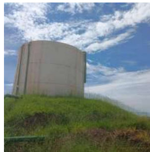
Foto 2 - Reservatório metálico desativado.
