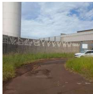
Foto 2 - Vista externa do centro de reservação
