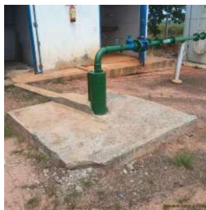
Foto 2 - Vista geral do Poço P6.
