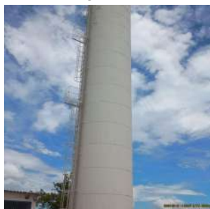
Foto 3 - Vista geral do reservatório.
