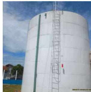
Foto 4 - Vista geral do reservatório metálico.
