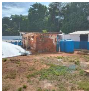
Foto 2 - Vista geral da EEAT.
