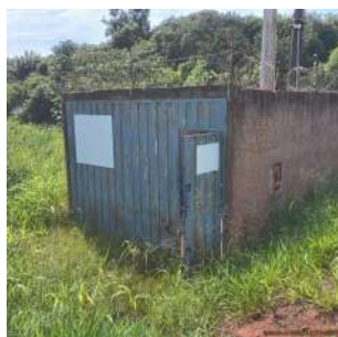
Foto 11 - Vista geral da área do Poço.
