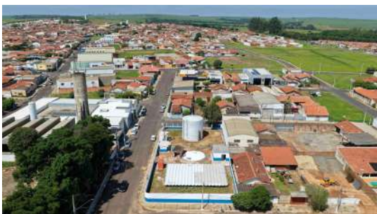
Foto 13 - Vista aérea da área operacional do Poço P4 (direita) e do reservatório elevado (esquerda).
