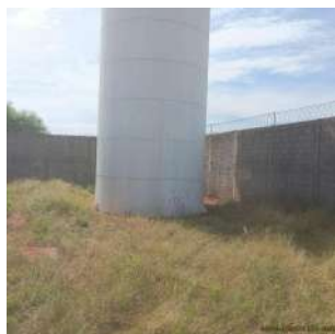
Foto 17 - Vista geral do reservatório ainda não operacional.
