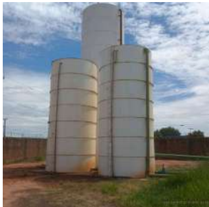
Foto 5 - Vista geral dos reservatórios de fibra (à frente) e metálico elevado (ao fundo).
