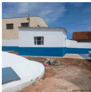
Foto 9 - Novo abrigo dos conjuntos motobomba.
