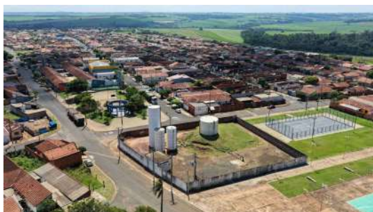
Foto 13 - Vista aérea da área operacional do Poço P5.
