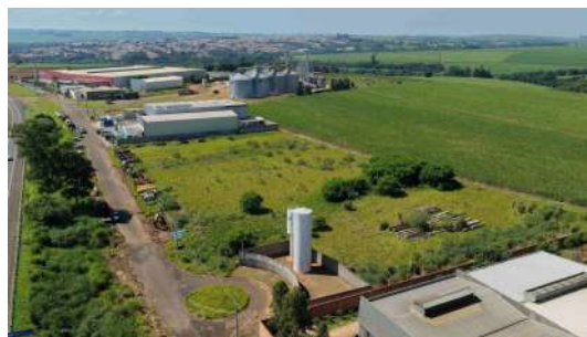
Foto 18 - Vista aérea dos reservatórios metálicos elevados.
