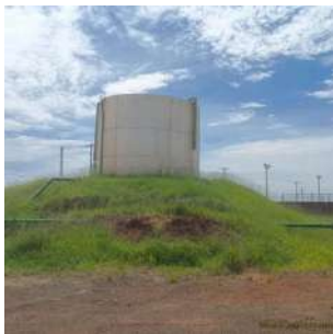
Foto 1 - Reservatório metálico desativado.
