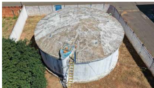
Foto 10 - Vista aérea do reservatório do Asilo.
