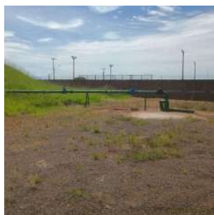
Foto 1 - Vista geral do Poço P5.
