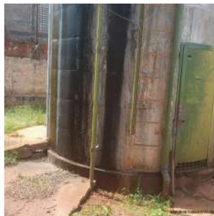
Foto 12 - Vista da base do reservatório.
