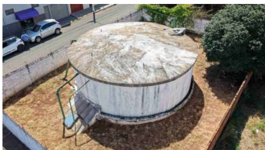
Foto 12 - Vista aérea do reservatório do Asilo.
