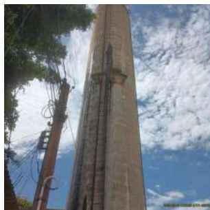
Foto 3 - Vista geral do reservatório elevado.
