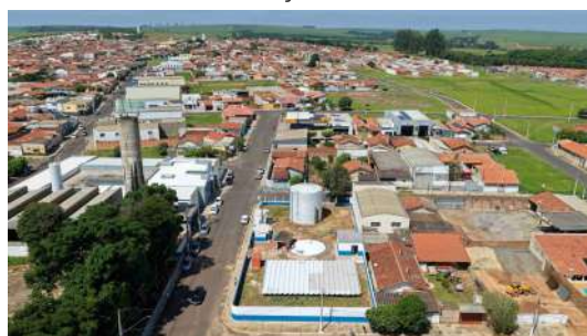
Foto 22 - Vista aérea da área operacional do Poço P4.
