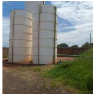
Foto 2 - Vista geral dos reservatórios de fibra (à frente) e metálico elevado (ao fundo).
