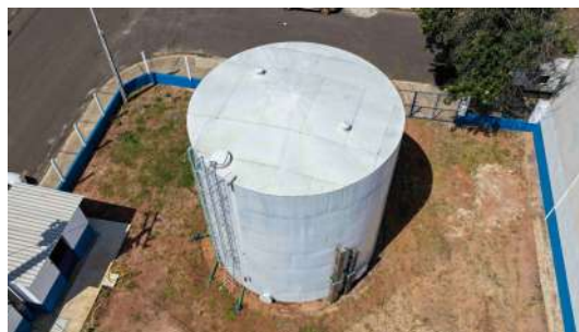
Foto 12 - Vista aérea do reservatório metálico.
