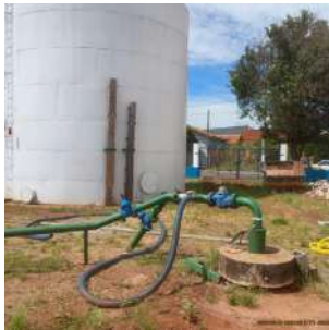
Foto 1 - Vista geral do reservatório metálico.
