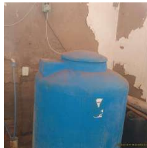
Foto 12 - Tanque de hipoclorito.
