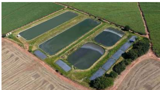
Foto 33 - Vista aérea da ETE.
