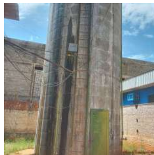
Foto 6 - Vista da base do reservatório.
