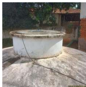
Foto 5 - Parte superior da cobertura do reservatório.
