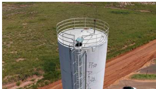
Foto 13 - Vista aérea do reservatório elevado.
