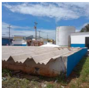
Foto 5 - Vista da cobertura do reservatório.
