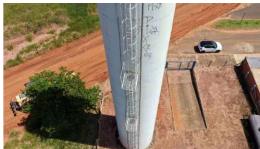
Foto 12 - Vista aérea do reservatório elevado.
