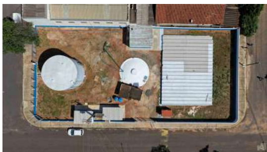
Foto 1 - Vista aérea da área operacional do Poço P4.
