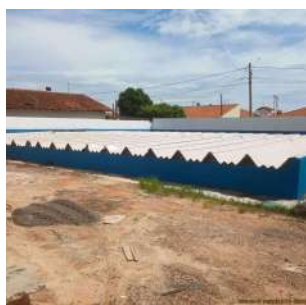
Foto 1 - Vista da cobertura do reservatório.
