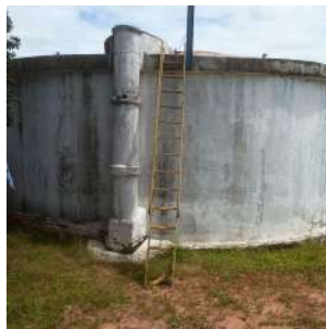
Foto 4 - Vista lateral do reservatório.
