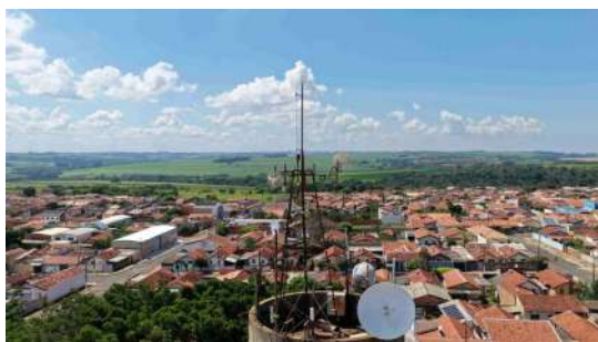
Foto 16 - Vista da cobertura e haste de captação do SPDA do reservatório elevado.
