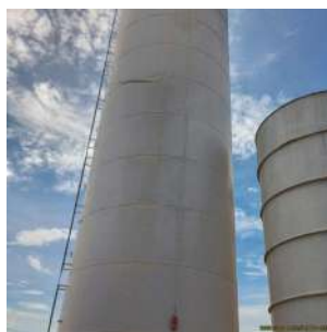
Foto 8 - Vista geral do reservatório.
