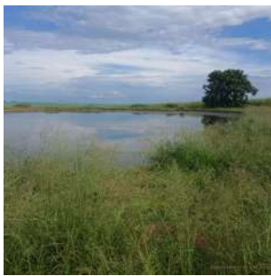
Foto 11 - Vista geral da segunda lagoa anaeróbia.
