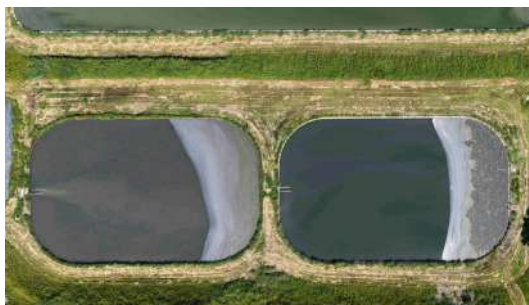
Foto 34 - Vista aérea das lagoas anaeróbias.
