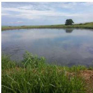
Foto 7 - Vista geral da primeira das duas lagoas anaeróbias.
