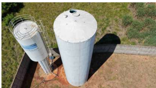
Foto 19 - Vista aérea da cobertura dos reservatórios metálicos: à esquerda o reservatório em operação; à direita o reservatório ainda desativado.
