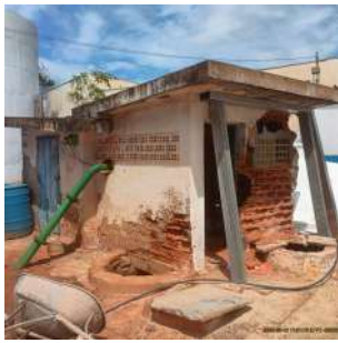
Foto 3 - Vista geral externa da EEAT.
