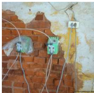
Foto 14 - Bombas dosadoras de produtos químicos.
