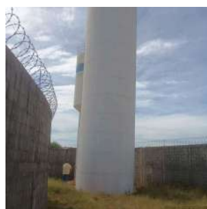
Foto 5 - Reservatório ainda não operacional.
