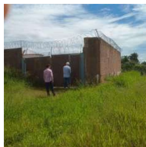
Foto 2 - Vista geral externa da EEE.
