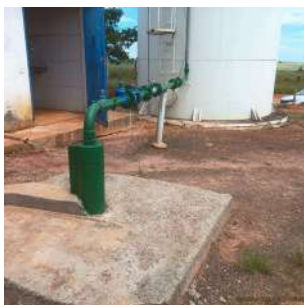
Foto 1 - Vista geral do Poço P6.
