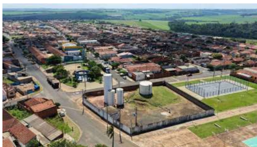
Foto 10 - Vista aérea da área operacional do Poço P5.
