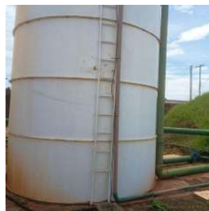
Foto 7 - Tubo em PVC do abastecimento 2 do elevado para os apoiados.
