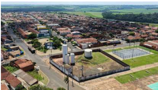
Foto 3 - Vista aérea da área operacional do Poço P5.
