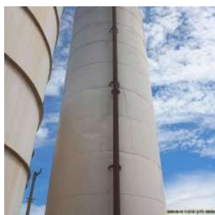
Foto 1 - Vista geral do reservatório.
