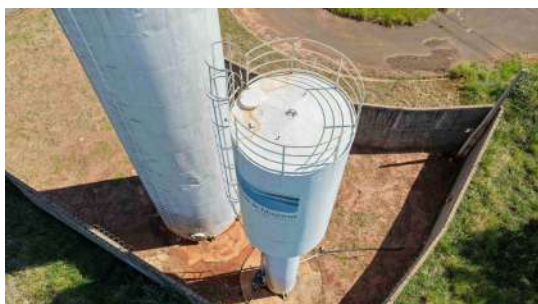
Foto 22 - Vista aérea do reservatório em operação.
