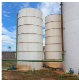
Foto 10 - Vista lateral dos dois reservatórios apoiados.
