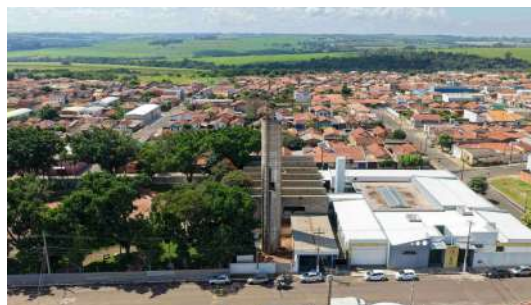
Foto 14 - Vista aérea do reservatório elevado.
