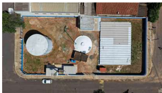
Foto 21 - Vista aérea da área operacional do Poço P4.
