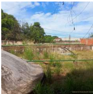
Foto 8 - Reservatório semienterrado retangular desativado.
