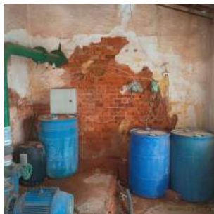
Foto 12 - Tanques de produtos químicos (hipoclorito e flúor).
