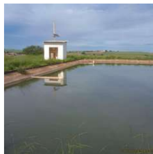
Foto 18 - Saída da lagoa de polimento.
