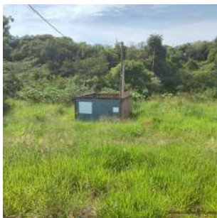
Foto 1 - Vista geral da área do Poço.
