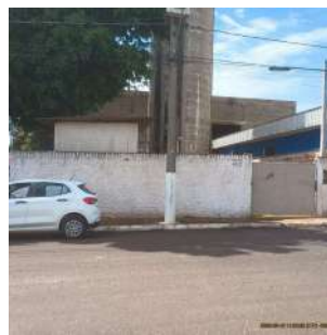
Foto 2 - Vista geral do reservatório elevado.
