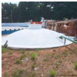
Foto 1 - Vista geral do reservatório Globo.
