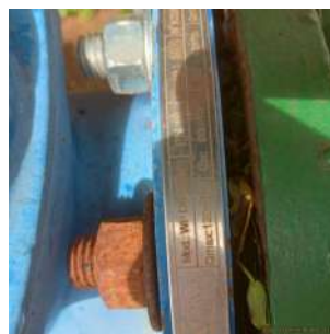
Foto 6 - Detalhe do macromedidor do poço.
