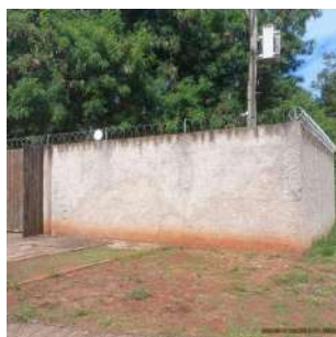
Foto 1 - Vista externa da área do poço.
