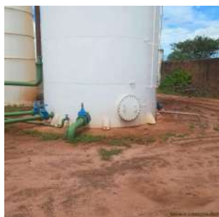
Foto 5 - Vista da base do reservatório.
