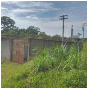
Foto 3 - Vista externa da entrada da EEE.
