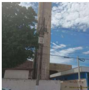
Foto 1 - Vista geral do reservatório elevado.
