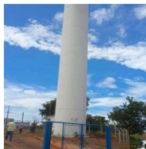
Foto 2 - Vista geral do reservatório.
