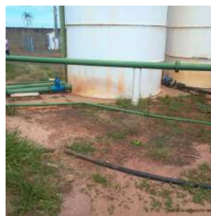
Foto 11 - Tubulação de saída do reservatório 2.
