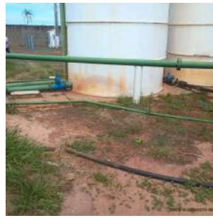
Foto 11 - Tubulação de saída do reservatório 2.
