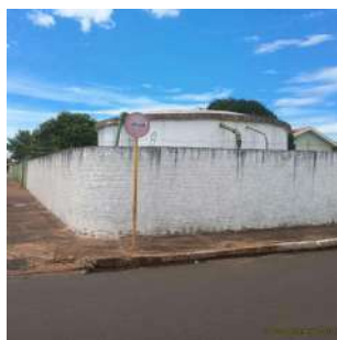
Foto 1 - Vista externa da área do reservatório.
