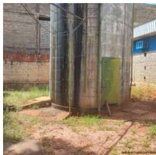
Foto 5 - Vista da base do reservatório.
