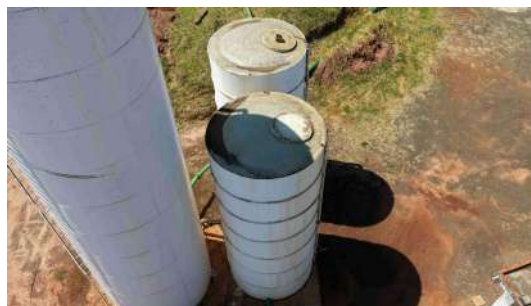
Foto 14 - Vista aérea dos reservatórios apoiados de fibra.
