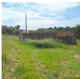
Foto 1 - Vista geral externa da EEE.
