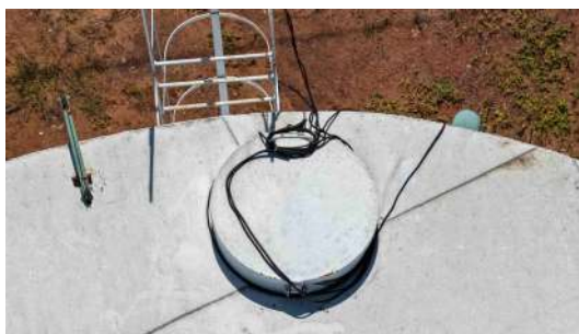
Foto 15 - Vista aérea do reservatório metálico.
