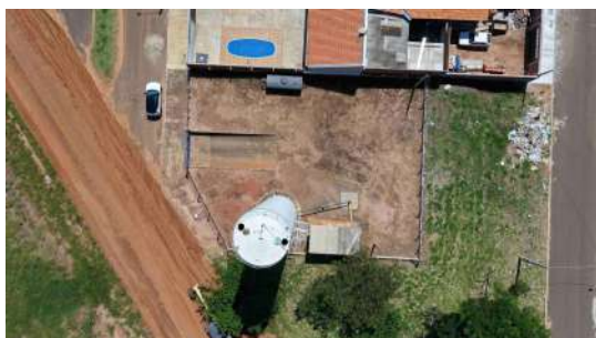
Foto 18 - Vista aérea da área operacional do Poço P6.
