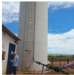
Foto 6 - Vista geral do reservatório e da adutora do poço.
