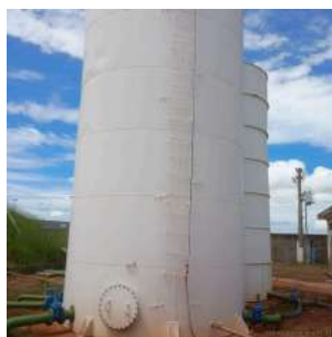
Foto 6 - Vista da base do reservatório.
