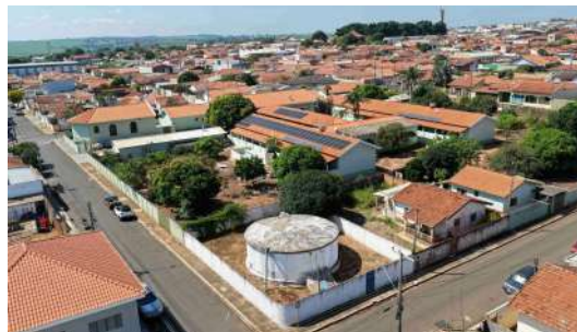
Foto 8 - Vista aérea do reservatório do Asilo.
