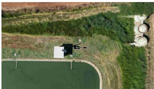
Foto 38 - À esquerda abrigo dos produtos químicos e das bombas dosadoras e, à direita, tanques de contato do hipoclorito após saída do efluente tratado.
