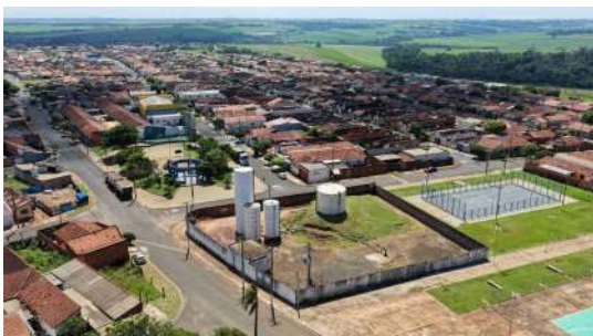
Foto 17 - Vista aérea da área operacional do Poço P5.
