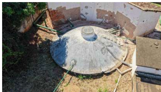
Foto 12 - Vista aérea do reservatório enterrado Globo P1.
