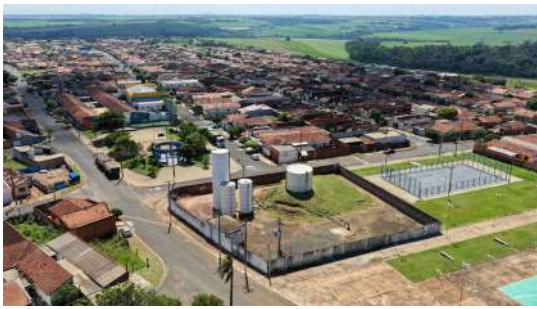
Foto 1 - Vista aérea da área operacional do Poço P5.
