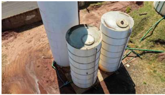
Foto 2 - Vista aérea dos reservatórios apoiados de fibra.
