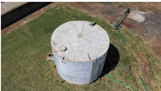
Foto 5 - Vista aérea do reservatório metálico desativado.
