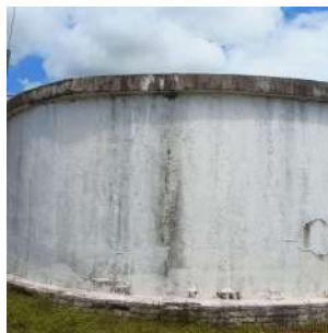
Foto 6 - Vista lateral do reservatório.
