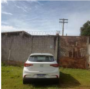
Foto 1 - Vista externa da entrada da EEE.
