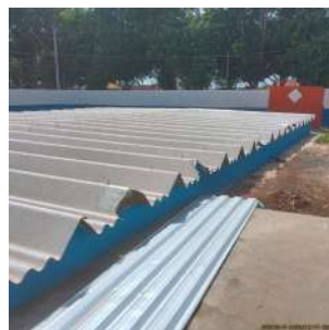
Foto 6 - Vista da cobertura do reservatório.
