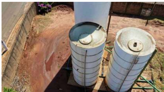
Foto 15 - Vista aérea dos reservatórios apoiados de fibra.
