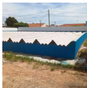
Foto 2 - Vista da cobertura do reservatório.
