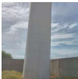
Foto 16 - Vista geral do reservatório ainda não operacional.
