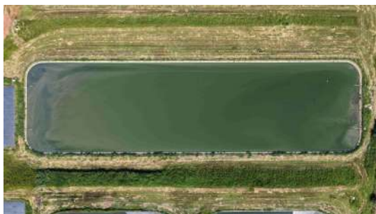
Foto 35 - Vista aérea da lagoa facultativa.
