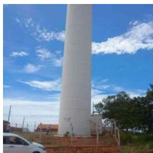
Foto 1 - Vista geral do reservatório.
