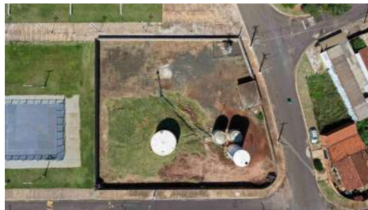
Foto 4 - Vista aérea da área operacional do Poço P5.
