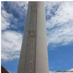
Foto 7 - Vista geral do reservatório.
