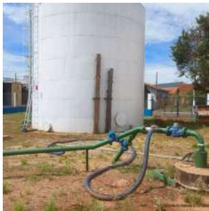
Foto 3 - Vista geral do reservatório metálico. Vista geral do reservatório metálico e, à frente, Poço P4.
