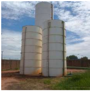
Foto 1 - Vista geral dos reservatórios de fibra (à frente) e metálico elevado (ao fundo).
