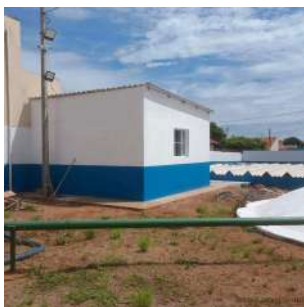
Foto 3 - Novo abrigo dos conjuntos motobomba.
