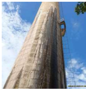
Foto 8 - Vista geral do reservatório elevado.
