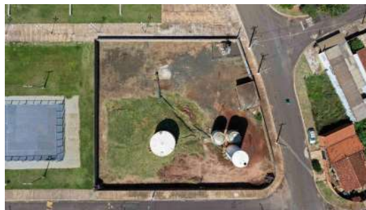
Foto 18 - Vista aérea da área operacional do Poço P5.
