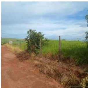
Foto 3 - Vista externa da área da ETE.
