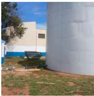
Foto 6 - Vista geral do reservatório metálico.
