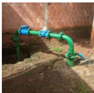
Foto 5 - Vista geral do cavalete do poço.
