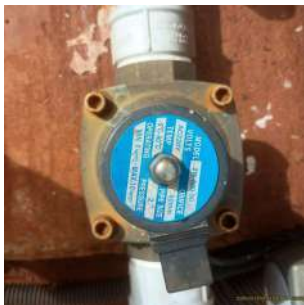
Foto 8 - Valvula solenóide de entrada de água dos poços. Apenas um tubo para os dois poços
