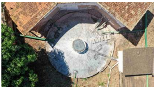
Foto 11 - Vista aérea do reservatório enterrado Globo P1.
