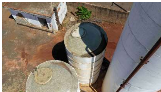
Foto 16 - Vista aérea dos reservatórios apoiados de fibra.
