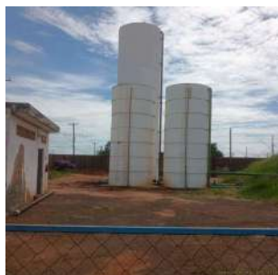
Foto 9 - Vista geral dos reservatórios.
