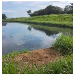
Foto 8 - Vista geral da primeira das duas lagoas anaeróbias.
