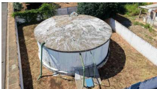
Foto 11 - Vista aérea do reservatório do Asilo.
