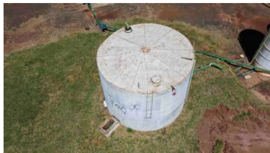
Foto 6 - Vista aérea do reservatório metálico desativado.
