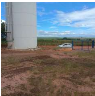
Foto 5 - Vista geral do reservatório.
