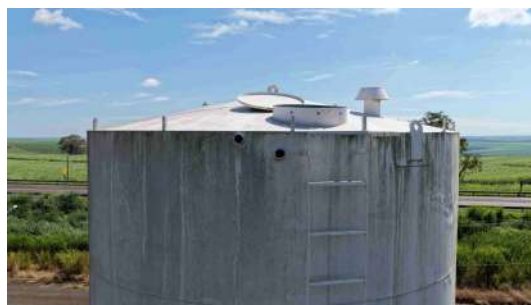
Foto 20 - Detalhe da cobertura do reservatório desativado: tubos extravasores (ladrão) e chaminé de respiro.
