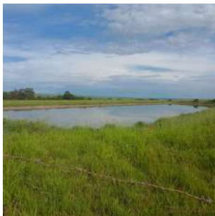
Foto 13 - Vista geral da segunda lagoa anaeróbia.
