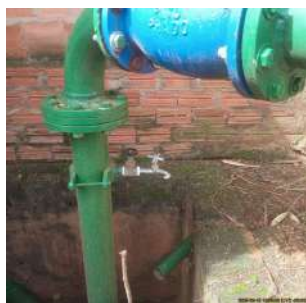
Foto 13 - Torneira para tomada de água bruta.
