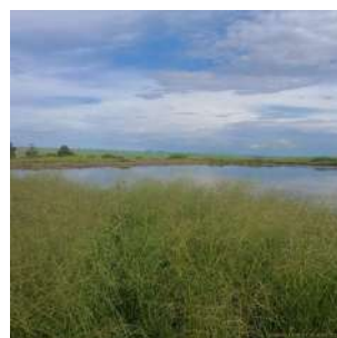
Foto 10 - Vista geral da segunda lagoa anaeróbia.
