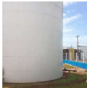
Foto 9 - Vista geral do reservatório metálico.
