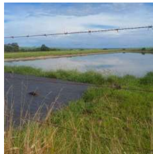
Foto 14 - Vista geral da lagoa facultativa.
