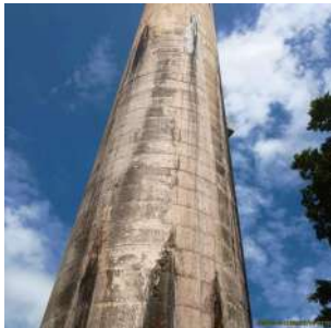
Foto 9 - Vista geral do reservatório elevado.
