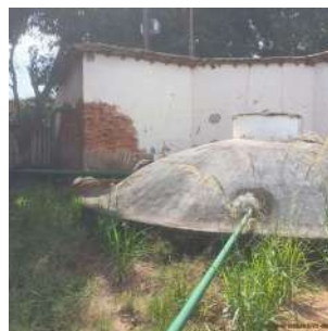
Foto 2 - Vista geral do reservatório e entorno.
