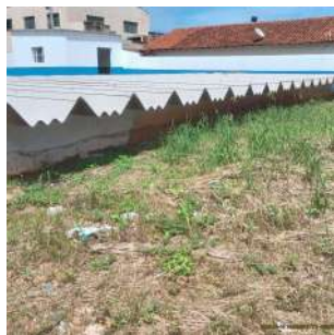
Foto 3 - Vista da cobertura do reservatório.
