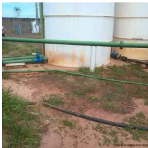
Foto 2 - Tubulação de saída do reservatório.
