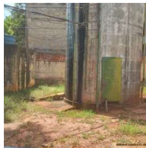
Foto 4 - Vista da base do reservatório.
