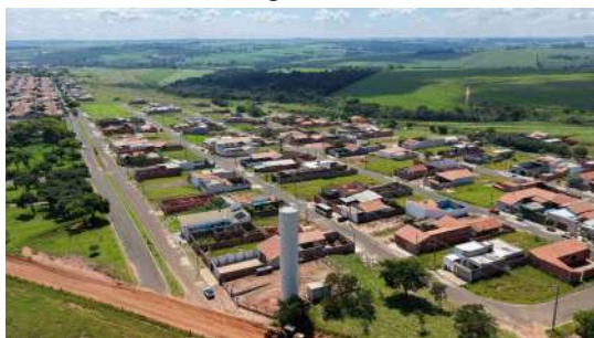
Foto 9 - Vista aérea da área operacional do Poço P6.
