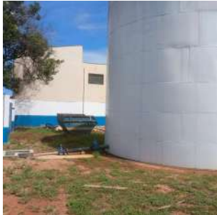
Foto 1 - Vista geral do reservatório metálico.
