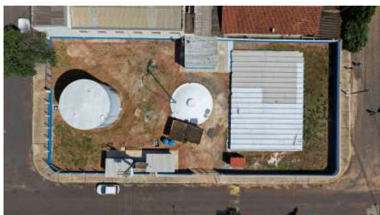
Foto 7 - Vista aérea da área operacional do Poço P4.
