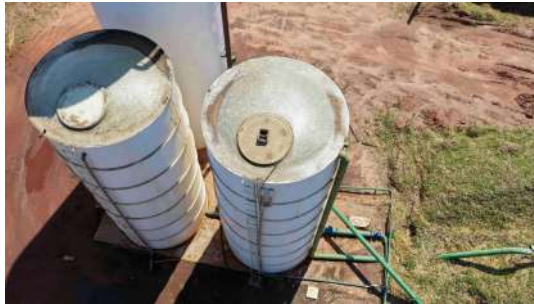
Foto 4 - Vista aérea dos reservatórios apoiados de fibra.
