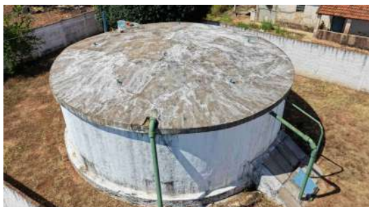
Foto 13 - Vista aérea do reservatório do Asilo.
