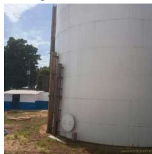
Foto 10 - Vista geral do reservatório metálico.
