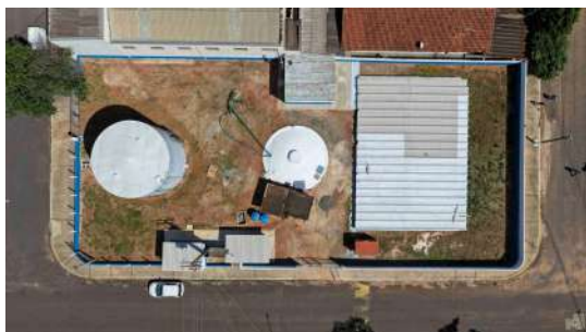
Foto 11 - Vista aérea da área operacional do Poço P4.
