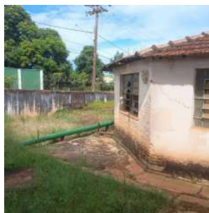
Foto 4 - Adutora que vem dos poços P2, P3 e continua até o P4.
