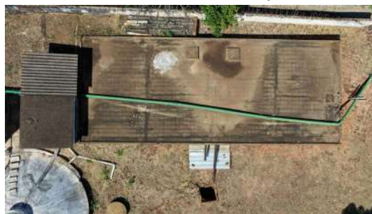
Foto 10 - Reservatório retangular desativado.
