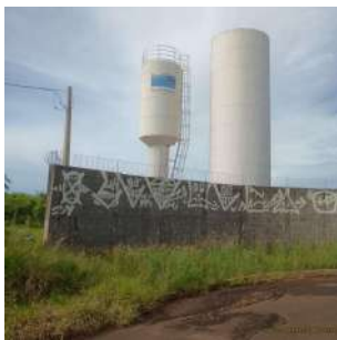
Foto 1 - Vista externa do centro de reservação
