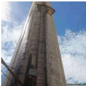
Foto 11 - Vista geral do reservatório elevado.
