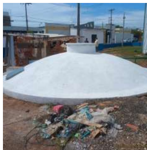
Foto 2 - Vista geral do reservatório Globo.
