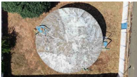
Foto 9 - Vista aérea do reservatório do Asilo.
