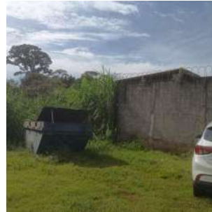
Foto 2 - Vista externa da entrada da EEE e caçamba para remoção de material retido no gradeamento da EEE.
