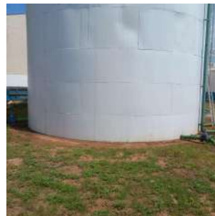
Foto 5 - Vista geral do reservatório metálico.
