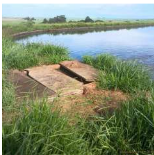
Foto 5 - Caixa de chegada do esgoto bruto na primeira lagoa.
