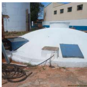
Foto 3 - Vista geral do reservatório Globo.
