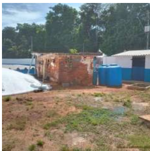
Foto 1 - Vista geral da EEAT.
