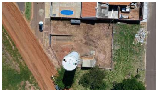
Foto 10 - Vista aérea da área operacional do Poço P6.
