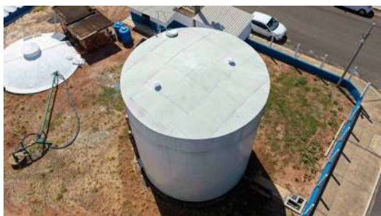
Foto 14 - Vista aérea do reservatório metálico.
