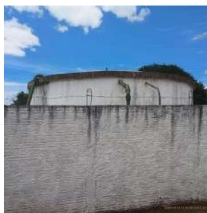
Foto 2 - Vista externa da área do reservatório.
