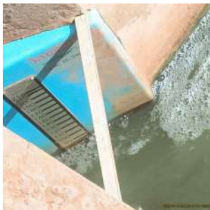
Foto 27 - Macromedicação por Calha Parshall, na saída do efluente tratado.
