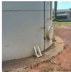
Foto 8 - Vista geral do reservatório e SPDA.
