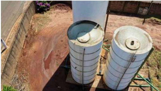
Foto 3 - Vista aérea dos reservatórios apoiados de fibra.
