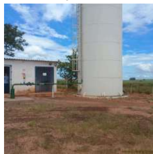
Foto 4 - Vista geral do reservatório.
