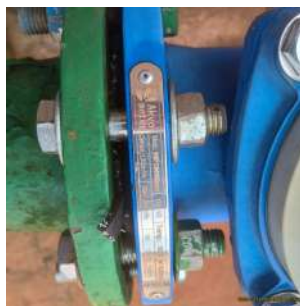
Foto 6 - Macromedidor do poço.
