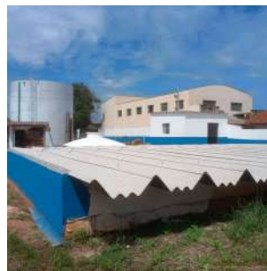
Foto 4 - Vista da cobertura do reservatório.
