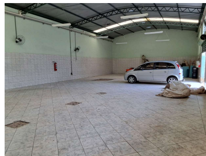
Foto 2 - Unidade de triagem desativada
