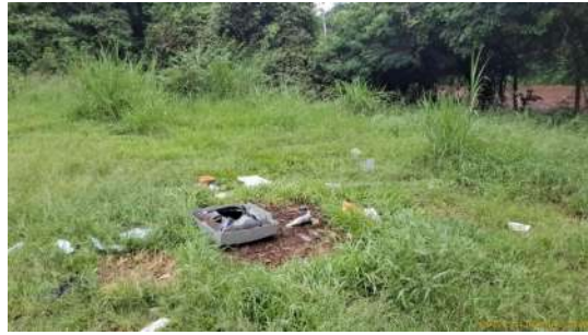
Foto 2 - Espalhamento de resíduos e necessidade de roçada.
