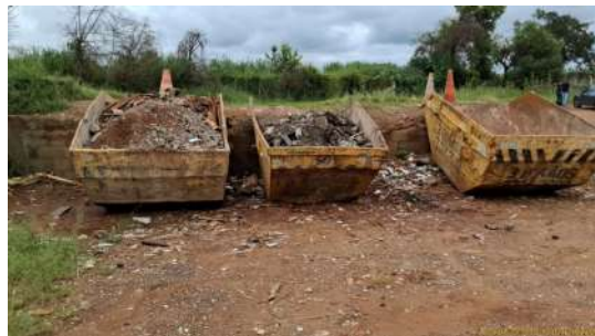
Foto 8 - Caçambas brooks, RCC
