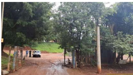
Foto 1 - Visão geral, externa
