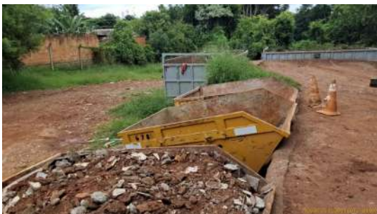
Foto 15 - Caçambas brooks, RCC
