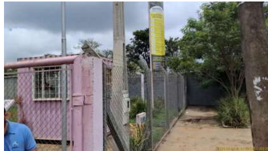
Foto 16 - Visão geral, externa
