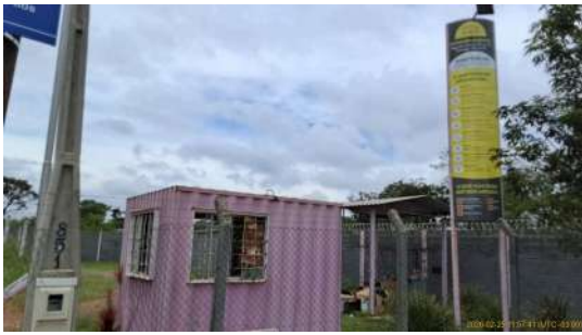
Foto 1 - Visão geral, externa
