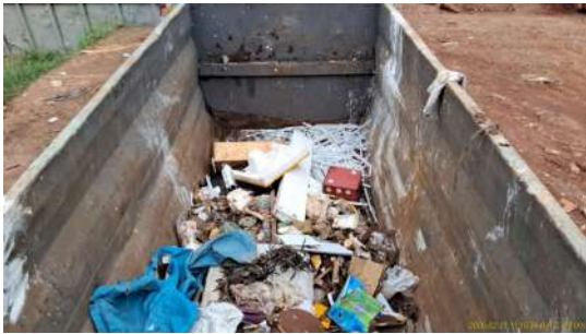
Foto 1 - Presença de lâmpadas fluorescentes no interior de caçamba roll on, sem segregação adequada
