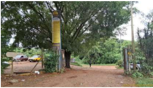
Foto 1 - Visão geral, externa
