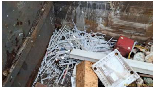
Foto 2 - Presença de lâmpadas fluorescentes no interior de caçamba roll on, sem segregação adequada
