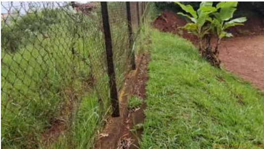
Foto 21 - Isolamento da unidade
