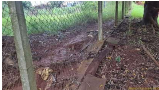
Foto 20 - Isolamento da unidade
