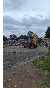
Foto 2 - Área superior - recebimento de resíduos
