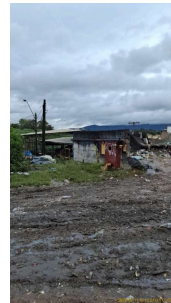
Foto 4 - Área superior - recebimento de resíduos
