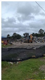
Foto 5 - Área superior - recebimento de resíduos
