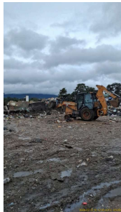
Foto 3 - Área superior - recebimento de resíduos
