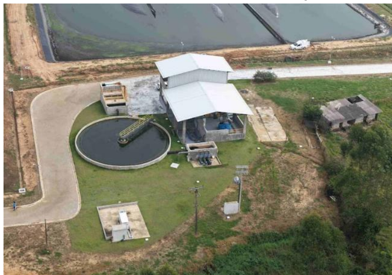
Foto 1 – Vista aérea do sistema terciário (decantador e tratamento do lodo).
