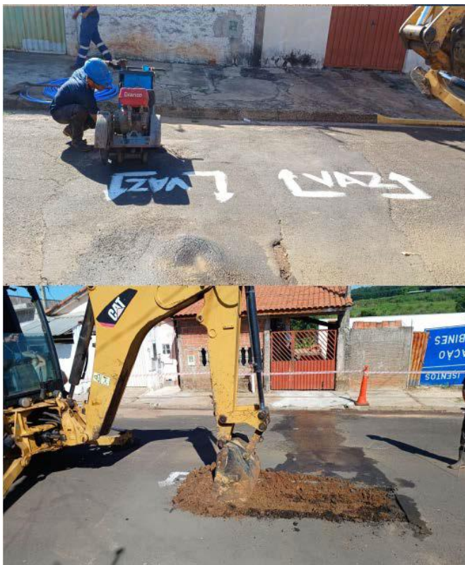
Foto 2 – Marcação do trecho de rede com vazamento e abertura de vala para correção do vazamento. Fonte: RELATÓRIO FINAL. Prefeitura Municipal de Itirapina. Outubro/2025.
