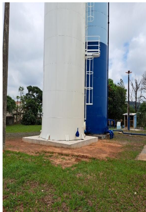
Foto 2 – Novo reservatório elevado da Rua Cinco (branco).
