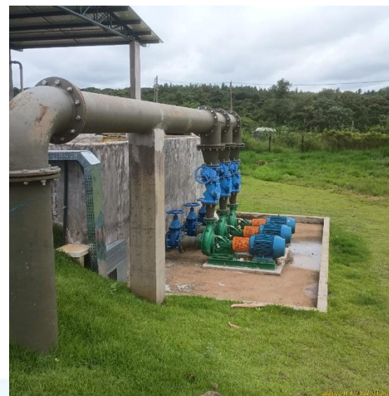
Foto 6 – Recalque do efluente tratado (pós sistema terciário) para o emissário final.
