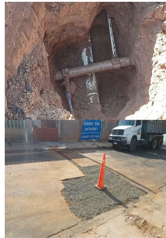
Foto 3 – Abertura de vala para correção do vazamento. Fonte: RELATÓRIO FINAL. Prefeitura Municipal de Itirapina. Outubro/2025.
