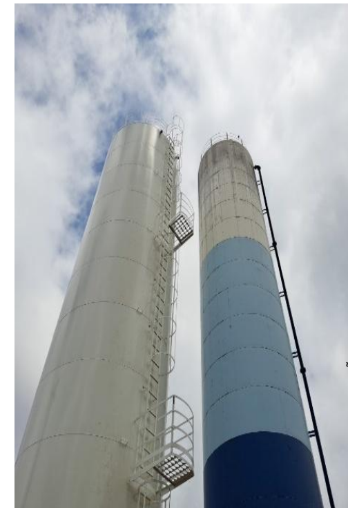
Foto 3 – Novo reservatório elevado da Rua Cinco (branco).
