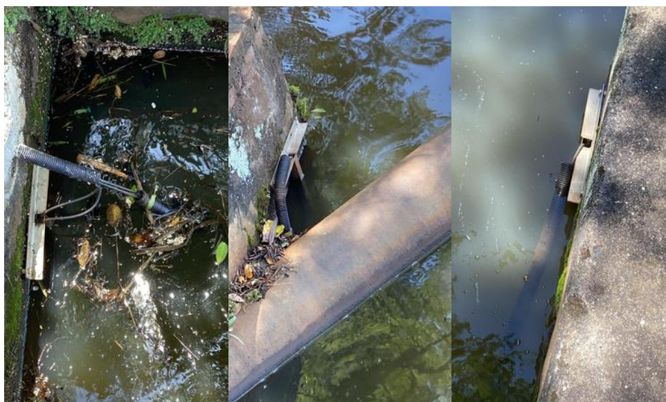
Figura XX: Ponto de instalação do transdutor USB- Subsuperficial.
