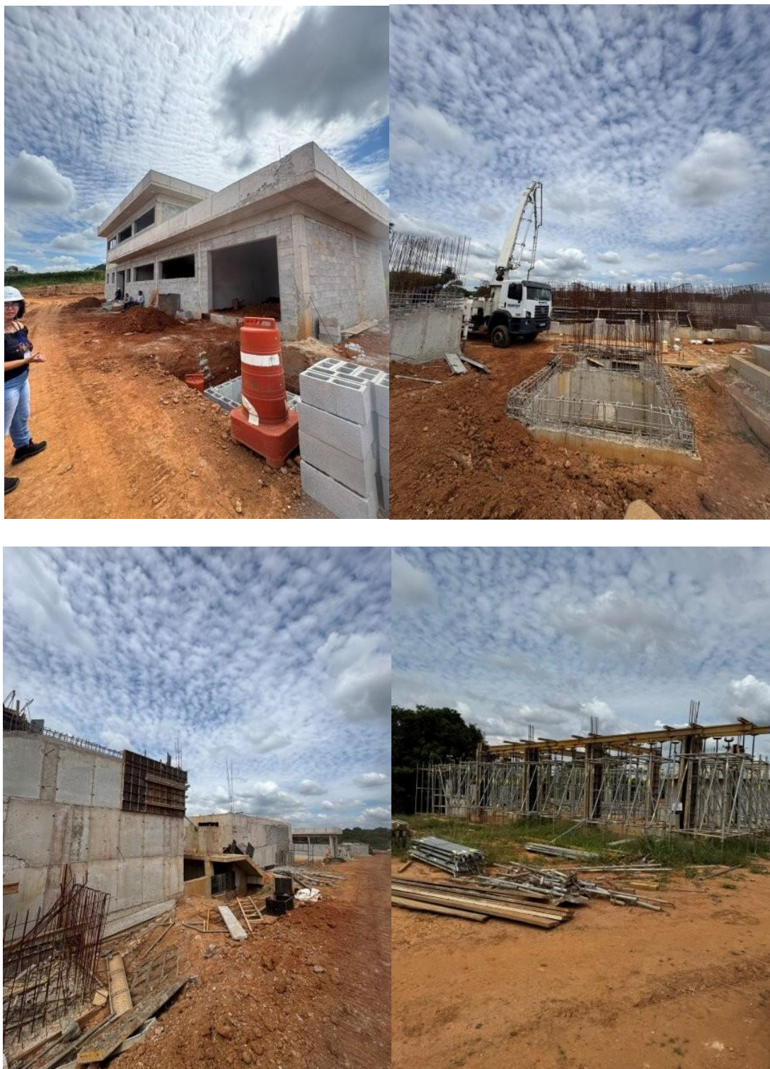
Figura TEC 5 – Execução da 1ª Etapa da ETA VI – Vazão de 150 L/s
