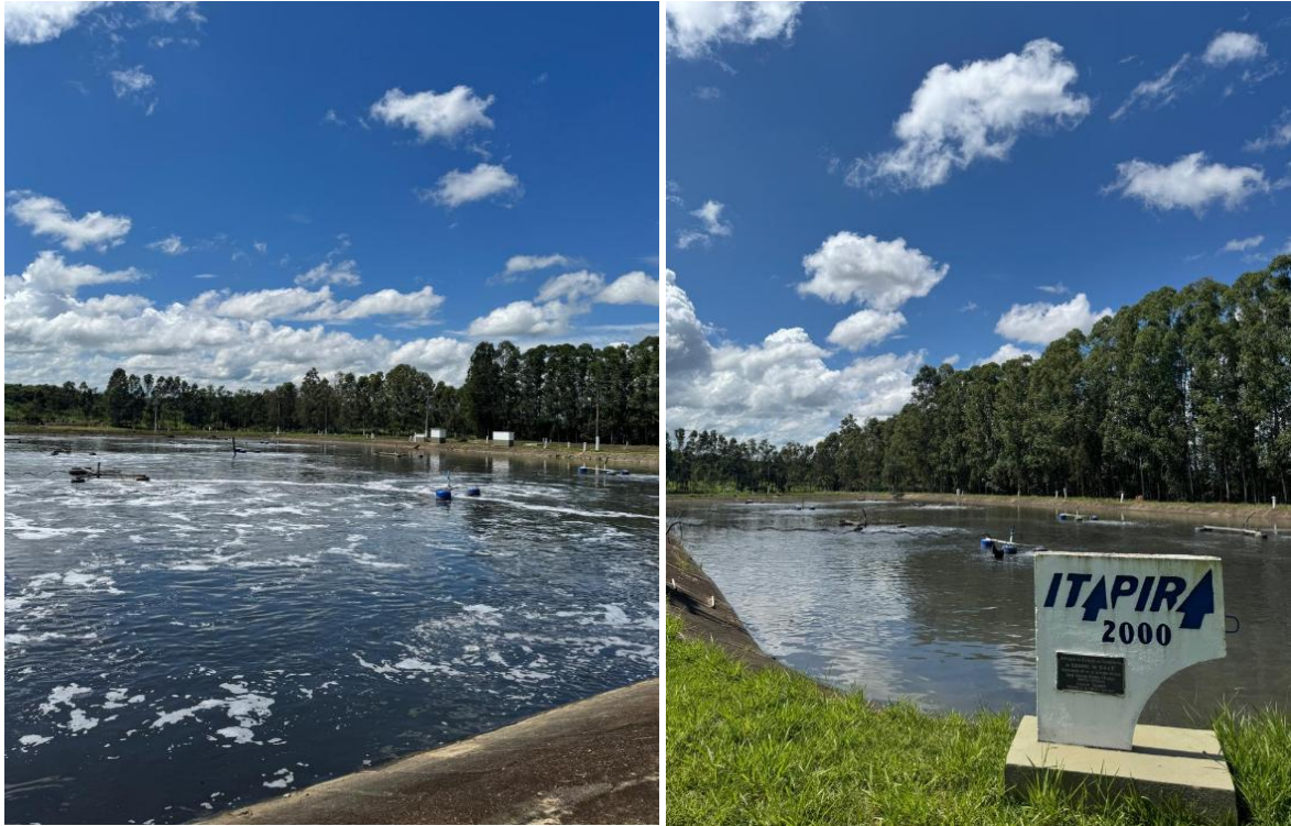
Figura TEC 5 – Aquisição e instalação de aeradores para a ETE
