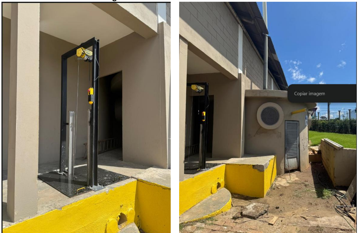
Figura TEC 4 – Reforma da EEEB Penha
