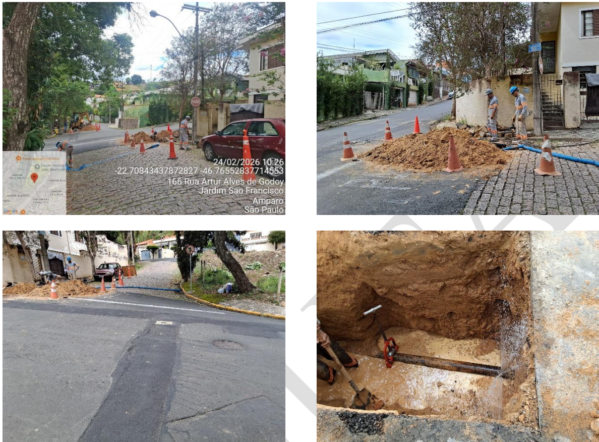
Figura TEC 8 – Substituição de redes na Rua Arthur Alves de Godoy.
