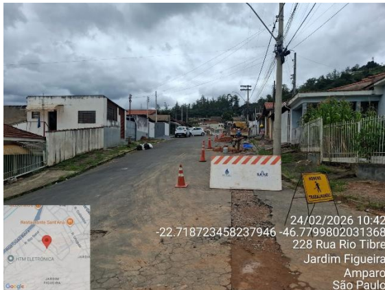
Figura TEC 4 – Substituição de redes no Jardim Figueira.
