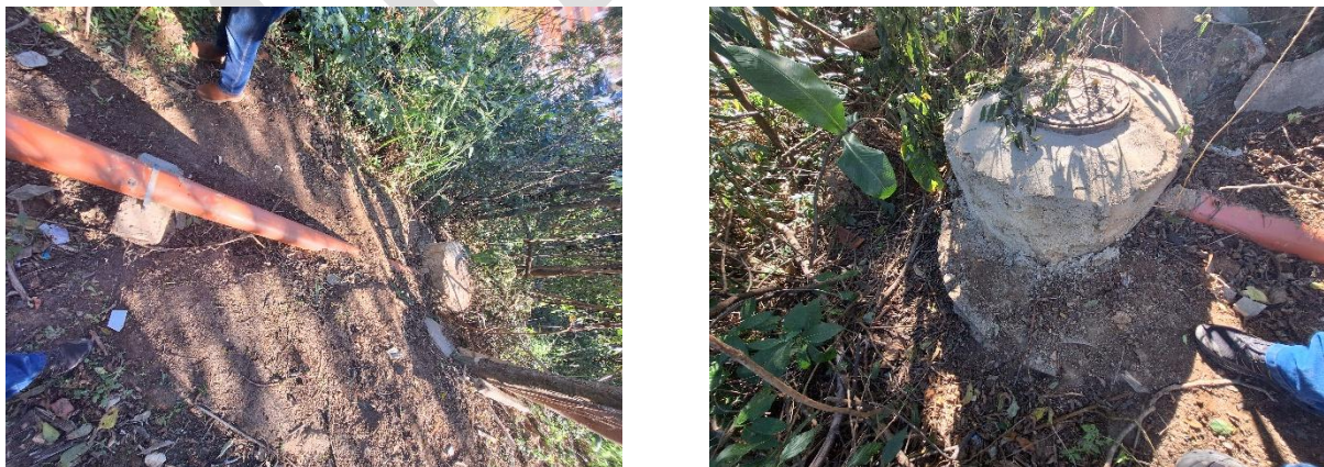
Figura TEC 9 – Obra de reparo de esgoto na viela sanitária, Rua Vaticano, Jardim Itália (Fonte: SAAE Amparo)
