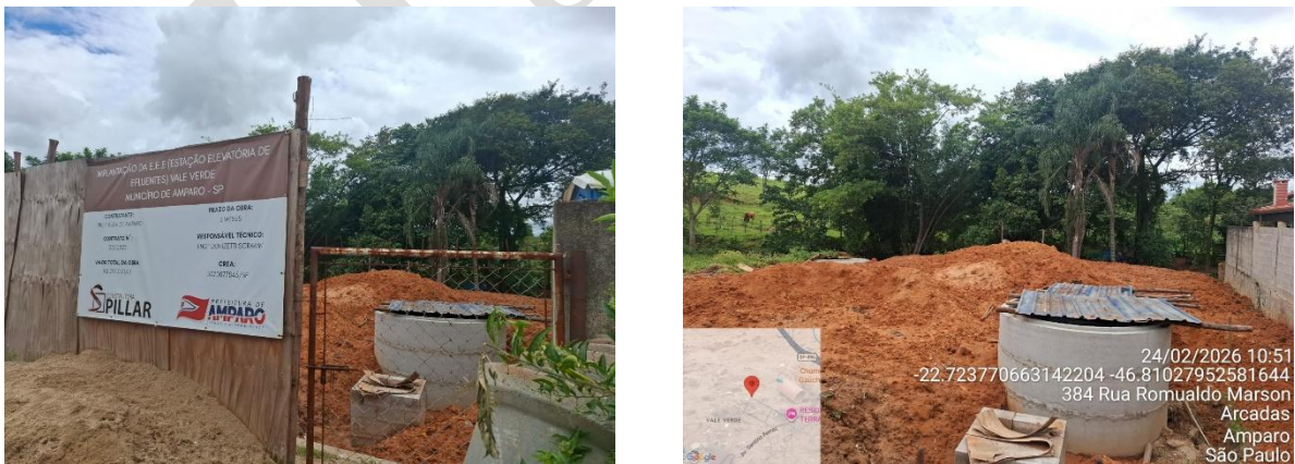
Figura TEC 7 – Implantação de Estação Elevatória de Esgoto no Loteamento Vale Verde
