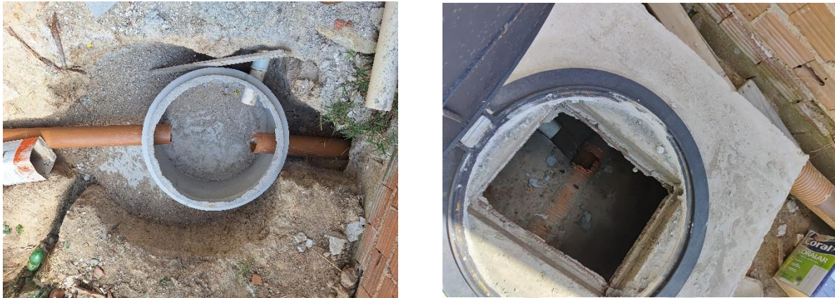
Figura TEC 10 – Execução de substituição de rede coletora de esgotos, localizada em viela adjacente a Rua Moises Turato Filho, Silvestre (Fonte: SAAE Amparo)
