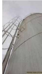
Foto 4 - Vista geral do reservatório.
