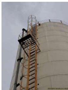
Foto 1 - Tubo extravasor, no alto, à direita da escada.
