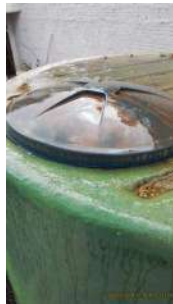
Foto 3 - Tampa de inspeção
