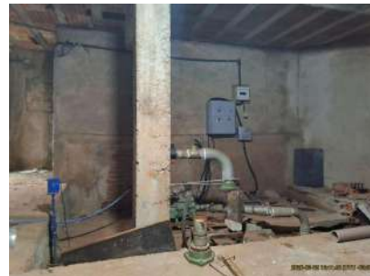
Foto 3 - Vista geral da EEA.
