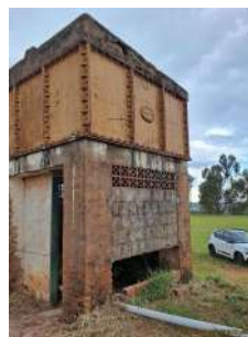
Foto 5 - Vista geral do reservatório.
