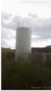
Foto 1 - Vista geral do reservatório.
