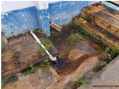
Foto 9 - Drenagem da água de lubrificação de gaixetas, saindo da edificação com bombas 1 e 2.
