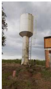
Foto 1 - Vista geral do reservatório.
