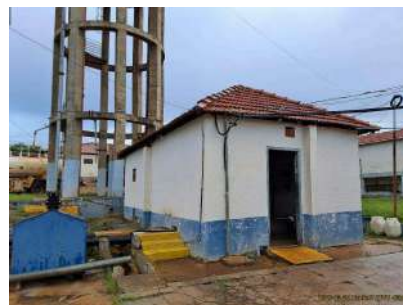
Foto 5 - Vista externa da edificação que abriga os conjuntos motobomba 1 e 2 (recalque para reservatório elevado).
