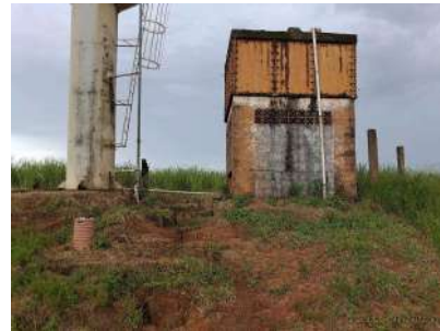
Foto 2 - Vista geral da área onde se localizam os reservatórios. Não há qualquer tipo de cercamento que evite acesso indevido.
