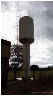
Foto 5 - Vista geral do reservatório, evidenciando escada e guarda corpo..
