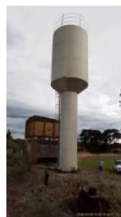
Foto 4 - Vista geral do reservatório.
