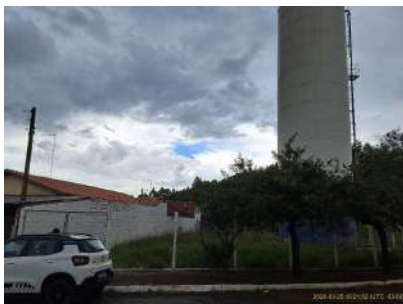
Foto 1 - Vista geral da área onde se encontra o reservatório, a partir do passeio público, evidenciando cercamento da área.
