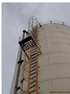
Foto 6 - Tubo extravasor, no alto, à direita da escada.
