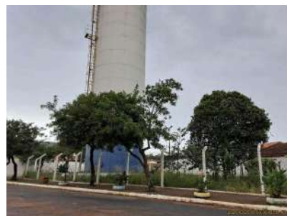
Foto 5 - Vista geral da área, a partir do passeio público.
