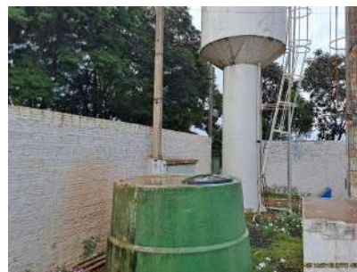
Foto 2 - Vista parte inferior do reservatório.
