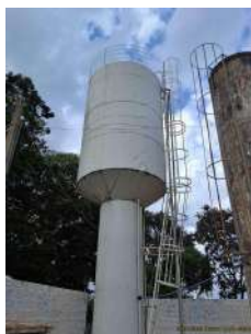
Foto 1 - Vista geral do reservatório evidenciando escada e guarda corpo.
