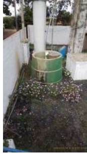
Foto 1 - Vista geral do reservatório.
