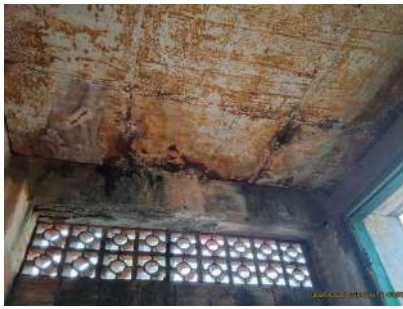
Foto 7 - Vista geral da parte interna da estrutura de alvenaria sob o reservatório.
