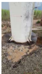
Foto 3 - Vista da base do reservatório.
