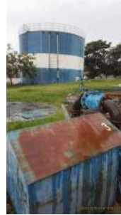
Foto 2 - Vista do reservatório apoiado (ao fundo), que recebe a água recalçada pela EEA fiscalizada.
