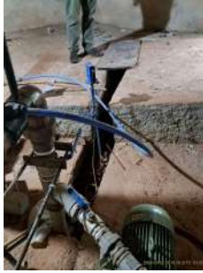
Foto 1 - Cortes no piso e valas abertas.
