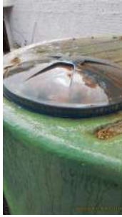
Foto 1 - Tampa de inspeção do reservatório.
