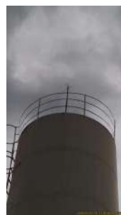
Foto 13 - Antena do SPDA instalado na estrutura.
