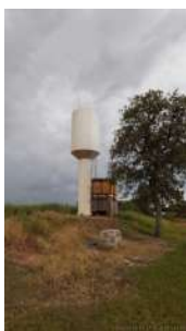
Foto 12 - Vista geral da área onde se encontra o reservatório.
