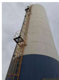
Foto 4 - Escadas e guarda corpos do reservatório.
