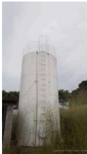
Foto 5 - Vista geral do reservatório.
