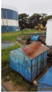
Foto 1 - Vista do abrigo metálico onde se localiza o conjunto moto bomba.
