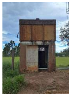
Foto 3 - Vista geral do reservatório.
