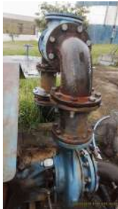
Foto 5 - Tubulação de recalque.
