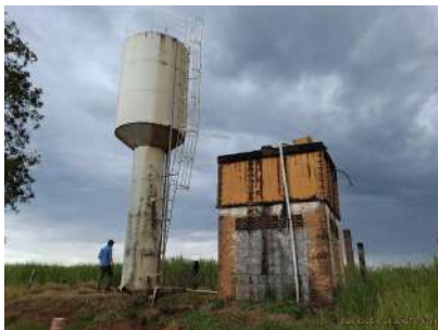
Foto 1 - Vista geral da área onde se encontra o reservatório.
