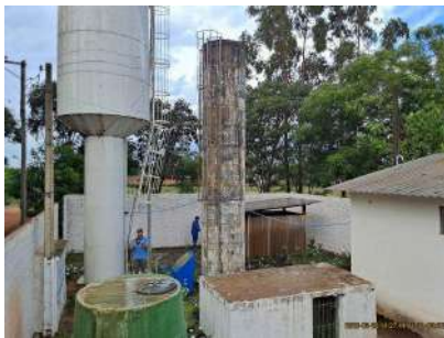
Foto 1 - Parte inferior da escada em ângulo maior que 90° (ângulo negativo, centro de gravidade do operador restará fora da base da escada).
