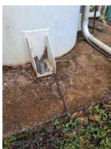
Foto 4 - Aterramento da estrutura.
