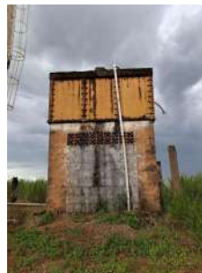
Foto 2 - Vista geral do reservatório.
