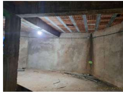
Foto 2 - Vista da parte interna da edificação onde se localiza a EEA.
