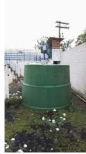
Foto 2 - Vista geral do reservatório.
