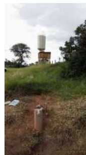
Foto 9 - Tubulação para conexão de caminhão pipa para abastecimento dos dois reservatórios existentes no local.
