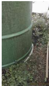
Foto 5 - Vista da lateral do reservatório, próximo ao nível do solo.
