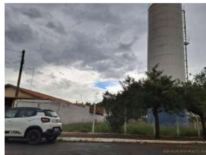
Foto 2 - Vista geral da área onde se encontra o reservatório, a partir do passeio público, evidenciando cercamento da área.
