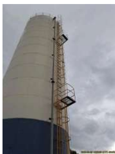
Foto 3 - Tubo de alimentação, escadas e guarda corpos do reservatório.
