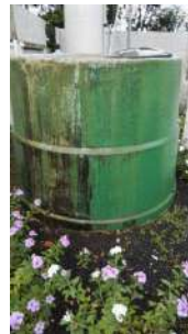
Foto 6 - Vista geral do reservatório.
