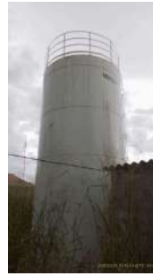
Foto 2 - Vista geral do reservatório.
