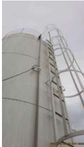
Foto 3 - Vista geral do reservatório.
