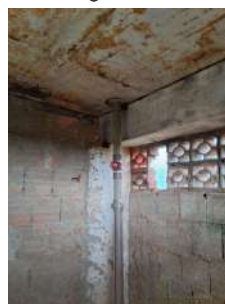
Foto 6 - Vista geral da parte interna da estrutura de alvenaria sob o reservatório.
