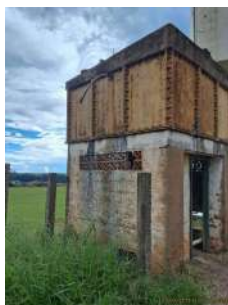
Foto 4 - Vista geral do reservatório, evidenciando tubo extravasor.
