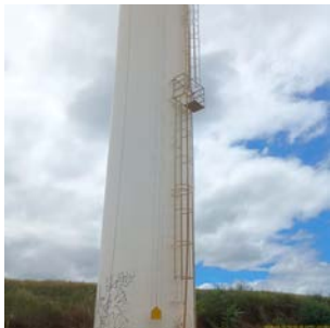
Foto 3 - Vista geral do reservatório.
