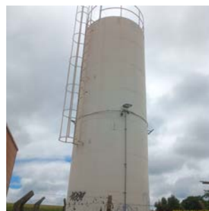
Foto 2 - Vista geral do reservatório.
