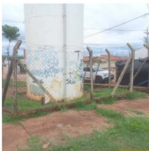
Foto 1 - Cercamento do reservatório.
