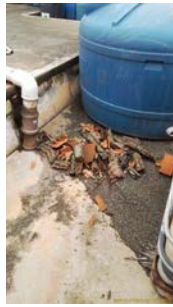
Foto 19 - Material retirado de dentro do reservatório
