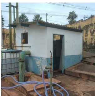
Foto 3 - Casa de bombas da EEAT.
