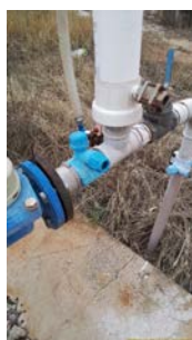
Foto 6 - Tomada de água bruta
