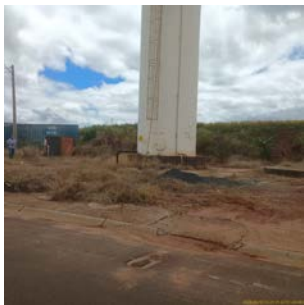
Foto 1 - Vista geral do reservatório e seu entorno.
