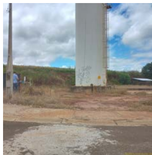
Foto 2 - Vista geral do reservatório e entorno.
