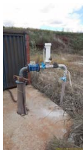
Foto 2 - Vista geral do poço
