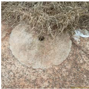
Foto 3 - Localização dos pontos da calçada de acesso aos registros.
