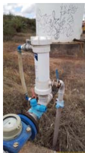
Foto 4 - Clorador e Fluoretação via pastilha
