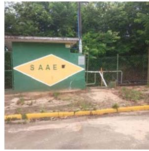
Foto 2 - Vista externa da EEE.
