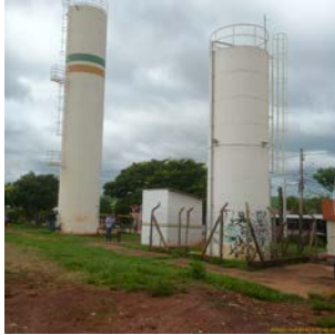
Foto 5 - Vista dos dois reservatórios São Pedro (novo à esquerda e novo à direita).
