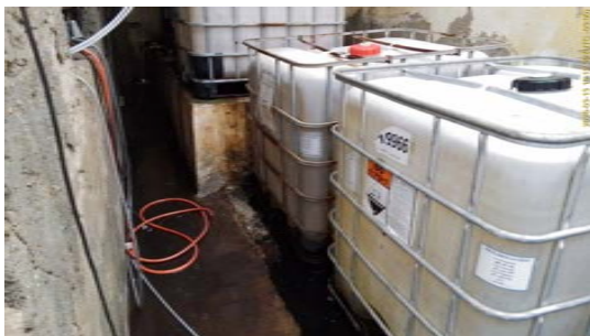
Foto 6 - IBC sem tanque de contenção
