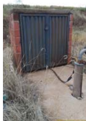
Foto 3 - Casa do painel elétrico. Não foi aberto no dia, pois não havia chave.
