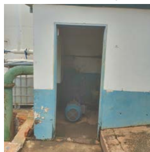
Foto 4 - Casa de bombas da EEAT.
