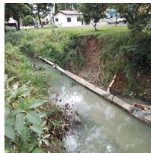
Foto 2 - Trecho do coletor tronco passando a ser envelopado
