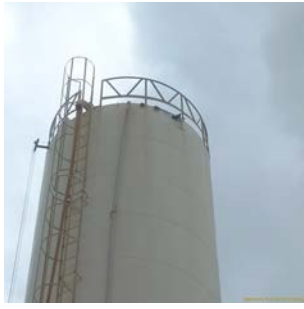
Foto 1 - Vista da parte superior do reservatório.
