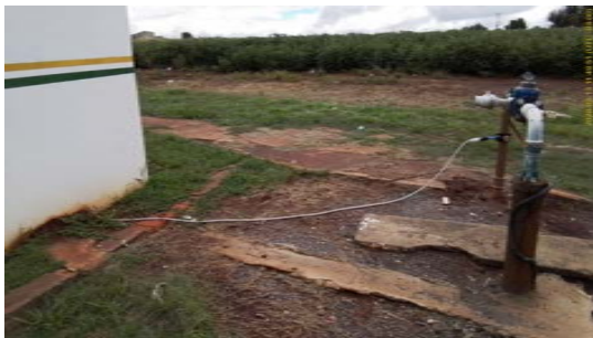
Foto 1 - A área não está cercada, permitindo acesso de pessoas estranhas a operação.
