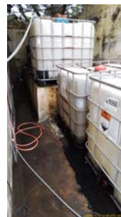
Foto 7 - IBC sem tanque de contenção e local apertado tanto para manobras de carga/descarga, quanto de manuseio
