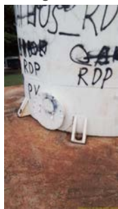
Foto 3 - Tampa de inspeção
