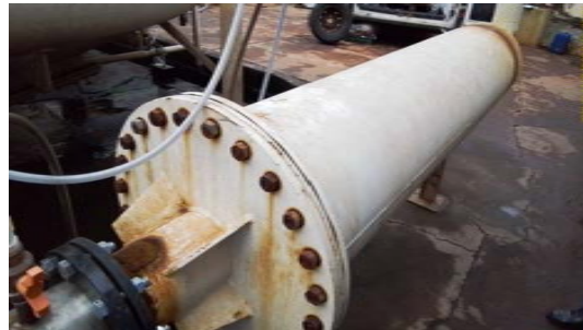
Foto 7 - Misturador rápido tubular
