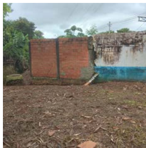
Foto 3 - Tubulação saindo da ETA III em direção à Represa.
