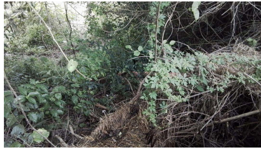
Foto 2 - Tubulação de esgoto direcionada para uma área verde
