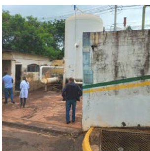
Foto 1 - Entrada da ETA III.
