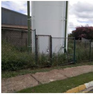
Foto 1 - Entrada ao reservatório
