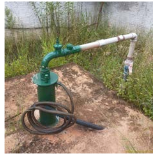
Foto 4 - Vista geral do poço.
