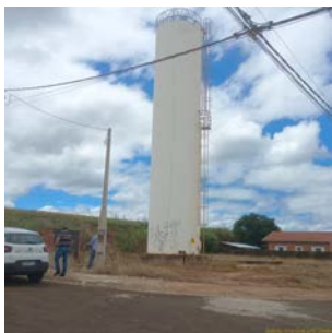
Foto 1 - Vista geral do reservatório e entorno.
