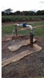
Foto 1 - Vista geral do poço
