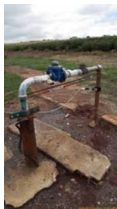
Foto 2 - Vista geral do poço
