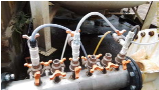
Foto 5 - Aplicação de carvão ativado, cloro e PAC 18 (respectivamente)
