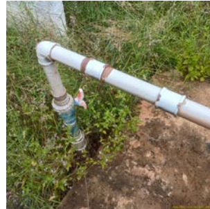
Foto 6 - Vista geral do poço.
