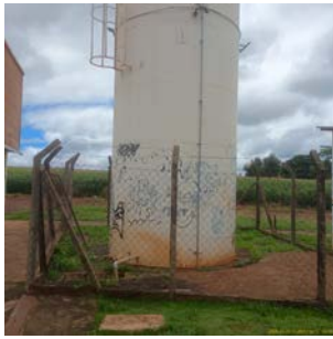
Foto 3 - Vista geral do reservatório.
