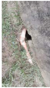
Foto 1 - Tubulação de esgoto próxima ao muro da Escola
