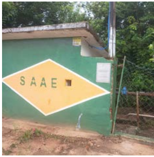
Foto 1 - Vista externa da EEE.
