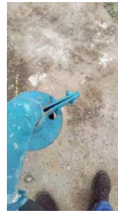
Foto 2 - Proteção para medidor de nível, porém não existe tal dispositivo
