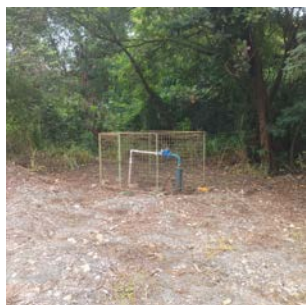
Foto 1 - Vista geral do poço e entorno.
