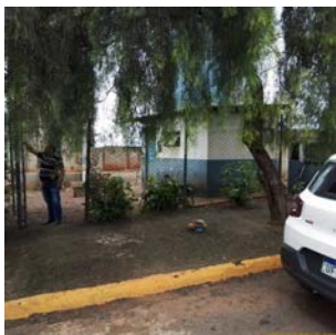
Foto 1 - Entrada do Centro de Reservação
