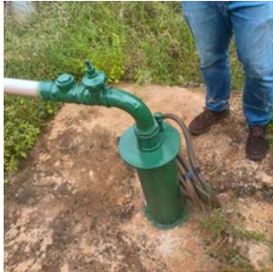
Foto 5 - Vista geral do poço.
