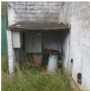
Foto 3 - Situação da laje dentro da área do poço.
