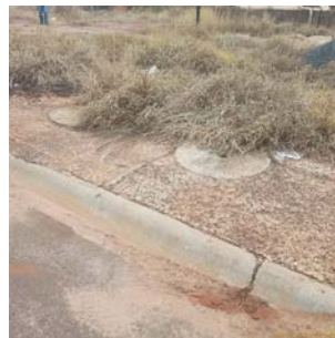
Foto 2 - Localização dos pontos da calçada de acesso aos registros.
