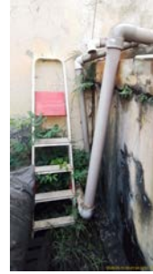
Foto 2 - Escada que o técnico precisa utilizar para coletar água bruta dos poços
