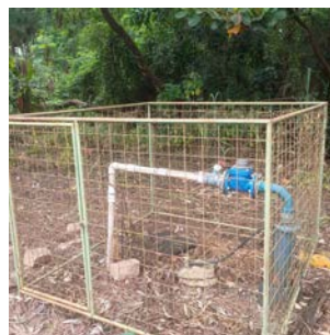
Foto 2 - Vista geral do poço e entorno.
