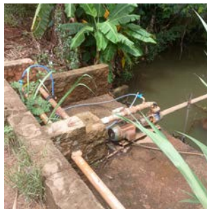
Foto 8 - Local de captação do sistema de retorno.
