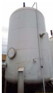
Foto 8 - Vista do decantador compacto
