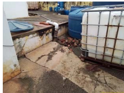
Foto 18 - Vista de cima do reservatório de água tratada semienterrado
