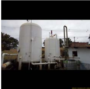
Foto 3 - Conjunto decantador e filtro rápido
