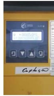
Foto 2 - Apesar de estar escrito Captação, medidor está na saída da ETA
