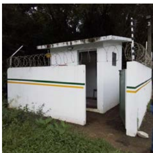
Foto 1 - Local não possui placa de identificação
