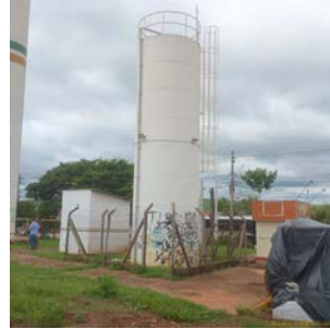
Foto 6 - Vista geral do reservatório.
