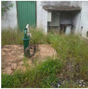
Foto 3 - Vista geral interna.
