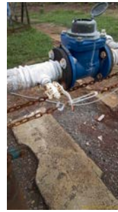
Foto 6 - Tomada de água bruta
