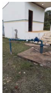
Foto 2 - Vista geral do poço
