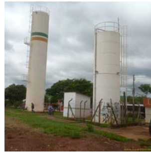
Foto 4 - Vista dos dois reservatórios São Pedro (novo à esquerda e novo à direita).
