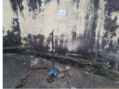
Foto 4 - Registro para manobra de água da ETA I
