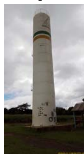
Foto 4 - Vista geral do reservatório
