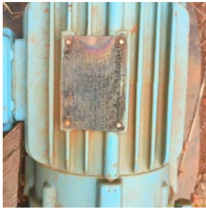
Foto 3 - Placa de especificações técnicas do motor do equipamento 1.
