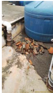
Foto 5 - Material retirado de dentro do reservatório
