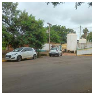
Foto 2 - Vista da ETA III.
