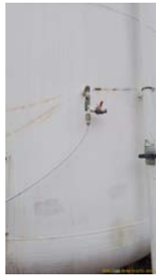
Foto 10 - Local de aplicação do polímero para auxiliar na formação dos flocos
