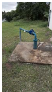
Foto 1 - Vista geral do poço
