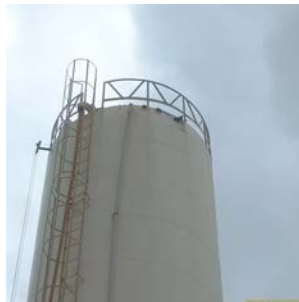
Foto 4 - Vista geral do reservatório.
