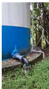
Foto 5 - Lateral do reservatório
