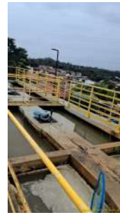
Foto 4 - Tanques floculadores
