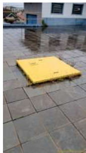
Foto 3 - Tampa de inspeção
