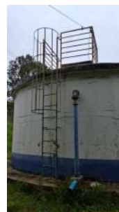
Foto 4 - Escada de acesso para manutenções
