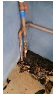
Foto 6 - Ponto para tomada de água para análises
