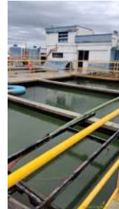
Foto 6 - Tanques de decantação
