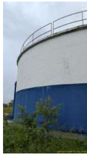
Foto 1 - Lateral do reservatório
