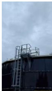
Foto 5 - Escada de acesso para manutenções
