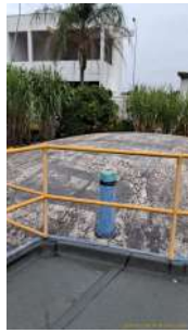
Foto 1 - Parte superior do reservatório
