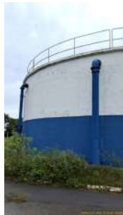
Foto 5 - Lateral do reservatório
