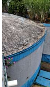
Foto 3 - Lateral do reservatório
