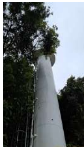
Foto 1 - Lateral do reservatório
