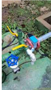
Foto 7 - Ponto para coleta de água de água para análises
