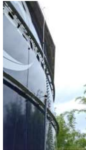
Foto 3 - Lateral do reservatório
