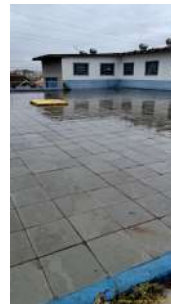
Foto 2 - Parte superior do reservatório
