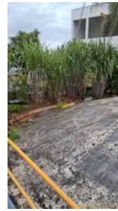
Foto 2 - Parte superior do reservatório
