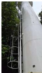
Foto 3 - Escada de acesso e guarda-corpo
