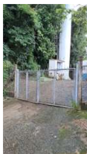
Foto 1 - Não há placa de identificação no local. A não conformidade já foi apontada na ficha do Poço Jardim Floresta, pois os dois subsistemas estão localizados no mesmo terreno
