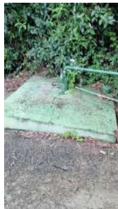
Foto 1 - Base de concreto
