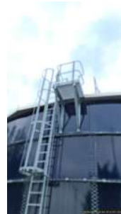
Foto 4 - Escada de acesso para manutenções
