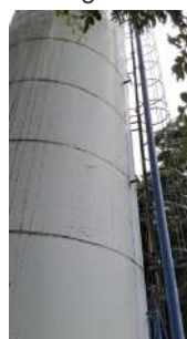
Foto 6 - Lateral do reservatório
