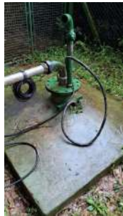
Foto 9 - Base de concreto do poço
