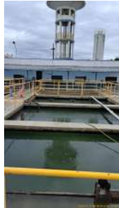
Foto 5 - Tanques de decantação
