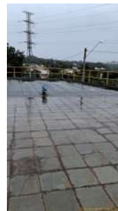
Foto 4 - Parte superior do reservatório
