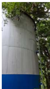
Foto 4 - Lateral do reservatório
