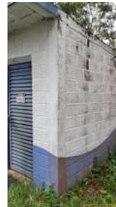
Foto 5 - Construção onde está instalada a EEA
