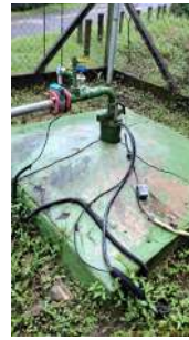
Foto 6 - Base de concreto
