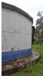
Foto 3 - Lateral do reservatório
