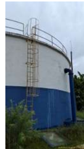
Foto 6 - Escada de acesso para manutenções
