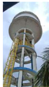
Foto 2 - Escada de acesso para manutenções
