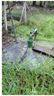
Foto 1 - Base de concreto do poço
