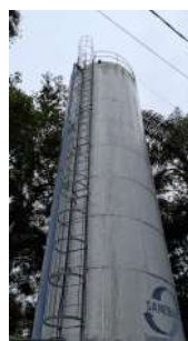
Foto 2 - Reservatório Elevado Alameda Arandu
