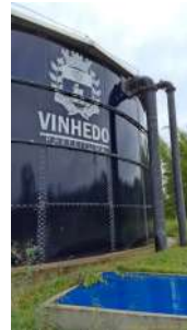
Foto 2 - Lateral do reservatório
