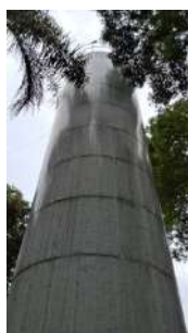
Foto 5 - Lateral do reservatório
