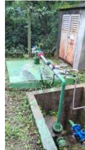
Foto 8 - Estrutura do poço
