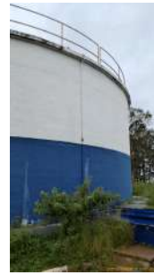
Foto 2 - Lateral do reservatório
