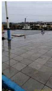
Foto 1 - Parte superior do reservatório
