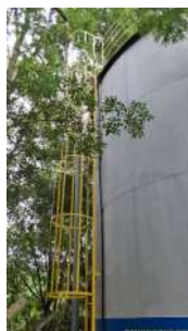
Foto 3 - Escada de acesso à parte superior do reservatório
