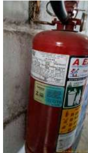
Foto 7 - Destaque para etiqueta com a validade do extintor (junho/2026)
