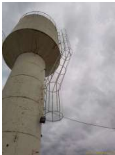
Foto 1 - Detalhe da escada inclinada.
