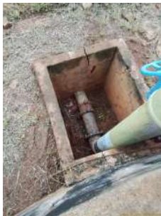
Foto 3 - Saída do reservatório.
