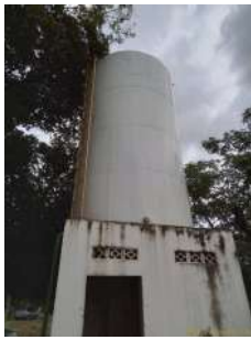
Foto 5 - Detalhe do reservatório 2.
