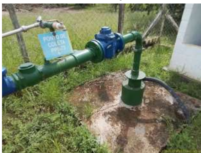
Foto 3 - Cavalete e laje do poço.
