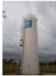
Foto 6 - Vista do reservatório.
