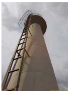
Foto 3 - Detalhe do guarda-corpos.
