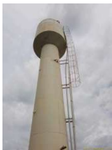
Foto 1 - Vista do reservatório.
