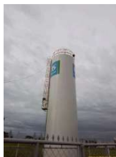
Foto 2 - Vista do reservatório.
