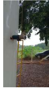
Foto 2 - Tubulação removida - imagem cedida pela prestadora de serviços.
