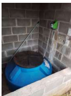
Foto 5 - Aplicação de cloro e flúor.
