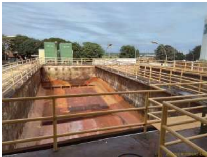
Foto 1 - Vista dos decantadores esvaziados.
