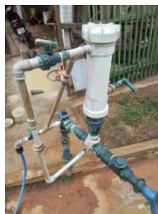
Foto 4 - Aplicação de cloro e flúor.
