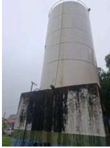
Foto 1 - Detalhe da estrutura da base do reservatório.
