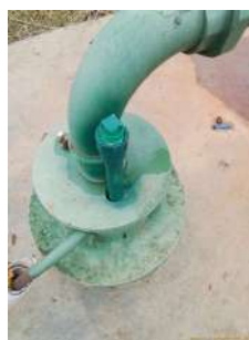
Foto 2 - Tubo de medição de nível.
