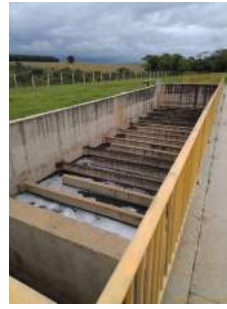
Foto 20 - Chicanas para desinfecção do efluente tratado.
