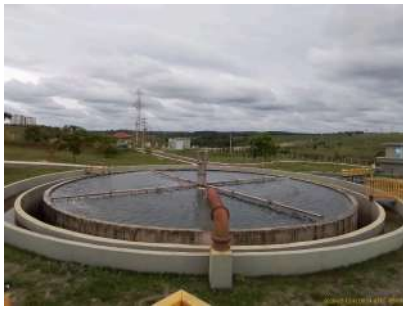
Foto 10 - Filtro 1 após os tanques de lodo ativado.
