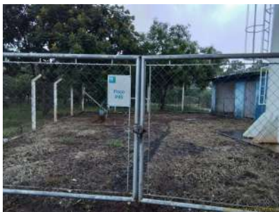
Foto 1 - Cercamento e identificação do local.
