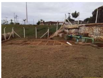
Foto 1 - Vista da captação
