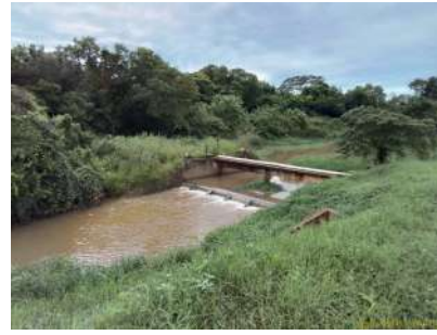
Foto 4 - Vista da represa junto à captação.
