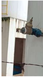
Foto 3 - Tubulação removida - imagem cedida pela prestadora de serviços.
