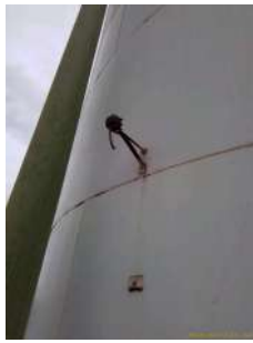
Foto 5 - Haste para suporte ao condutor de descida sem o mesmo.
