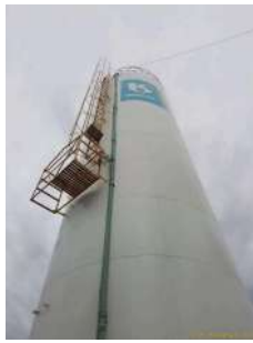
Foto 5 - Tubulação oriunda do P70, que abastece o reservatório.
