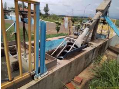
Foto 3 - Tratamento preliminar - rosca infinita.
