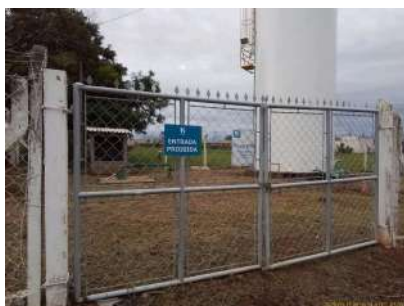
Foto 1 - Cercamento do local.
