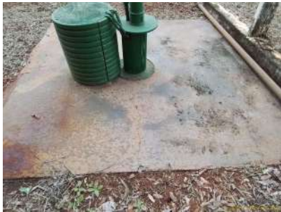
Foto 5 - Laje de proteção do poço.
