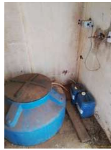
Foto 6 - Abrigo dos produtos químicos sob o reservatório 2.
