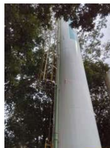
Foto 4 - Detalhe do reservatório 1.
