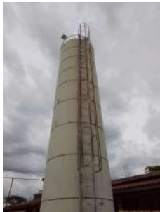
Foto 7 - Detalhe do guarda-corpo.
