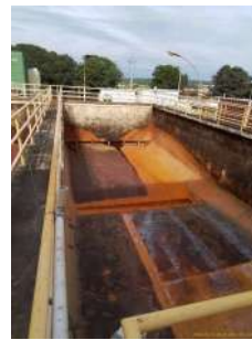
Foto 4 - Detalhe de um dos decantadores.
