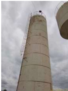
Foto 3 - Detalhe do reservatório 1.
