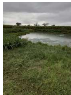
Foto 6 - Lagoa de chegada do efluente e cercamento ao fundo.
