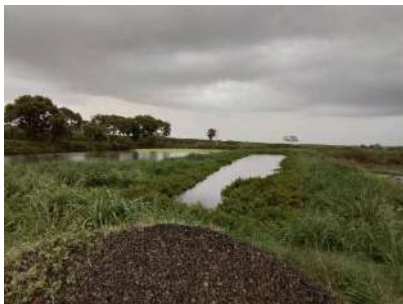
Foto 4 - Lagoas que recebem o efluente que eventualmente é evaporado ou infiltrado.
