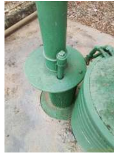
Foto 2 - Tubo de medição de nível.
