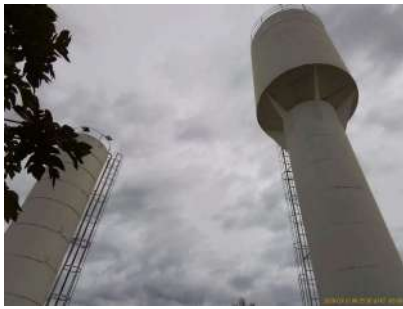
Foto 1 - Vista dos reservatórios.
