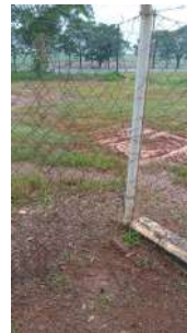
Foto 2 - Detalhe do reparo da abertura - imagem cedida pela prestadora de serviços.
