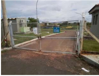
Foto 1 - Identificação da ETE.
