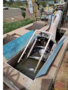
Foto 4 - Tratamento preliminar - rosca infinita.
