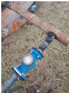
Foto 5 - Macromedição na saída do reservatório.
