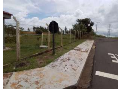
Foto 2 - Cercamento do local.
