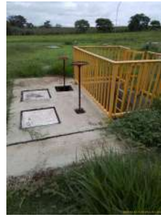
Foto 8 - Local próximo aos decantadores com abertura, representando risco aos operadores.
