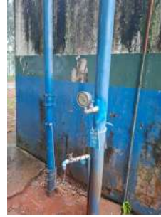
Foto 2 - Manômetro na saída do reservatório.
