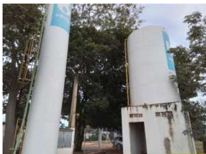
Foto 3 - Reservatórios vaso-comunicantes.
