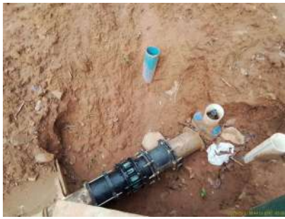
Foto 8 - Abertura de vala para manobra em registro ao lado do booster.
