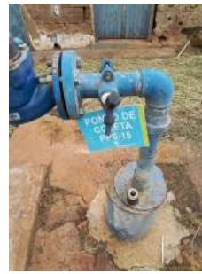
Foto 2 - Ponto para coleta de água.
