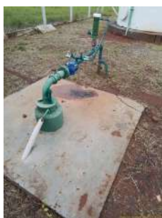
Foto 1 - Detalhe da laje de proteção.
