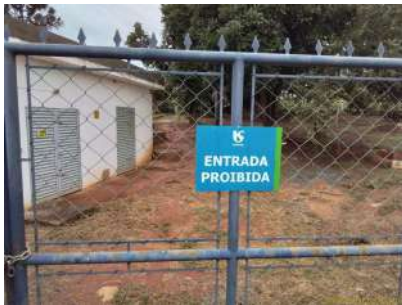
Foto 1 - Cercamento do local.
