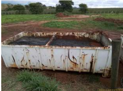
Foto 12 - Container utilizado para acúmulo de lodo e posterior encaminhamento a aterro.
