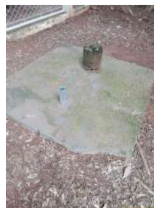
Foto 2 - Laje do poço desativado.
