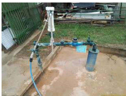
Foto 1 - Vista do poço e laje de proteção.
