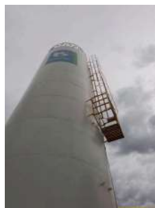
Foto 4 - Escadas e guarda-corpo.
