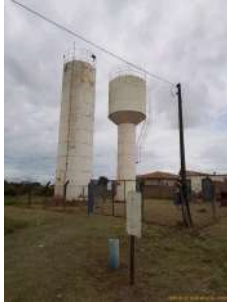
Foto 1 - Vista dos reservatórios.
