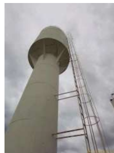
Foto 6 - Detalhe do guarda-corpo.
