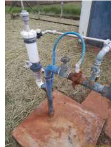
Foto 4 - Aplicação de cloro e flúor.
