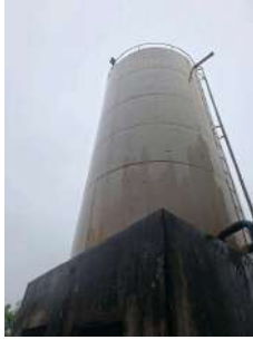
Foto 1 - Vista do reservatório.
