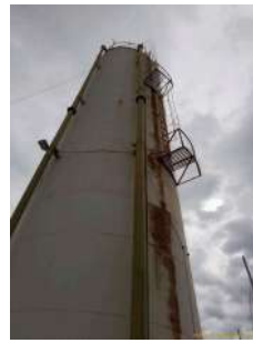
Foto 6 - Escada e guarda-corpos.
