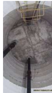
Foto 4 - Interior da câmara inferior
