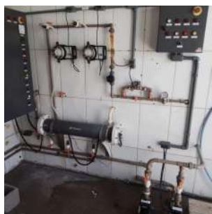
Foto 1 - Produção de cloro por eletrólise, transformando sal em hipoclorito de sódio.
