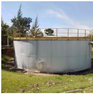
Foto 7 - Vista geral do reservatório metálico
