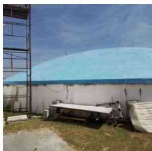
Foto 1 - Vista lateral do reservatório de 2.000 m 3
