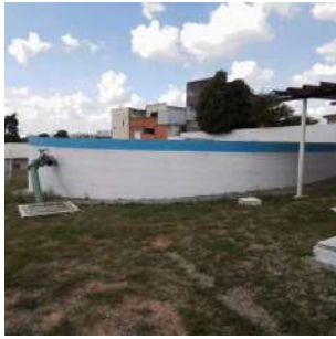
Foto 1 - Vista geral do reservatório
