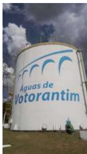
Foto 3 - Visão geral do reservatório
