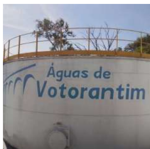
Foto 5 - Vista lateral do reservatório de 800 m 3
