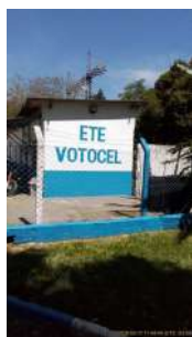
Foto 1 - Entrada da ETE
