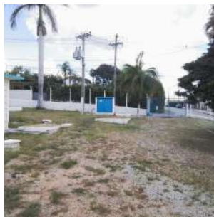
Foto 2 - Vista geral do Centro de Reservação
