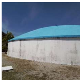
Foto 3 - Vista lateral do reservatório de 2.000 m 3
