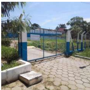
Foto 20 - Portão de acesso
