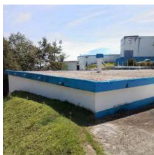
Foto 1 - Vista geral do reservatório de alvenaria
