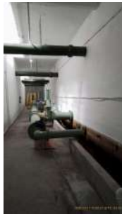
Foto 12 - Pintura interna. Área das saídas dos filtros.
