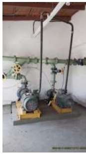
Foto 8 - Manutenção das bases das bombas e pintura
