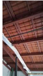
Foto 11 - Recuperação dos telhados da casa de bombas
