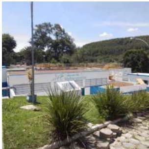
Foto 16 - Vista geral da ETA
