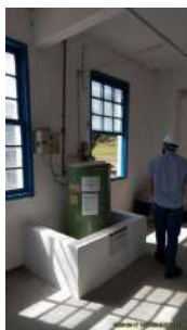
Foto 16 - Pintura e manutenção em dique de contenção
