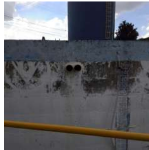
Foto 4 - Tubo extravasador
