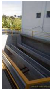
Foto 22 - Manutenção em um dos filtros
