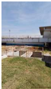
Foto 1 - Obras do tanque de equalização.
