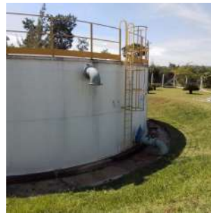
Foto 8 - Vista geral do reservatório metálico
