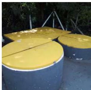
Foto 3 - Vista geral das tampas de inspeção
