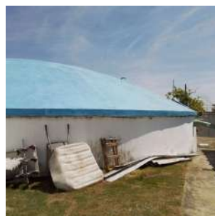
Foto 2 - Vista lateral do reservatório de 2.000 m 3
