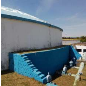
Foto 9 - Vista lateral do reservatório de 2.000 m 3
