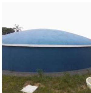
Foto 6 - Vista lateral do reservatório
