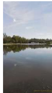
Foto 27 - Ao fundo, lagoa aerada. À frente, lagoa de decantação
