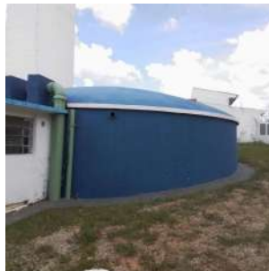
Foto 4 - Vista geral do reservatório
