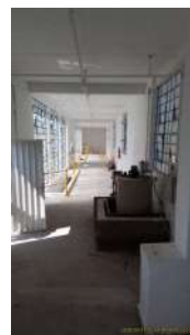
Foto 17 - Retrofit e pintura das área internas da ETA
