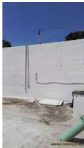
Foto 42 - Pintura externa dos decantadores
