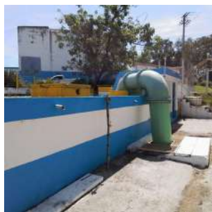
Foto 3 - Vista lateral do reservatório de alvenaria
