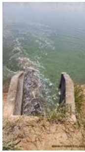
Foto 30 - Entrada na lagoa de maturação, após lagoa aerada e decantada.
