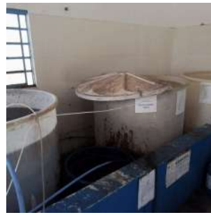
Foto 14 - Reservatório de ácido fluossilícico
