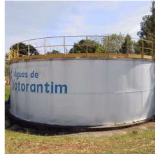
Foto 10 - Vista geral do reservatório metálico
