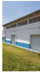
Foto 13 - Instalações dos sopradores
