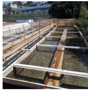
Foto 4 - Decantadores metálicos
