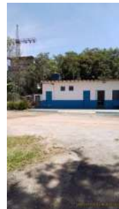
Foto 11 - Instalações da ETE
