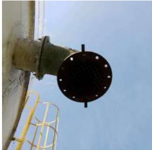
Foto 9 - Tela de proteção na saída do extravasador
