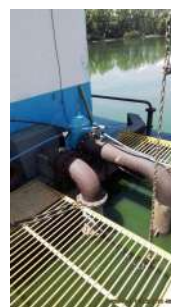
Foto 4 - Sucção do esgoto da lagoa de maturação.
