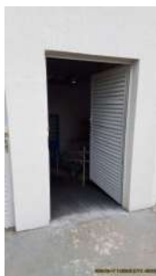
Foto 1 - Entrada da casa de bombas.
