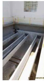
Foto 28 - Filtro em manutenção
