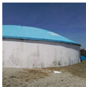
Foto 4 - Vista lateral do reservatório de 2.000 m 3
