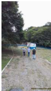
Foto 3 - Visão geral da elevatória de esgoto
