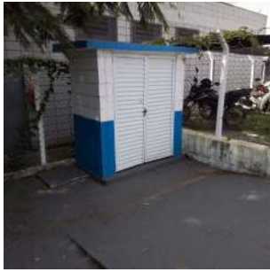
Foto 5 - Vista da casa do painel elétrico
