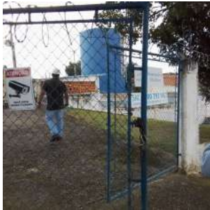
Foto 1 - Vista da entrada do Sistema de Reservação
