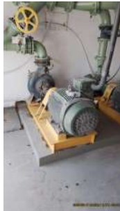
Foto 10 - Manutenção da base das bombas
