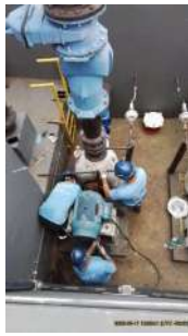
Foto 1 - Manutenção em uma das bombas centrífugas.
