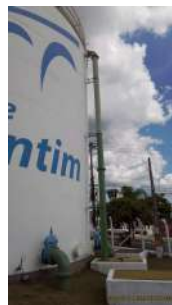
Foto 4 - Alimentação do reservatório
