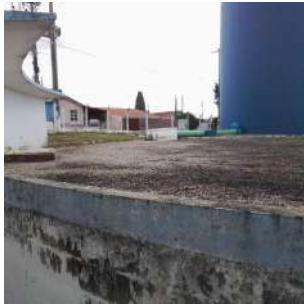
Foto 9 - Vista por cima do reservatório
