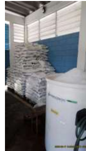
Foto 4 - Armazenamento de cloreto de sódio para geração de hipoclorito.
