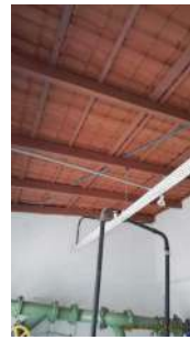
Foto 9 - Recuperação do telhado da casa de bombas.
