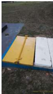
Foto 1 - Poço com gradeamento
