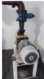
Foto 6 - Bomba centrífuga
