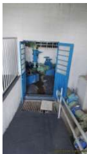
Foto 1 - Acesso casa de bombas.
