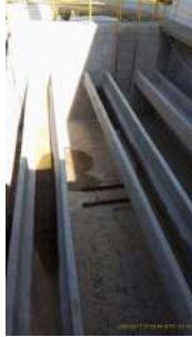
Foto 23 - Filtro em manutenção.
