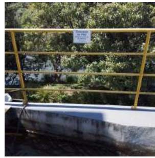
Foto 4 - Dosagem de PAC na entrada de água bruta
