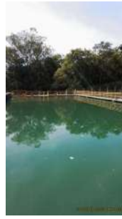
Foto 19 - Decantadores da ETA
