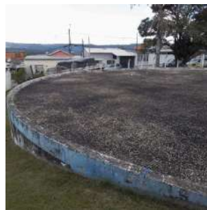
Foto 6 - Vista por cima do reservatório
