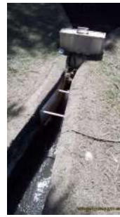
Foto 4 - Calha parshall na entrada.
