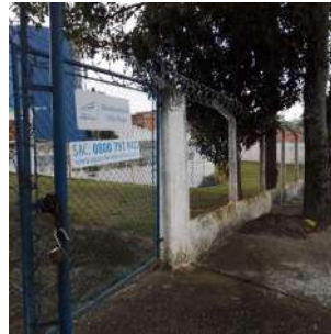
Foto 2 - Vista da entrada do Sistema de Reservação
