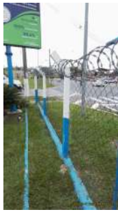
Foto 1 - Cercamento no perímetro.
