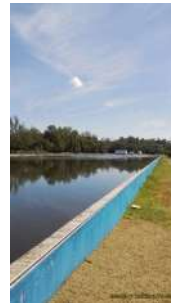
Foto 25 - Lagoa de decantação. Ao fundo, lagoa aerada. Há uma divisão entre as etapas.
