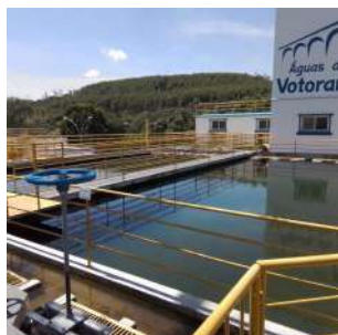
Foto 1 - Vista geral do decantador
