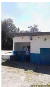
Foto 1 - Captação de água bruta da ETA Central
