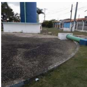
Foto 7 - Vista por cima do reservatório
