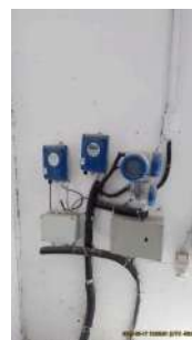
Foto 15 - Medidores de vazão da ETA
