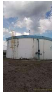
Foto 4 - Reservatório de concreto.
