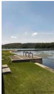
Foto 24 - Entradas na lagoa aerada
