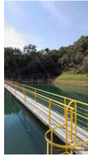
Foto 20 - Pintura dos guarda corpos da ETA
