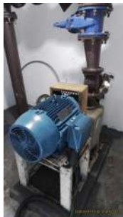
Foto 5 - Bomba centrífuga
