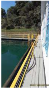
Foto 18 - Manutenção e pintura de guarda corpos dos decantadores
