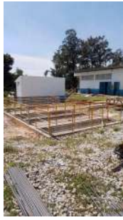
Foto 3 - Obras do tanque de equalização
