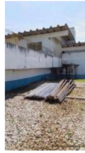
Foto 4 - Neste local será a saída de lodo da ETA para o tanque de equalização.
