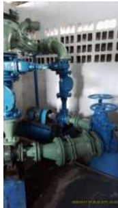
Foto 5 - Recalque para o reservatório elevado.
