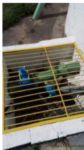
Foto 5 - Saída do reservatório
