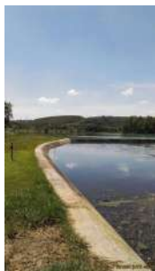
Foto 19 - Lagoa aerada e Lagoa de maturação ao fundo.
