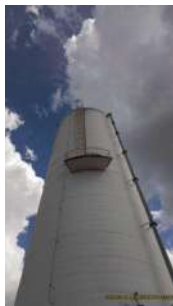
Foto 3 - Escada externa para manutenção
