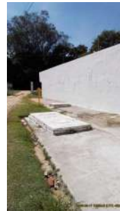
Foto 41 - Pintura externa dos decantadores
