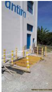
Foto 40 - Retofo da ETA. Pintura em sinalizações
