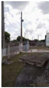
Foto 1 - Cerca e portão de acesso.
