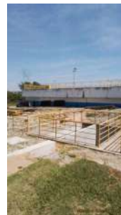
Foto 2 - Obras do tanque de equalização
