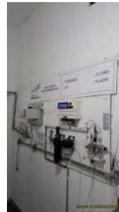
Foto 33 - Analisador de parâmetros do tratamento
