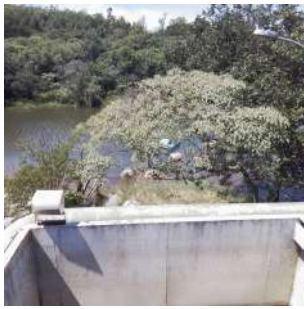
Foto 3 - Vista da captação de água bruta
