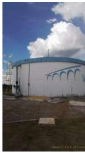
Foto 3 - Reservatório de concreto apoiado.
