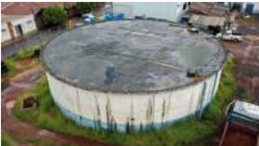
Foto 7 - Vista geral do reservatório.
