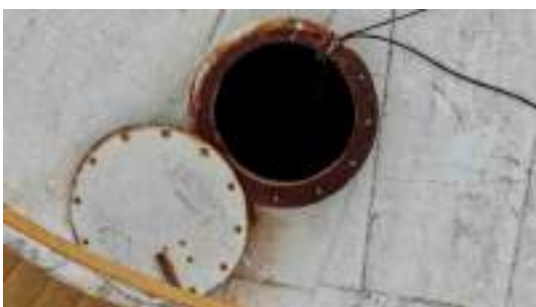
Foto 1 - Detalhe da tampa de inspeção.
