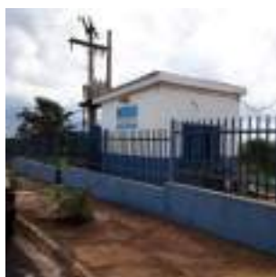
Foto 1 - Vista geral do cercamento e portão de acesso à área.
