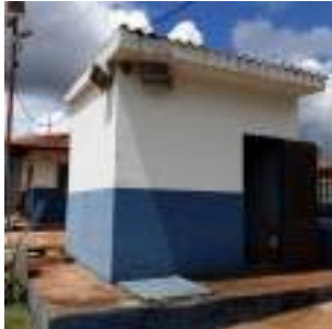
Foto 7 - Edificação que abriga o painel elétrico do poço.
