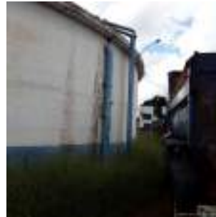
Foto 11 - Adutora da água captada no Poço Arthur Balsi.
