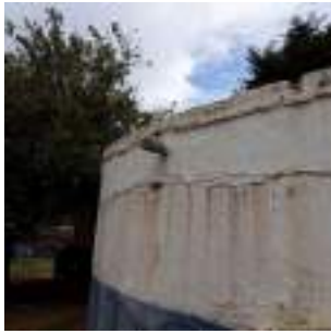
Foto 1 - Detalhe da vedação do tubo extravasor.
