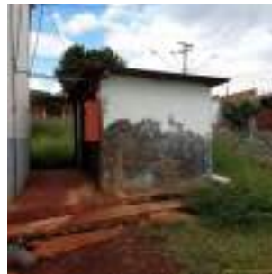
Foto 11 - Vista geral da edificação que abriga os equipamentos de aplicação de cloro e flúor na água bruta. Essa estrutura está localizada na área do Reservatório 750.
