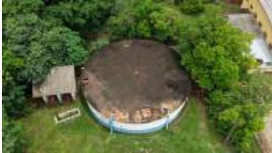
Foto 5 - Vista geral do reservatório.
