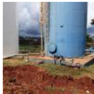
Foto 11 - Reservatório 1 - Vista geral.
