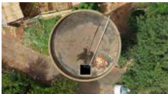
Foto 5 - Vista geral do topo do reservatório.
