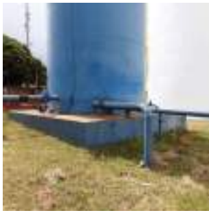
Foto 12 - Reservatório 1 - Vista geral.
