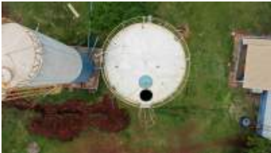
Foto 16 - Reservatório 2 - Detalhe do topo do reservatório.
