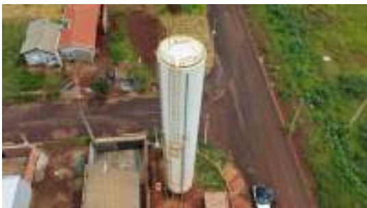
Foto 5 - Vista geral do reservatório. É possível observar a escada de acesso ao topo do
