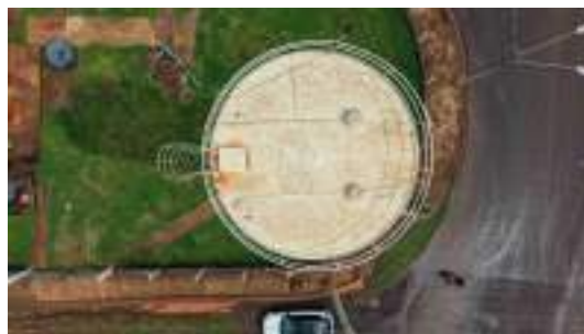
Foto 6 - Vista geral do topo do reservatório.
