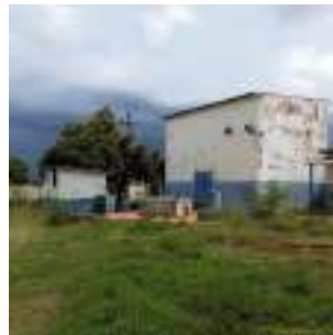
Foto 10 - Vista geral das edificações da área, a maior abriga o transformador e painéis elétricos, e a menor, os tanques de cloro e flúor.
