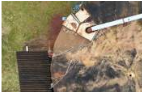
Foto 18 - Ponto de aplicação de cloro e flúor na água bruta, diretamente no Reservatório 750.
