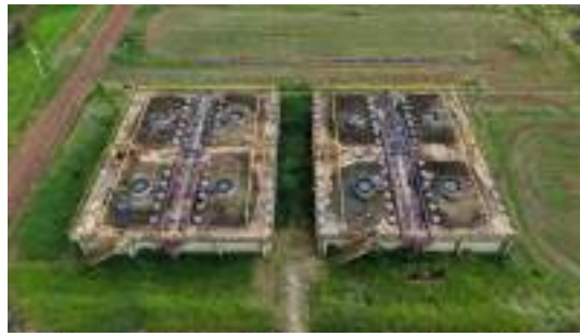
Foto 11 - Vista aérea do Tratamento Secundário, composto por dois módulos, cada um com quatro células.
