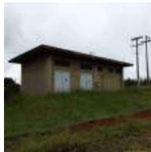
Foto 36 - Abrigo dos transformadores e painéis elétricos.
