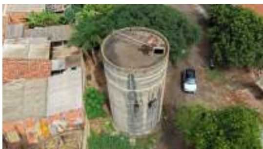
Foto 3 - Vista geral do reservatório.
