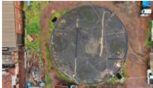
Foto 8 - Vista geral do topo do reservatório.
