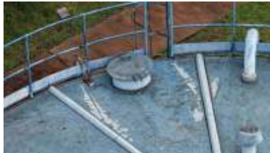
Foto 8 - Detalhe da tampa de inspeção.
