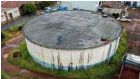
Foto 7 - Vista geral do reservatório.
