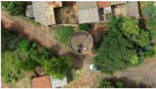
Foto 1 - Ausência de cercamento na área do reservatório.
