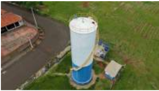
Foto 5 - Escadas de acesso e guarda-corpos do topo do reservatório.
