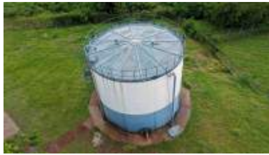
Foto 4 - Vista geral do reservatório.
