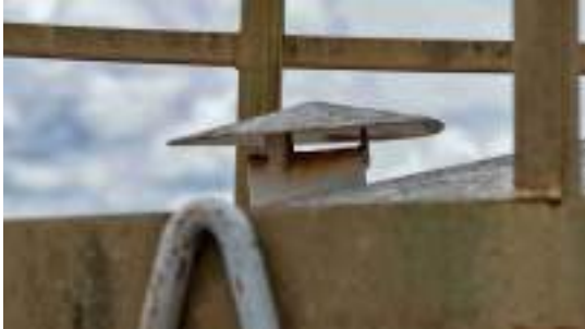
Foto 9 - Detalhe do segundo tubo de ventilação no topo do reservatório.
