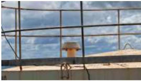
Foto 8 - Detalhe do primeiro tubo de ventilação no topo do reservatório.
