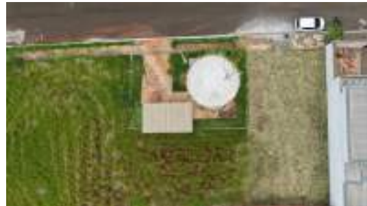
Foto 2 - Vista aérea do local. É possível observar o cercamento no entorno da área e o Poço Flamboyant localizado à esquerda do reservatório.
