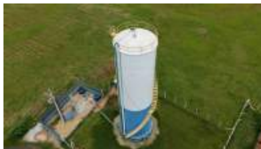
Foto 4 - Vista geral do reservatório.
