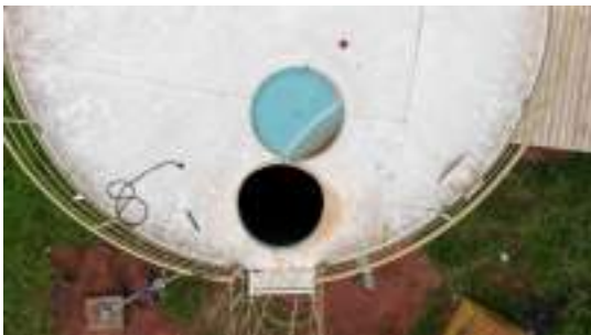
Foto 1 - Detalhe da tampa de inspeção.
