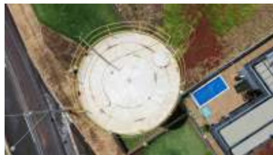
Foto 6 - Vista geral do topo do reservatório.
