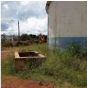
Foto 1 - Vegetação alta no entorno do reservatório.
