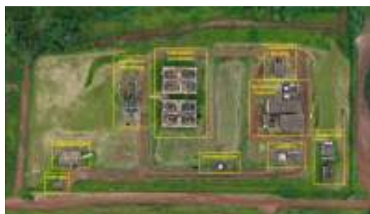
Foto 2 - Vista aérea da ETE com identificação das estruturas e edificações.
