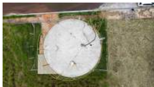
Foto 6 - Vista geral do topo do reservatório.
