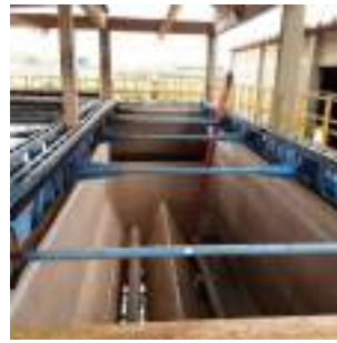
Foto 20 - Flotador 2, em manutenção.
