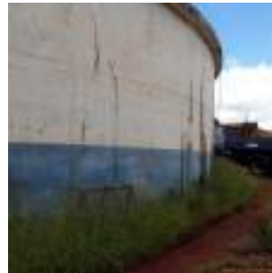
Foto 2 - Vegetação alta no entorno do reservatório.
