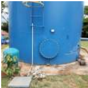
Foto 18 - Reservatório 2 - Vista geral.
