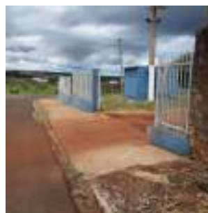
Foto 2 - Vista geral do cercamento e portão de acesso à área.
