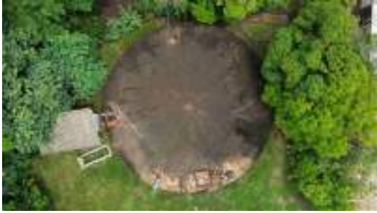
Foto 1 - Ausência de guarda-corpos.
