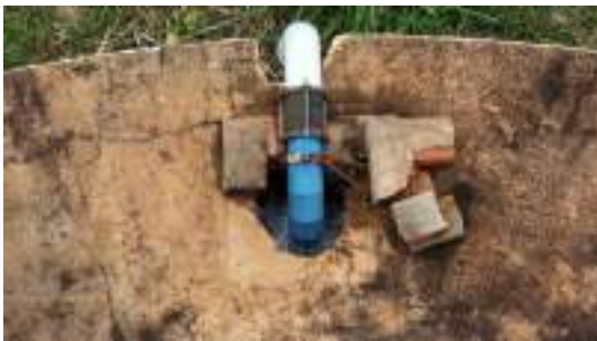
Foto 1 - Abertura para passagem de tubulação no topo do reservatório.
