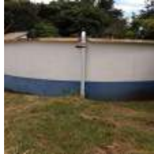
Foto 6 - Adutora do Poço Habitacional.
