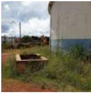
Foto 1 - Vegetação alta no entorno do reservatório.
