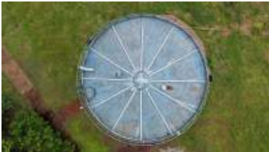
Foto 7 - Vista geral do topo do reservatório.
