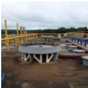
Foto 12 - Detalhe de um distribuidor de fluxo, há oito no total, um para cada célula.
