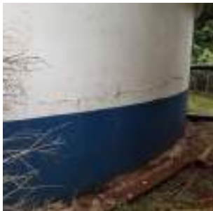
Foto 9 - Vista geral do reservatório.
