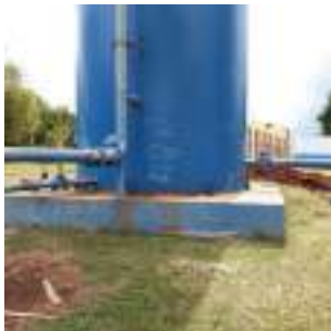
Foto 20 - Reservatório 2 - Vista geral.
