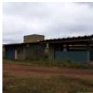
Foto 37 - Depósito e banheiros.
