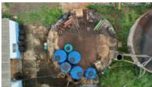
Foto 5 - Reservatório 2 - Vista geral do topo do reservatório.
