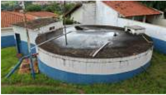
Foto 5 - Vista geral do reservatório.
