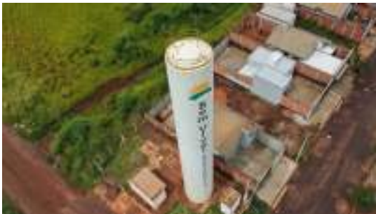
Foto 3 - Vista geral do reservatório.
