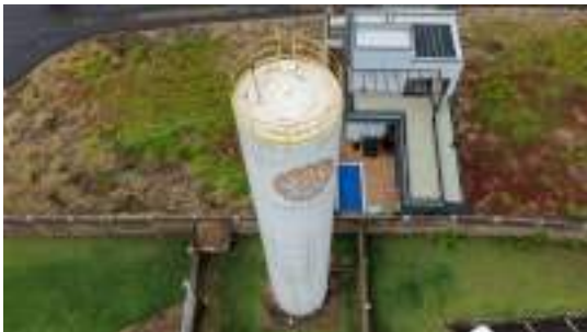
Foto 3 - Vista geral do reservatório.
