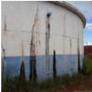
Foto 1 - Detalhe da vedação do tubo extravasor.
