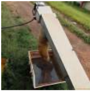
Foto 10 - Detalhe de uma das caçambas de descarte do material retirado dos desarenadores.
