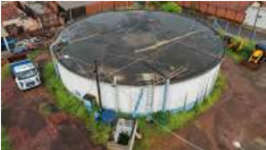
Foto 5 - Vista geral do reservatório.
