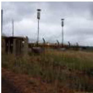
Foto 6 - Queimadores de gás do tratamento secundário não estão funcionando.
