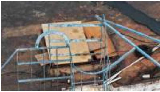
Foto 1 - Detalhe da abertura de inspeção coberta por placas de madeira.
