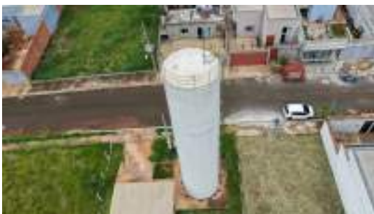
Foto 3 - Vista geral do reservatório.
