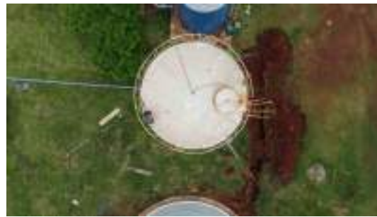
Foto 8 - Reservatório 1 - Detalhe do topo do reservatório.
