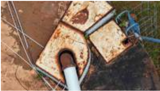
Foto 1 - Abertura em uma das tampas metálicas para passagem da adutora do Poço 2004.
