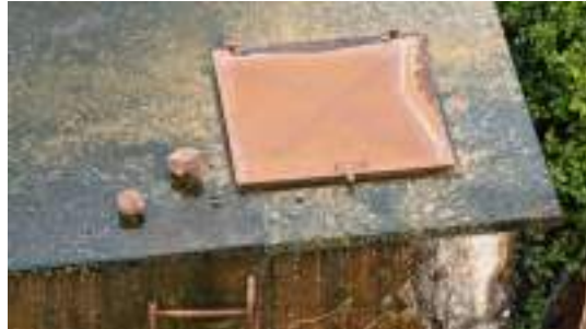
Foto 6 - Detalhe da tampa de inspeção do reservatório.
