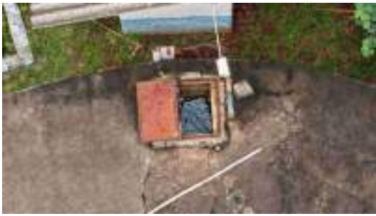
Foto 1 - Detalhe da tampa de inspeção aberta.
