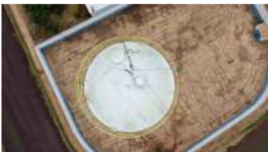
Foto 7 - Vista geral do topo do reservatório.
