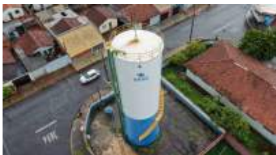
Foto 3 - Vista geral do reservatório.
