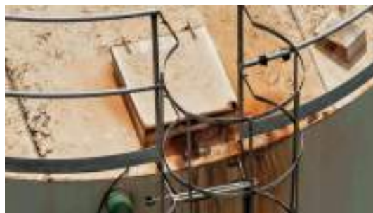
Foto 7 - Detalhe da tampa de inspeção.
