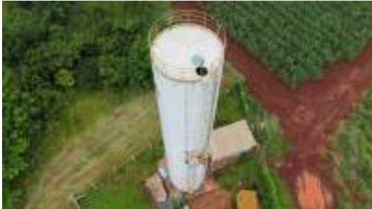
Foto 5 - Escadas de acesso e guarda-corpos do topo do reservatório.
