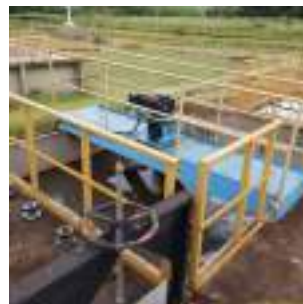
Foto 9 - Detalhe do desarenador 2.
