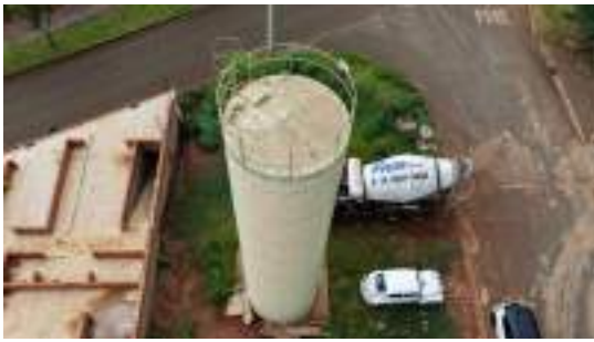
Foto 3 - Vista geral do reservatório.
