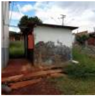
Foto 14 - Vista geral da edificação que abriga os equipamentos de aplicação de cloro e flúor na água bruta captada no Poço 2004.
