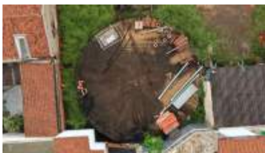
Foto 4 - Reservatório 1 - Vista geral do topo do reservatório.
