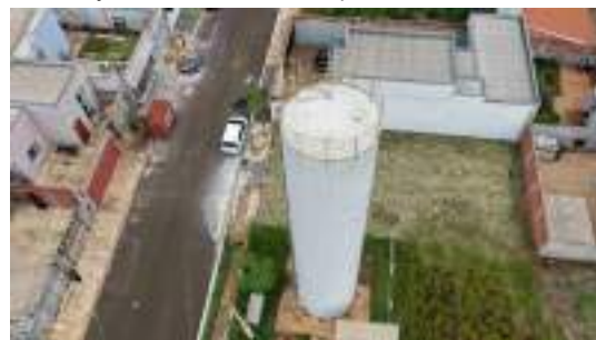
Foto 4 - Vista geral do reservatório.
