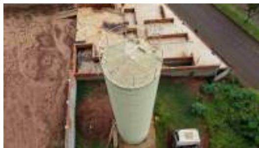
Foto 2 - Vista geral do reservatório.
