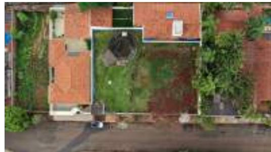
Foto 2 - Vista aérea do local. É possível observar o cercamento da área.
