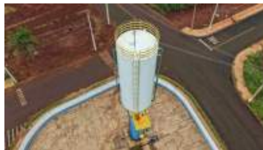
Foto 6 - Escadas de acesso e guarda-corpos do topo do reservatório.
