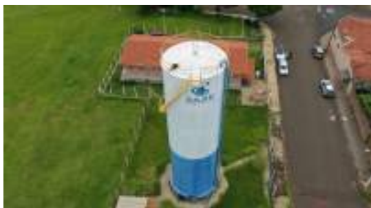
Foto 3 - Vista geral do reservatório.
