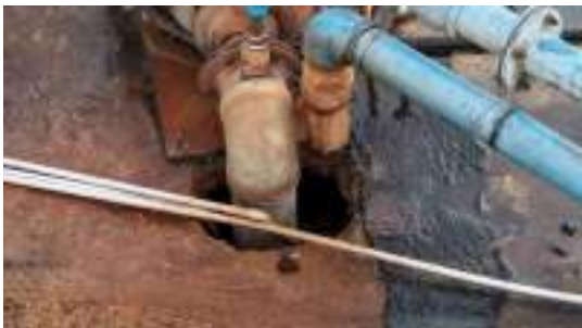
Foto 5 - Abertura para passagem de tubulação no topo do reservatório.
