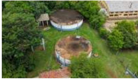
Foto 4 - Vista geral do reservatório.
