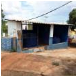
Foto 11 - Abrigo dos tanques de cloro e flúor.
