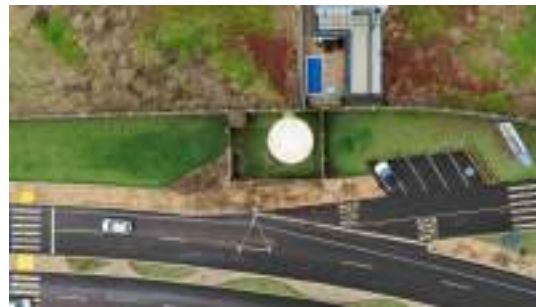
Foto 2 - Vista aérea do local. É possível observar o cercamento da área.
