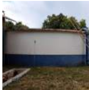
Foto 8 - Vista geral do reservatório.
