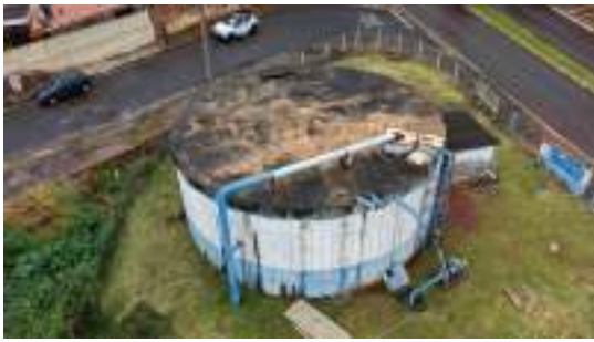
Foto 5 - Vista geral do reservatório.
