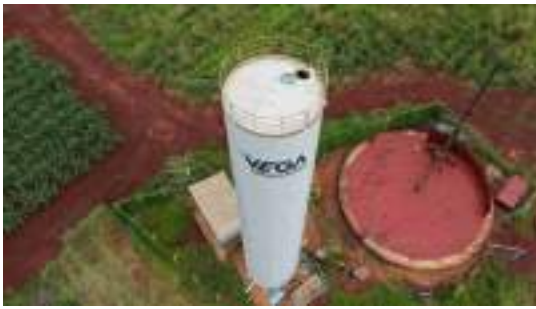
Foto 3 - Vista geral do reservatório.
