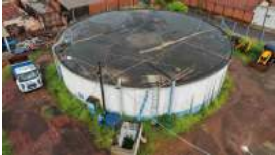
Foto 5 - Vista geral do reservatório.
