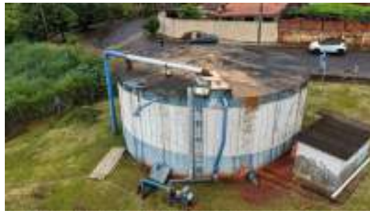
Foto 6 - Vista geral do reservatório.
