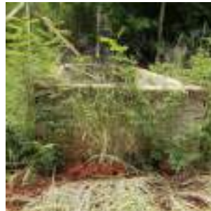
Foto 8 - Caixa de passagem da tubulação de água bruta, localizada ao lado do poço.
