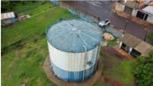
Foto 5 - Vista geral do reservatório.
