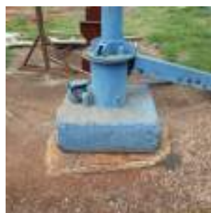
Foto 4 - Detalhe da laje de proteção.
