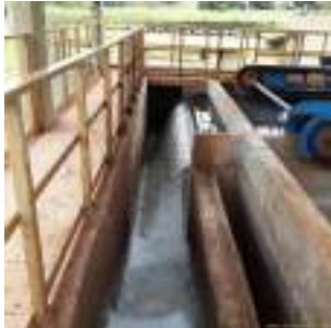
Foto 21 - Saída da água clarificada do flotador 1.
