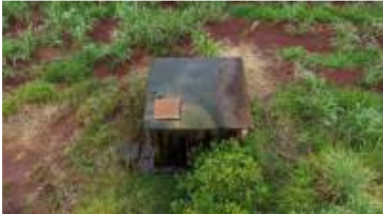
Foto 5 - Vista geral do reservatório.
