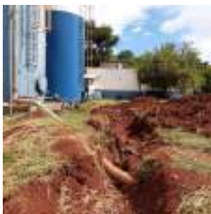
Foto 1 - Detalhe da vala aberta em frente aos reservatórios;
