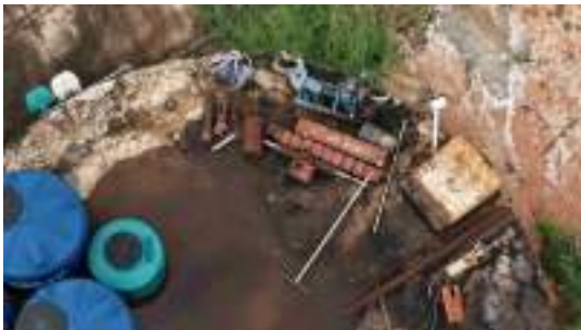
Foto 3 - Reservatório 2 - Detalhe do material depositado sobre o reservatório.
