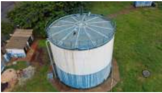
Foto 3 - Vista geral do reservatório.
