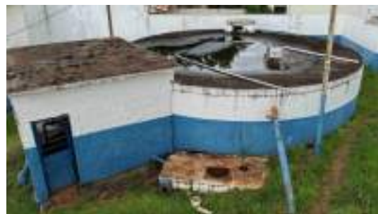
Foto 4 - Vista geral do reservatório.
