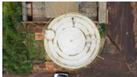
Foto 6 - Detalhe do topo do reservatório e tampa de inspeção.
