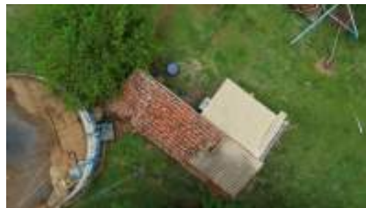
Foto 12 - Vista aérea da edificação que abriga os equipamentos para cloração e fluoretação da água bruta.
