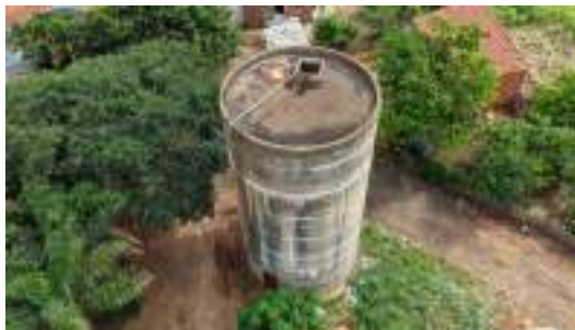
Foto 2 - Vista geral do reservatório.
