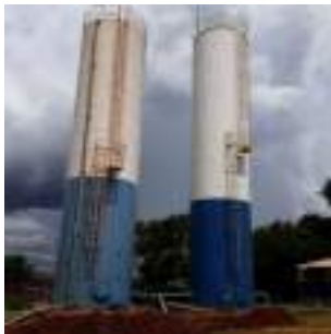
Foto 5 - Vista geral dos reservatórios.
