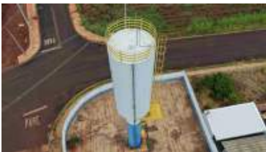
Foto 5 - Vista geral do reservatório.
