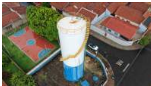
Foto 4 - Escadas de acesso e guarda-corpos do topo do reservatório.
