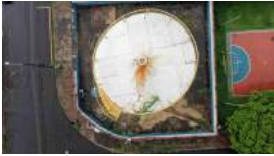
Foto 5 - Vista geral do topo do reservatório.
