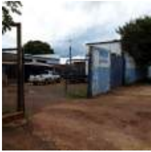
Foto 3 - Vista geral do cercamento e portão de acesso ao reservatório.
