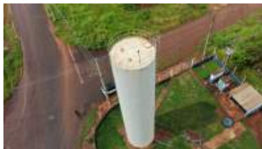
Foto 4 - Vista geral do reservatório.
