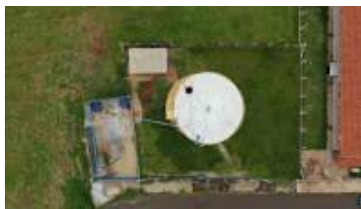
Foto 2 - Vista aérea do local. É possível observar o cercamento no entorno da área e o Poço Nova Barra, localizado à esquerda do reservatório.
