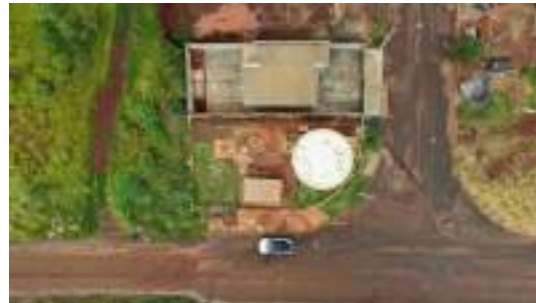
Foto 2 - Vista aérea do local. É possível observar o cercamento no entorno da área e o Poço Bem Viver, localizado à esquerda do reservatório.
