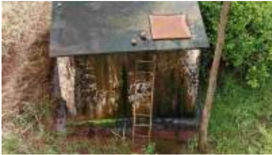
Foto 1 - Detalhe da escada para acesso à tampa de inspeção.
