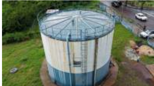
Foto 6 - Escadas de acesso e guarda-corpos do topo do reservatório.
