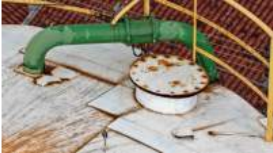
Foto 7 - Detalhe da tampa de inspeção.
