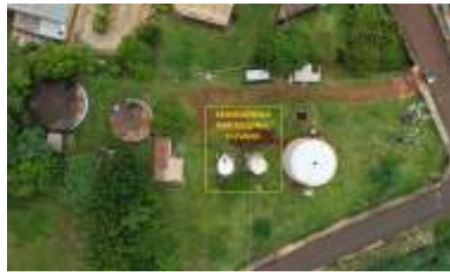
Foto 4 - Vista aérea dos subsistemas existentes no local e localização do Reservatório Habitacional Elevado.
