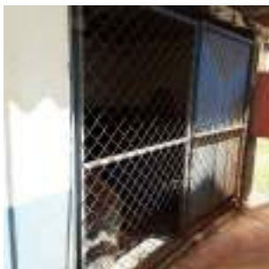
Foto 12 - Portão da edificação.
