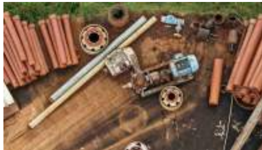
Foto 2 - Reservatório 1 - Detalhe do material depositado sobre o reservatório.
