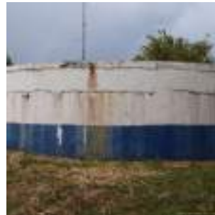
Foto 7 - Vista geral do reservatório.
