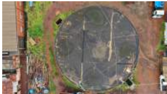
Foto 8 - Vista geral do topo do reservatório.
