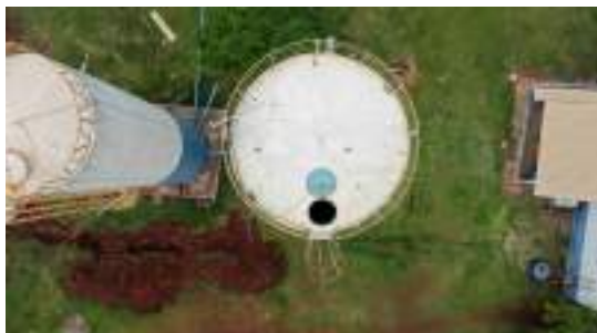
Foto 1 - Detalhe da tampa de inspeção aberta no topo do segundo reservatório.
