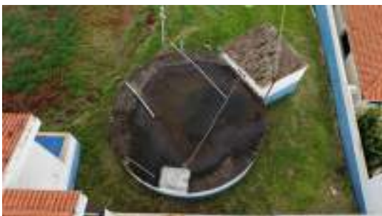
Foto 3 - Vista geral do topo do reservatório.
