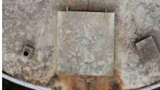
Foto 6 - Detalhe da tampa de inspeção.
