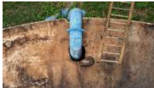
Foto 2 - Abertura para passagem de tubulação no topo do reservatório.
