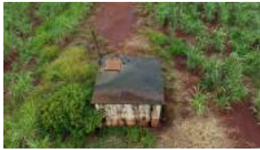
Foto 4 - Vista geral do reservatório.
