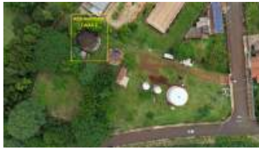
Foto 4 - Vista aérea dos subsistemas existentes no local e localização do Reservatório Caixa 2.
