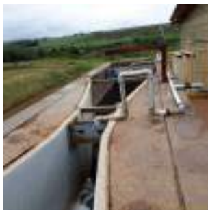
Foto 16 - Calha Parshal onde é aplicado o PAC no efluente que vai para os floculadores.
