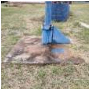
Foto 7 - Detalhe da laje de proteção.
