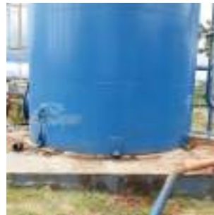
Foto 19 - Reservatório 2 - Vista geral.
