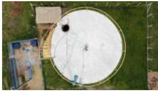
Foto 6 - Vista geral do topo do reservatório.
