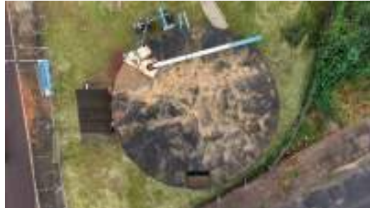
Foto 8 - Vista geral do topo do reservatório.
