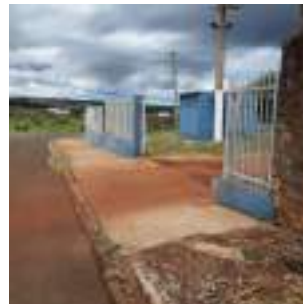
Foto 2 - Vista geral do cercamento e portão de acesso à área.
