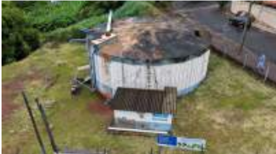
Foto 7 - Vista geral do reservatório.
