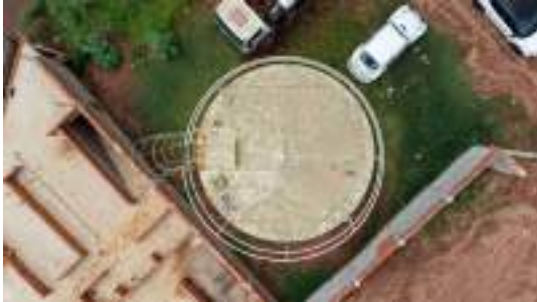
Foto 5 - Vista geral do topo do reservatório.
