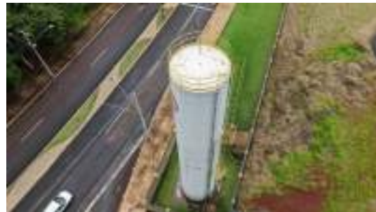
Foto 4 - Vista geral do reservatório.
