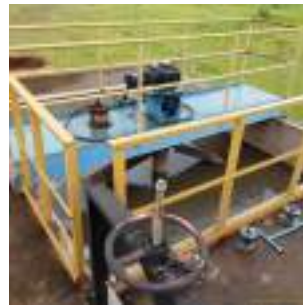
Foto 8 - Detalhe do desarenador 1.
