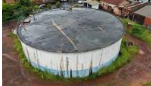
Foto 6 - Vista geral do reservatório.
