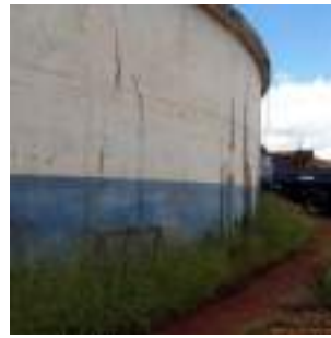
Foto 2 - Vegetação alta no entorno do reservatório.
