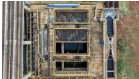
Foto 15 - À direita, canaleta de chegada do efluente tratado nos reatores UABS, à esquerda, os dois floculadores.
