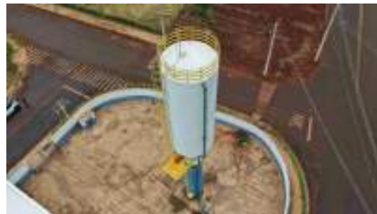
Foto 4 - Vista geral do reservatório.
