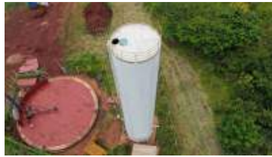
Foto 4 - Vista geral do reservatório.
