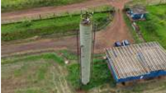
Foto 40 - Reservatório de água de reuso ao lado do prédio da administração. O reservatório não está em operação.
