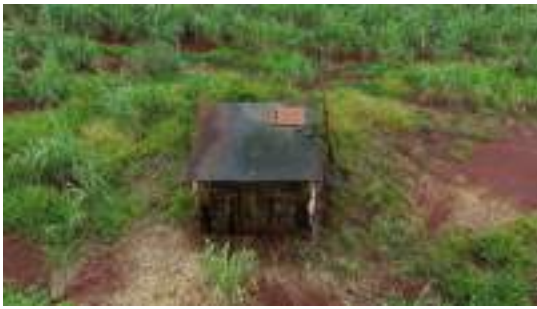
Foto 3 - Vista geral do reservatório.
