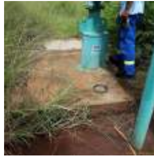
Foto 4 - Detalhe da laje de proteção.
