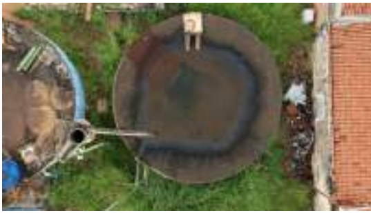
Foto 5 - Reservatório 3 - Material depositado sobre e ao lado do reservatório.
