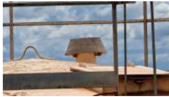
Foto 9 - Detalhe do segundo tubo de ventilação no topo do reservatório.
