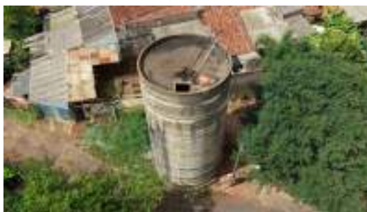
Foto 4 - Vista geral do reservatório.
