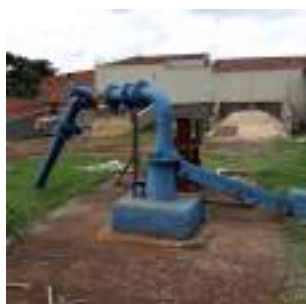
Foto 3 - Vista geral da estrutura do poço.
