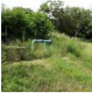
Foto 3 - Vista geral da estrutura do poço.
