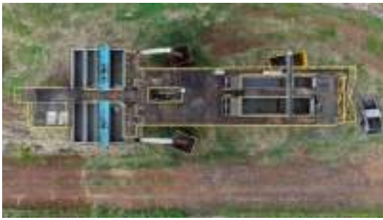
Foto 3 - Vista aérea do tratamento preliminar, composto por gradeamento mecanizado e desarenadores.
