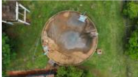
Foto 5 - Vista geral do topo do reservatório.
