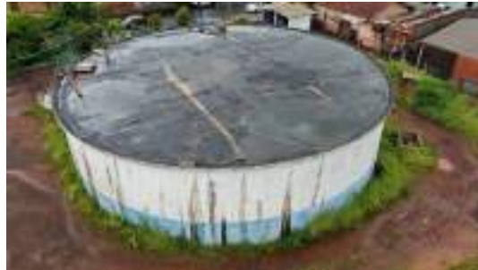
Foto 6 - Vista geral do reservatório.
