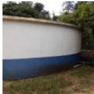
Foto 10 - Vista geral do reservatório.
