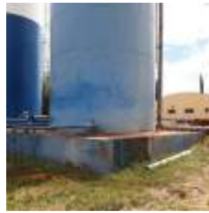
Foto 13 - Reservatório 1 - Vista geral.
