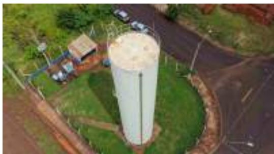
Foto 3 - Vista geral do reservatório.
