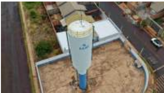
Foto 3 - Vista geral do reservatório.
