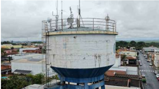
Foto 5 - Vista geral do reservatório.
