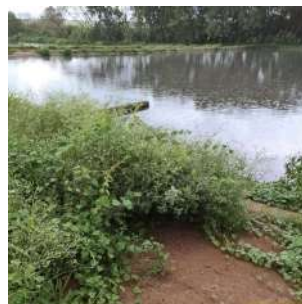
Foto 8 - Ponto de entrada do esgoto na segunda lagoa anaeróbica.
