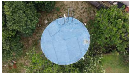
Foto 4 - Vista superior do reservatório.
