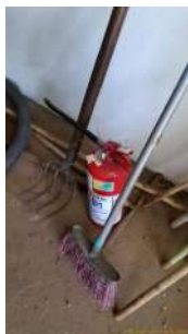
Foto 4 - Extintor de incêndio.
