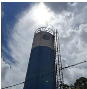
Foto 4 - Vista do topo do reservatório.
