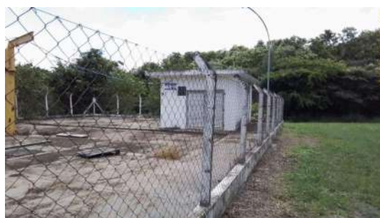
Foto 7 - Fachada lateral da EEE.
