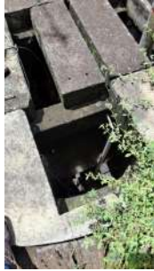
Foto 3 - Passagem de esgoto para recalque.
