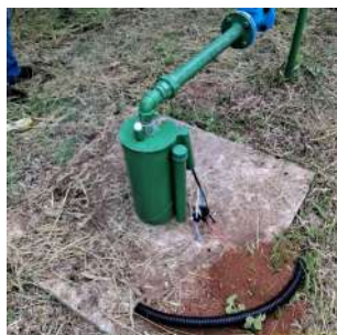
Foto 3 - Laje de proteção e medidor de nível.
