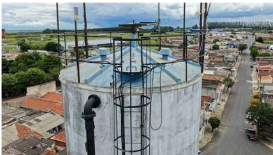
Foto 7 - Vista do topo do reservatório.
