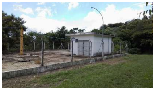
Foto 6 - Fachada lateral da EEE.
