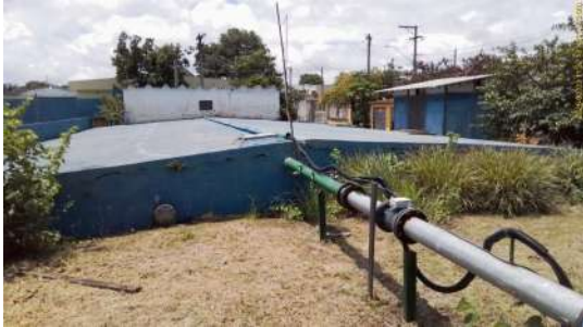
Foto 1 - Vista interna da área do reservatório
