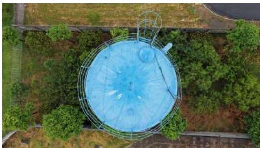
Foto 5 - Vista superior do topo do reservatório.
