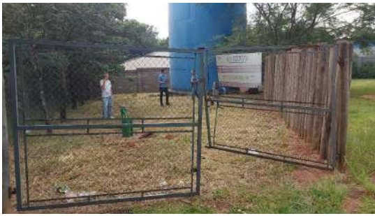
Foto 3 - Fachada da Entrada do Reservatório.
