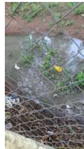
Foto 2 - Acúmulo de esgoto no entorno da estação elevatória.
