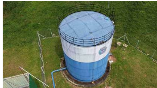
Foto 6 - Vista geral do reservatório.
