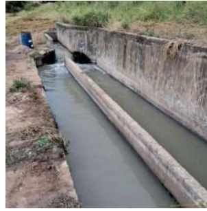
Foto 2 - Passagem do esgoto bruto.
