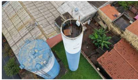
Foto 6 - Vista superior dos dois reservatórios.
