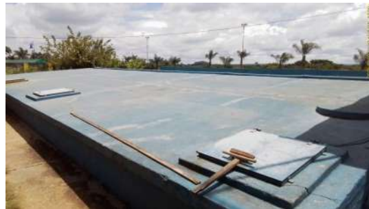
Foto 4 - Vista de cima do reservatório.
