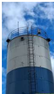
Foto 3 - Topo do reservatório ativo.
