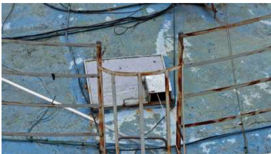
Foto 7 - Tampa de inspeção.
