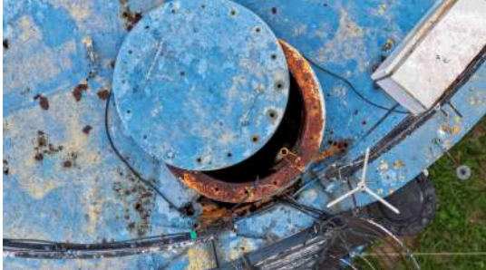
Foto 9 - Tampa de inspeção.
