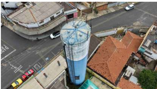
Foto 5 - Vista lateral do reservatório.
