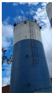
Foto 1 - Vista geral do reservatório ativo.
