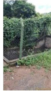
Foto 6 - Área reservada para entrada de esgoto bruto e gradeamento.
