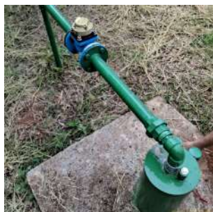
Foto 1 - Vista geral do poço.
