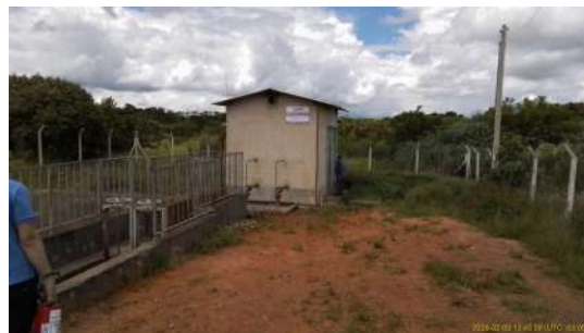
Foto 2 - Foto externa da casa de bombas.
