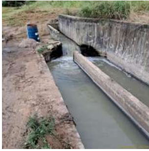
Foto 1 - Ponto de entrada do esgoto bruto.
