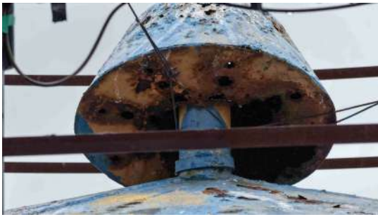
Foto 1 - Tampa de proteção do tubo de respiro.
