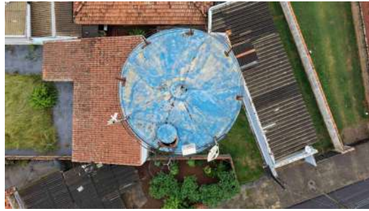
Foto 8 - Vista superior do topo do reservatório.
