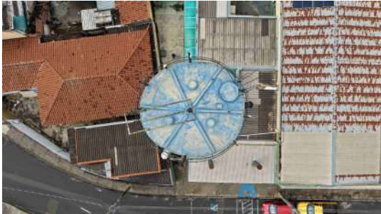
Foto 3 - Vista superior do topo do reservatório.
