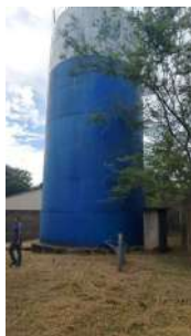
Foto 1 - Vista lateral do Reservatório.
