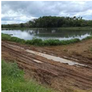
Foto 5 - Vista da segunda lagoa anaeróbica.
