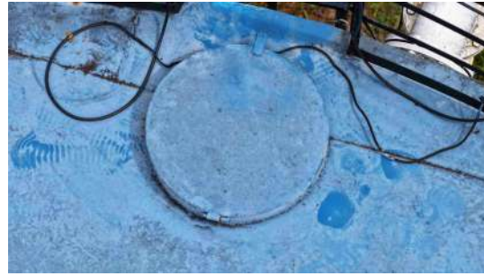
Foto 2 - Tampa de inspeção.
