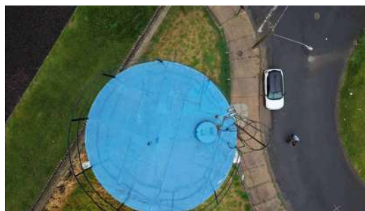
Foto 2 - Vista superior do reservatório.
