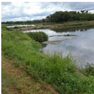
Foto 7 - Delimitação física entre a segunda lagoa anaeróbica e a lagoa facultativa.
