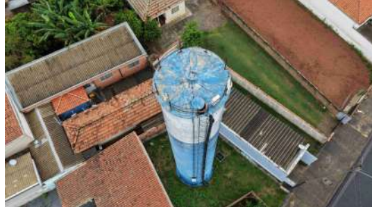
Foto 10 - Vista geral do reservatório.
