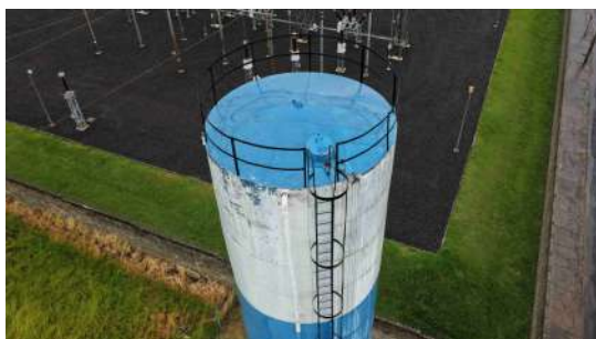
Foto 1 - Vista do topo do reservatório.
