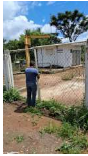
Foto 1 - Portão de acesso para a elevatória de esgoto bruto.
