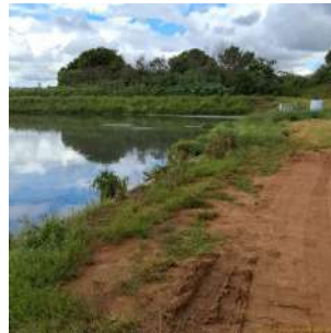
Foto 6 - Ponto de entrada do esgoto na primeira lagoa anaeróbica.
