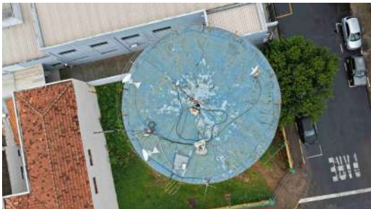
Foto 1 - Vista superior do reservatório.
