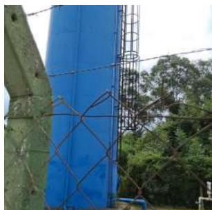
Foto 3 - Escada de acesso ao topo do reservatório.
