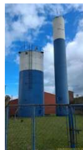
Foto 2 - Vista dos dois reservatórios.
