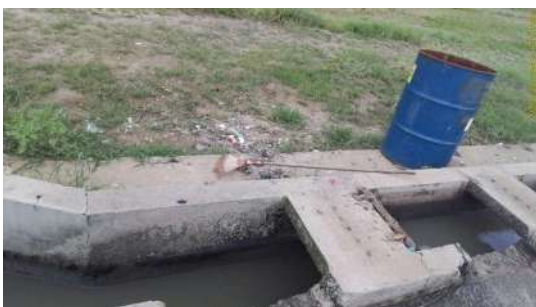
Foto 1 - Resíduo proveniente do gradeamento disposto diretamente sobre o solo.
