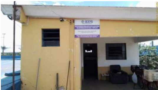
Foto 3 - Fachada de entrada.
