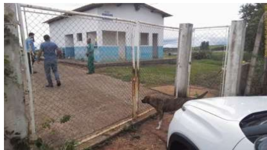
Foto 2 - Portão de acesso à Estação de Tratamento de Esgoto (ETE) e placa de identificação.
