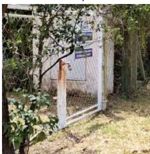
Foto 5 - Portão de acesso para o reservatório e placa de identificação.
