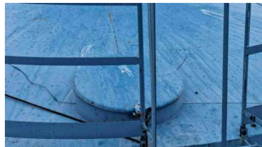
Foto 8 - Tampa de inspeção.
