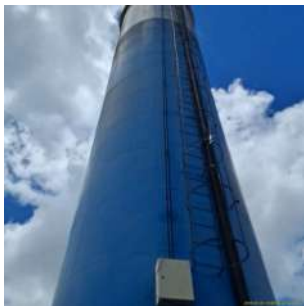
Foto 3 - Vista geral do reservatório.
