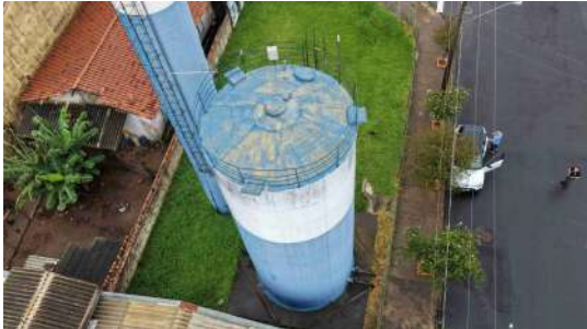
Foto 7 - Vista superior do reservatório ativo.
