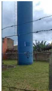
Foto 1 - Local reservado para instalação da placa de identificação.
