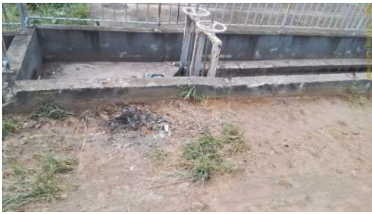
Foto 1 - Resíduo do gradeamento descartado diretamente no solo.
