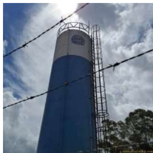
Foto 1 - Vista geral do reservatório.
