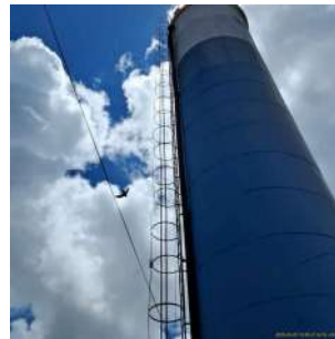
Foto 2 - Escada de acesso ao topo do reservatório.
