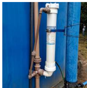
Foto 4 - Ponto de cloração e fluoretação.
