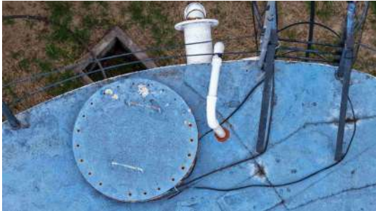
Foto 5 - Tampa de inspeção.
