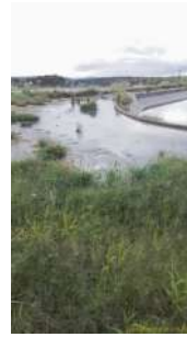
Foto 2 - Presença de esgoto acumulado na área adjacente às lagoas em razão de extravasamento.
