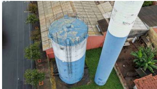
Foto 10 - Vista da escada de acesso ao topo.
