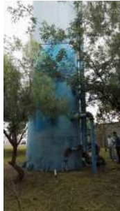
Foto 1 - Vista lateral do reservatório.
