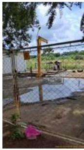
Foto 1 - Portão de acesso para a estação elevatória.
