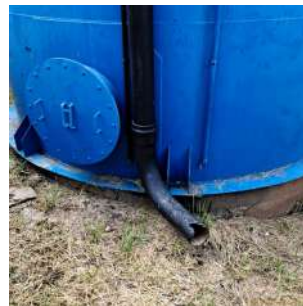
Foto 4 - Abertura de saída do tubo extravasor do reservatório.
