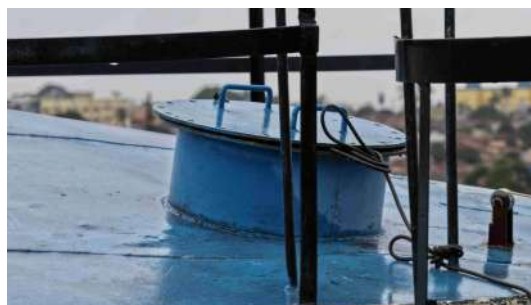
Foto 4 - Tampa de inspeção.
