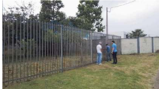
Foto 2 - Fachada da entrada da área do reservatório.
