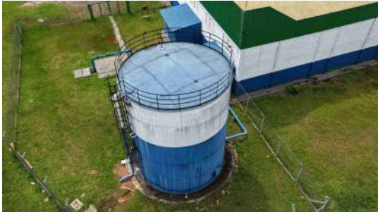
Foto 3 - Vista geral do reservatório.
