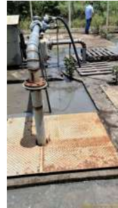
Foto 3 - Vista geral da área do poço de sucção.
