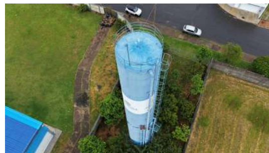
Foto 6 - Vista lateral do reservatório.
