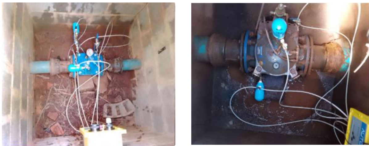
Figura TEC 6 – Automação de VRP e monitoramento da pressão (Fonte: SAEP)
