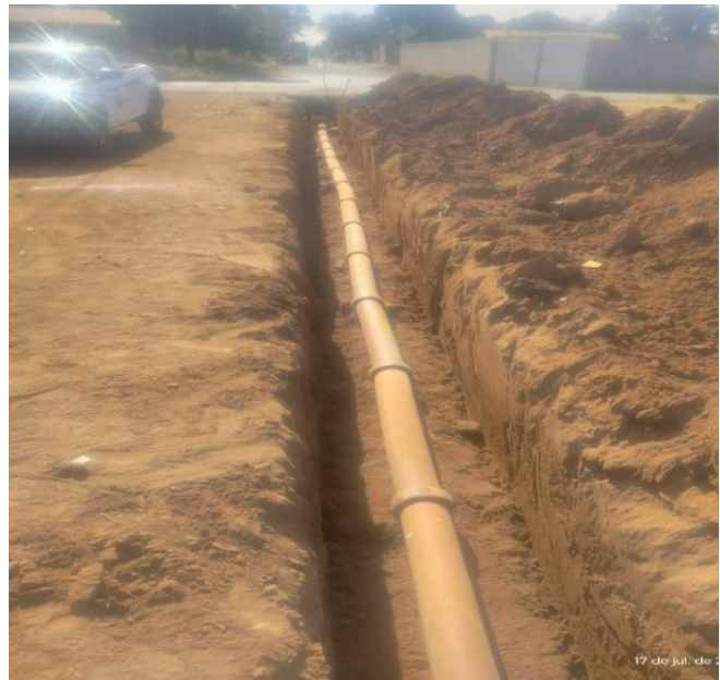
Figura TEC 9 – Implantação de rede de água e esgoto na Rua São Cristóvão (Fonte: SAEP)
