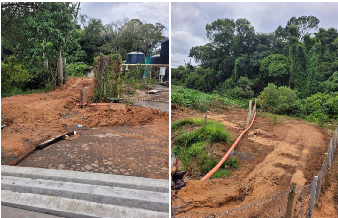
Figura TEC 5 – Execução de nova rede de esgoto para interligação do efluente anteriormente direcionado à EEE do Bairro Chico Xavier à EEE Cassucci.
