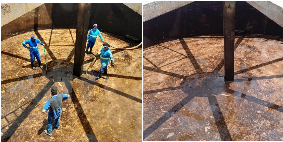
Figura TEC 7 – Limpeza após a demolição da laje do Reservatório da Vila Formosa.
