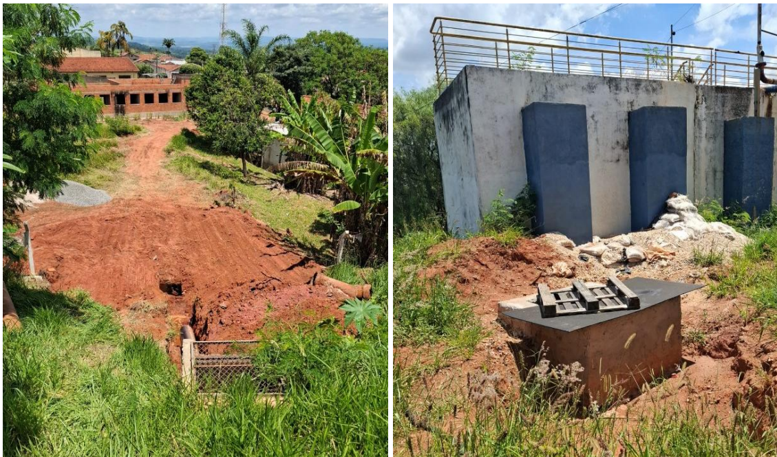
Figura TEC 3 – Sistema de filtragem de lodo sendo executado na ETA Cassucci.
