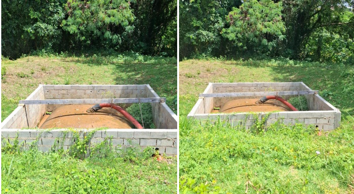
Figura TEC 3 – Sistema de filtragem de lodo sendo executado na ETA Cassucci.
