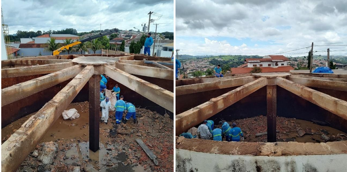
Figura TEC 7 – Limpeza após a demolição da laje do Reservatório da Vila Formosa.
