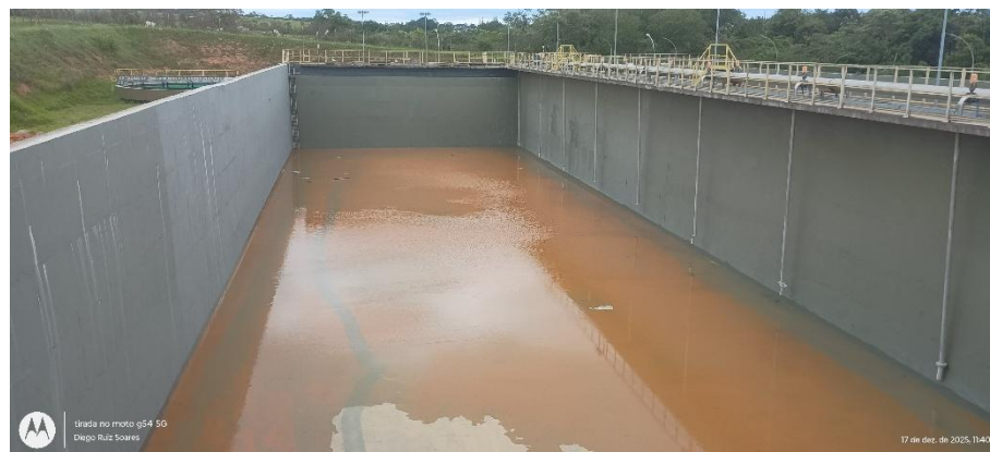
Foto 3 – Vista interna do tanque 1 de aeração.
