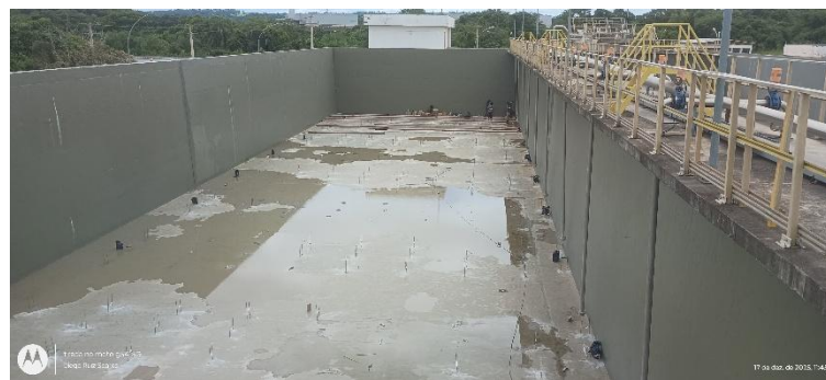
Foto 5 – Vista interna do tanque 2 de aeração.
