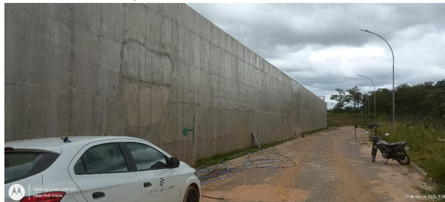
Foto 2 – Vista lateral externa do tanque 2 de aeração.
