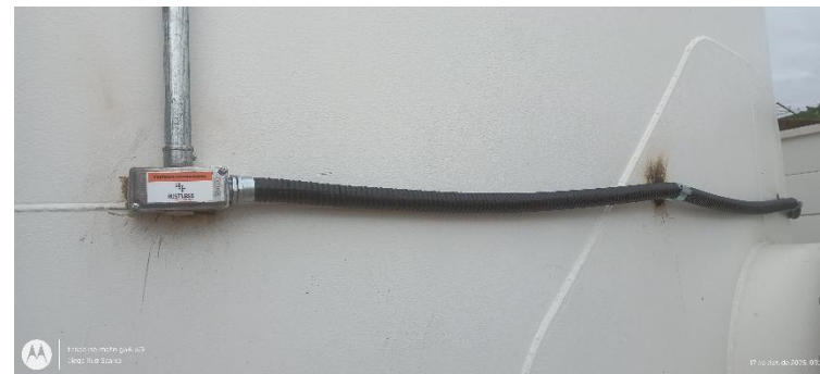
Foto 2 – Proteção anticorrosiva instalada no novo reservatório do bairro Progresso.
