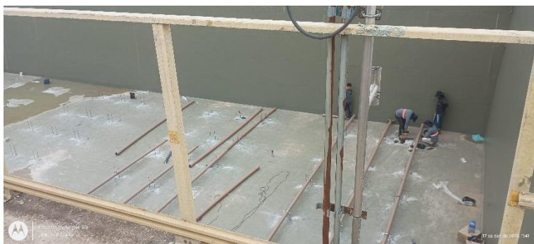
Foto 4 – Vista interna do tanque 2 de aeração.
