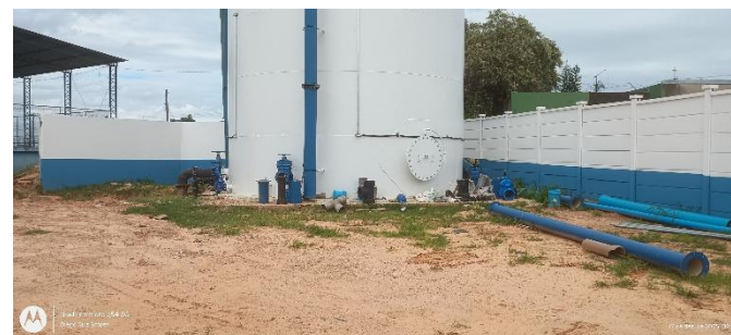
Foto 4 – Vista geral da área do novo reservatório.
