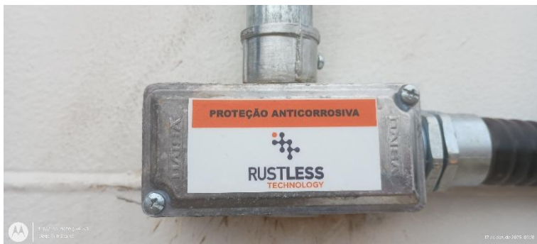
Foto 1 – Proteção anticorrosiva instalada no novo reservatório do bairro Progresso.
