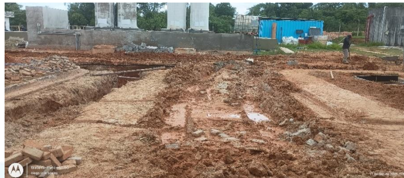
Foto 9 – Obras do sistema de chicanas para desinfecção do efluente tratado.
