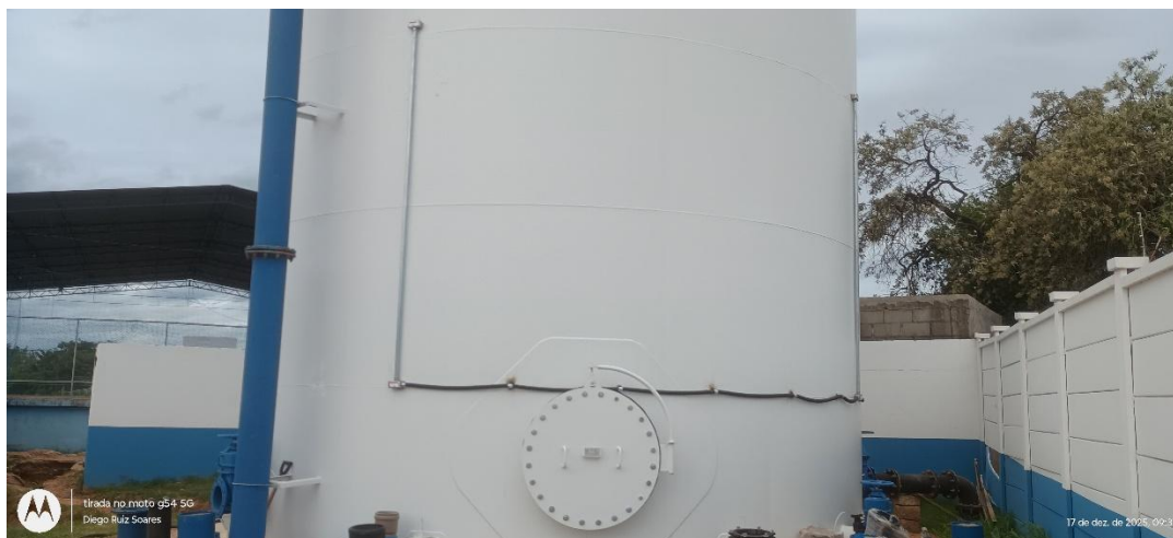
Foto 3 – Proteção anticorrosiva instalada no novo reservatório do bairro Progresso.
