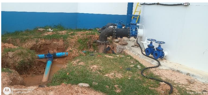
Foto 3 – Interligação do novo reservatório do bairro progresso.
