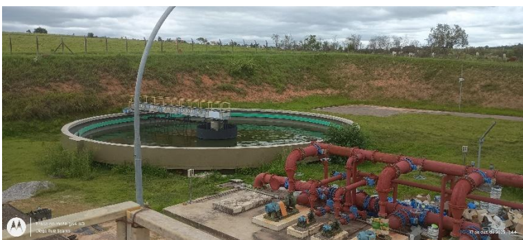
Foto 8 – Vista do outro decantador.
