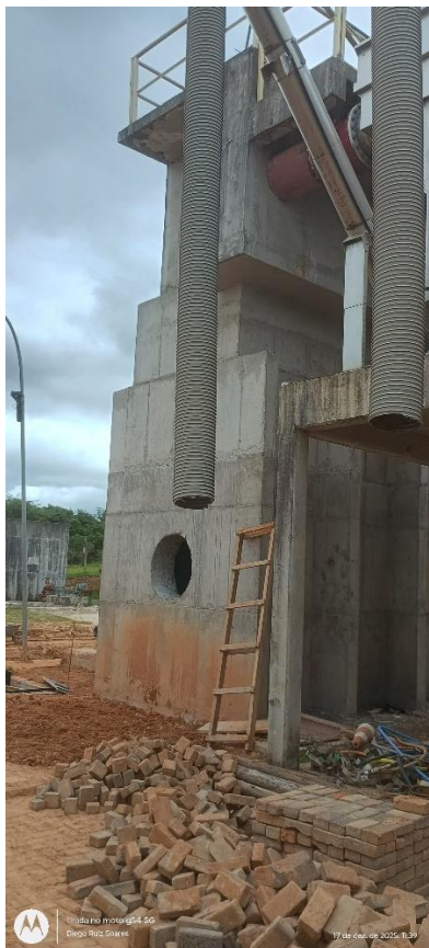
Foto 1 – Caixa de entrada de esgoto.
