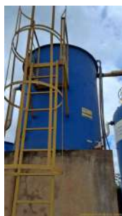
Foto 7 - Destaque para escada e guarda-corpo nos flocladores
