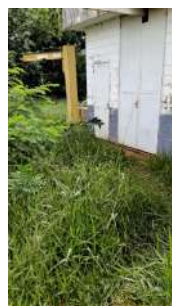
Foto 2 - Necessária a realização de roçagem no terreno
