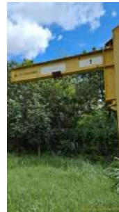
Foto 2 - Sistema de içamento para manutenção
