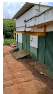
Foto 2 - Prédio onde está localizada a elevatória
