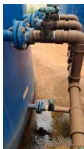
Foto 1 - Vazamento aparente em um dos tanques Foto 2 - Vazamento aparente em um dos tanques
