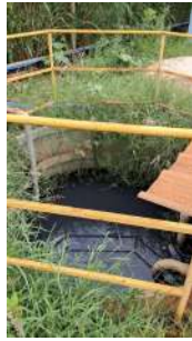
Foto 1 - Tanque de efluente tratado
