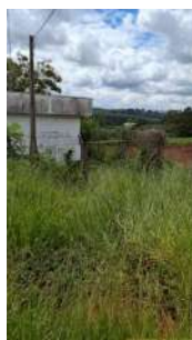
Foto 1 - Necessária a realização de roçagem no terreno
