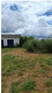
Foto 1 - Prédio da elevatória de esgoto
