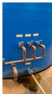
Foto 1 - Vazamento aparente em um dos tanques Foto 2 - Vazamento aparente em um dos tanques
