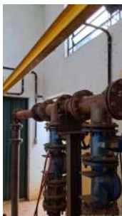
Foto 7 - Içamento para manutenção
