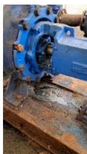
Foto 1 - Drenagem inadequada causando empoçamento de água
