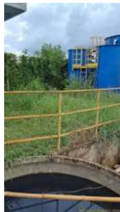
Foto 1 - Tanque cheio pois a bomba não entrou em funcionamento
