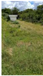
Foto 1 - Dificuldade para acessar à elevatória devido ao mato
