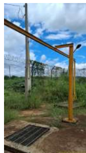
Foto 8 - Içamento para manutenção
