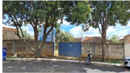
Foto 8 - Vista externa da unidade, a partir do passeio público, evidenciando cercamento da área.
