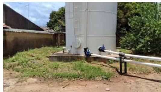
Foto 12 - Vista geral da base do reservatório 1.
