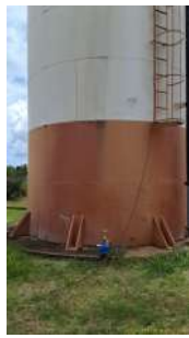
Foto 9 - Vista geral da base do reservatório.
