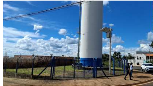
Foto 8 - Vista geral da unidade a partir do passeio público, evidenciando cercamento da área.
