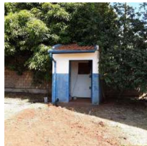
Foto 10 - Edificação dentro da qual está o painel elétrico da captação.
