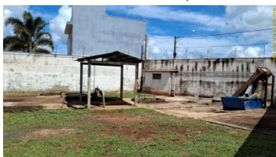
Foto 7 - Vista da área interna da unidade.
