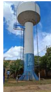
Foto 2 - Vista geral do reservatório.
