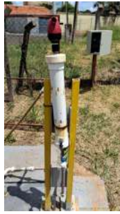
Foto 1 - Dispositivo para cloração e fluoretação da água com o uso de reagentes sólidos.
