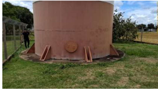
Foto 12 - Vista geral da base do reservatório.
