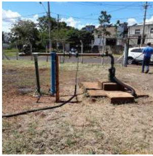
Foto 1 - Vista geral da captação.
