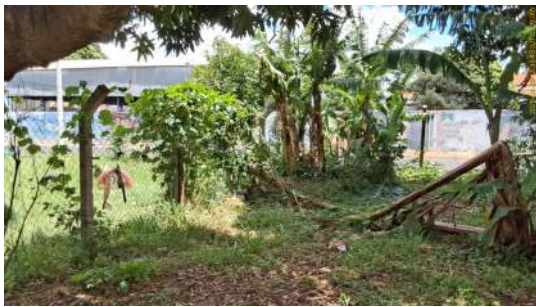
Foto 1 - Vegetação crescendo sobre o cercamento.
