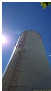
Foto 3 - Escada e guarda corpo instalados na estrutura.
