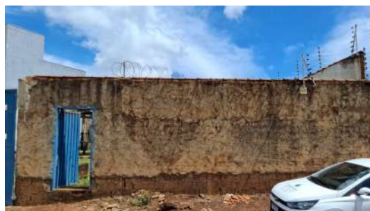
Foto 6 - Vista externa da unidade, evidenciando cercamento com muro e portões.
