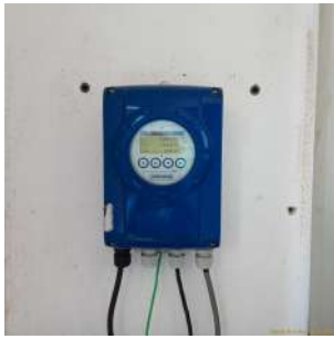
Foto 11 - Painel com medição de vazão da captação.
