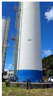
Foto 1 - Vista geral do reservatório.
