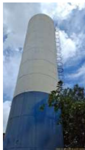
Foto 1 - Vista geral do reservatório, evidenciando escada e guarda corpo afixado na estrutura.
