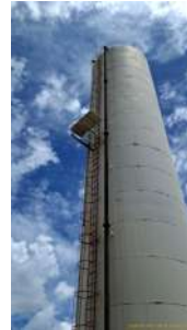
Foto 2 - Escada e guarda corpo instalados na estrutura.
