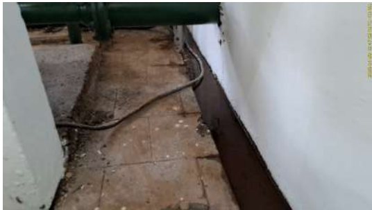
Foto 10 - Canaleta, cortada no piso, junto à parede, para escoamento da água de lubrificação de gaixeta.
