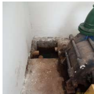
Foto 8 - Corte no piso para drenagem da água de lubrificação de gaixetas.
