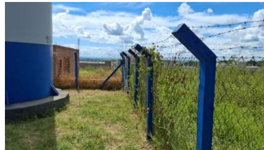
Foto 10 - Vista da área interna da unidade.
