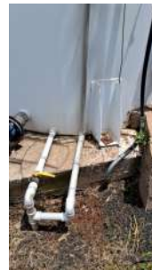
Foto 8 - Tubo extravasor e tubo de drenagem são direcionados à galeria de águas pluviais.
