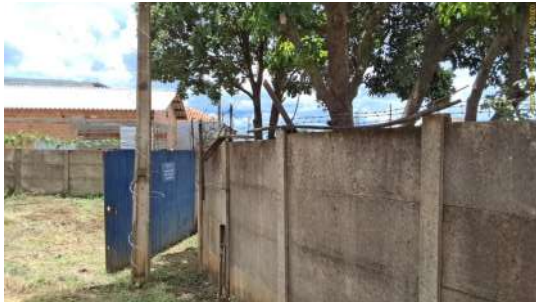
Foto 4 - Obstáculo de arame farpado instalado sobre o muro colapsado. Pedacos de madeira suportam o que resta.
