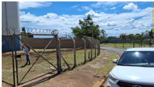
Foto 10 - Vista da unidade a partir do passeio público, evidenciando cercamento com muro e portão.
