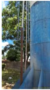
Foto 5 - Descida do tubo extravasador do reservatório 2.
