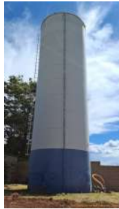
Foto 1 - Vista geral do reservatório.
