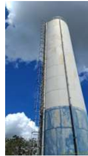
Foto 2 - Vista geral do reservatório evidenciando escada e guarda corpo.
