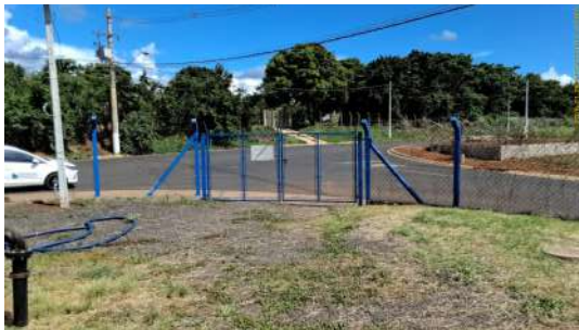
Foto 9 - Vista da área interna da unidade.
