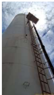
Foto 5 - À esquerda da escada, tubo extravasor.
