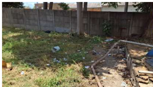
Foto 5 - Acúmulo de sujeira e material inservível na área ao redor do reservatório.
