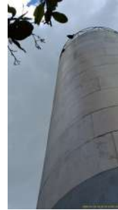
Foto 7 - Abertura para extravasão, próximo ao topo do reservatório.
