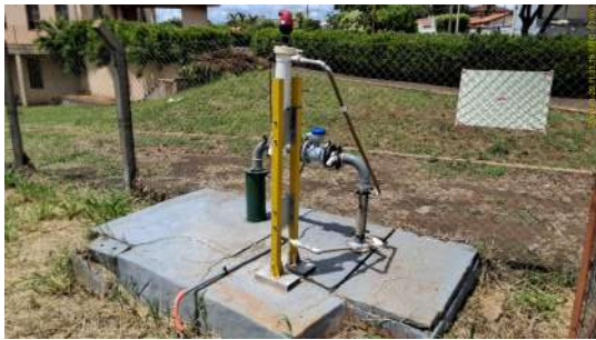
Foto 5 - Vista geral da captação.
