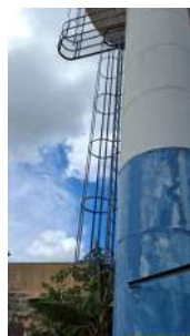
Foto 4 - Escada e guarda corpo instalados na estrutura.
