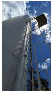
Foto 7 - Descida do tubo extravasor.
