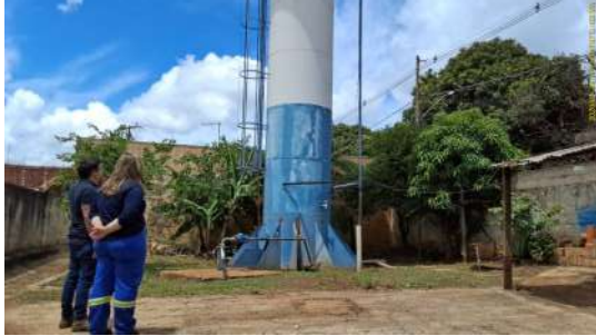
Foto 8 - Vista geral da parte inferior do reservatório.
