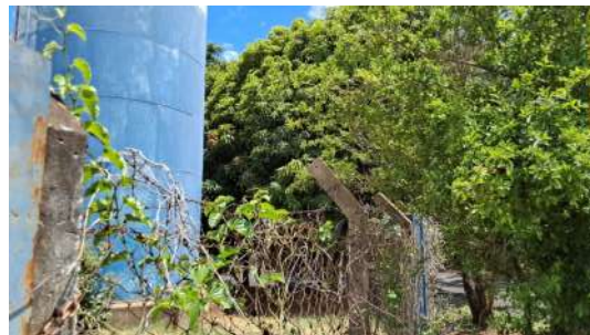
Foto 5 - Vegetação crescendo sobre o alambrado.
