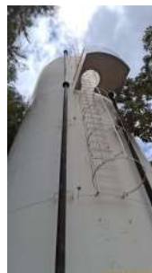
Foto 2 - Escada e guarda corpo instalados na estrutura.
