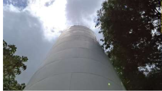
Foto 7 - Vista geral da parte superior do reservatório.
