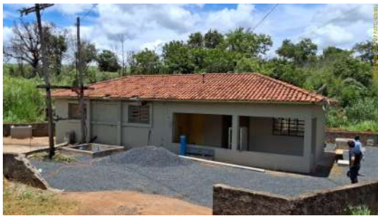
Foto 11 - Vista externa da edificação dentro da qual está a EEA.
