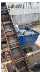
Foto 3 - Dispositivo para remoção de material grosseiro a partir da caixa de passagem pela qual o efluente entra na unidade.
