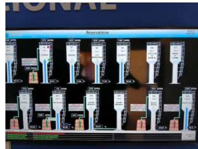
Foto 15 - Painel no CCO exibindo nível dos reservatórios.
