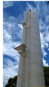
Foto 2 - Vista geral do reservatório 1, cilíndrico, indicando escada e guarda corpo instalados na estrutura. Tubulação de entrada de água à direita da escada.
