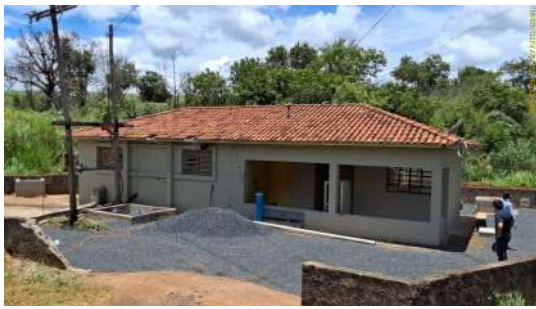
Foto 7 - Vista externa da edificação dentro da qual está instalada a EEA.
