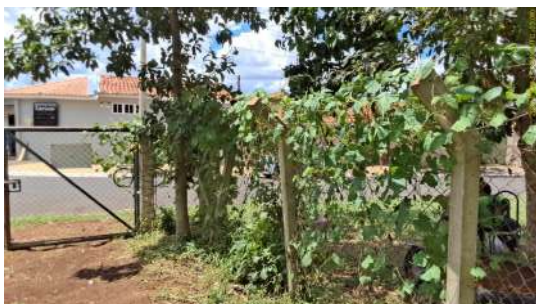
Foto 4 - Vegetação crescendo sobre o cercamento.
