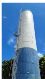
Foto 3 - Vista da escada e guarda corpo instalados na estrutura.
