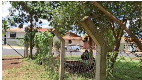
Foto 3 - Ausência do obstáculo de arame farpado na parte superior da cerca. Ao fundo, vegetação crescendo sobre a cerca.
