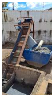
Foto 4 - Dispositivo para remoção de material grosseiro a partir da caixa de passagem pela qual o efluente entra na unidade.
