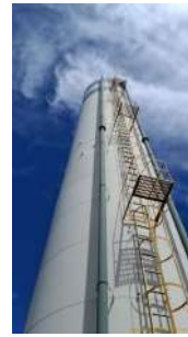
Foto 4 - Escada e guarda corpo instalados na estrutura. Tubo extravasor à esquerda e tudo de entrada de água à direita.
