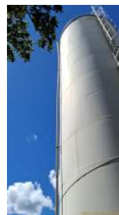
Foto 5 - Descida do tubo extravasador.
