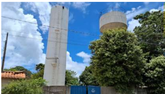
Foto 11 - Vista geral dos dois reservatórios, a partir do passeio público.
