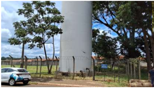
Foto 5 - Vista externa da unidade, a partir do passeio público., evidenciando cercamento da área.
