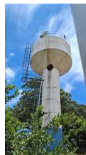
Foto 4 - Vista geral do reservatório 2, em formato de taça, evidenciando escada e guarda corpo instalados na estrutura.
