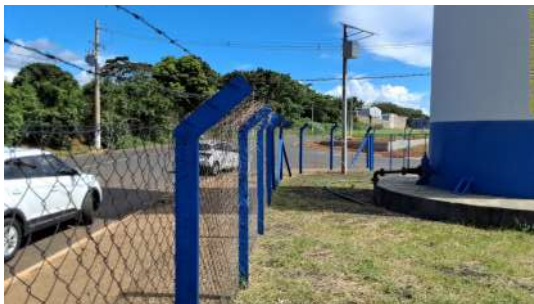
Foto 11 - Vista da área interna da unidade.
