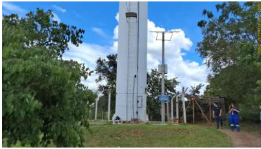
Foto 9 - Vista geral da unidade, evidenciando cercamento da área.
