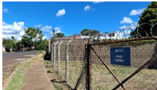
Foto 11 - Vista da unidade a partir do passeio público, evidenciando cercamento com muro e portão.
