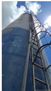
Foto 5 - Escadas e guarda corpo instalados na estrutura.
