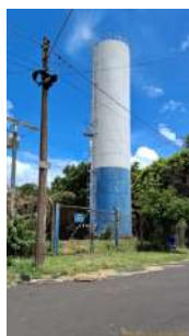
Foto 1 - Vista geral do reservatório.
