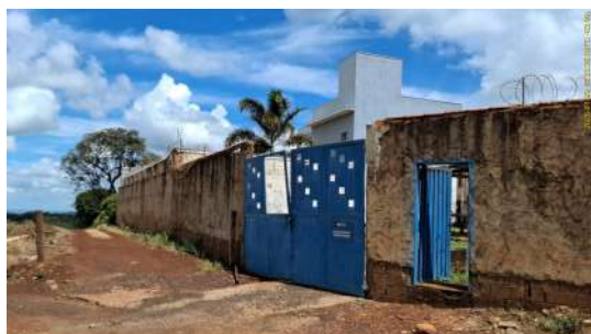
Foto 5 - Vista externa da unidade, evidenciando cercamento com muro e portões.
