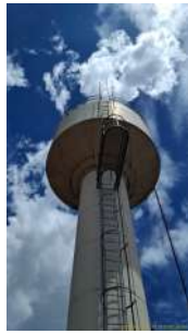
Foto 6 - Escada e guarda corpo instalados na estrutura.
