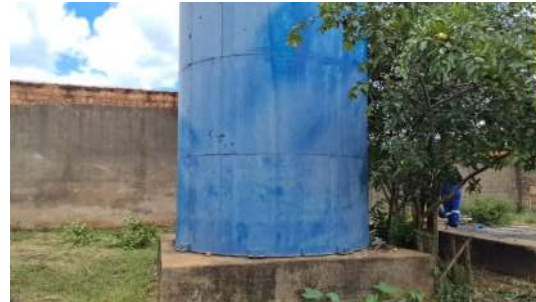
Foto 10 - Vista geral da base do reservatório.
