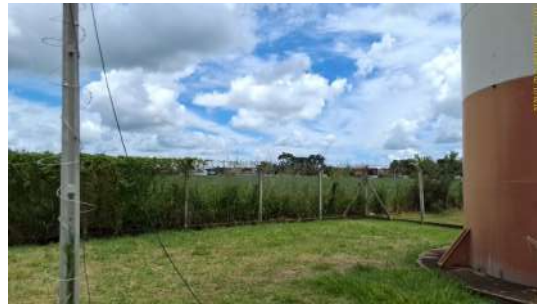
Foto 13 - Vista interna da unidade, evidenciando cercamento da área.
