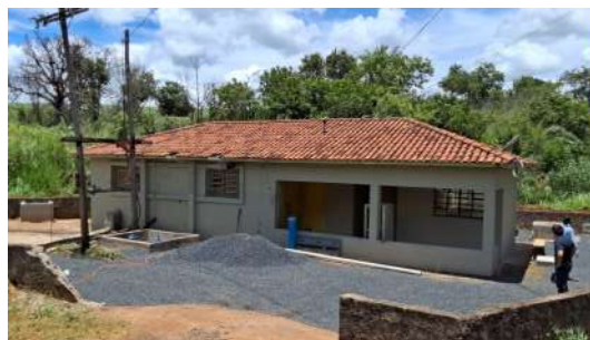
Foto 2 - Vista externa da edificação dentro da qual está instalada a EEA.
