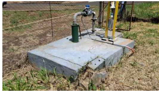
Foto 6 - Vista geral da captação.
