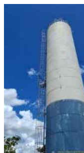
Foto 2 - Vista da escada e guarda corpo instalados na estrutura.
