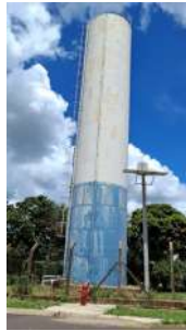
Foto 1 - Vista geral da unidade, evidenciando cercamento da área com alambrado.
