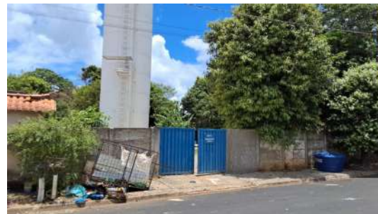
Foto 10 - Vista externa da área, a partir do passeio público, evidenciando cercamento da área com muro e acesso por portão.
