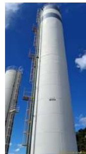
Foto 2 - Escada e guarda corpo instalados na estrutura.
