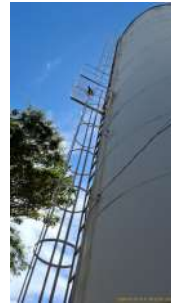
Foto 2 - Escada e guarda corpo instalados na estrutura.
