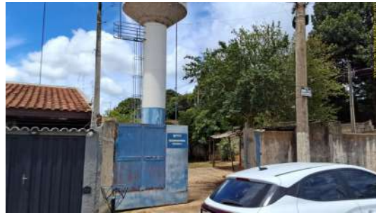
Foto 7 - Vista geral da área da unidade, a partir do passeio público.
