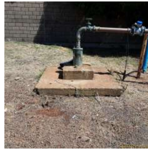
Foto 2 - Laje de alvenaria sobre o solo, protegendo o poço.
