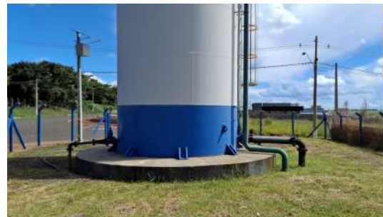
Foto 12 - Vista geral da base do reservatório.
