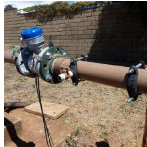
Foto 6 - Torneira para coleta de água bruta da captação.
