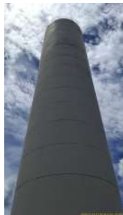
Foto 7 - Vista geral do reservatório, evidenciando guarda corpo no topo.
