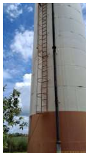
Foto 3 - Escada e guarda corpo instalados na estrutura.
