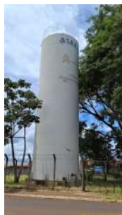
Foto 1 - Vista geral do reservatório, a partir do passeio público.
