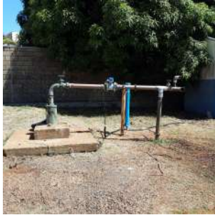
Foto 3 - Vista geral da captação.
