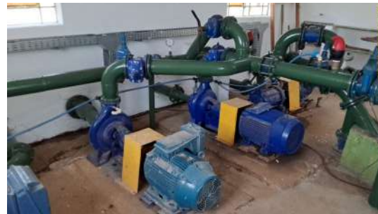
Foto 8 - Vista geral da EEA
