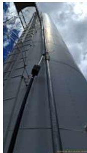
Foto 5 - Descida do condutor do SPDA.
