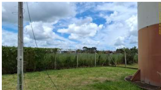
Foto 1 - Vegetação crescendo sobre o alambrado que cerca a área.
