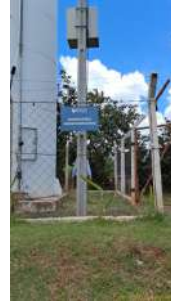
Foto 2 - Placa com identificação da unidade, afixada no cercamento.
