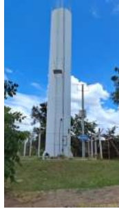
Foto 1 - Vista geral do reservatório.
