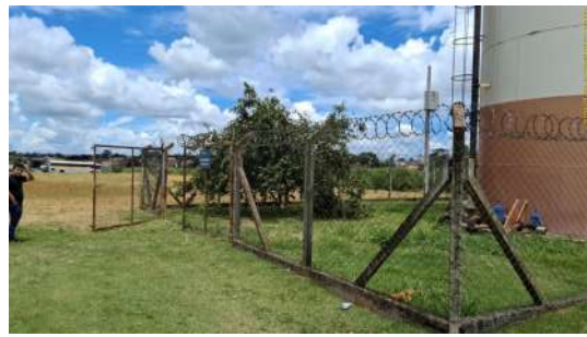
Foto 10 - Vista externa da área, evidenciando cercamento.
