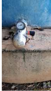
Foto 6 - Manômetro e sensor de pressão interligado à telemetria para medição de nível do reservatório.
