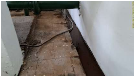
Foto 3 - Canaleta cortada no piso para afastamento da água de lubrificação de gaixeta.
