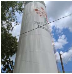
Foto 6 - Vista lateral do reservatório.
