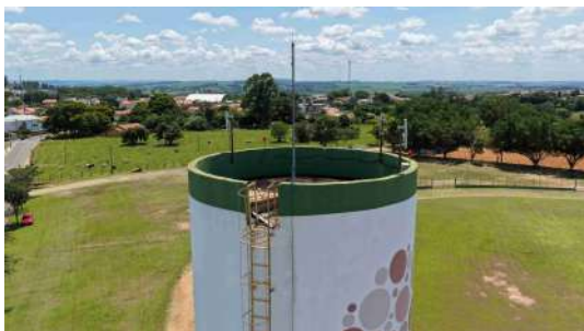
Foto 11 - Topo do reservatório, com destaque para o para-raios.
