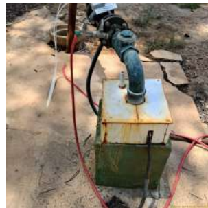
Foto 4 - Laje de proteção e tubo de nível.
