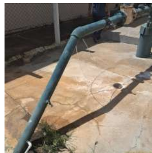
Foto 2 - Pontos de cloração e fluoretação.
