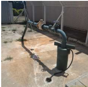
Foto 6 - Vista geral do poço.
