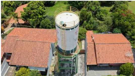
Foto 9 - Vista lateral do reservatório, com detalhe da escada de acesso ao topo.
