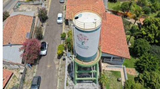
Foto 8 - Vista lateral do reservatório
