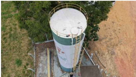
Foto 10 - Parte superior do reservatório.
