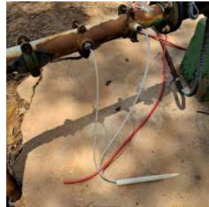
Foto 2 - Ponto de cloração e fluoretação.
