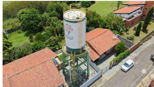
Foto 10 - Vista geral do reservatório.
