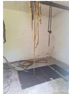
Foto 3 - Poço de sucção instalado no interior do abrigo, caracterizado como ambiente fechado.
