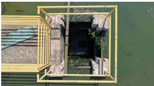
Foto 21 - Vista superior da caixa de saída/vertedouro da lagoa facultativa.
