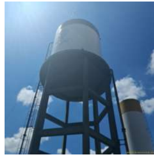
Foto 4 - Vista geral do reservatório.
