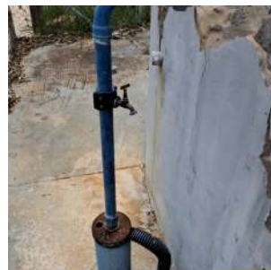
Foto 2 - Torneira para coleta de água para análise.
