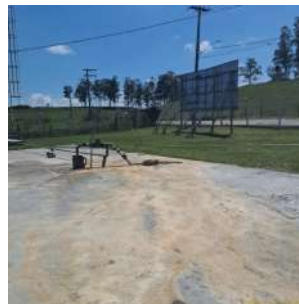
Foto 2 - Vista geral do poço.
