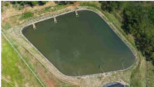
Foto 17 - Vista superior da lagoa facultativa.
