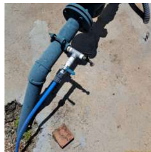
Foto 2 - Torneira para coleta de água para análise.
