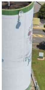
Foto 15 - Medidor de nível.
