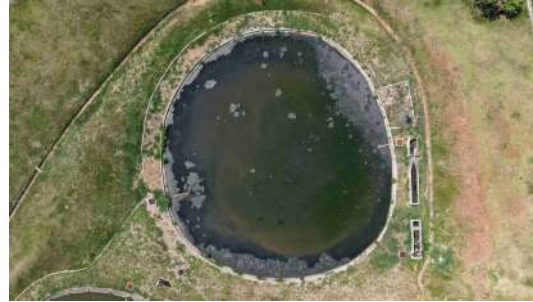
Foto 16 - Vista superior da lagoa anaeróbica.
