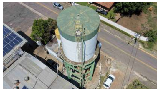
Foto 7 - Tampa de inspeção, tubo extravasor e para-raios.
