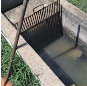
Foto 5 - Segundo gradeamento.
