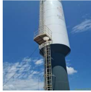
Foto 2 - Escada de acesso ao topo.
