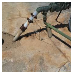
Foto 5 - Ponto de cloração e fluoretação.
