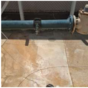
Foto 3 - Torneira para coleta de água para análise.
