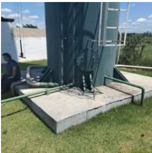
Foto 5 - Base do reservatório em detalhe.
