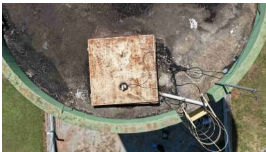
Foto 9 - Tampa de inspeção.
