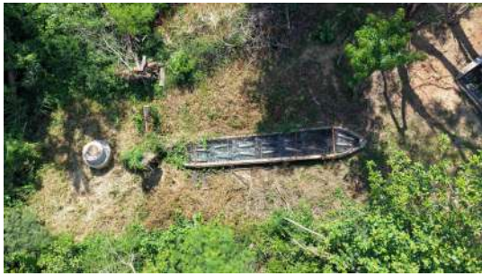
Foto 23 - Vista superior do tanque de contato.
