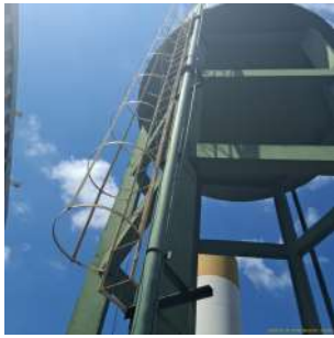
Foto 3 - Escada de acesso ao topo.
