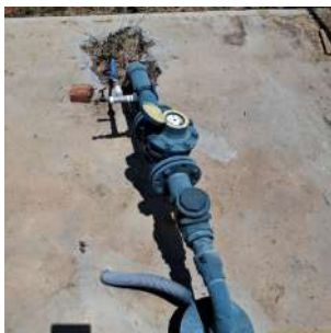
Foto 1 - Vista geral do poço.
