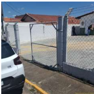
Foto 1 - Portão de acesso à área reservada do poço.
