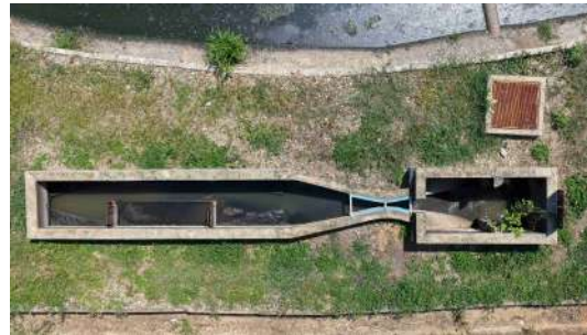
Foto 18 - Vista superior do tanque de areia.
