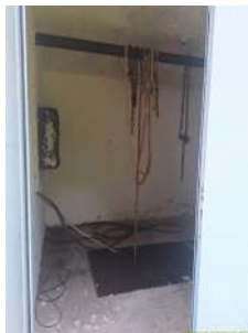
Foto 4 - Vista da porta de acesso ao poço de sucção.
