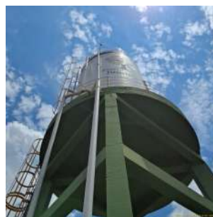
Foto 4 - Vista lateral do reservatório.
