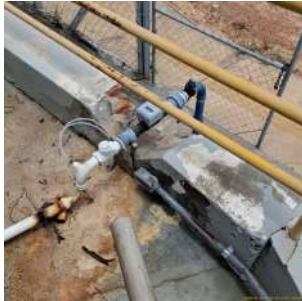
Foto 5 - Vista geral do poço.
