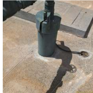
Foto 5 - Tubo de nível do poço.
