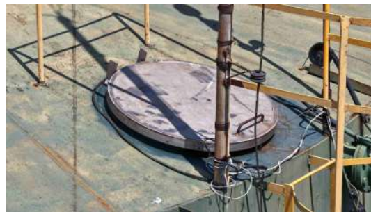
Foto 9 - Tampa de inspeção.
