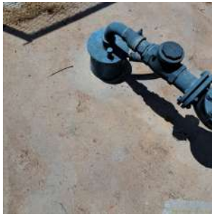
Foto 3 - Laje de proteção e medidor de nível.
