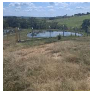
Foto 2 - Cercamento da estação de tratamento de esgoto.
