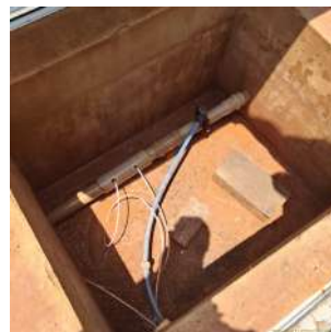
Foto 8 - Ponto de cloração e fluoretação.
