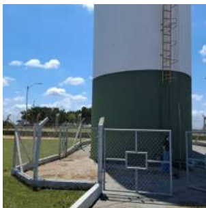
Foto 1 - Portão de acesso para a área do reservatório.
