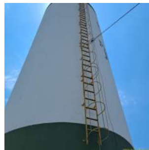
Foto 2 - Escada de acesso ao topo.
