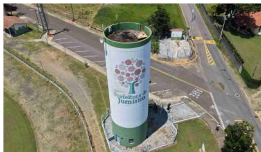
Foto 14 - Vista geral do reservatório.
