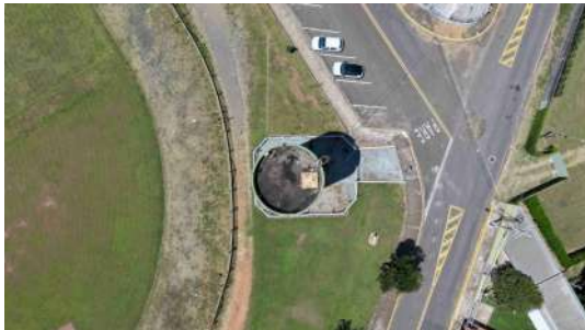
Foto 7 - Vista da parte superior do reservatório.
