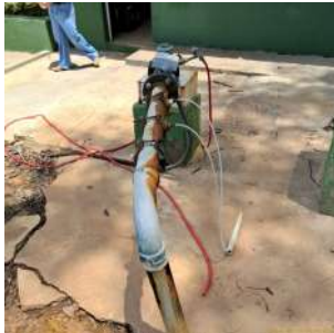
Foto 1 - Vista geral do poço.
