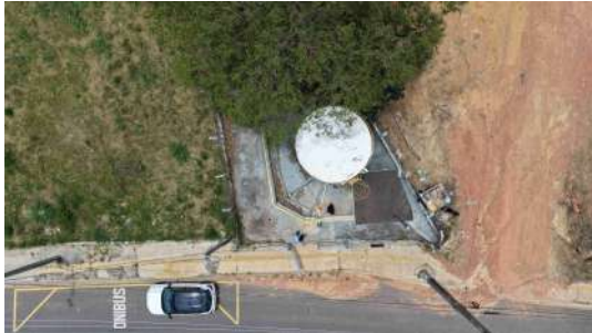
Foto 8 - Vista do entorno do reservatório
