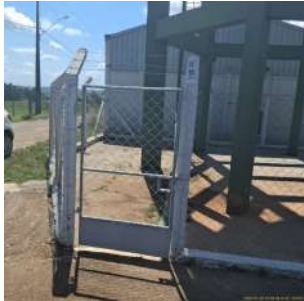
Foto 5 - Portão de acesso para a área do reservatório.
