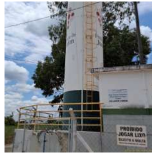
Foto 7 - Vista geral do reservatório.
