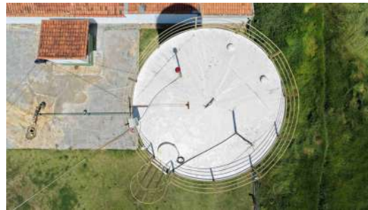
Foto 6 - Vista da parte superior do reservatório.
