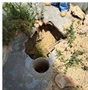
Foto 2 - Abertura feita para instalação de macromedidor.
