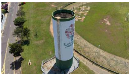
Foto 13 - Vista geral do reservatório.
