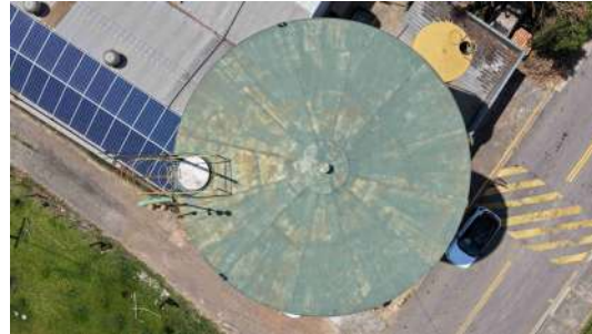
Foto 6 - Vista da parte superior do reservatório.
