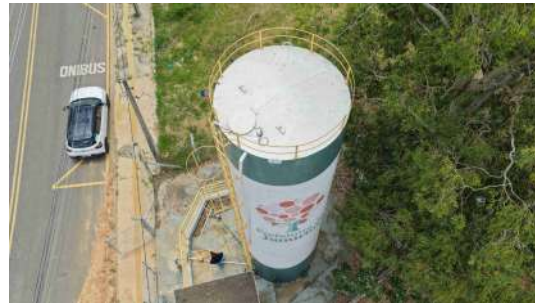
Foto 11 - Parte superior do reservatório.
