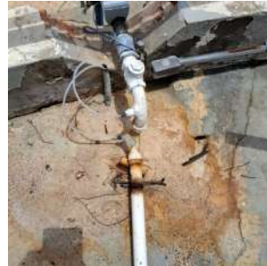
Foto 6 - Ponto de cloração e fluoretação.
