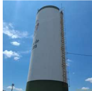
Foto 6 - Vista geral do reservatório.
