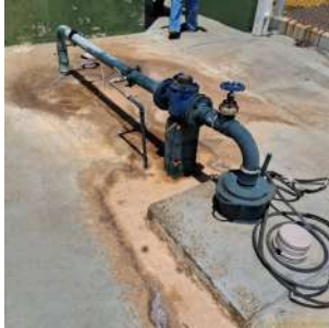
Foto 1 - Vista geral do poço.
