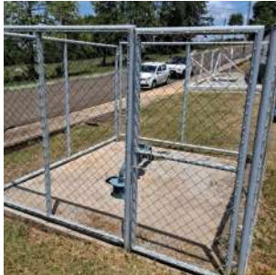
Foto 5 - Vista geral do poço.
