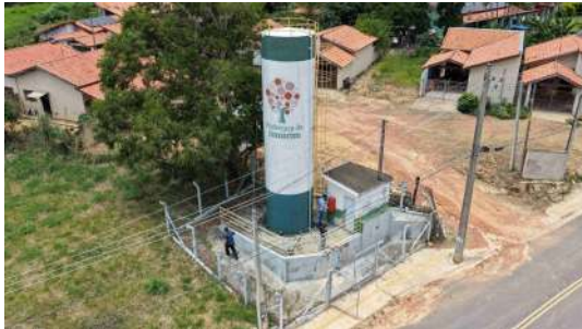
Foto 12 - Vista geral do reservatório.
