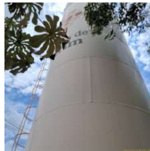
Foto 4 - Vista lateral do reservatório.
