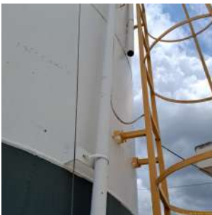
Foto 3 - Tubo extravasor (saída localizada atrás da escada).
