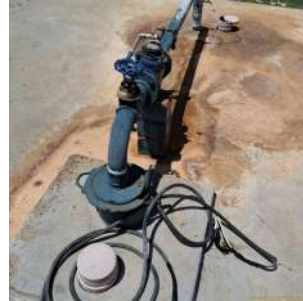
Foto 2 - Laje de proteção e tubo de nível.
