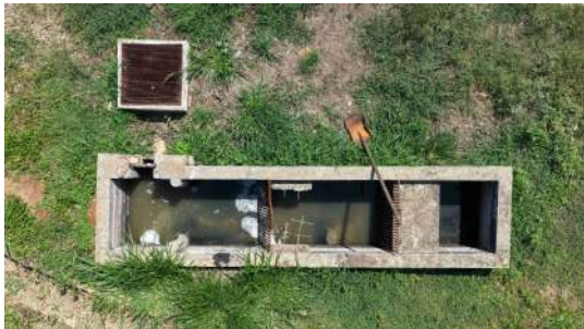
Foto 19 - Vista superior do gradeamento.
