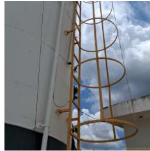
Foto 2 - Escada de acesso ao topo.
