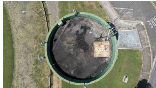
Foto 8 - Vista da parte superior do reservatório detalhada.
