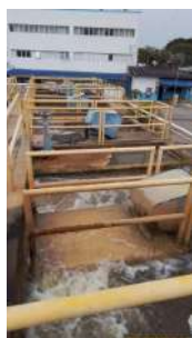
Foto 7 - Canal de entrada da água
