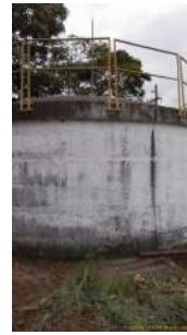
Foto 4 - Vista da lateral do reservatório
