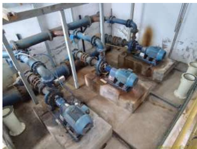
Foto 1 - Vista geral da casa de bombas
