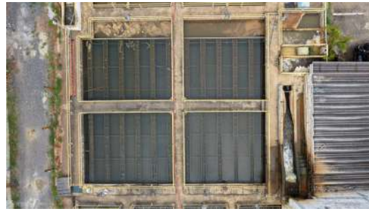
Foto 30 - Vista aérea dos tanques da ETA Central
