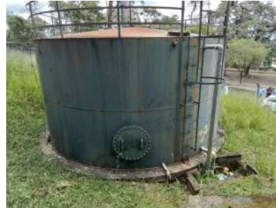
Foto 4 - Vista lateral do reservatório
