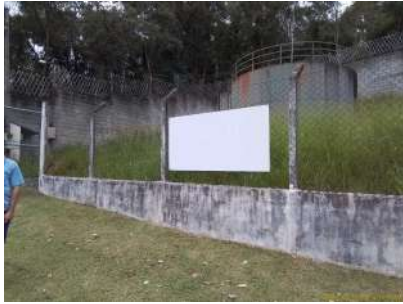
Foto 1 - Fachada da entrada da área do reservatório
