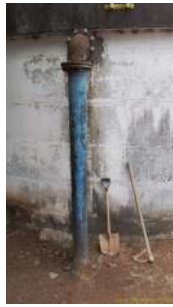
Foto 3 - Tubulação da lateral do reservatório
