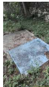
Foto 6 - Tampa de inspeção
