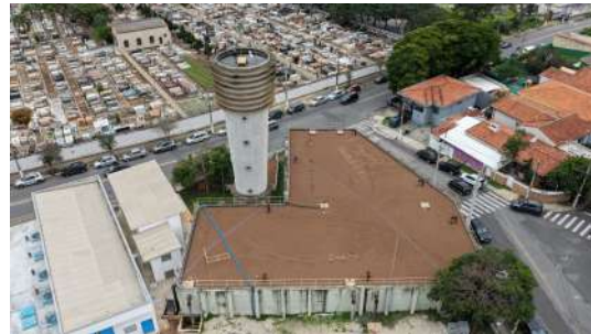
Foto 5 - Vista aérea do reservatório semienterrado da ETA Central
