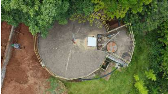
Foto 5 - Vista aérea do reservatório
