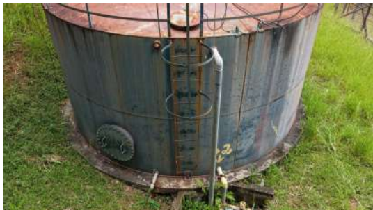
Foto 9 - Escada de acesso na lateral
