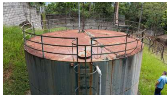
Foto 8 - Parte superior do reservatório
