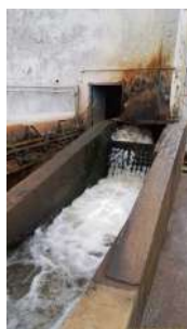
Foto 5 - Canal de entrada da água
