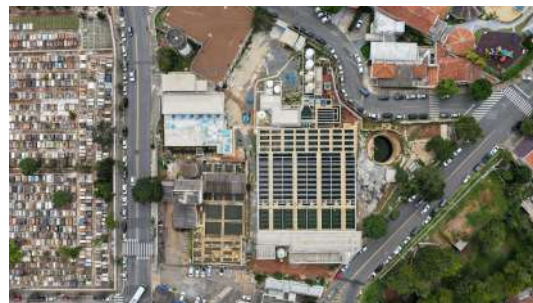
Foto 28 - Vista aérea da ETA
