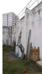
Foto 4 - Lateral do reservatório
