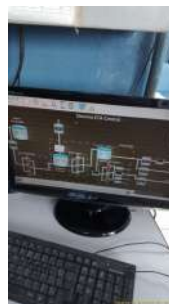
Foto 4 - Controle de operações das bombas e reservatórios
