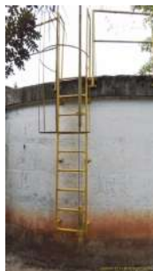
Foto 1 - Escada de acesso para o reservatório
