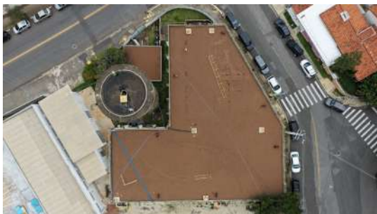
Foto 6 - Vista aérea do reservatório semienterrado da ETA Central
