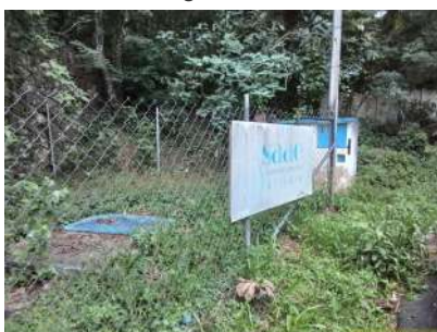
Foto 9 - Fachada da EEAT
