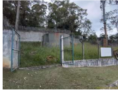
Foto 2 - Fachada da entrada da área do reservatório
