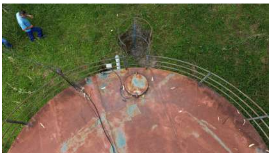
Foto 7 - Destaque para tampa do reservatório
