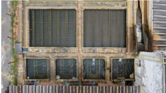
Foto 31 - Vista aérea dos tanques da ETA Central
