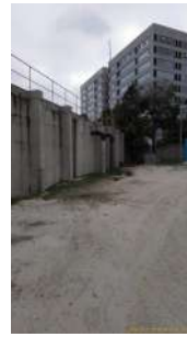
Foto 2 - Lateral do reservatório
