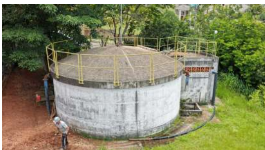
Foto 11 - Reservatório Fazenda do Porto (caixa branca)
