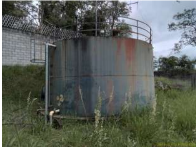
Foto 3 - Vista lateral do reservatório
