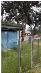
Foto 1 - Ausência de placa de identificação do sistema
