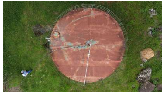
Foto 6 - Vista aérea do reservatório
