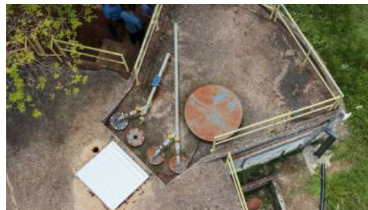
Foto 8 - Vista aérea do reservatório
