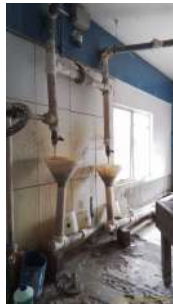
Foto 13 - Dosador de sulfato
