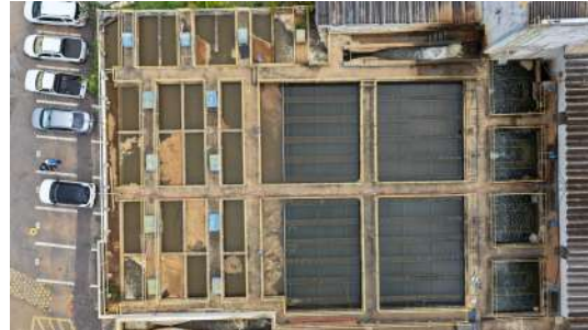
Foto 32 - Vista aérea dos tanques da ETA Central
