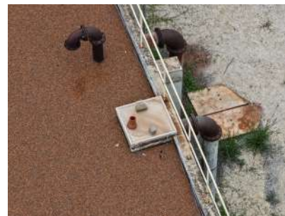
Foto 7 - Parte superior do reservatório
