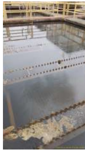
Foto 1 - Vertedores desnivelados
