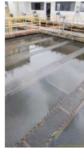
Foto 2 - Vertedores desnivelados
