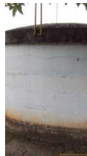
Foto 2 - Lateral do reservatório Fazenda Porto (caixa branca)
