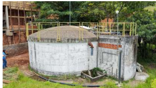
Foto 10 - Reservatório Fazenda do Porto (caixa branca)
