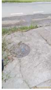
Foto 1 - Tampa do poço
