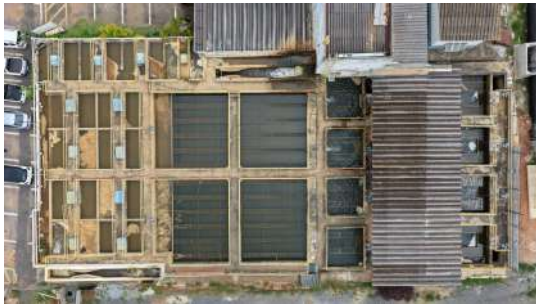
Foto 29 - Vista aérea dos tanques da ETA Central
