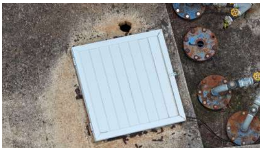
Foto 7 - Tampa do reservatório
