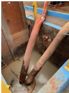
Foto 1 - Mangote deformado.
