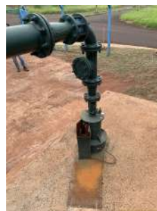
Foto 4 - Vista geral do poço desativado.
