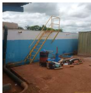
Foto 2 - Vista geral do reservatório.
