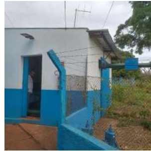
Foto 2 - Vista geral da casa de bombas.
