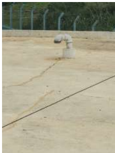
Foto 7 - Tubulações de ventilação com tela.
