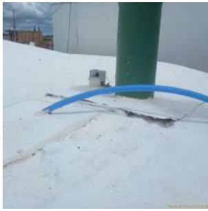
Foto 7 - Uma das entrada de tubulação pela laje do reservatório (Poço P0).
