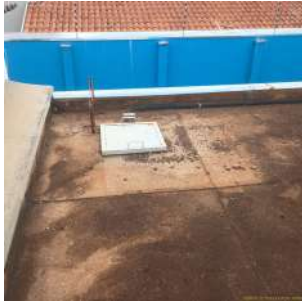
Foto 7 - Tampa de inspeção substituída.
