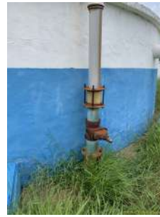
Foto 2 - Vista do entorno do reservatório.
