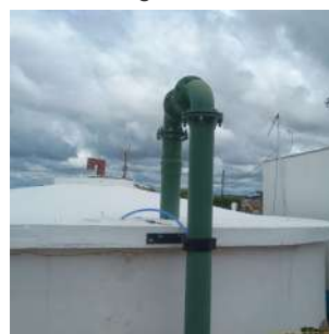
Foto 6 - Vista geral do reservatório.
