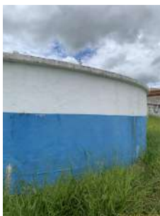
Foto 9 - Vista do entorno do reservatório.
