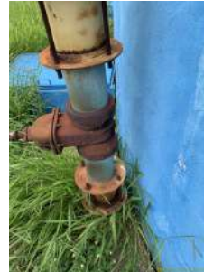
Foto 4 - Vista do entorno do reservatório.
