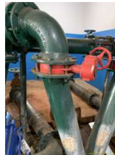
Foto 2 - Registro sem vazamento.
