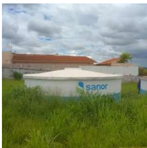
Foto 5 - Vista geral do reservatório.
