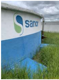
Foto 1 - Vista do entorno do reservatório.
