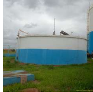
Foto 4 - Vista geral do reservatório.
