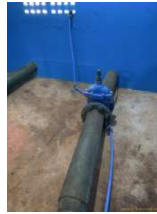
Foto 6 - Registro sem vazamento.
