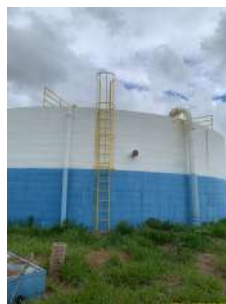
Foto 2 - Guarda-corpo do topo parcialmente concluído.
