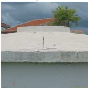
Foto 7 - Vista geral do reservatório.
