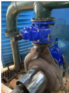
Foto 1 - Registro sem vazamento.
