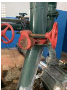
Foto 3 - Registro sem vazamento.
