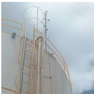
Foto 5 - Vista geral do reservatório.
