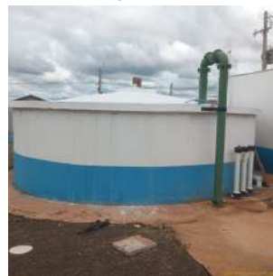
Foto 4 - Vista geral do reservatório.
