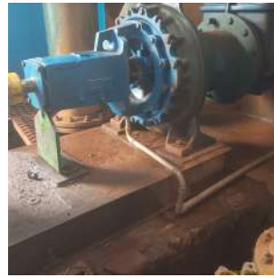
Foto 8 - Drenagem inadequada.
