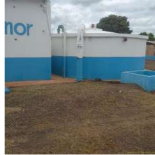
Foto 10 - Vista geral do reservatório.
