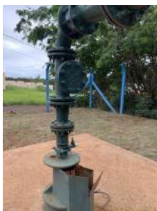
Foto 3 - Vista geral do poço desativado.
