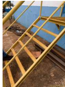
Foto 8 - Escada de acesso à porta de inspeção.
