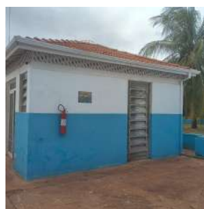
Foto 2 - Vista geral da casa de bombas.
