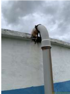
Foto 3 - Vista do entorno do reservatório.
