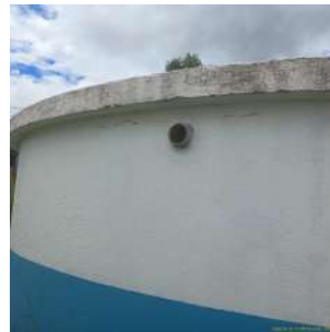
Foto 4 - Vista geral do reservatório.
