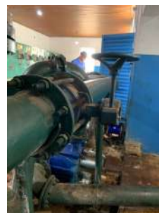
Foto 4 - Registro sem vazamento.
