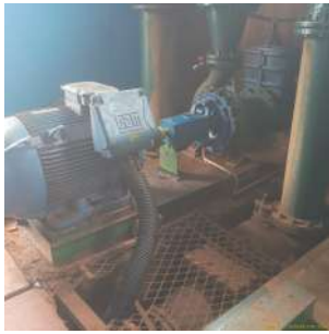
Foto 7 - Drenagem inadequada.
