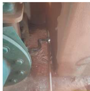
Foto 6 - Saída da drenagem.
