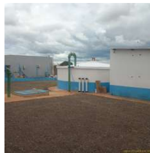
Foto 2 - Vista geral do reservatório.
