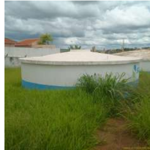
Foto 2 - Vista geral do reservatório.
