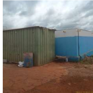
Foto 8 - Vista geral do reservatório.
