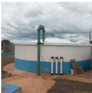
Foto 3 - Vista geral do reservatório.
