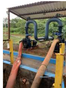
Foto 2 - Mangote deformado.
