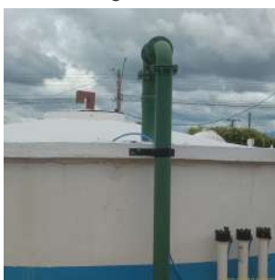
Foto 5 - Vista geral do reservatório.
