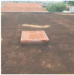
Foto 5 - Tampa de inspeção substituída.
