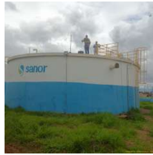
Foto 2 - Guarda-corpo do topo parcialmente concluído.
