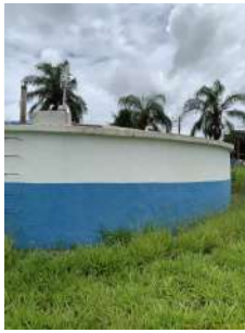
Foto 11 - Vista do entorno do reservatório.
