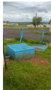
Foto 2 - Tampa das caixas de válvulas.
