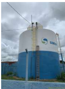
Foto 1 - Vista dos guarda-corpos do reservatório.
