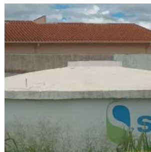
Foto 6 - Vista geral do reservatório.
