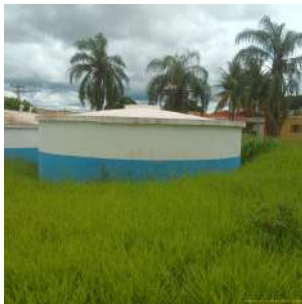
Foto 3 - Vista geral do reservatório.
