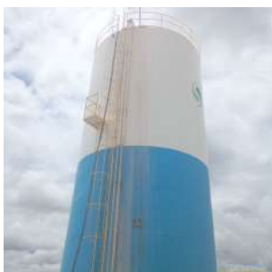
Foto 3 - Vista geral do reservatório.
