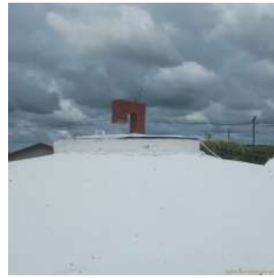
Foto 8 - Tampa de inspeção central, com tubo de ventilação.
