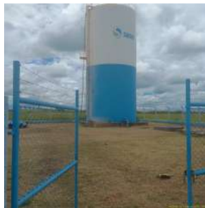
Foto 2 - Vista geral do reservatório.
