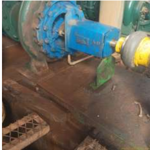
Foto 9 - Drenagem inadequada.
