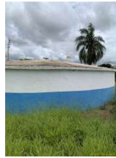
Foto 12 - Vista do entorno do reservatório.
