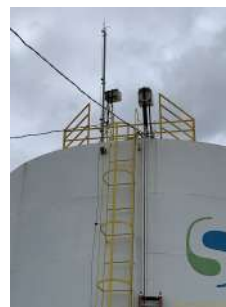
Foto 2 - Guarda-corpo do topo do reservatório.
