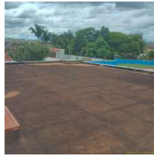
Foto 6 - Tampa de inspeção substituída.
