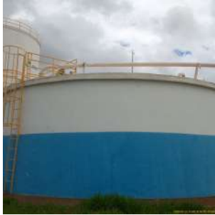
Foto 3 - Guarda-corpo do topo parcialmente concluído.
