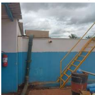
Foto 3 - Vista geral do reservatório.
