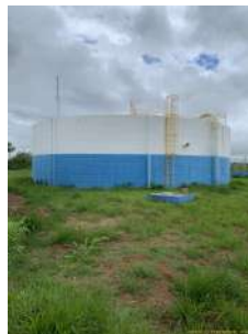
Foto 2 - Vista geral do reservatório.
