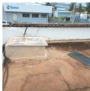
Foto 4 - Tampa de inspeção substituída.
