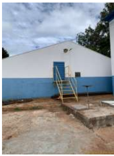
Foto 3 - Vista frontal do reservatório.
