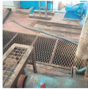
Foto 2 - Direcionamento da drenagem.
