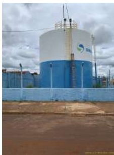
Foto 1 - Vista geral do reservatório.
