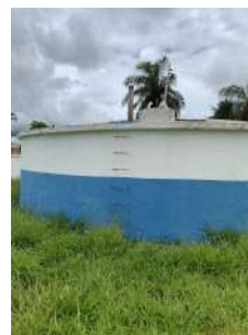
Foto 10 - Vista do entorno do reservatório.
