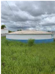
Foto 1 - Vista geral do reservatório.
