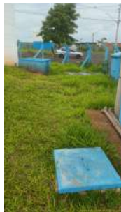
Foto 1 - Tampa das caixas de válvulas.
