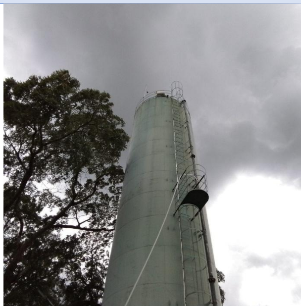
Foto 2 - Vista geral do Reservatório Santa Fé.
