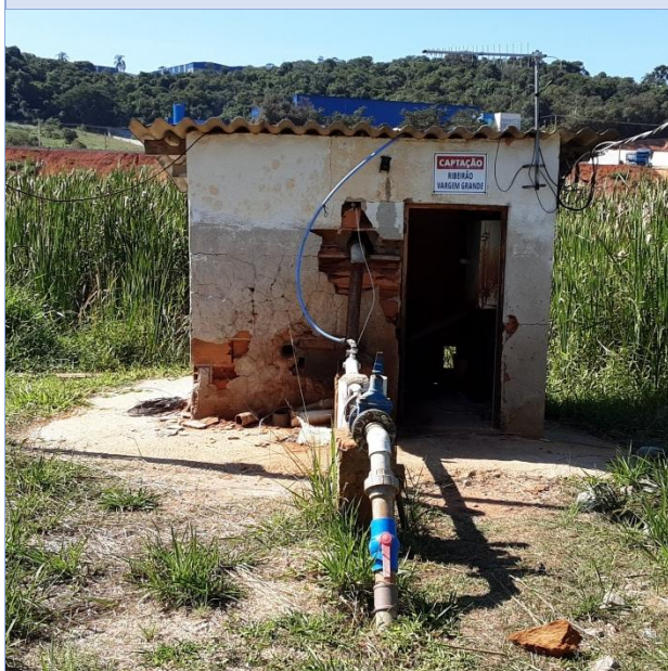
Foto 1 – Vista geral das instalações da Captação
