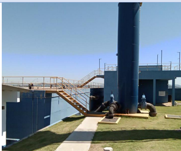
Foto 2 – Vista geral do novo módulo (à direita) e novo reservatório (à esquerda).
