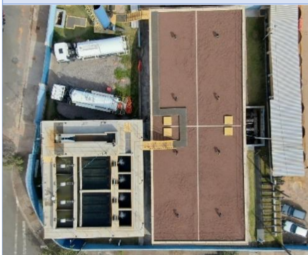
Foto 1 – Módulo de ampliação da ETA Central e novo reservatório.
