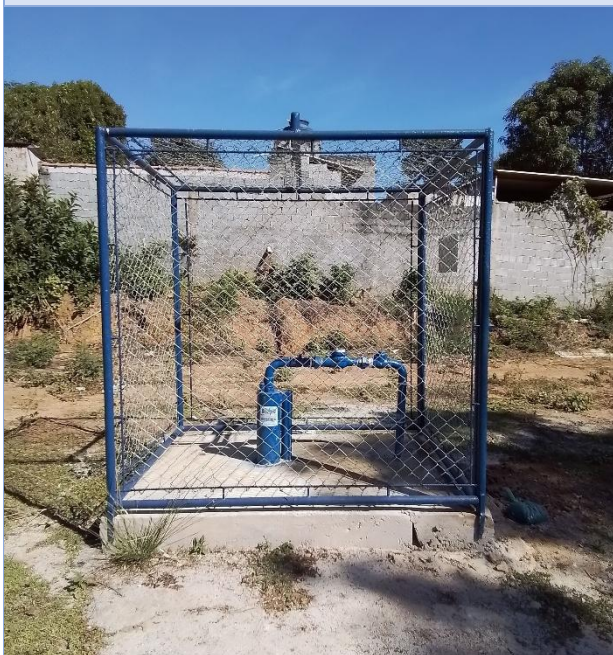
Foto 1 – Novo poço para abastecimento do Bairro Serra Negra.
