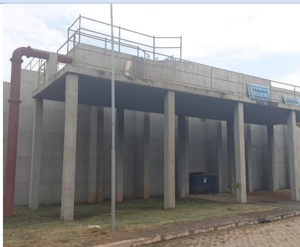
Foto 2 – Vista geral da ETE.
