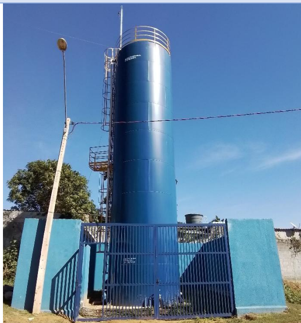
Foto 2 – Novo reservatório do Bairro Serra Negra.
