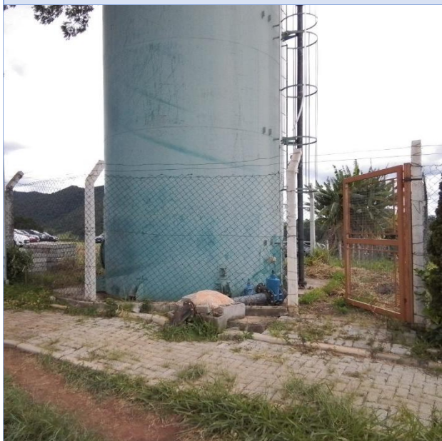
Foto 1 – Vista geral do Reservatório Santa Fé.
