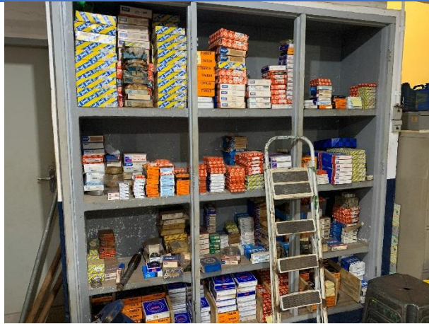
Figura 16 - Estoque de peças de manutenção das bombas.
