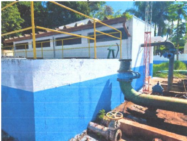
Figura 9 - Exterior Cx. sucção Quintino (Fonte: SAERP).
