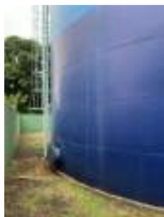
Foto 8 - Vista geral do reservatório.
