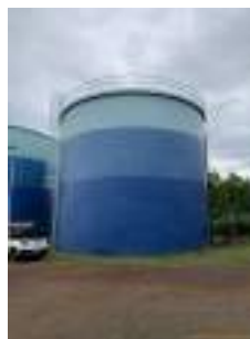
Foto 2 - Vista do reservatório 1.
