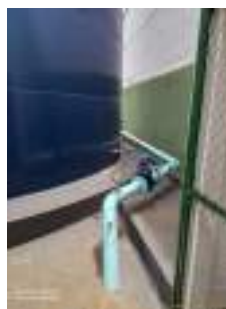
Foto 4 - Base do reservatório.
