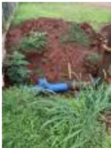
Foto 1 - Fechar o buraco da adutora do p52.
