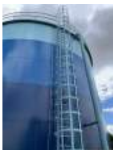
Foto 10 - Guarda-corpo e medição de nível do reservatório maior.
