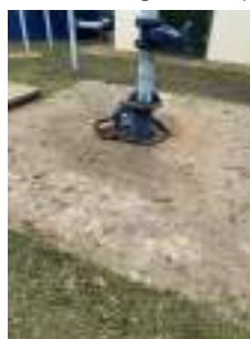
Foto 4 - Laje do poço.
