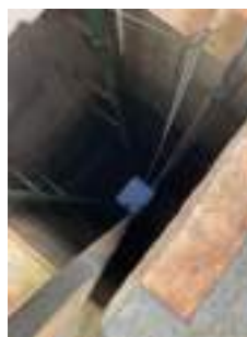
Foto 6 - Poço de chegada com cesto.
