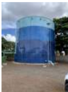
Foto 1 - Vista do extravasor e tubo de medição de nível.
