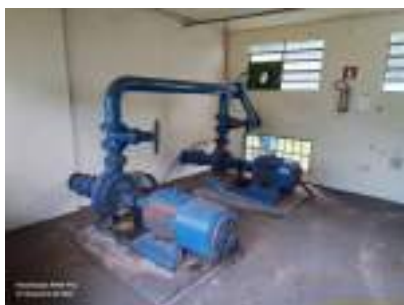
Foto 5 - Vista do interior da edificação da EEA.
