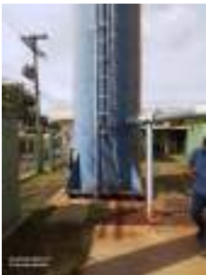
Foto 2 - Vista da escada com guarda-corpo e medidor de nível.
