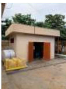
Foto 1 - Vista geral da edificação da EEA.
