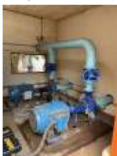
Foto 3 - Vista do interior da edificação da EEA.
