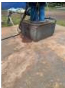
Foto 9 - Laje do poço.
