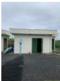
Foto 1 - Vista geral da edificação da EEA.
