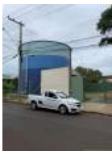
Foto 1 - Vista geral do reservatório e cercamento.
