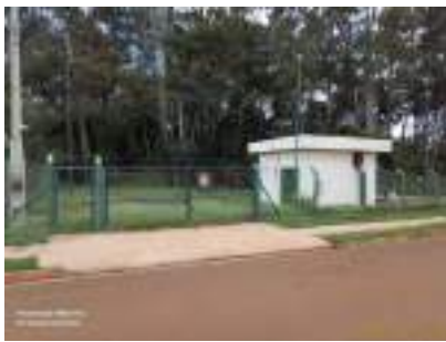
Foto 1 - Vista externa da EEEB e cercamento..
