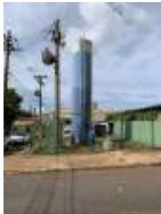
Foto 1 - Vista geral do poço e cercamento.
