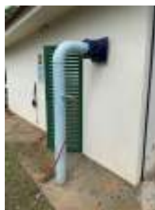
Foto 14 - Tubulação de recalque.
