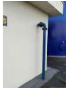
Foto 8 - Tubulação de recalque.
