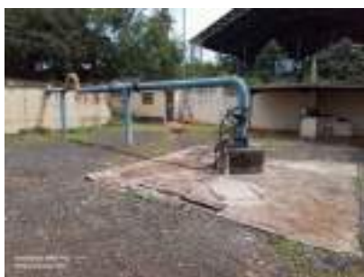
Foto 1 - Vista geral do poço, cercamento e laje de proteção.
