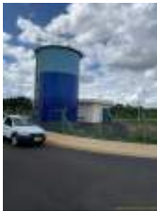
Foto 1 - Vista externa do local e cercamento.
