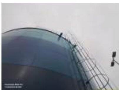
Foto 3 - Guarda-corpo e extravasor do reservatório.
