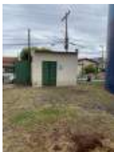
Foto 1 - Vista geral da edificação da EEA.
