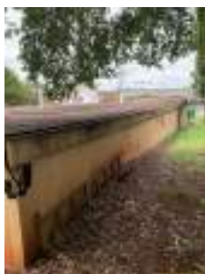
Foto 6 - Vista do reservatório face 4.
