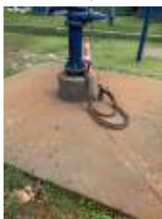
Foto 5 - Laje do poço.
