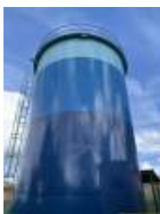
Foto 8 - Guarda-corpo do reservatório 1.
