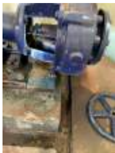
Foto 1 - Bomba 2 com o chão molhado.
