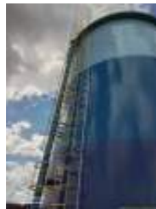
Foto 2 - Guarda-corpo e medidor de nível.
