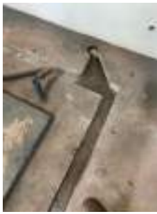
Foto 13 - Saída da canaleta de drenagem.
