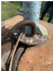
Foto 5 - Tubo para medição de nível.
