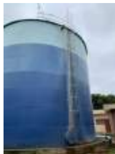
Foto 12 - Guarda-corpo e extravasor do reservatório 2.
