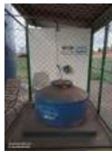
Foto 6 - Tanque e dosadora de ácido fluossilícico.
