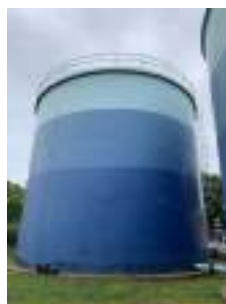
Foto 5 - Vista do reservatório 1.
