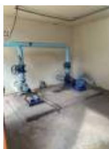
Foto 6 - Vista do interior da edificação da EEA.
