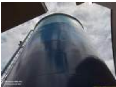
Foto 5 - Vista do reservatório.
