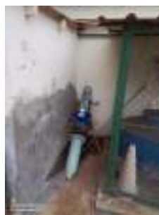
Foto 8 - Tubulação de recalque.
