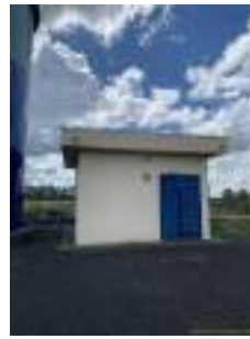
Foto 2 - Vista geral da edificação da EEA.
