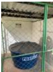
Foto 11 - Tanque de armazenamento de Hipoclorito de Sódio no lugar do Ácido Fluossilícico.
