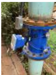
Foto 21 - Macromedidor em instalação na tubulação de recalque.
