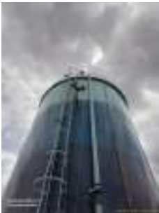
Foto 2 - Guarda-corpo e medidor de nível.
