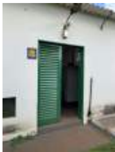
Foto 5 - Vista externa da porta de acesso.
