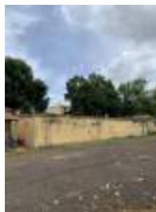
Foto 2 - Vista do reservatório.
