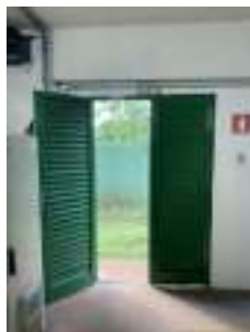
Foto 14 - Vista interna da porta de acesso.
