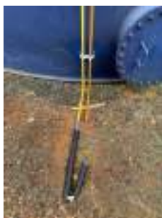
Foto 10 - Ausência de aplicação de flúor.
