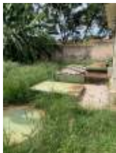
Foto 16 - Vista do fundo e caixas de chegada.
