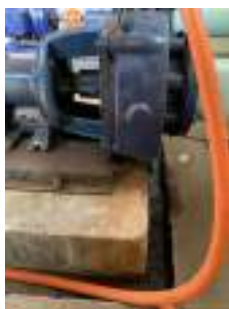
Foto 6 - Drenagem da água de gaxeta da bomba 1.
