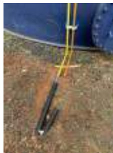
Foto 2 - Ausência de aplicação de flúor.
