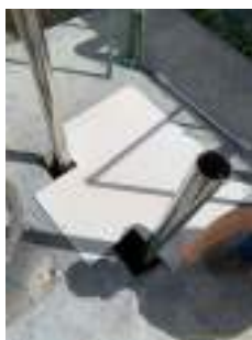
Foto 5 - Poço de chegada com tampa fixa.
