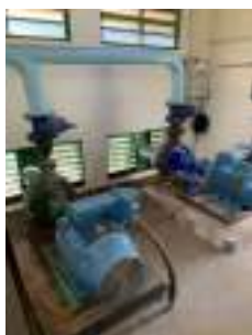
Foto 5 - Vista do interior da edificação da EEA.
