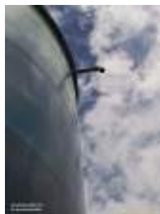
Foto 6 - Vista do extravasor.
