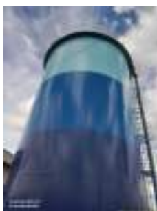
Foto 4 - Vista do reservatório.
