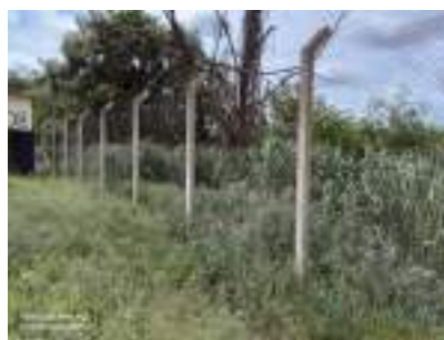
Foto 2 - Cerca da EEEB.
