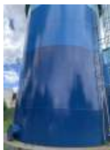
Foto 7 - Vista do reservatório menor.
