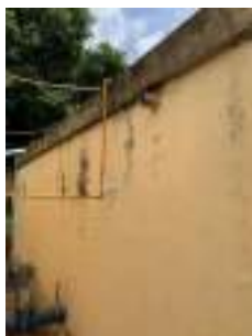
Foto 12 - Estravasor do reservatório.
