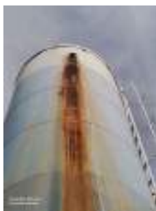
Foto 1 - Extravasor corroído sem tela de proteção. Foto 2 - Extravasor corroído sem tela de proteção.
