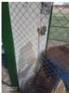
Foto 3 - Reparar a alvenaria danificada da parede.
