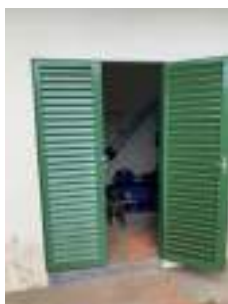
Foto 3 - Vista externa da porta de acesso.
