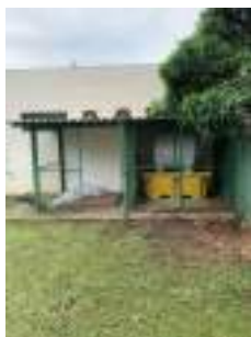
Foto 12 - Abrigo dos produtos químicos.
