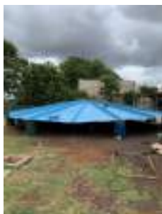
Foto 16 - Cobertura do novo reservatório P47.
