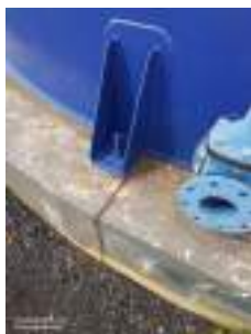
Foto 10 - Aterramento do reservatório.
