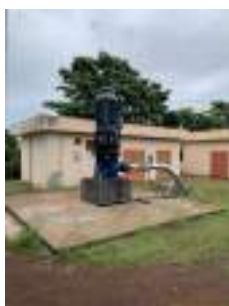
Foto 5 - Laje do poço.
