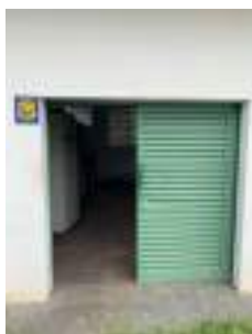
Foto 5 - Vista externa da porta de acesso.
