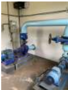
Foto 9 - Vista do interior da edificação da EEA.
