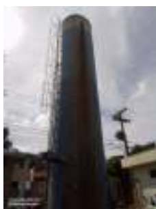
Foto 1 - Realizar pintura de proteção contra oxidação.
