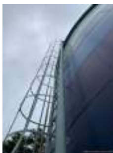
Foto 5 - Extravasor e guarda-corpo.
