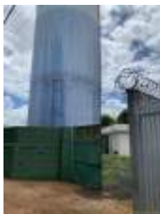
Foto 1 - Portão de acesso ao local.
