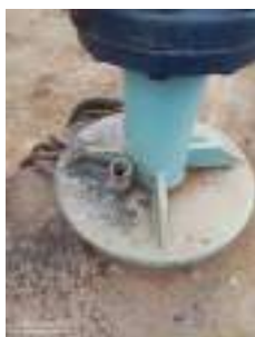
Foto 1 - Proteger o tubo de medição de nível com CAP.
