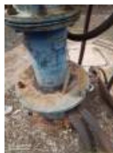
Foto 2 - Tubo para medição de nível.
