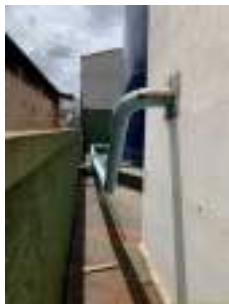
Foto 17 - Tubulação de recalque.
