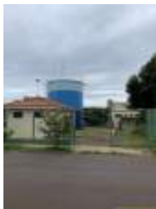
Foto 1 - Vista geral do reservatório e cercamento.
