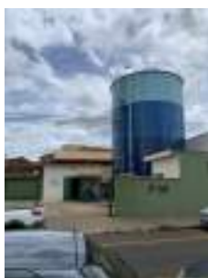
Foto 1 - Vista geral do poço e cercamento.
