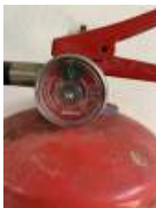
Foto 1 - Extintor despressurizado.
