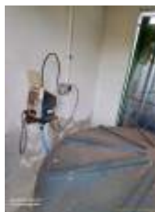
Foto 8 - Tanque e dosadora de cloro ou fluor.
