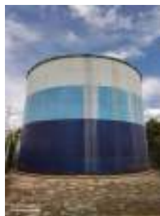
Foto 6 - Vista do reservatório.
