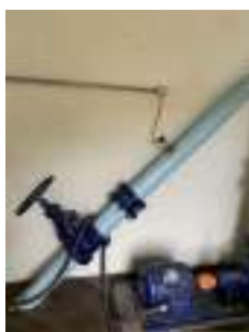
Foto 11 - Tubulação de recalque.
