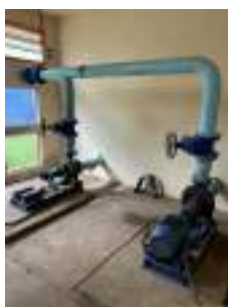
Foto 7 - Vista do interior da edificação da EEA.
