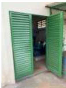
Foto 3 - Vista externa da porta de acesso.
