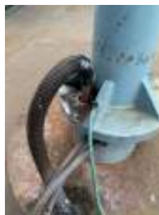
Foto 6 - Tubo para medição de nível.
