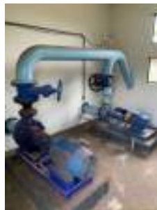
Foto 10 - Vista do interior da edificação da EEA.
