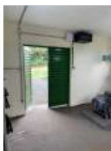
Foto 6 - Vista interna da porta de acesso.
