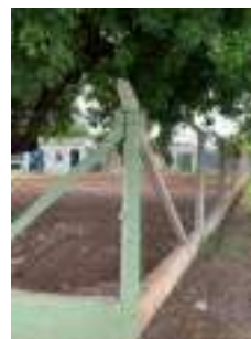
Foto 2 - Cercamento da área.
