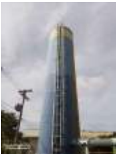
Foto 1 - Vista da escada com guarda-corpo e medidor de nível.
