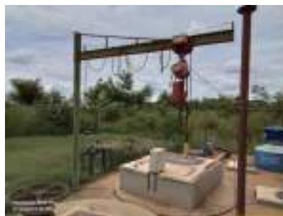
Foto 4 - Estrutura para içamento de bombas.
