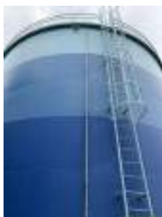
Foto 4 - Guarda-corpo e extravasor do reservatório 1.
