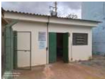
Foto 1 - Vista geral da edificação da EEA.
