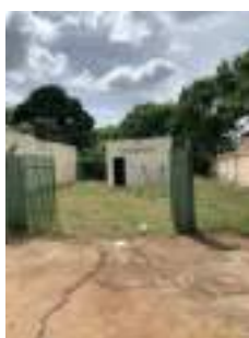
Foto 1 - Vista externa da EEEB.
