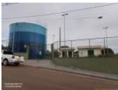
Foto 1 - Vista geral do reservatório e cercamento.
