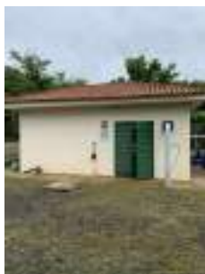
Foto 1 - Vista geral da edificação da EEA.
