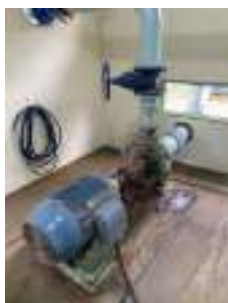
Foto 11 - Conjunto moto bomba 1 com selo mecânico.
