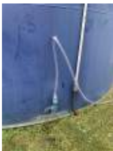
Foto 1 - Mangueira de nível no chão.
