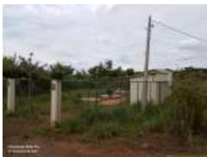
Foto 1 - Vista externa da EEEB e cercamento.
