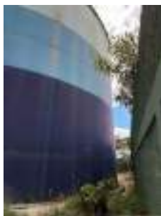
Foto 5 - Vista do reservatório.
