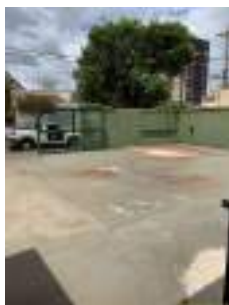
Foto 15 - Cercamento da área.
