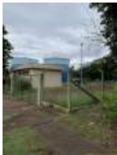
Foto 1 - Cercamento da área.
