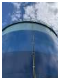
Foto 11 - Mangueiras de aplicação de Ácido Fluossilícico e Hipoclorito de Sódio no reservatório.
