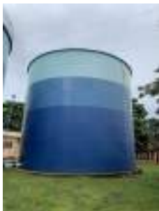
Foto 9 - Vista do reservatório 2.
