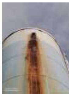
Foto 1 - Extravasor corroído sem tela de proteção. Foto 2 - Extravasor corroído sem tela de proteção.
