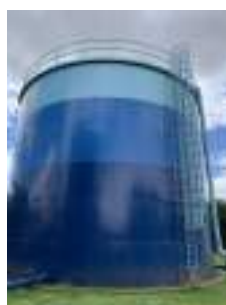
Foto 9 - Guarda-corpo e medição de nível do reservatório maior.
