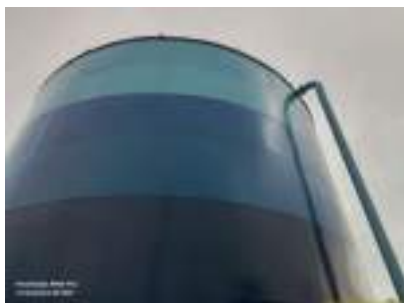
Foto 7 - Vista geral do reservatório.
