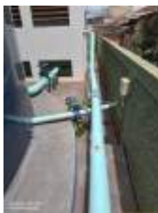
Foto 1 - Tubulação de descarga atravessando o muro.
