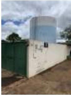
Foto 1 - Vista externa do reservatório e cercamento.
