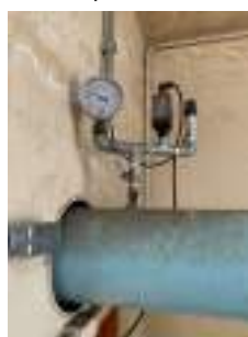
Foto 18 - Medição de pressão na tubulação de recalque.
