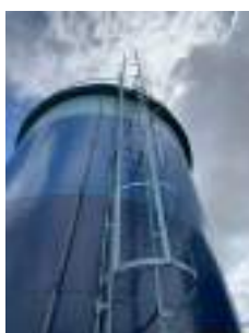
Foto 8 - Guarda-corpo e medição de nível do reservatório menor.
