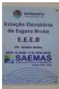
Foto 1 - Placa de identificação instalada pelo prestador (E-mail de 23/01/2026).
