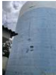
Foto 7 - Vista do reservatório.
