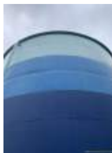
Foto 15 - Vista geral do reservatório.
