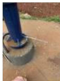
Foto 6 - Torneira para tomada de água bruta.
