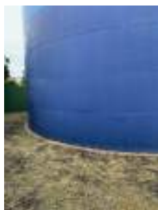
Foto 13 - Vista geral do reservatório.
