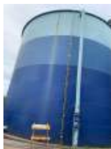
Foto 14 - Mangueiras de aplicação de Ácido Fluossilícico e Hipoclorito de Sódio no reservatório.
