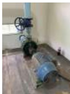
Foto 12 - Conjunto moto bomba 2 com selo mecânico.
