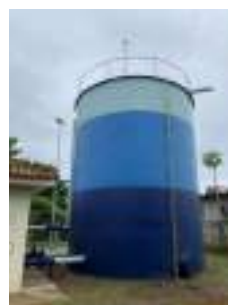
Foto 7 - Vista geral do reservatório
