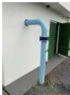
Foto 2 - Tubulação de recalque.
