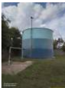
Foto 1 - Vista do reservatório.
