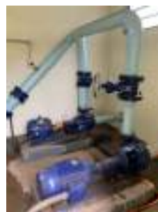
Foto 4 - Vista do interior da edificação da EEA.
