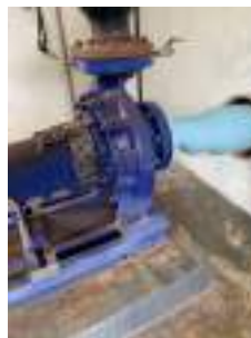
Foto 12 - Conjunto moto bomba 1 com selo mecânico.
