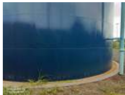
Foto 8 - Vista geral do reservatório.
