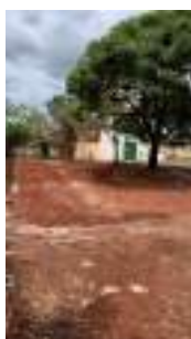
Foto 16 - Local de construção do novo reservatório P22.
