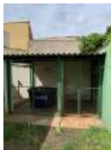
Foto 4 - Abrigo de cloro e flúor. Ausência de flúor.
