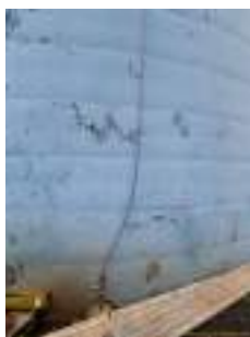
Foto 10 - Medidor de nível.
