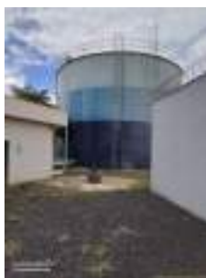
Foto 1 - Vista do reservatório.
