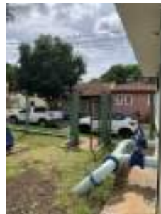
Foto 19 - Cercamento e acesso da área.
