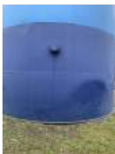
Foto 6 - Vista geral do reservatório.
