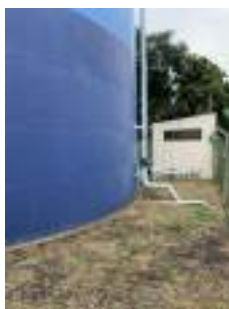
Foto 14 - Vista geral do reservatório.
