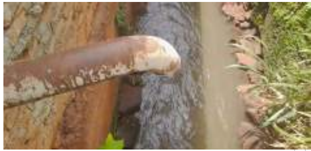
Foto 4 - Vazamento consertado pelo prestador (E-mail de 20/01/2026).
