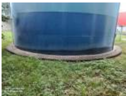
Foto 5 - Vista do reservatório.
