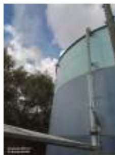
Foto 8 - Vista do reservatório.
