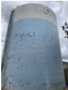
Foto 4 - Vista do reservatório.
