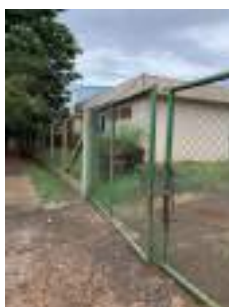
Foto 3 - Cercamento da área.
