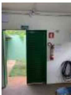
Foto 7 - Vista interna da porta de acesso.
