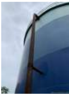
Foto 7 - Adutora do p52.
