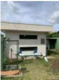
Foto 1 - Vista geral da edificação da EEA.
