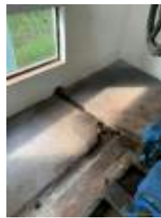
Foto 19 - Saída da canaleta de drenagem.
