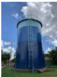
Foto 3 - Guarda-corpo e medição de nível do reservatório menor.
