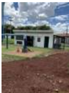
Foto 3 - Vista geral do poço.
