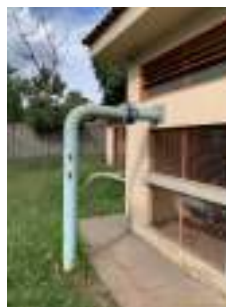
Foto 2 - Tubulação de recalque.
