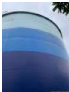
Foto 10 - Vista geral do reservatório.
