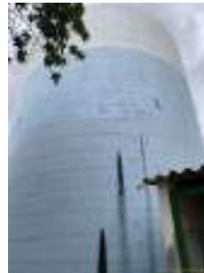
Foto 5 - Vista do reservatório.
