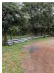
Foto 18 - Tubulação para futura instalação de bomba submersa.
