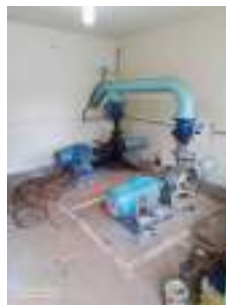
Foto 2 - Vista do interior da edificação da EEA.
