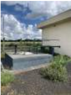
Foto 2 - Caixas de chegada e poço de sucção.
