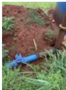
Foto 6 - Buraco aberto para manutenção da adutora do P52.
