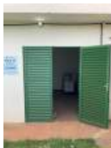
Foto 6 - Vista externa da porta de acesso.
