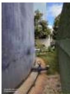
Foto 7 - Dreno de fundo.
