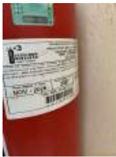
Foto 15 - Validade do extintor.
