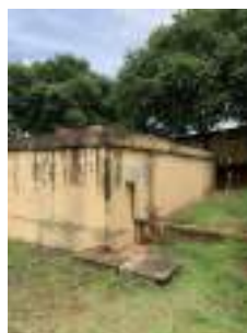
Foto 5 - Vista do reservatório face 3.
