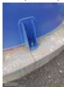
Foto 7 - Aterramento do reservatório.
