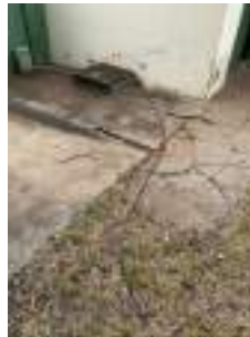
Foto 2 - Adequar a fiação solta na área externa da EEA.
