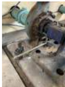
Foto 7 - Drenagem da água de lubrificação da gaxeta da bomba 2.
