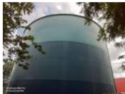
Foto 4 - Vista do reservatório.
