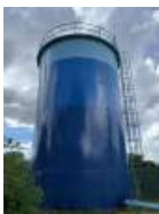
Foto 13 - Guarda-corpo do reservatório 2.
