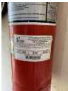
Foto 9 - Validade do extintor.
