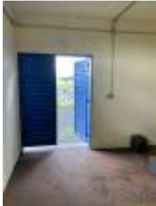
Foto 3 - Vista interna da porta de acesso.
