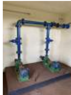
Foto 6 - Vista do interior da edificação da EEA.
