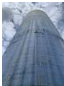
Foto 6 - Vista do reservatório.
