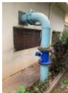
Foto 20 - Tubulação de recalque com macromedidor em instalação.
