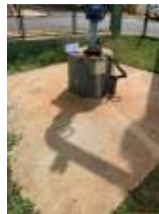
Foto 8 - Laje do poço.
