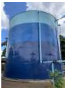
Foto 6 - Vista do reservatório.
