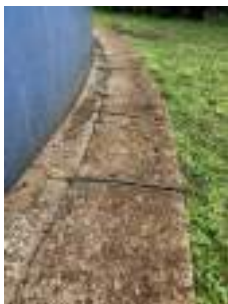
Foto 11 - Aterramento do reservatório 2.
