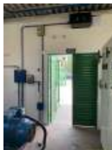
Foto 4 - Vista interna da porta de acesso.
