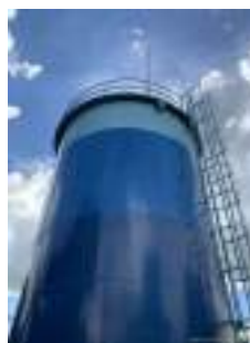
Foto 11 - Guarda-corpo do reservatório 2.
