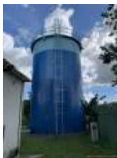
Foto 10 - Guarda-corpo e extravasor do reservatório 2.
