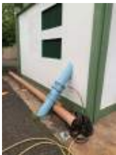
Foto 6 - Tubulação de recalque.
