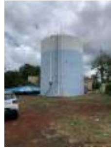
Foto 2 - Vista do reservatório.
