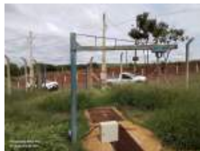
Foto 10 - Acesso à EEEB e estrutura para içamento de bombas.
