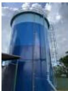
Foto 4 - Guarda-corpo do reservatório 1.
