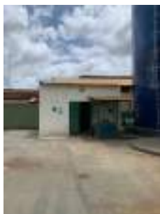
Foto 1 - Vista geral da edificação da EEA.
