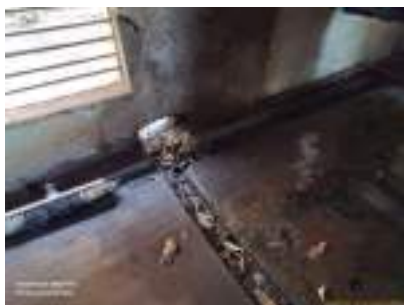
Foto 4 - Saída da canaleta de drenagem.
