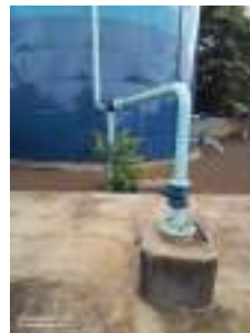
Foto 4 - Laje do poço.
