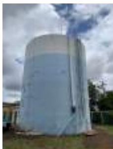
Foto 12 - Vista do reservatório.
