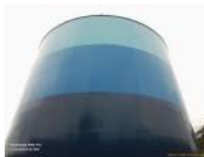
Foto 6 - Vista geral do reservatório.
