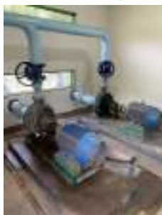
Foto 9 - Vista do interior da edificação da EEA.
