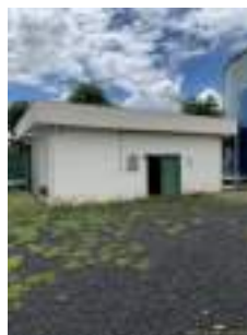
Foto 2 - Vista geral da edificação da EEA.
