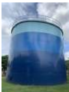
Foto 13 - Vista do reservatório maior e extravasor.
