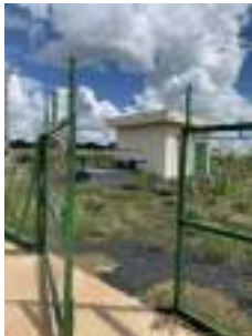
Foto 1 - Vista externa da EEEB e cercamento.
