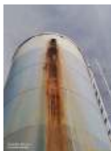
Foto 2 - Consertar o extravasor. O extravasor deve seguir as orientações do item
