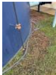
Foto 2 - Mangueira de nível no chão.
