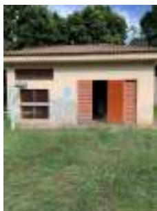
Foto 1 - Vista geral da edificação da EEA.
