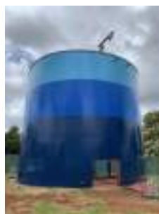
Foto 15 - Estrutura do novo reservatório P47.
