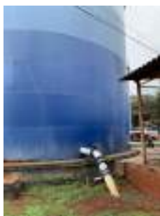
Foto 17 - Vista do reservatório 2.
