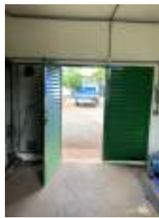
Foto 8 - Vista interna da porta de acesso.
