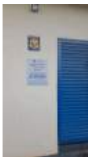
Foto 1 - Placa de identificação instalada pelo prestador (E-mail de 23/01/2026).
