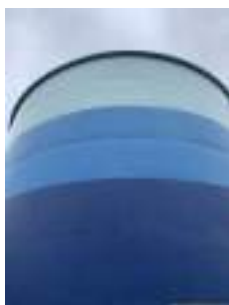
Foto 12 - Vista geral do reservatório.
