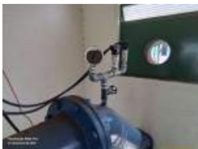
Foto 9 - Medido de pressão da tubulação de recalque.
