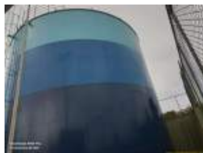
Foto 4 - Vista geral do reservatório.
