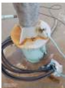
Foto 1 - Proteger a abertura do tubo de medição de nível com CAP.
