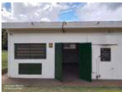
Foto 1 - Vista geral da edificação da EEA.
