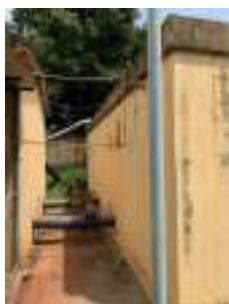
Foto 4 - Vista do reservatório face 2.
