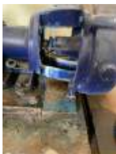
Foto 9 - Drenagem da água de gaxeta da bomba 2.
