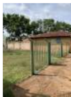
Foto 2 - Cerca da EEEB.
