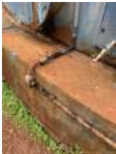
Foto 2 - Substituir conduítes do cabeamento na escada do reservatório 2.
