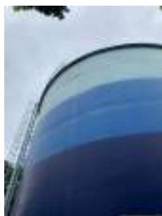
Foto 9 - Vista geral do reservatório.
