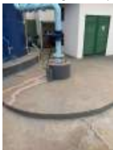
Foto 5 - Laje do poço.
