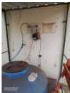
Foto 11 - Dosadora de Ácido Fluossilícico e identificação.
