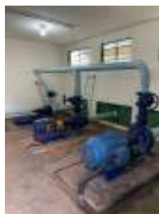
Foto 6 - Vista do interior da edificação da EEA.
