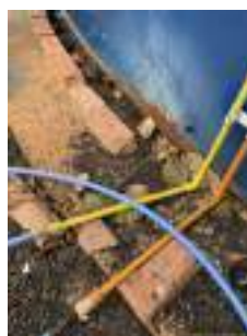
Foto 4 - Cabo do aterramento conectado.
