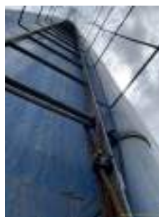
Foto 4 - Linha de vida na escada.
