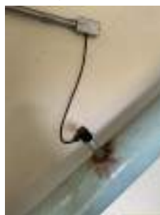
Foto 10 - Medição de pressão da tubulação de recalque.
