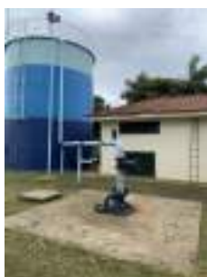
Foto 3 - Vista geral do poço.
