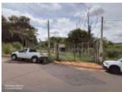
Foto 1 - Vista externa da EEEB.
