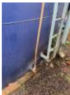
Foto 6 - Mangueira para medição de nível.
