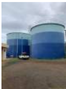
Foto 1 - Vista de dois reservatórios vaso comunicantes.
