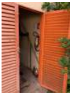
Foto 7 - Vista externa da porta de acesso.
