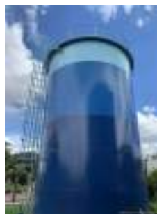
Foto 4 - Vista do reservatório menor.
