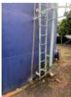
Foto 1 - Mangueira de nível pendurada na escada.
