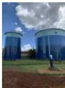
Foto 2 - Vista de dois reservatórios vaso comunicantes.
