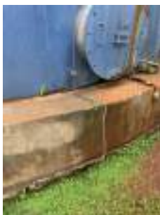
Foto 13 - Aterramento do reservatório 2.
