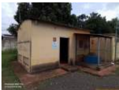
Foto 1 - Vista geral da edificação da EEA.
