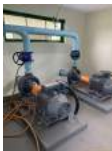
Foto 4 - Vista do interior da edificação da EEA.
