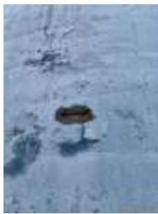
Foto 1 - Armadura exposta.
