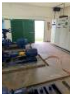
Foto 20 - Vista interna da porta de acesso.
