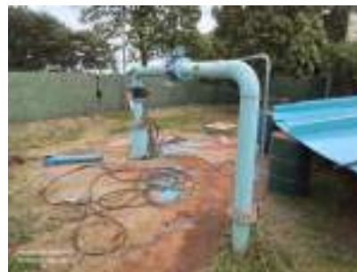
Foto 2 - Vista geral do poço e cercamento.
