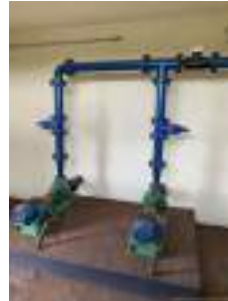
Foto 4 - Vista do interior da edificação da EEA.
