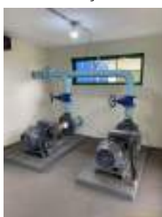
Foto 5 - Vista do interior da edificação da EEA.
