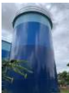
Foto 6 - Vista do reservatório menor.
