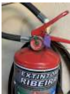
Foto 9 - Pressão do extintor.
