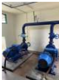
Foto 2 - Vista do interior da edificação da EEA.
