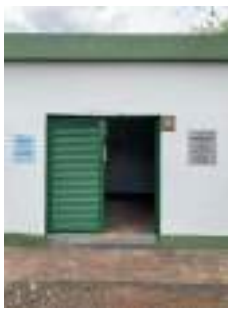
Foto 7 - Vista externa da porta de acesso.
