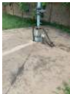
Foto 6 - Laje do poço.
