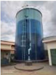
Foto 1 - Vista do reservatório.
