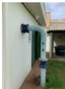
Foto 4 - Tubulação de recalque.
