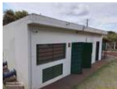
Foto 2 - Vista geral da edificação da EEA.
