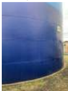
Foto 11 - Vista geral do reservatório.
