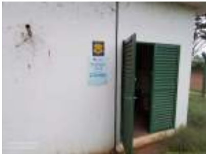
Foto 3 - Vista geral da edificação da EEE e placa de identificação.
