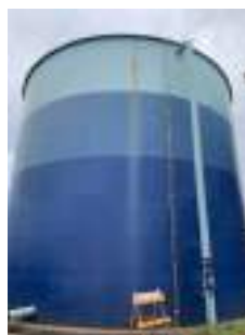
Foto 18 - Vista do reservatório 2.
