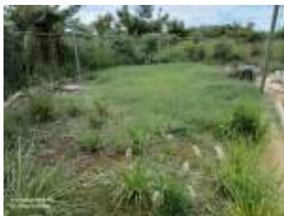
Foto 13 - Tanque pulmão enterrado.
