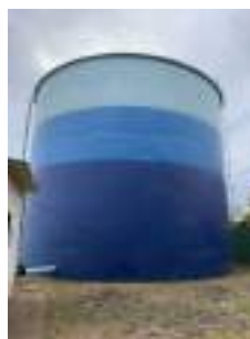
Foto 2 - Vista geral do reservatório.
