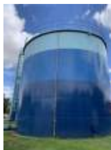
Foto 14 - Vista do reservatório maior e extravasor.
