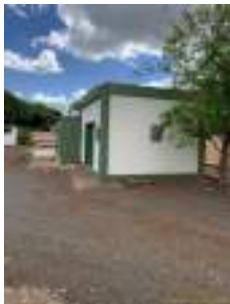
Foto 2 - Vista geral da edificação da EEA.
