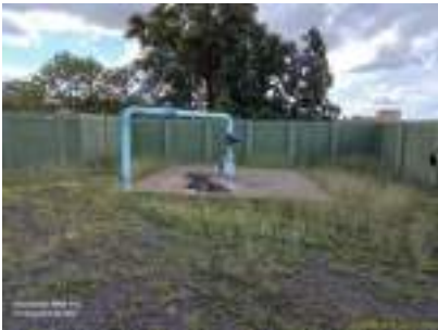
Foto 1 - Vista geral do poço, laje e cercamento.
