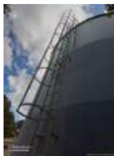
Foto 6 - Guarda-corpo da escada.
