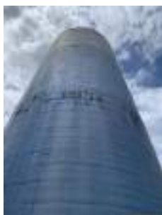
Foto 7 - Vista do reservatório.
