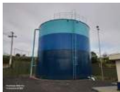
Foto 2 - Guarda-corpo e extravasor do reservatório.
