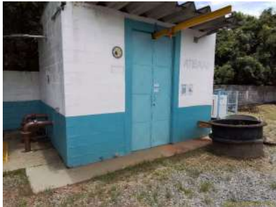
Foto 1 - Casa de bombas
