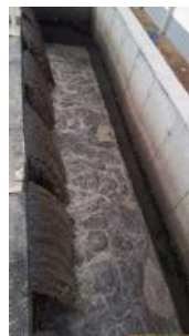
Foto 18 - Saída do efluente para decantador
