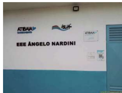
Foto 2 - Entrada da Casa de Máquinas
