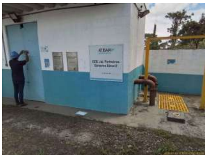
Foto 2 - Casa de máquinas
