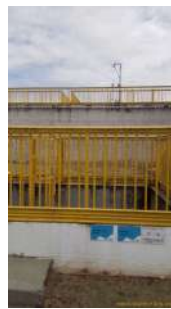
Foto 2 - Estrutura de entrada do efluente na estação
