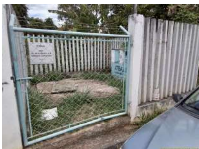
Foto 1 - Fachada da EEE
