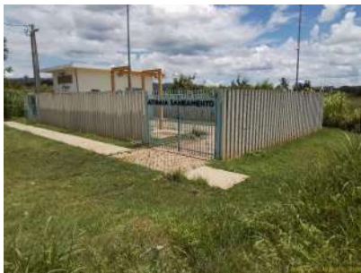
Foto 1 - Fachada da EEE
