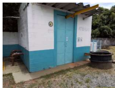
Foto 2 - Casa de bombas
