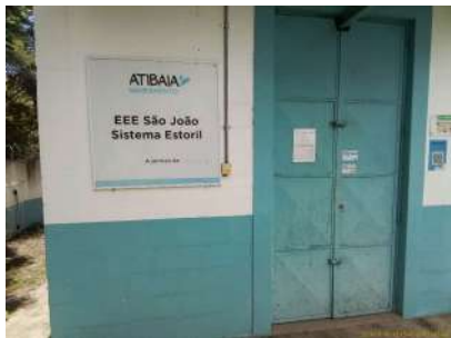
Foto 3 - Entrada da Casa de Máquinas
