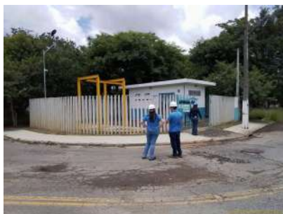
Foto 1 - Fachada da EEE
