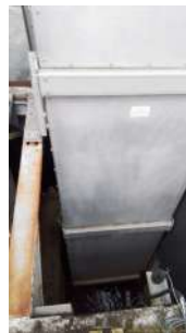
Foto 4 - Gradeamento mecanizado
