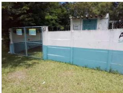
Foto 1 - Fachada da EEE
