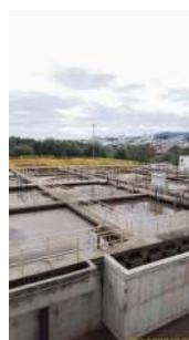
Foto 9 - Vista geral dos tanques de tratamento
