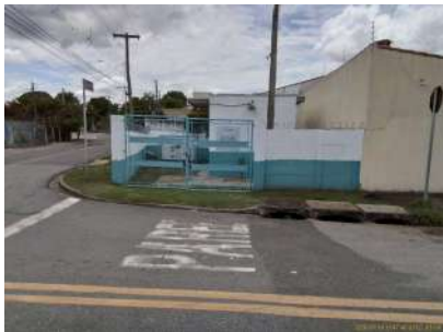
Foto 1 - Fachada da EEE
