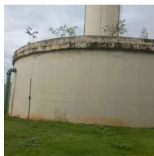
Foto 3 - Vista lateral do reservatório.
