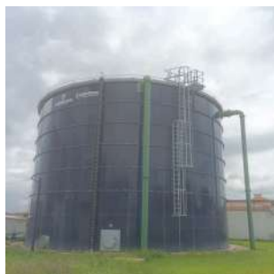
Foto 1 - Vista geral do reservatório.
