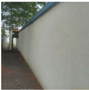
Foto 3 - Vista lateral do reservatório.
