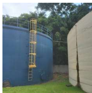
Foto 2 - Vista lateral do reservatório.
