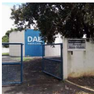
Foto 1 - Entrada do Centro de Reservação
