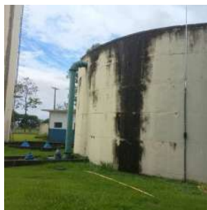
Foto 5 - Vista geral do reservatório.
