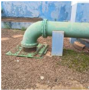
Foto 3 - Tampa com vãos próximos ao piso.
