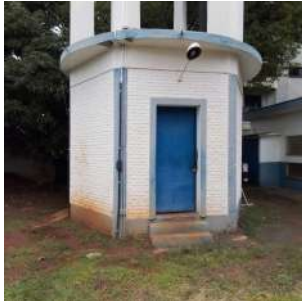
Foto 3 - Base do Reservatório Elevado
