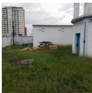
Foto 1 - Vista geral do Centro de Reservação
