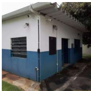
Foto 1 - Entrada da Casa de Máquinas
