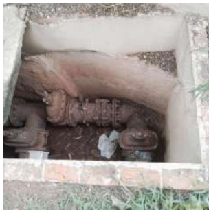
Foto 3 - Caixa de inspeção aberta.
