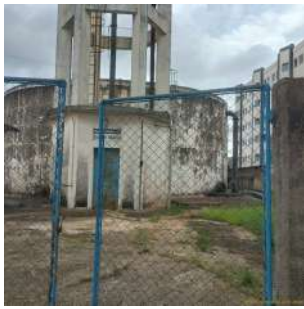
Foto 1 - Entrada do local, com reservatório apoiado ao fundo e elevado à frente.
