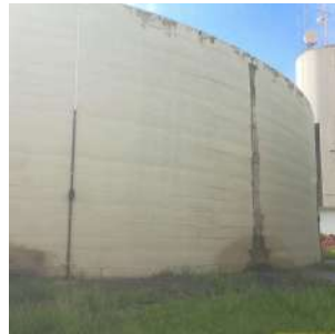
Foto 4 - Vista lateral do reservatório.
