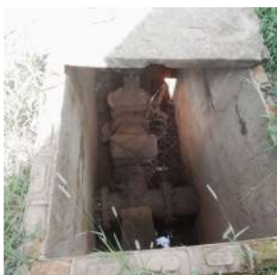
Foto 1 - Caixa de inspeção aberta.
