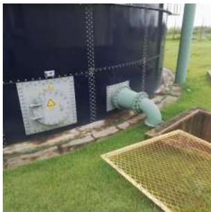
Foto 5 - Vista Lateral do Reservatório Metálico
