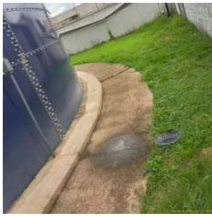
Foto 6 - Aterramento do SPDA.
