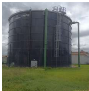
Foto 2 - Vista geral do reservatório.
