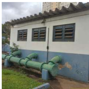
Foto 1 - Vista geral da EEAT.
