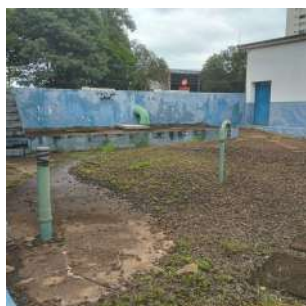
Foto 3 - Vista da laje do reservatório enterrado e tubos de ventilação.
