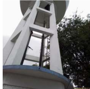
Foto 4 - Vista do acesso e da tubulação do reservatório
