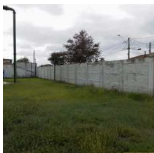
Foto 3 - Vista geral do Centro de Reservação
