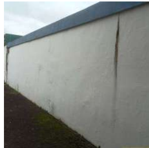
Foto 6 - Vista lateral do reservatório.
