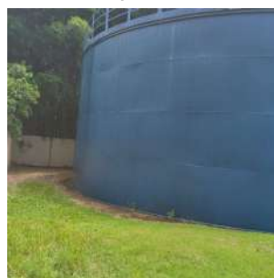
Foto 6 - Vista lateral do reservatório.
