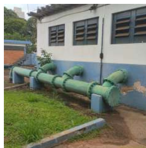
Foto 4 - EEAT ao lado do reservatório enterrado.
