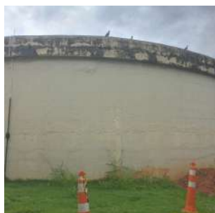
Foto 4 - Vista lateral do reservatório.
