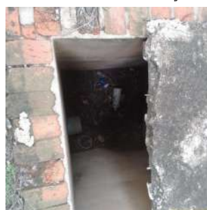
Foto 4 - Caixa de Inspeção do Dreno do Tubo Extravador
