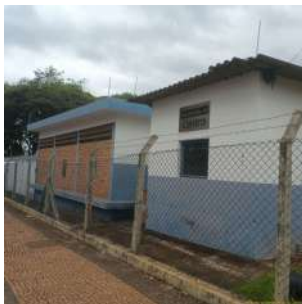
Foto 5 - Identificação do local.
