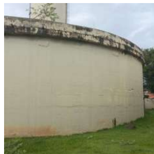
Foto 2 - Vista lateral do reservatório.
