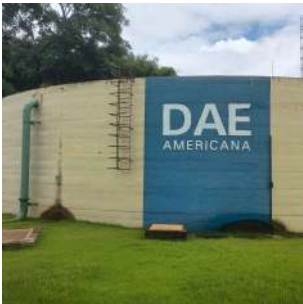
Foto 1 - Vista do reservatório e logo do DAE.
