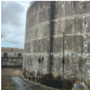
Foto 4 - Vista lateral do reservatório.
