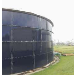
Foto 4 - Vista Lateral do Reservatório Metálico
