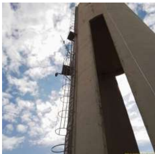
Foto 7 - Escada Marinheiro do Reservatório Elevado
