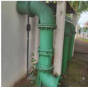
Foto 5 - Extravasor do reservatório.
