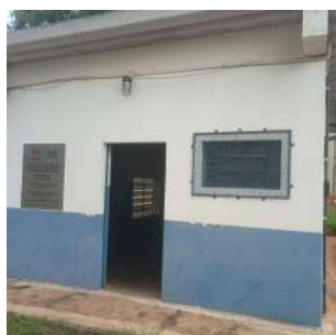
Foto 1 - Entrada da casa de bombas.
