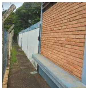
Foto 2 - Vista lateral do reservatório.
