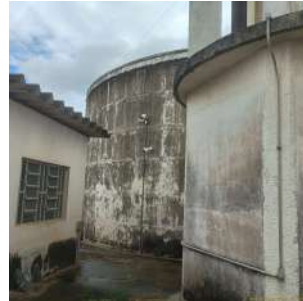
Foto 3 - Reservatório apoiado ao fundo, elevado à direita e EEAT à esquerda.
