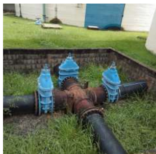
Foto 3 - Cruzeta de Distribuição entre reservatórios e EEAT.
