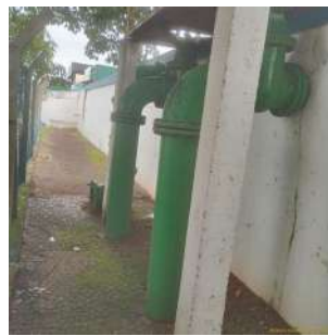
Foto 4 - Vista lateral do reservatório.
