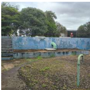
Foto 7 - Vista lateral do reservatório.
