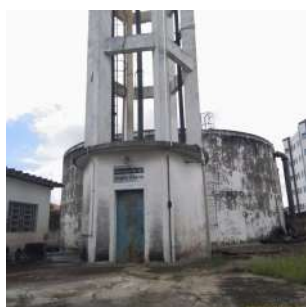
Foto 3 - Vista lateral da base do reservatório elevado
