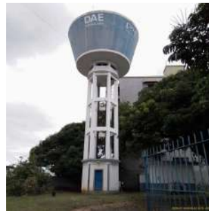
Foto 2 - Vista Geral do Reservatório Elevado
