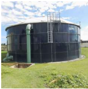
Foto 1 - Vista Lateral do Reservatório Metálico
