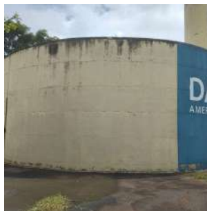
Foto 3 - Vista geral do reservatório.
