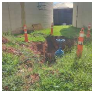
Foto 1 - Escavação para obra envolvendo tubulação do local.
