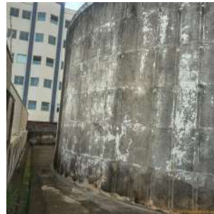
Foto 5 - Vista lateral do reservatório.
