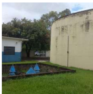
Foto 7 - Vista geral do reservatório.
