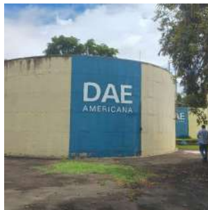
Foto 2 - Vista geral do reservatório.
