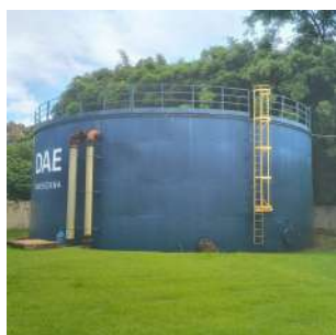
Foto 1 - Vista geral do reservatório.
