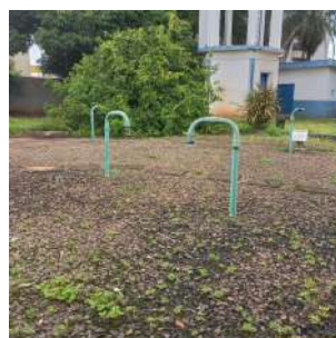
Foto 2 - Vista da laje do reservatório enterrado e tubos de ventilação.
