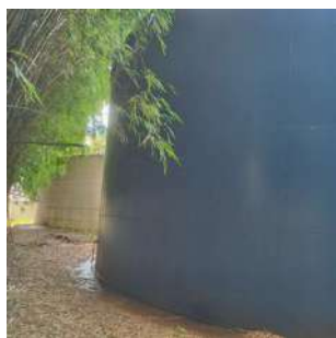
Foto 7 - Vista lateral do reservatório.
