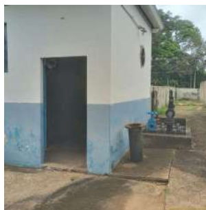
Foto 2 - Vista geral da entrada e lateral da EEAT.
