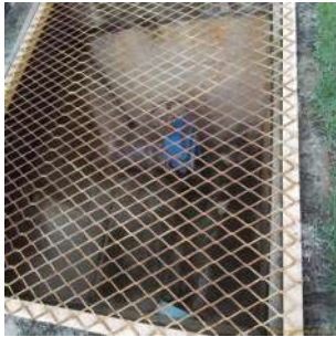
Foto 3 - Caixa de passagem do tubo extravasor
