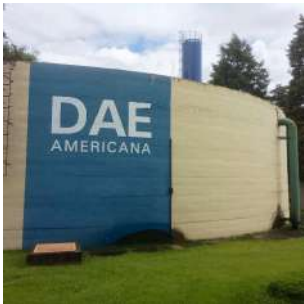
Foto 2 - Vista do reservatório e logo do DAE.
