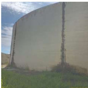
Foto 5 - Vista lateral do reservatório.
