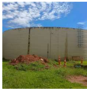
Foto 2 - Vista lateral do reservatório.
