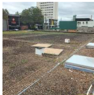
Foto 8 - Laje do reservatório, tampas de inspeção e tubos de ventilação.
