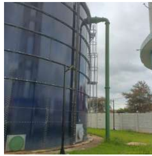
Foto 7 - Vista geral do reservatório.
