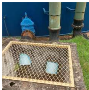
Foto 4 - Detalhe dos tubos extravasor e de descarga de fundo.
