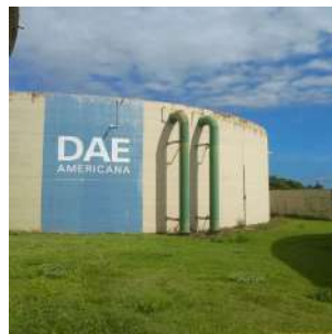
Foto 6 - Tubulação esquerda é o extravasor e direita é a entrada.
