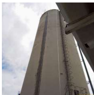
Foto 2 - Vista externa do reservatório elevado
