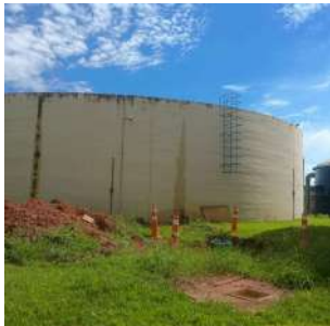
Foto 3 - Vista lateral do reservatório.
