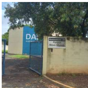
Foto 9 - Identificação do local.
