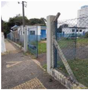
Foto 1 - Entrada do Centro de Reservação
