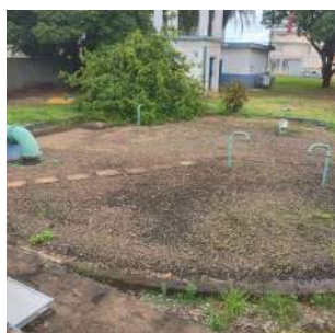
Foto 1 - Vista da laje do reservatório enterrado.
