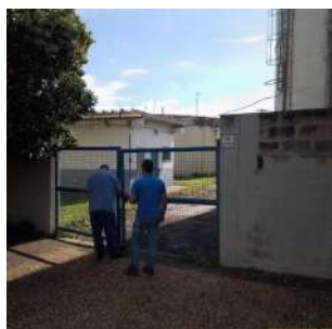
Foto 1 - Fachada do Centro de Reserva São Roque
