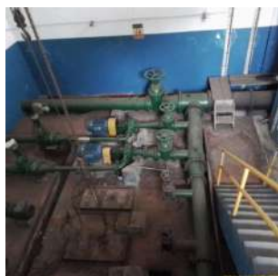
Foto 1 - Vista geral da casa de bombas da EEAT
