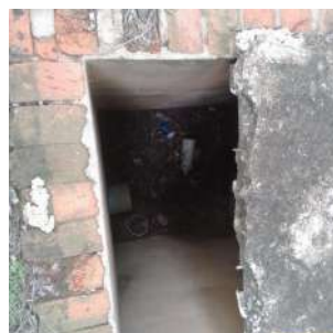
Foto 2 - Caixa de inspeção aberta.
