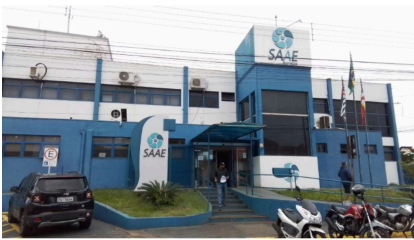
Foto 1 - Fachada prédio SAAEB
