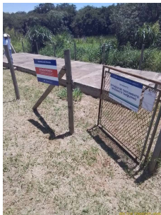
Foto 2 - Portão de acesso à estação de tratamento de esgoto.
