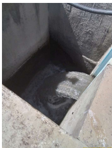
Foto 31 - Saída do efluente tratado.
