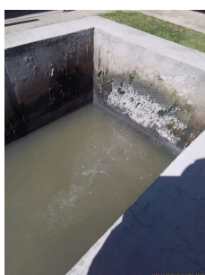
Foto 4 - Entrada do esgoto bruto.
