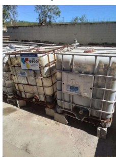
Foto 11 - Tanque contendo biorremediador para tratamento do esgoto bruto.
