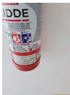
Foto 14 - Extintor de incêndio dentro da validade, conforme indicado na etiqueta.
