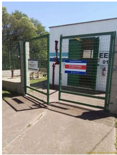
Foto 1 - Portão de acesso para a estação elevatória de esgoto.
