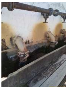
Foto 21 - Descarga dos filtros. Utilizado para limpeza e manutenção.
