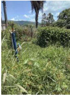
Foto 1 - Presença de vegetação excessiva na área de instalação do poço.
