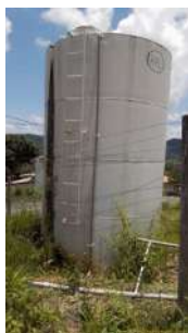
Foto 5 - Escada de acesso ao topo do reservatório 2.
