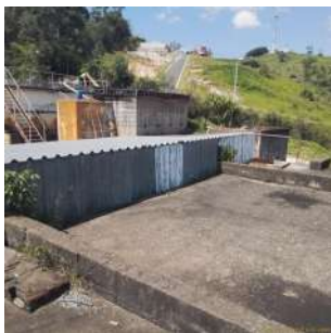
Foto 2 - Topo do reservatório.
