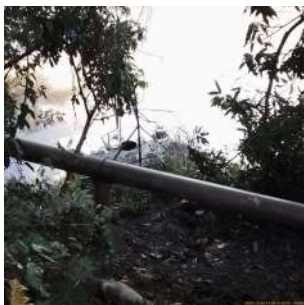
Foto 5 - Ponto de captação da água bruta.
