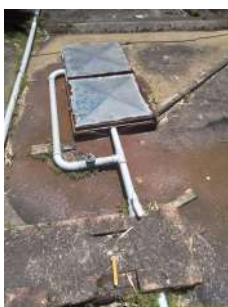
Foto 3 - Entrada de água no reservatório.
