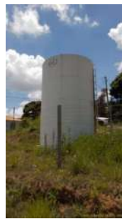
Foto 2 - Vista geral do reservatório 2.
