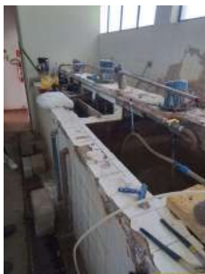
Foto 28 - Bombas que impulsionam as soluções de barrilha e sulfato de alumínio para o ponto de adição no início do tratamento.
