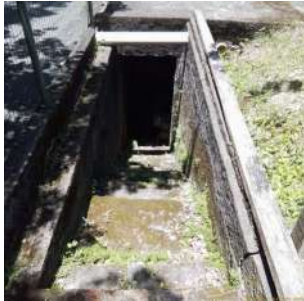
Foto 3 - Entrada de acesso a sala da moto bomba.
