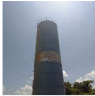
Foto 2 - Topo do reservatório.
