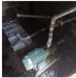
Foto 2 - Moto bomba em operação.
