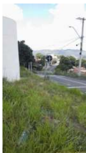
Foto 1 - Área dos reservatórios com vegetação em tamanho excessivo.
