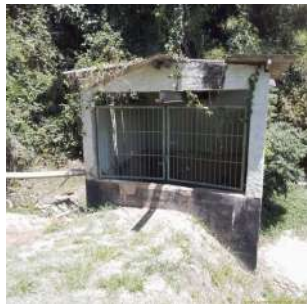
Foto 5 - Abrigo da motobomba.
