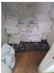
Foto 31 - Sacos de sulfato de alumínio armazenados no interior da ETA.
