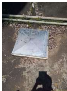
Foto 2 - Tampa de inspeção.
