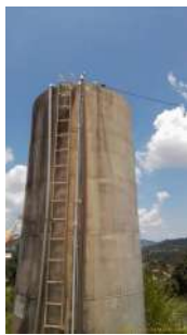
Foto 1 - Topo do reservatório 1.
