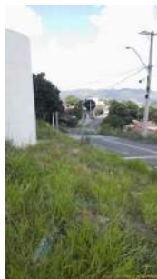
Foto 3 - Ausência de cercamento em torno dos reservatórios.
