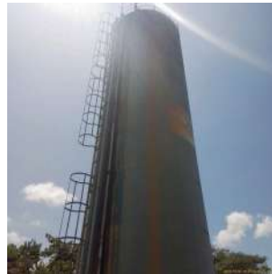
Foto 4 - Escada de acesso ao topo do reservatório.
