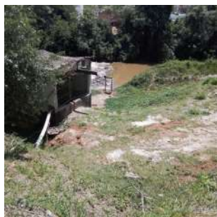
Foto 3 - Ponto de captação.
