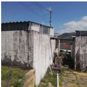
Foto 3 - Vista lateral do reservatório
