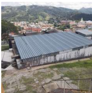
Foto 1 - Vista geral do reservatório.
