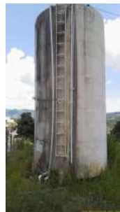
Foto 4 - Escada de acesso ao topo do reservatório 1.
