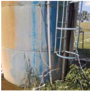
Foto 1 - Medidor de nível (mangueira).
