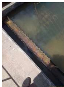
Foto 18 - Calha de um dos decantadores.
