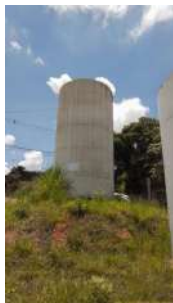
Foto 3 - Vista geral do reservatório 1.
