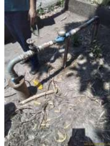
Foto 2 - Vista geral do poço.
