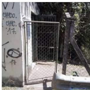
Foto 1 - Entrada da captação sem identificação.
