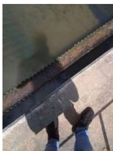
Foto 17 - Calha de um dos decantadores.
