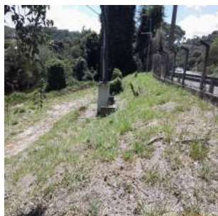
Foto 7 - Cercamento da área do ponto de captação.
