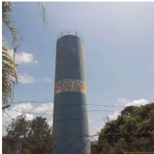
Foto 3 - Vista geral do reservatório.
