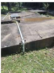
Foto 5 - Vista geral do reservatório.
