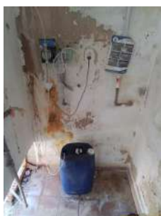
Foto 1 - Barril de armazenamento de ácido fluossilícico.
