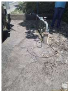
Foto 5 - Laje de proteção.
