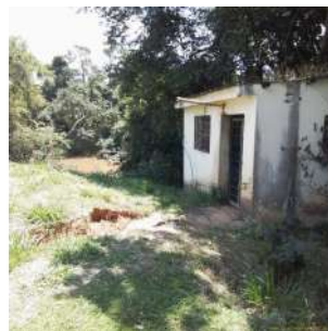
Foto 6 - Vista geral do abrigo da moto bomba.
