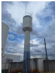
Foto 1 - Reservatório elevado Itaqui - visão geral
