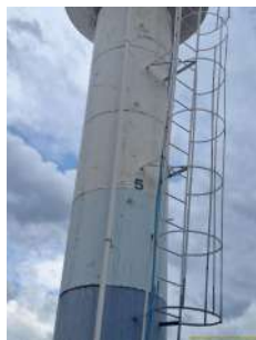
Foto 1 - Marcação de níveis de com volume, mas sem medidor
