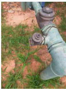
Foto 3 - Ponto de tomada de água bruta
