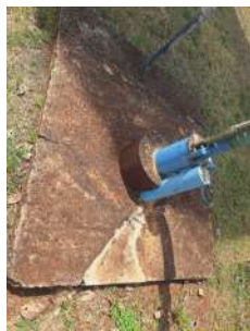
Foto 3 - Laje de proteção
