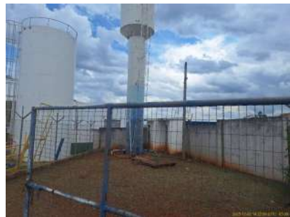
Foto 2 - Cercamento de área - Reservatório Itaqui
