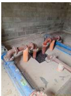
Foto 5 - Dois conjuntos motobomba instalados
