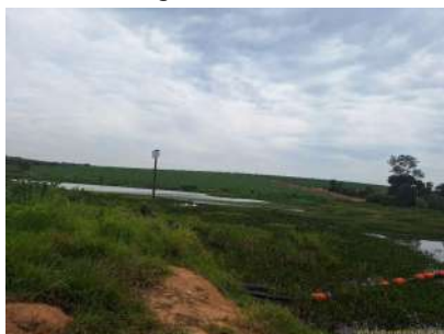
Foto 3 - Tubos da captação de água
