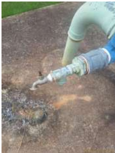
Foto 5 - Torneira para amostragem de água
