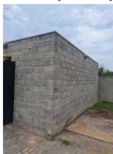
Foto 7 - Abrigo com poço de sucção e conjuntos instalados
