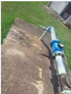
Foto 4 - Laje de proteção
