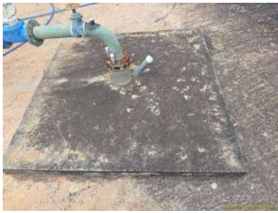
Foto 3 - Laje de proteção
