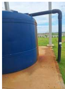
Foto 2 - Reservatório de água bruta
