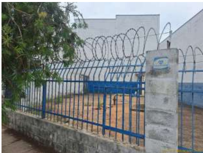
Foto 1 - Cercamento da área
