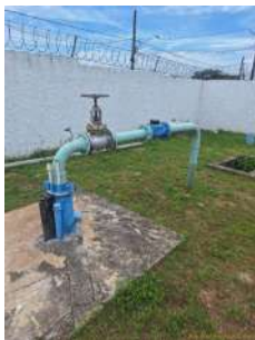
Foto 1 - Visão geral, cercamento, laje de proteção
