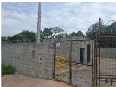
Foto 1 - Cercamento da área
