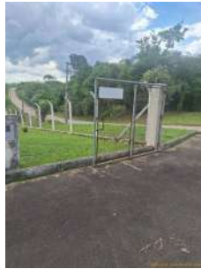
Foto 1 - Ausência de identificação na entrada
