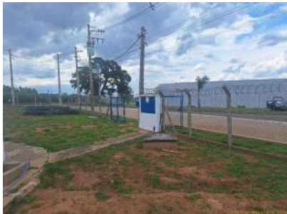
Foto 1 - Cercamento de área - Reservatório Soamin
