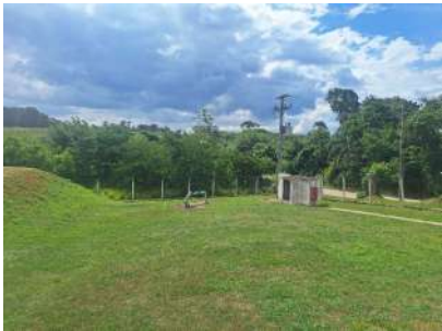
Foto 1 - Visão geral - Poço Soamin
