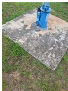
Foto 6 - Laje de proteção
