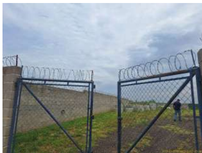
Foto 1 - Cercamento da área
