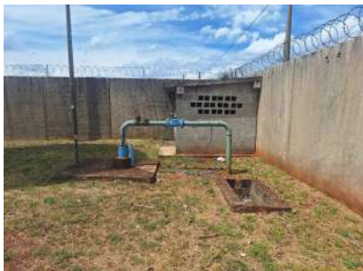
Foto 1 - Visão geral - Poço P13
