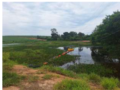
Foto 2 - Conjunto motobomba instalado
