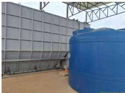
Foto 11 - Tanque de acúmulo de lodo
