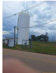
Foto 2 - Guarda-corpos e extravasor - Reservatório Soamin
