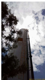
Foto 1 - Escada com proteção.
