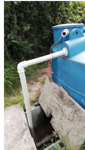
Foto 4 - Entrada do reservatório.
