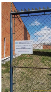
Foto 1 - Entrada e placa de identificação. Apesar da indicação, trata-se apenas de reservatório.
