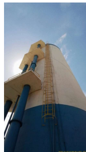
Foto 3 - Escada com proteção.
