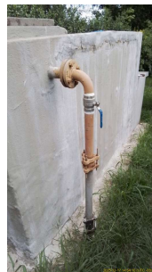
Foto 4 - Entrada do reservatório.
