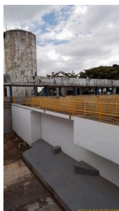
Foto 4 - Houve demolição de laje neste local
