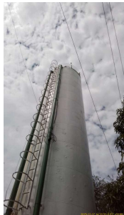
Foto 3 - Visão geral do reservatório
