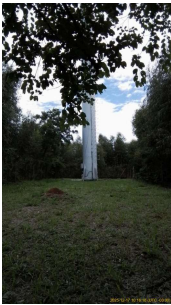
Foto 4 - Escada para acessar a cobertura.
