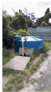
Foto 2 - Visão geral do reservatório.
