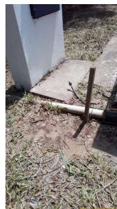
Foto 8 - Saída do reservatório
