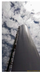
Foto 5 - Escada com proteção
