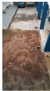
Foto 2 - Tanques para armazenamento de produtos químicos foram removidos
