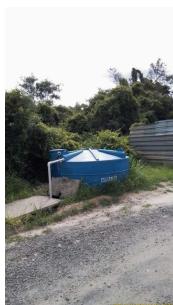
Foto 6 - Visão geral do reservatório.
