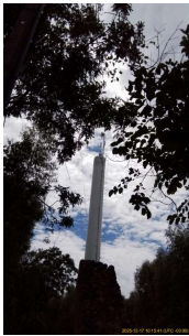
Foto 3 - Visão geral do reservatório.
