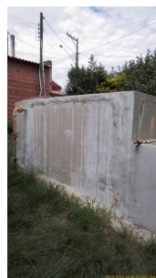
Foto 8 - Foi realizada reforma no reservatório, envolvendo tratamento de fissuras e impermeabilização.
