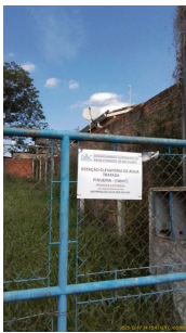
Foto 1 - Placa de identificação. Apesar do indicado, trata-se apenas de reservatório.
