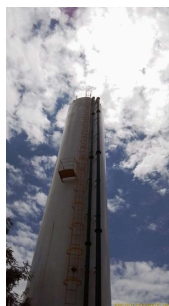
Foto 2 - Visão geral do reservatório.
