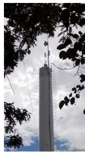
Foto 6 - Para-raios na cobertura
