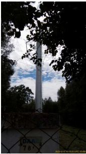
Foto 2 - Visão geral do reservatório.
