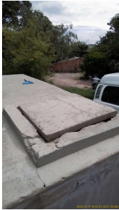
Foto 1 - Tampa de inspeção.
