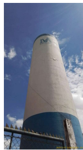
Foto 2 - Visão geral do reservatório.
