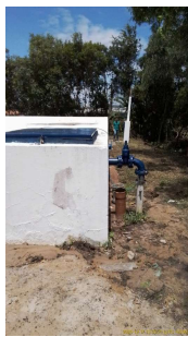
Foto 4 - Tampa de inspeção reformada e tubulação de alimentação
