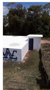
Foto 3 - Reservatório e casa de bombas, que recalca para outro reservatório situado em cota superior.
