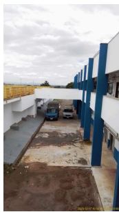
Foto 1 - Local onde antes ficavam tanques para armazenamento de produtos em situações inadequadas.
