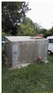
Foto 3 - Visão geral do reservatório.
