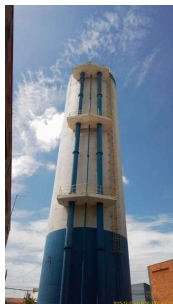
Foto 6 - Visão geral do reservatório
