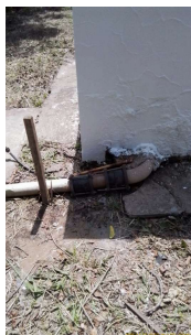
Foto 7 - Saída do reservatório
