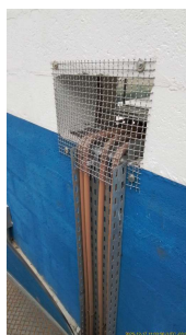
Foto 18 - Saída do PAC, flúor e Dióxido de cloro
