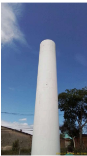
Foto 2 - Visão geral do reservatório.
