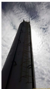
Foto 1 - Escada com proteção
