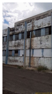
Foto 20 - Calha para subida das tubulações que transportam produtos químicos.
