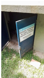
Foto 1 - Acesso à casa de bomba.
