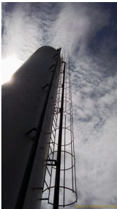
Foto 3 - Escada com proteção.
