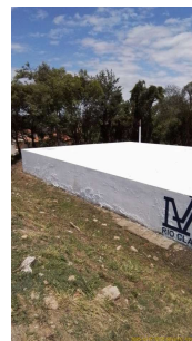
Foto 2 - Reservatório recuperado. Havia vazamentos generalizados causados por infiltrações.
