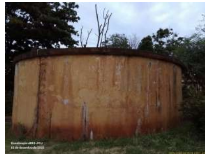
Foto 9 - Vista geral do reservatório.
