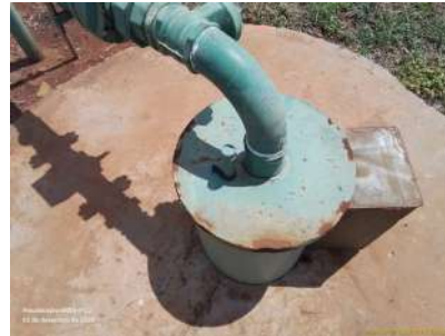
Foto 6 - Tubo para medição de nível do poço.
