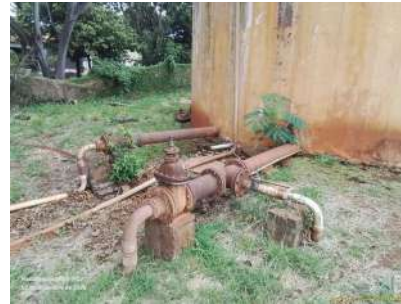
Foto 6 - Tubulações de saída do reservatório.
