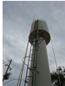
Foto 6 - Vista geral do reservatório, evidenciando mangueira para medição de nível à direita.
