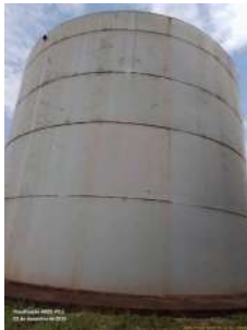
Foto 8 - Vista geral do reservatório.
