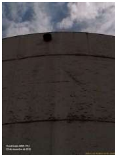
Foto 10 - Extravasor próximo ao topo do reservatório.
