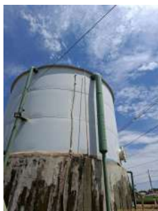
Foto 7 - Mangueira para medição de nível do reservatório.
