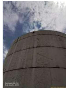
Foto 9 - Extravasor próximo ao topo do reservatório.
