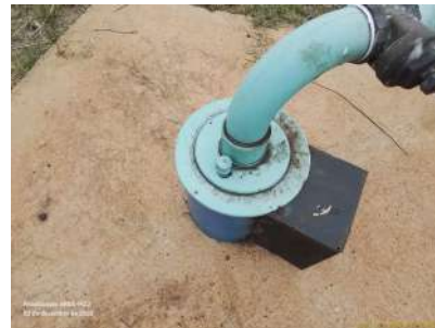
Foto 4 - Tubo para medição de nível do poço.
