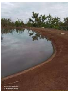
Foto 14 - Vista do perímetro da terceira lagoa da ETE evidencia bordo de alvenaria para estabilização do talude.
