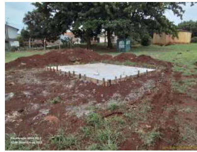
Foto 4 - Base de alvenaria construída na área, preparada para instalação de novo reservatório que substituirá o reservatório atual.
