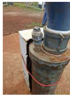
Foto 4 - Tubo para medição de nível do poço.
