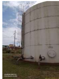
Foto 11 - Vista geral do reservatório.
