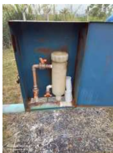
Foto 7 - Equipamento para adição de reagentes empregados no tratamento da água (cloro e flúor em pastilhas).
