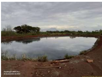
Foto 8 - Lagoa anaeróbica à esquerda, vista a partir do tratamento primário, em paralelo à outra lagoa anaeróbica.
