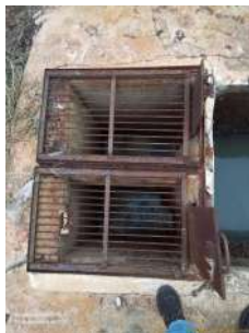
Foto 6 - Efluente após o tratamento preliminar.
