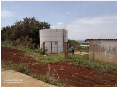
Foto 1 - Vista geral da área a partir do passeio público, evidenciando cercamento da unidade.
