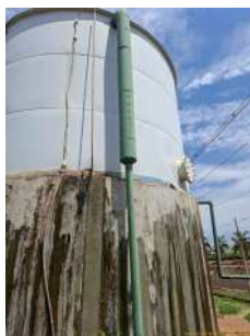
Foto 5 - Tubo extravasor do reservatório.
