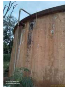
Foto 8 - Medidor de nível tipo mangueira.
