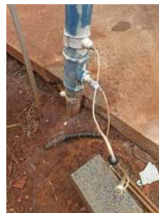
Foto 7 - Pontos para adição de reagentes químicos utilizados no tratamento da água.
