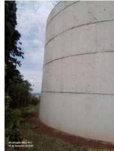
Foto 7 - Vista geral do reservatório.
