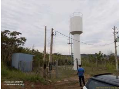
Foto 1 - Vista geral da unidade a partir do passeio público, evidenciando cercamento da área.
