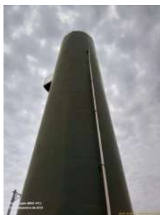
Foto 7 - Vista geral do reservatório.
