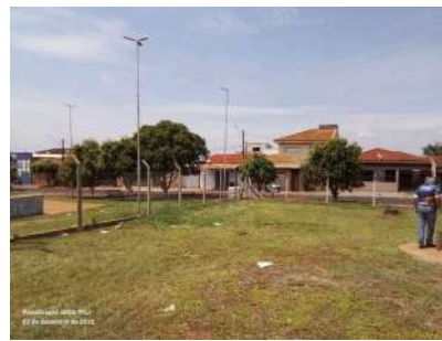
Foto 4 - Vista da parte interna da unidade, indicando cercamento da área.
