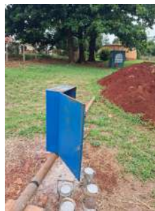
Foto 7 - Posicionamento do equipamento dosador de reagentes na saída do poço, antes do reservatório existente no local.
