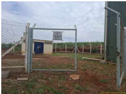
Foto 1 - Vista da área a partir do passeio público, evidenciando cercamento da área.
