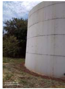
Foto 6 - Vista geral do reservatório.
