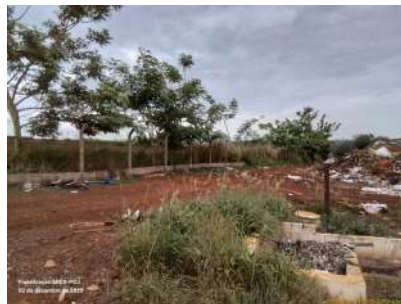
Foto 2 - Vista da área interna, próximo ao tratamento preliminar.
