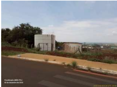
Foto 2 - Vista geral da área a partir do passeio público, evidenciando cercamento da unidade.
