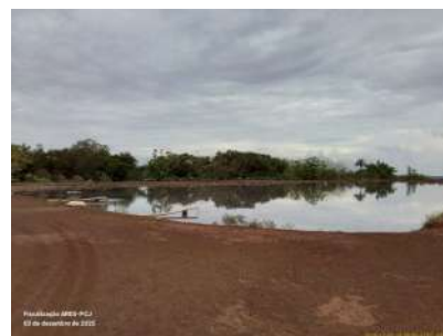
Foto 12 - Vista geral da terceira lagoa, facultativa, da ETE.
