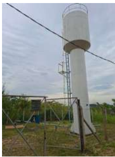
Foto 1 - Vista geral da unidade a partir do passeio público, evidenciando cercamento da área.
