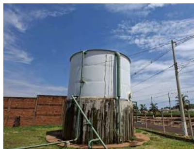
Foto 6 - Vista geral do reservatório.
