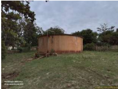
Foto 5 - Vista geral do reservatório.
