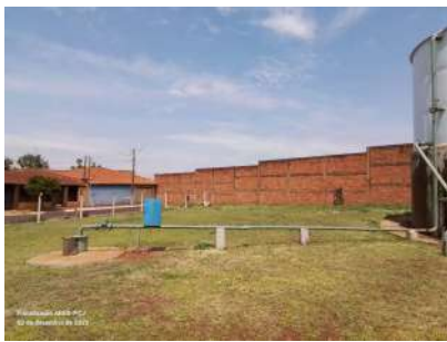
Foto 3 - Vista geral da captação.
