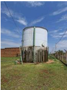
Foto 1 - Vista geral do reservatório.
