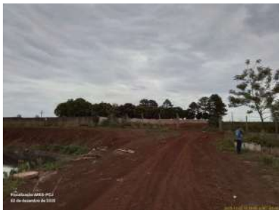
Foto 1 - Vista da entrada da unidade. Há cercamento com alambrado, mas não há portão no acesso.
