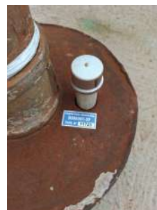
Foto 3 - Tubo para medição de nível.
