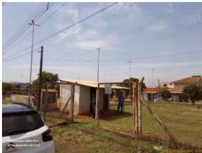
Foto 1 - Vista geral da área a partir do passeio público, evidenciando cercamento da área.
