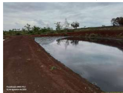
Foto 10 - As duas lagoas anaeróbicas apresentam acúmulo de resíduos na superfície.
