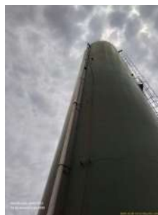
Foto 8 - Vista geral do reservatório.
