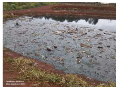
Foto 6 - As duas lagoas anaeróbicas apresentam acúmulo de resíduos na superfície.
