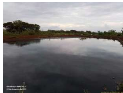
Foto 9 - As duas lagoas anaeróbicas apresentam acúmulo de resíduos na superfície.
