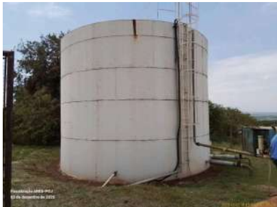
Foto 4 - Vista geral do reservatório.
