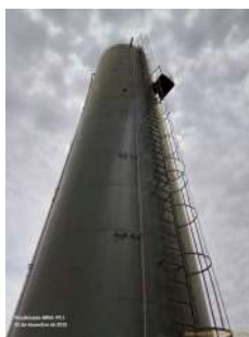
Foto 5 - Vista geral do reservatório, evidenciando mangueira para medição de nível.
