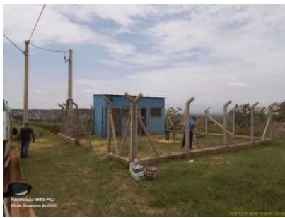
Foto 1 - Vista geral da unidade a partir do passeio público, evidenciando cercamento da área.
