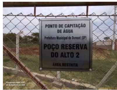
Foto 2 - Placa de identificação afixada no portão de acesso à área de acesso à área.
