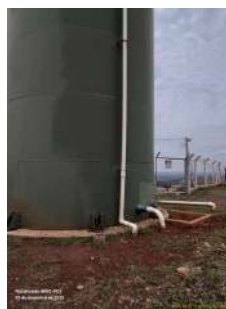
Foto 6 - Vista da base do reservatório, evidenciando tubulações de saída.
