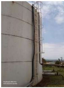
Foto 5 - Escadas e guarda corpos presentes na estrutura.
