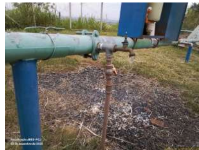
Foto 6 - Torneira para coleta de água bruta da captação.
