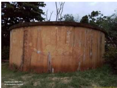
Foto 10 - Vista geral do reservatório.
