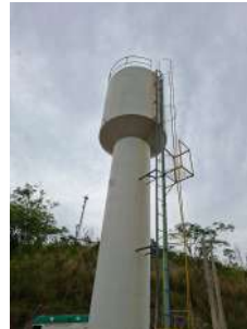
Foto 4 - Vista geral do reservatório evidenciando escada e guarda corpos.
