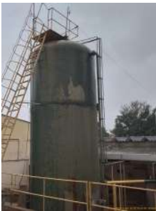
Foto 3 - Lateral do reservatório
