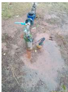
Foto 4 - Estrutura do poço Samambaia
