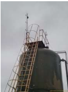
Foto 2 - Para-raio e guarda-corpo na parte superior do reservatório
