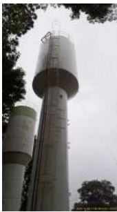
Foto 4 - Escada de acesso e tubulação lateral
