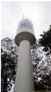
Foto 2 - Vista lateral do reservatório
