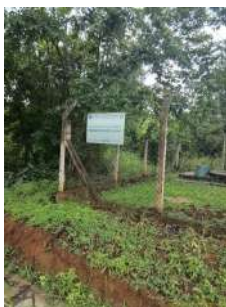
Foto 1 - Placa de identificação da Estação Elevatória de Esgoto
