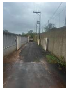
Foto 17 - Entrada da ETA
