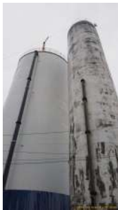
Foto 1 - Lateral dos dois reservatórios
