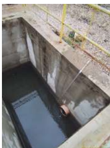
Foto 9 - Aplicação de cloro no tanque
