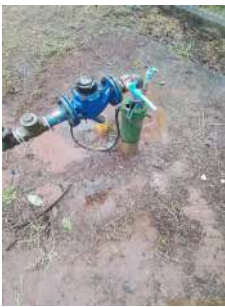
Foto 6 - Destaque para a tubulação do poço
