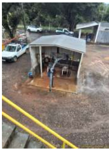
Foto 11 - Elevatória que bombeia o efluente para o tratamento
