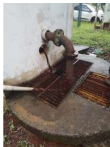
Foto 7 - Tubulação de entrada do efluente
