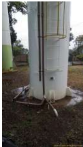
Foto 5 - Destaque para a base do reservatório
