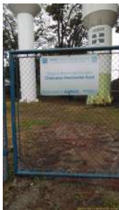
Foto 1 - Placa de identificação do reservatório
