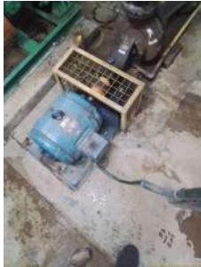
Foto 3 - Destaque para a bomba em utilização
