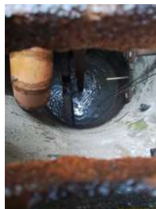
Foto 5 - Gradeamento na entrada do efluente
