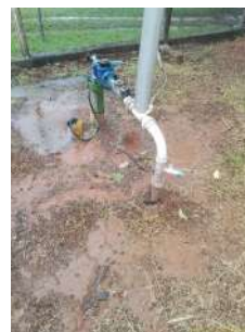
Foto 2 - Estrutura do poço Samambaia
