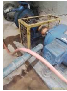
Foto 2 - Destaque para a bomba em utilização
