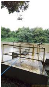
Foto 1 - Instalações da captação
