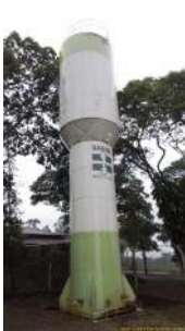
Foto 2 - Vista geral do reservatório
