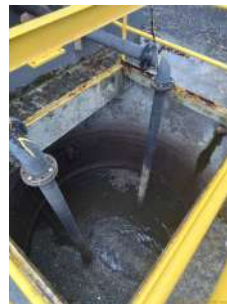
Foto 18 - Poço de entrada
