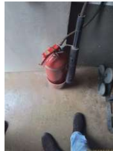
Foto 8 - Extintor de incêndio disponível no local
