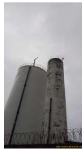
Foto 6 - Vista geral dos reservatórios
