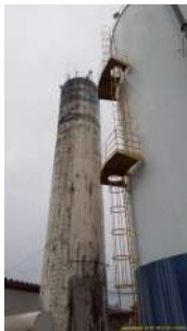
Foto 3 - Destaque para escada de acesso
