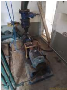
Foto 2 - Bomba instalada
