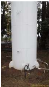
Foto 3 - Vista lateral da base do reservatório
