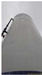
Foto 5 - Lateral do reservatório
