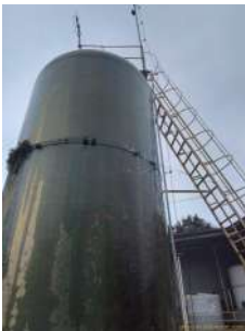
Foto 4 - Lateral do reservatório
