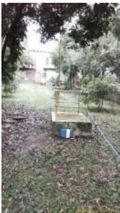
Foto 4 - Área de passagem da água bruta, que é encaminhada até a ETA Compacta Martin Prado Jr
