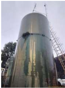
Foto 6 - Lateral do reservatório
