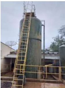
Foto 1 - Escada na lateral do reservatório
