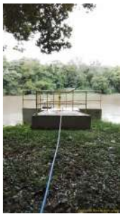
Foto 5 - Instalações da captação
